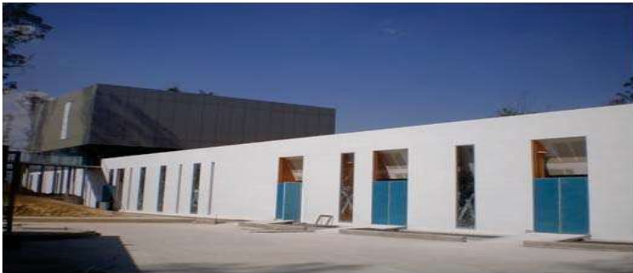
FACHADA PRINCIPAL (CBI). (Fig. N° 7)
