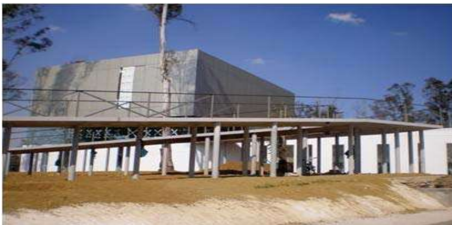
RAMPA ACCESO AL PRIMER NIVEL. (Fig. N° 9)
