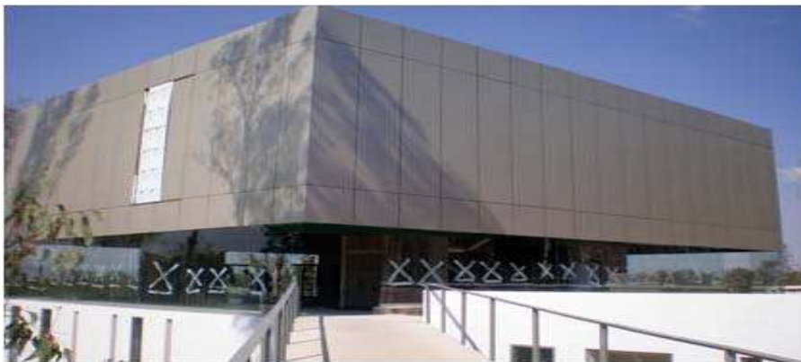
FACHADA PRIMERO Y SUGUNDO NIVEL. (Fig.N° 8)
