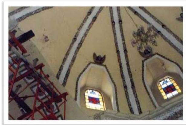
**Figura 2.14** Daños en la cúpula del camarín y en el arco que se formó sobre el muro retirado
