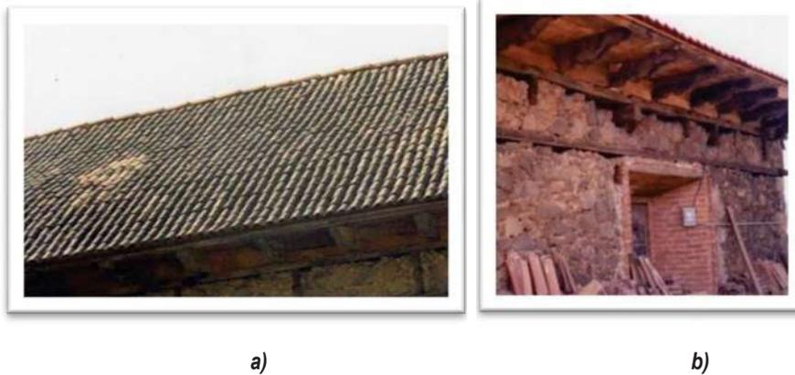
**Figura 3.14** a) se observa deterioro en la techumbre; b) detalles de la techumbre y de la boquilla de la ventana
