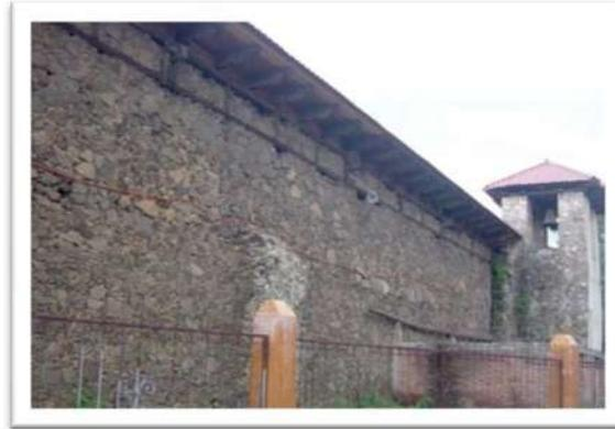
**Figura 3.7** Muro y arrastres de madera colocados en la parte superior.
