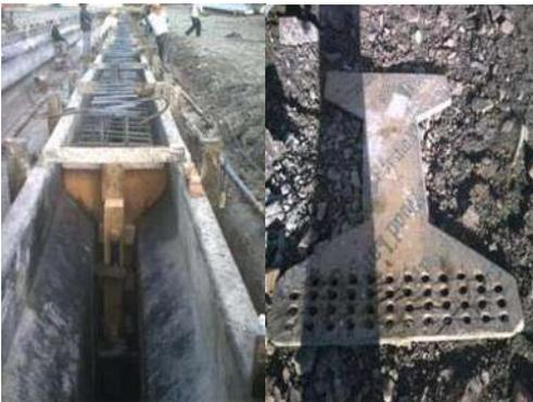
Ya colocado el acero, se insertan los torones en su respectivo lugar dentro del acero, previamente encamisados. Se observa la cimbra del extremo de la viga con orificios en donde pasan los torones.
