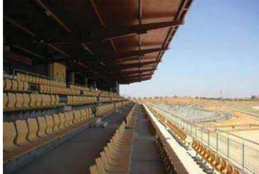
Fig. 1.8.- Gradería cubierta para el Hipódromo de Caracas, Venezuela. Cascarones de 7.5 cm de espesor de concreto presforzado con 27 metros de cantilíver [2].
