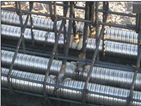
Enfoque a la unión del ducto de aluminio con el ducto de plástico para la inyección, se logra por medio de coples de plástico fijados con alambre recocido y cinta adhesiva.
