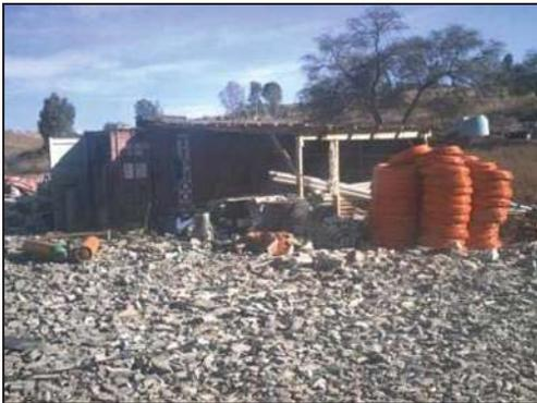
Almacenamiento de ductos de aluminio para el postensado y de ductos (manguera) de plástico para el encamisado de los torones en el pretensado y para los respiradores de las vigas tipo VI postensadas.
