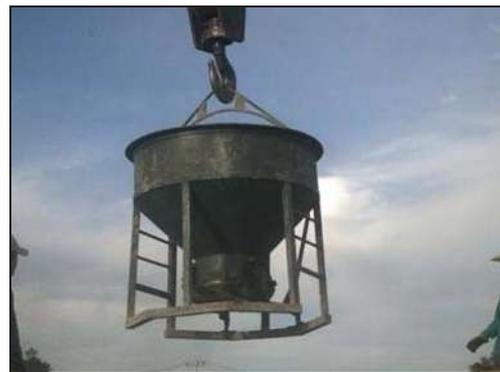
Contenedor de concreto (bacha) con capacidad de  $1.5 \text{ m}^3$ , el cual se emplea para el colado de las vigas tipo VI, elevándolo con una grúa.
