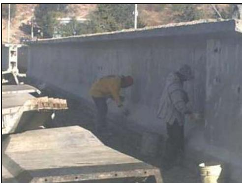
Se resanan las vigas con pasta de cemento y agua para cubrir los defectos producidos durante el descimbrado.
