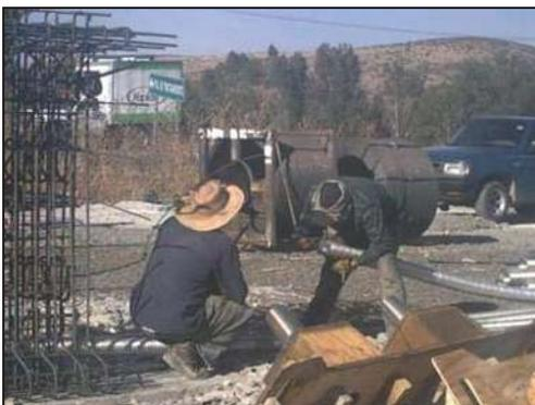
Momento en el que se introduce el paquete de torones necesarios por medio del ducto de aluminio, para las vigas tipo VI.
