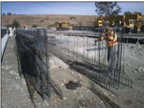
Se continúa con el habilitado de los estribos y del acero longitudinal que forman parte del alma de la viga.
