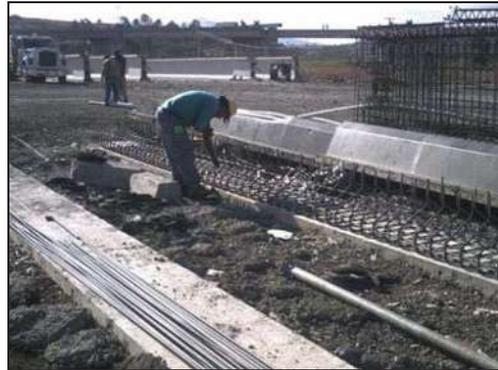
Inicio del armado inferior de una viga tipo VI, se habilita sobre la plantilla, lugar donde se realizará el colado.
