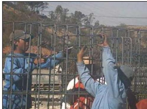
Finalmente se realiza el armado del patín superior de la viga, colocando las botellas y los aviones.
