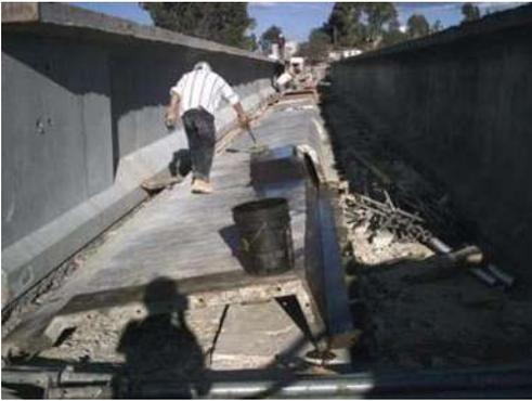
Descimbrado de la viga. Inmediatamente se engrasa la cimbra con diesel para evitar su adherencia al concreto, para posteriormente trasladarla a la siguiente posición.
