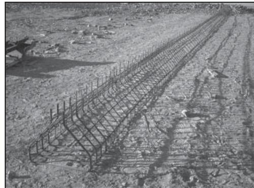
Inicio del armado de la trabe AASHTO tipo IV, se habilita el acero longitudinal inferior con las botellas que forman el patín inferior de la viga.
