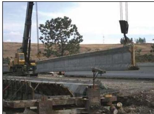
Retiro de la viga de la cama de presfuerzo, el izaje se realiza con dos grúas, una en cada extremo; se estiban a un costado de la cama sobre dos apoyos de concreto, uno en cada extremo para evitar daños.
