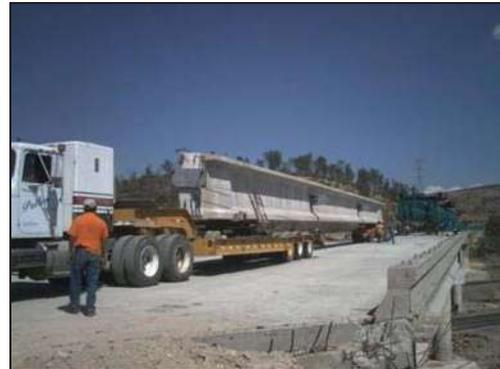
Alimentación de traves con el auxilio del vehículo de carga (tráiler y Dolly), entrando en reversa por el terraplén de acceso.
