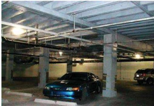
Fig. 1.9.- Vigas y losas presforzadas del garage de la Humble Oil, Houston, Texas. Tiene cuadros típicos de 19 x 8.5 metros y soporta maquinaria pesada en el techo hasta de 3.41 kg/cm<sup>2</sup> [2].
