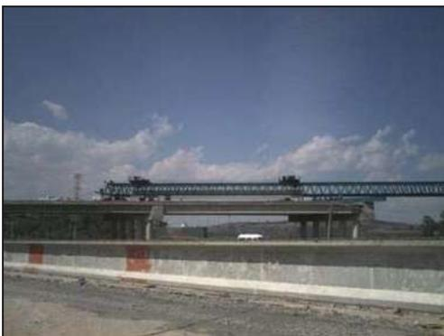
Corrimiento transversal a través del dispositivo, descenso y posicionamiento de traves en sus ejes.
