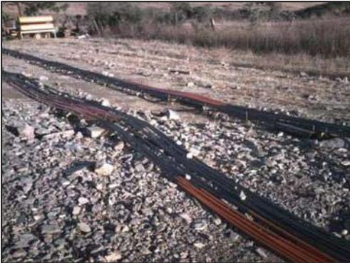
Encamisado de los torones con tubería de plástico en los extremos de las vigas tipo IV, las longitudes se indican en el corte longitudinal de las vigas en los planos de proyecto. Esto con el fin de evitar adherencia del torón con el concreto y no producir momentos negativos indeseables, ya que donde se requieren es en la parte central de la viga.
