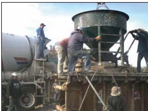
El concreto es vaciado del contenedor por medio de un sistema de compuertas que regulan el paso del concreto, dichas compuertas son operadas manualmente.
