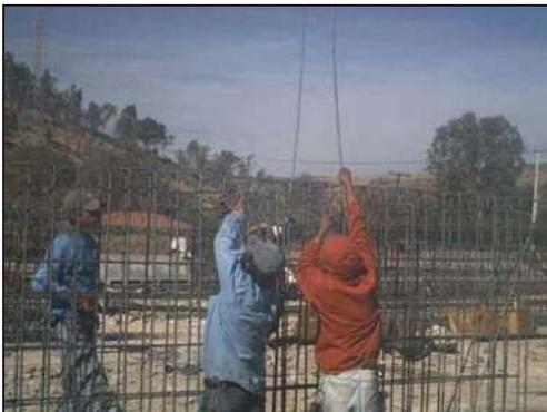
Al igual que las vigas tipo IV, se continúa con el habilitado del alma de una viga tipo VI.
