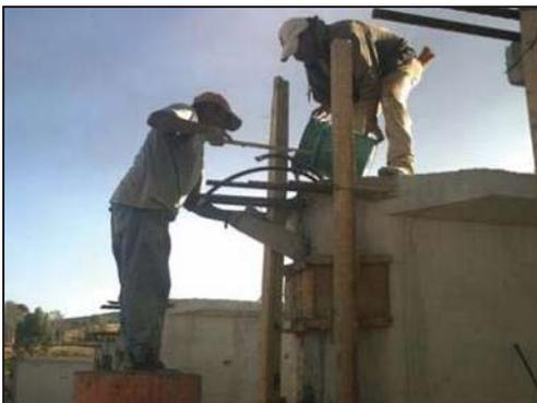
Colado de los cajones en los extremos del anclaje, para formar los tapones para la inyección. Éstos se cuejan con un concreto de resistencia  $f'c = 250 \text{ kg/cm}^2$ .
