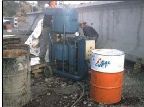
Se bombea la lechada por un extremo de los ductos expulsando el agua contenida debido a la diferencia de densidad, una vez que salga con la consistencia adecuada por el otro extremo y que alcance una presión de  $8 \text{ kg/cm}^2$  (8 bares), indicados en el proyecto, se cierra el conducto, se desconecta y se continúa con otro de los ductos.
