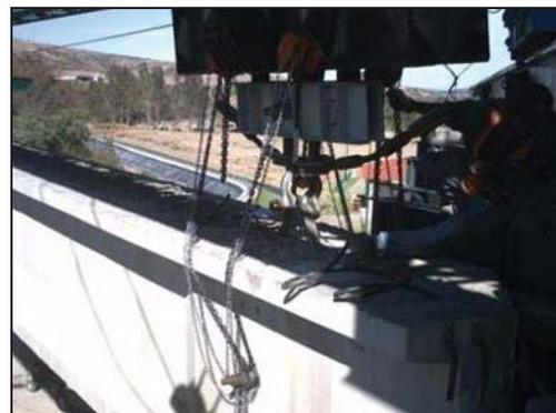
Se retiran los dispositivos de sujeción, se nivela y se fija la trabe en su posición, para posteriormente continuar con las demás traves. Terminado el número total de traves y colada la losa, se traslada el dispositivo al siguiente claro y se repiten las mismas operaciones.
