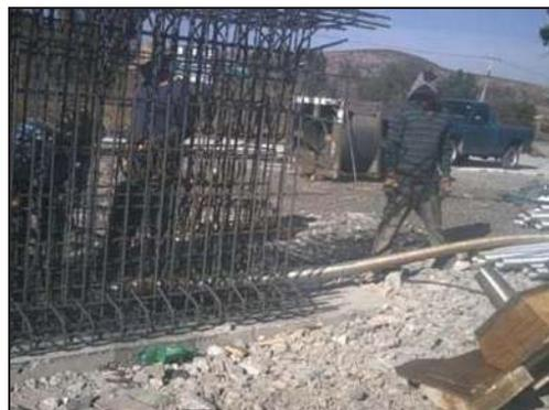
Posteriormente se introducen los ductos con los torones en su interior, colocándolos en su posición adecuada, indicada en los planos del proyecto.
