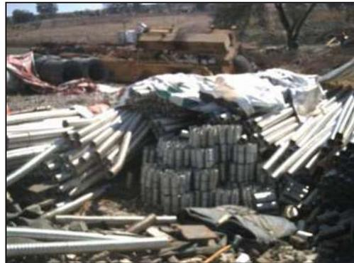
Ductos de aluminio de 4" de diámetro (10 cms) en presentación de 4 y 6 metros de longitud, así como sus respectivos coples para lograr una longitud mayor que cubra el total de la viga.
