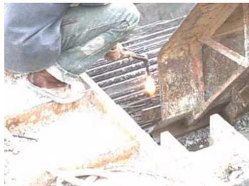
Corte de los torones de las vigas tipo IV después de descimbrarlas, es en este momento donde se transfiere el presfuerzo al concreto. El corte se realiza con un soplete a base de gas y oxígeno.
