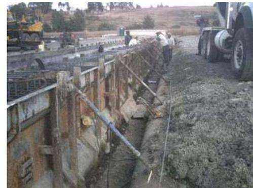
Fijación superior de la cimbra por medio de puntales metálicos, se emplean separadores metálicos insertados en orificios en la parte superior de la cimbra para mantener el ancho requerido. Posteriormente se nivela y se alinea.
