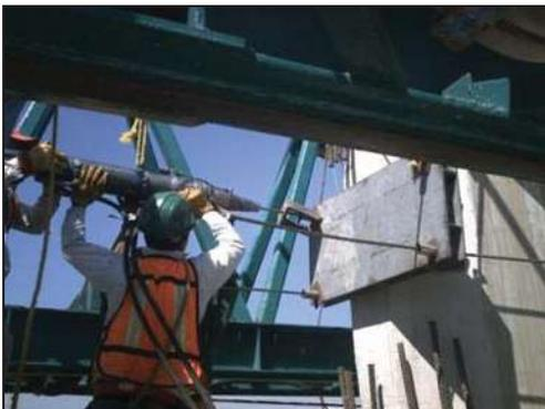
Destensado de la viga por medio del gato de tensado, ésta operación se realiza cuando la viga se encuentra encima del vehículo de carga.
