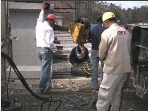
Preparación del equipo para el postensado de las vigas tipo VI, el gato para tensado es levantado con la ayuda de una grúa debido a su gran peso.
