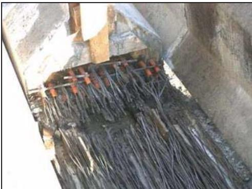
Residuos de torón producto del corte. Se observan los ductos que evitan la adherencia del torón con el concreto en el extremo.
