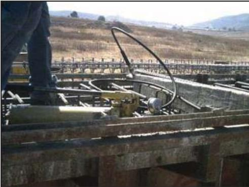
Colocación de separadores metálicos, se abre la cimbra con ayuda de una bomba hidráulica para proporcionar el ancho requerido.
