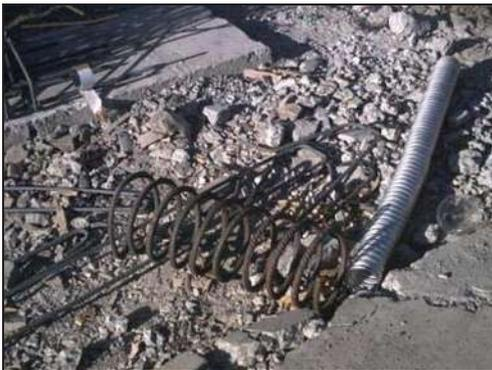
Espirales o resortes de acero que se utilizan para reforzar el presfuerzo, se colocan en el extremo del ducto por donde pasan los torones.
