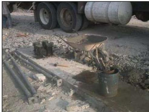
Se realiza el control de calidad del concreto; se hacen pruebas de revenimiento y fabricación de cilindros en obra para posteriormente determinar su resistencia a compresión en Laboratorio.
