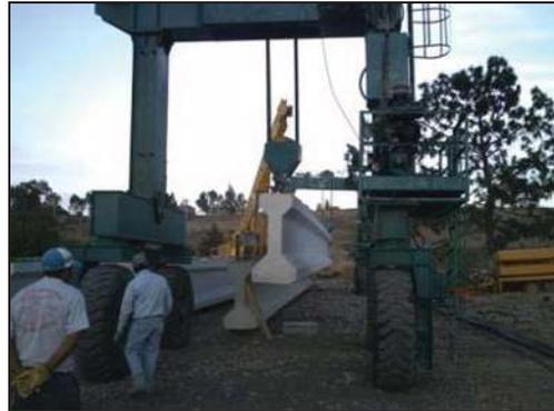
Para el izaje de las vigas tipo IV, no se requiere de aditamentos adicionales debido a su menor peso con respecto a las vigas tipo VI. Únicamente se instala un perno en la polea del pórtico que engancha a la gaza de torones que contiene la viga.
