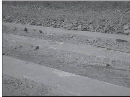
Plantillas de concreto reforzado de 12 cms de espesor, 71 cms de ancho y 45 m de longitud, se empleó concreto con un  $f'c = 150 \text{ kg/cm}^2$  reforzado con varillas del No. 3 (3/8"); se utilizan como bases para la fabricación de las vigas AASHTO tipo VI postensadas.
