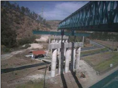
Armado del dispositivo que consta de una estructura metálica a base de módulos, pórticos y balancines o poleas de corrimiento longitudinales y de rieles que permiten el desplazamiento transversal.
