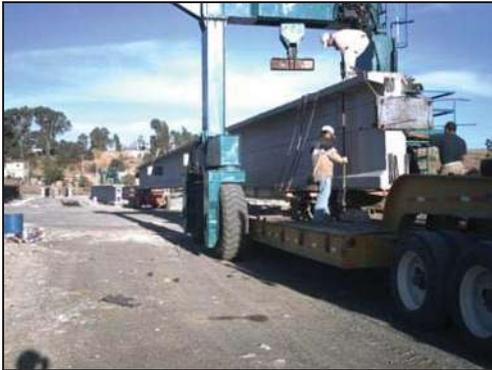
El transporte de las vigas tipo VI se realiza por medio de un tráiler auxiliado de un Dolly. Estos se colocan debajo de la viga cuando ésta se encuentra suspendida, uno en cada extremo; posteriormente se desciende la viga para colocarla encima y luego se sujeta firmemente quedando lista para ser transportada al lugar donde se requiera.
