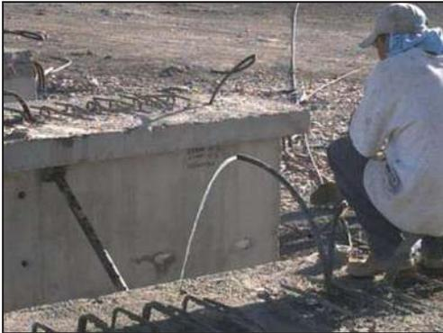
Se conecta la inyectora a un extremo de los ductos y se bombea agua saliendo por el otro extremo, esto para facilitar el posterior paso de la mezcla de cemento y agua (lechada). Se prepara la lechada con una proporción de 1:3/4 en la inyectora, que cuenta con una capacidad de tanque de 100 litros.
