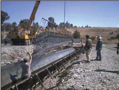
Traslado del armado de la viga a la cama de presfuerzo con la ayuda de una grúa.
