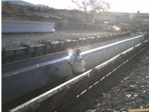
Una vez fraguado el concreto, se descimbra girando las placas metálicas, se retira la viga y se protege la cimbra con diesel, evitando la adherencia con el concreto.
