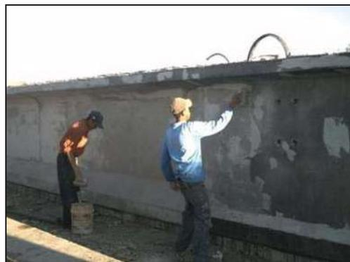
El acabado final se realiza pintando las vigas con lechada hecha con cemento gris, cemento blanco y agua, esto para darle el color deseado. Se le adiciona la membrana de curado a la lechada para su curado.
