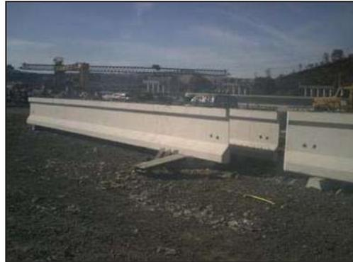
El acabado final se realiza pintando las vigas con lechada hecha con cemento gris, cemento blanco y agua. El curado se realiza con membrana de curado adicionada a la lechada.
