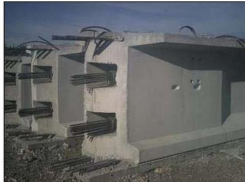
Extremo de la viga después del tensado, se observa las bases metálicas para el anclaje de los torones. Posteriormente se cortan las puntas sobrantes de torón.
