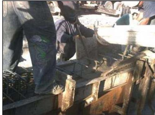
El colado de las vigas tipo IV se realiza vaciando directamente el concreto del camión mezclador por medio de las canaletas que contiene para tal fin. El vibrado empleado es el de cabeza de inmersión.
