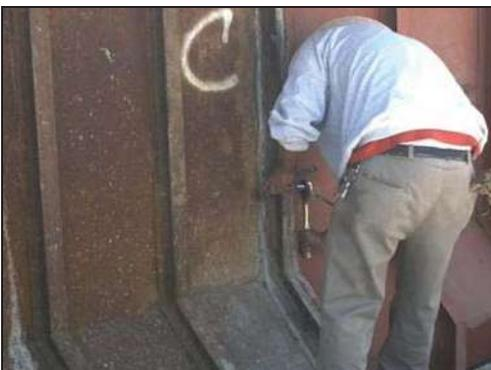
Unión de las piezas metálicas que conforman la cimbra, se realiza por medio de tornillos y tuercas.
