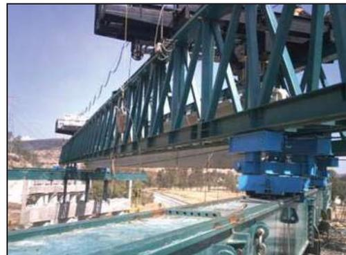
Sujeción de las traves con balancines y corrimiento longitudinal a través del dispositivo.
