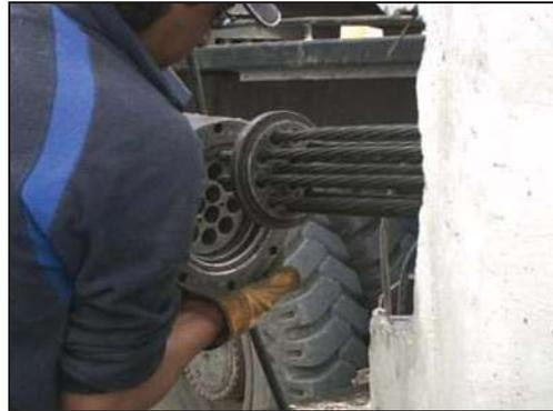
Anclajes activos o móviles que van situados en los extremos de los cables desde que se aplica la fuerza de tensado. Colocación del gato para tensado.
