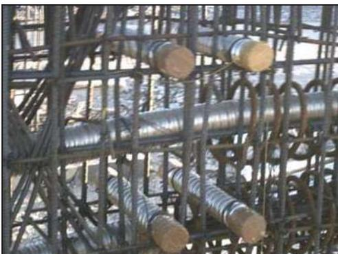
Ductos perpendiculares al eje longitudinal de la viga, sirven para colocar el acero de los diafragmas de liga, los cuales se cuelan junto con la losa.
