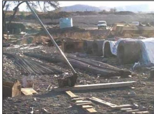
Almacenamiento de varillas según su diámetro y de los torones; la varilla se suministró en presentación recta de 12 m y el torón en rollos de peso variable; se cubren con una lona para evitar el contacto directo con el agua y evitar la corrosión.
