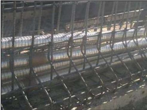
Ductos añadidos con coples colocados en el interior del armado de la viga, se observa que casi se encuentran a la misma altura debido a que son tendones parabólicos.
