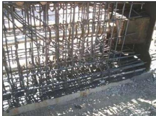
Extremo de una viga. Se observa la unión del ducto de aluminio con la placa metálica que servirá como base para el tensado; el ducto pasa por el interior del espiral de refuerzo, el cual proporciona mayor seguridad al presfuerzo.
