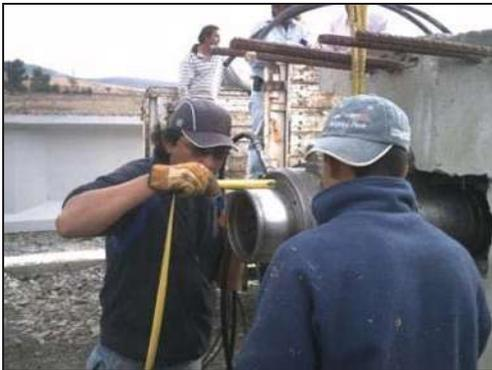
Medición y registro del alargamiento del torón por medio de un flexómetro, además se mide la presión en el aceite del gato con un manómetro en la unidad de bombeo.
