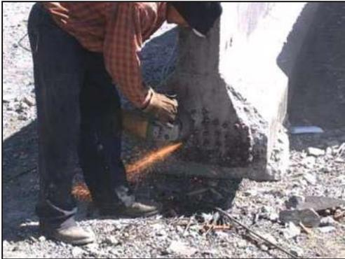
Corte de las puntas del ducto y del torón sobrante de las vigas, para su posterior resane con pasta de cemento y agua.
