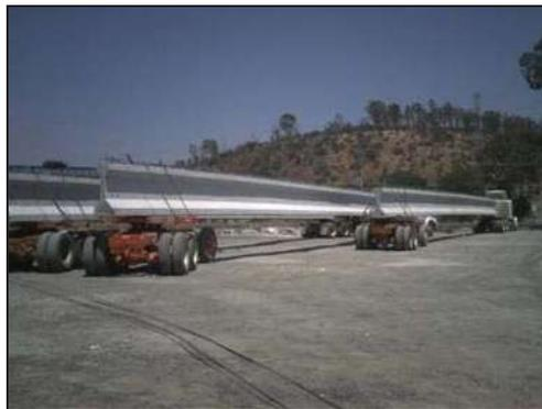
El transporte de las vigas tipo IV se realiza igualmente que las vigas tipo VI, por medio de un tráiler auxiliado de un Dolly, realizando las mismas maniobras.
