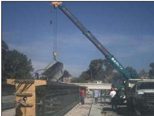
Traslado de la cimbra metálica por medio de una grúa; se observa la cimbra de madera para los extremos, la cual contiene orificios para el paso de los ductos.
