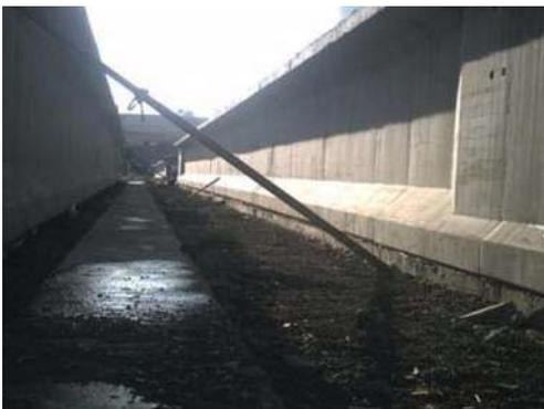
Viga tipo VI postensada terminada, se observa la contraflecha producida por el presfuerzo, aproximadamente de 4 cms en el centro.
