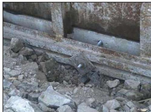
Detalle de la sujeción de la cimbra en la parte inferior, se logra con una varilla roscada que atraviesa la plantilla fijada con tuercas.
