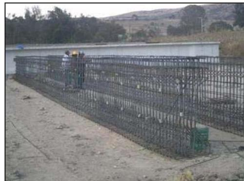
Finalmente se colocan las botellas superiores junto con el acero longitudinal superior, así como los aviones para formar el patín superior de la viga. Se adicionan pequeños bloques de concreto que sirven para proporcionar el recubrimiento.
