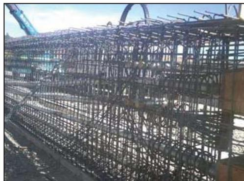
Se observa la gasa de un extremo formada por 6 torones que sirven para el izaje; así como los anclajes pasivos por adherencia o fijos, en los cuales el tensado se realiza sólo desde un extremo del cable. Se coloca un plástico entre la plantilla y la viga para evitar la adherencia con el concreto.
