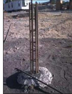
Base de varillas de acero fijadas al suelo por medio de concreto, se emplea para fabricar los espirales de acero con la ayuda de una barra (grifa) metálica.
