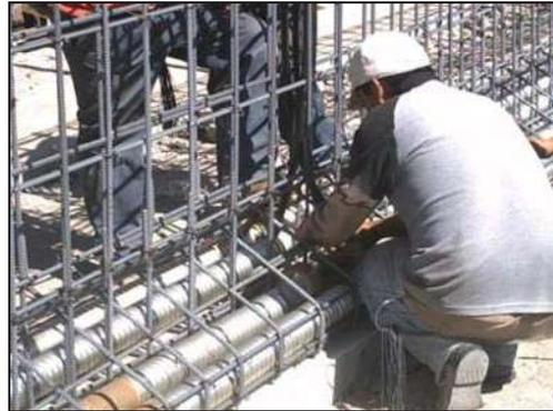
Colocación de los respiradores o ductos para la posterior inyección de la lechada de cemento y agua.
