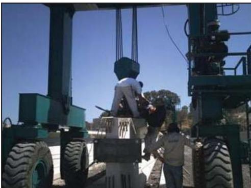
Instalación de aditamentos para el izaje de una viga tipo VI; se colocan placas en los costados de la viga y en sus extremos para tensarlas por medio de torones, esto antes de izarlas para balancearlas y evitar torceduras o que se quiebre. Se coloca un perfil de acero inferior y otro superior, unidos por dos vástagos atornillados, que son fijados a la polea del pórtico, esto en cada extremo de la viga.
