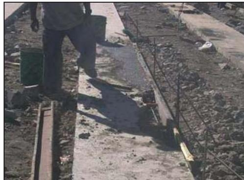
Reparación de las plantillas fracturadas durante el descimbrado y el izaje de las vigas. Se observan ductos de plástico perpendiculares al eje longitudinal de la posición de la viga, previstos para introducir por ellos una varilla de acero roscada para la fijación de la cimbra.
