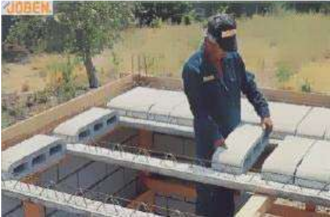
FOTO No. 8 (COLOCACIÓN DE TODAS LAS BOVEDILLAS).
