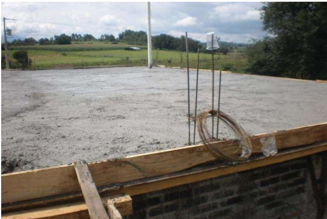
FOTO No. 4 (COLOCACIÓN DEL CONCRETO).
