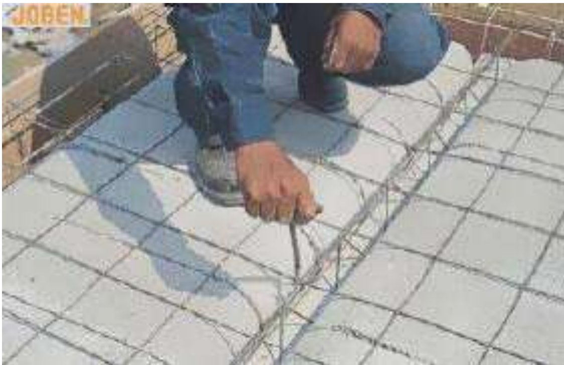
FOTO No. 9 (COLOCACIÓN Y AMARRADO DE LA MALLA ELECTROSOLDADA).
