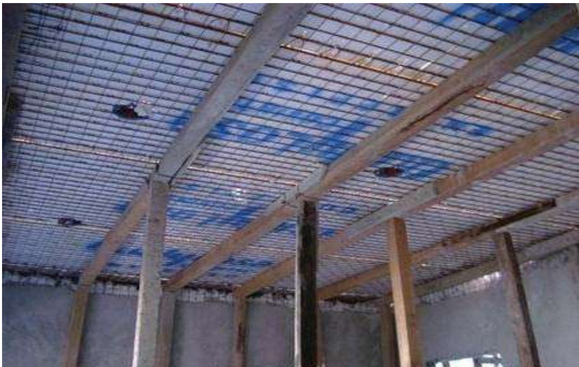
FOTO No. 16 (COLOCACIÓN DEL PANEL).
