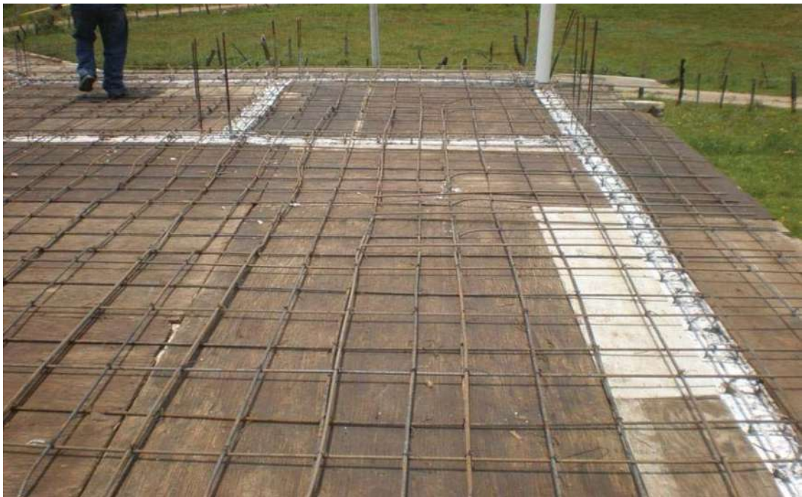
FOTO No. 2 (ARMADO DEL ACERO EN DOS DIRECCIONES).
