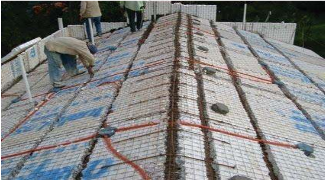
FOTO No. 19 (INSTALACIÓN ELECTRICA Y BAJADAS DE AGUA PLUVIAL).
