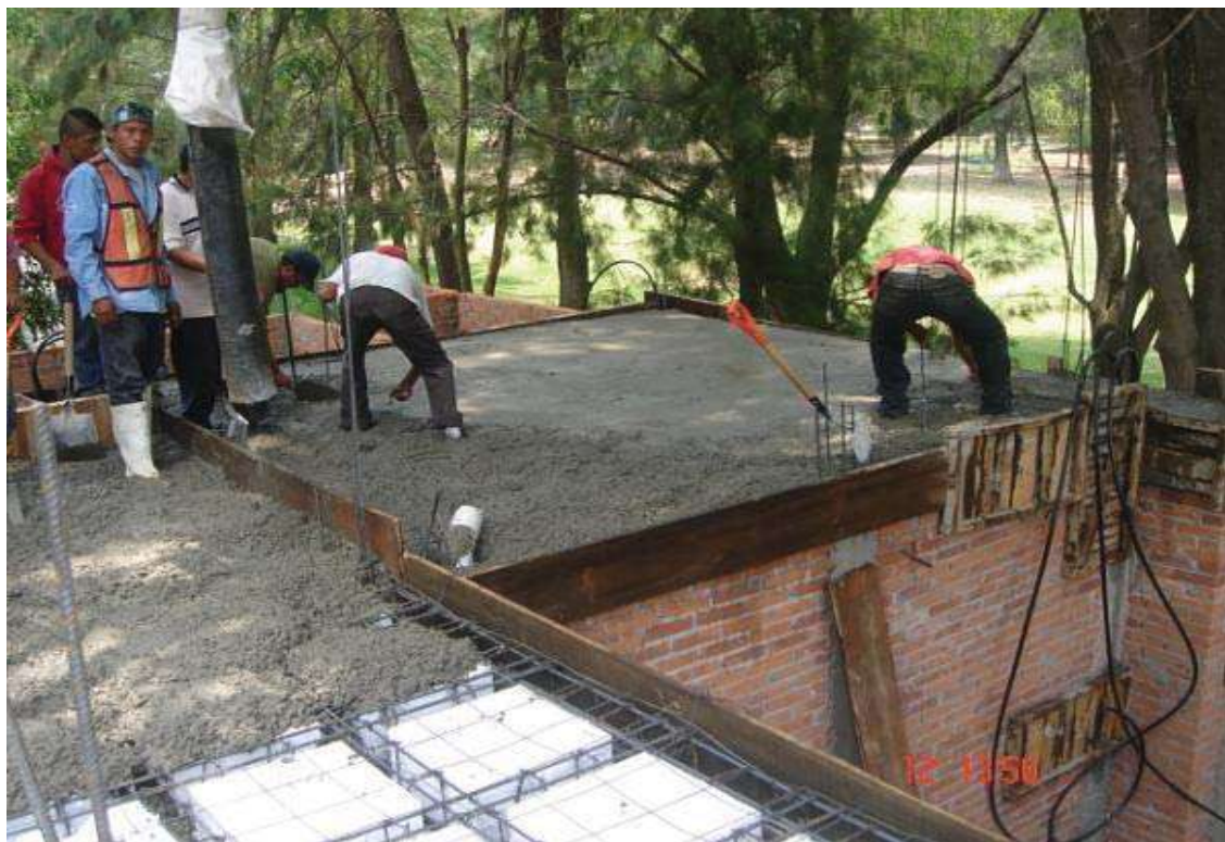
FOTO No. 13 (COLOCACIÓN DEL CONCRETO).
