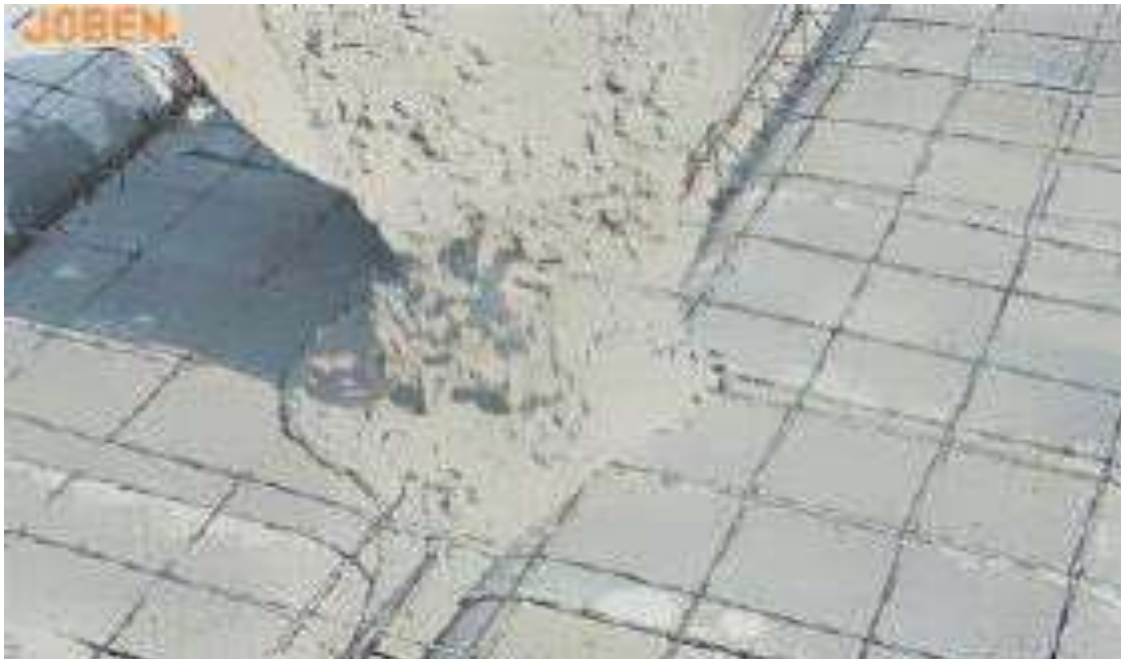
FOTO No. 10 (COLOCACIÓN DEL CONCRETO).
