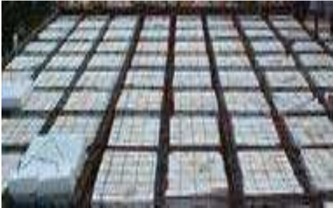
FOTO No. 12 (COLOCACIÓN DEL POLIESTIRENO).
