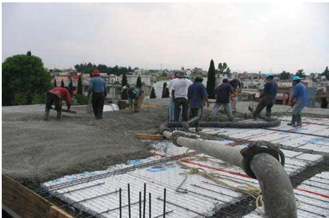
FOTO No. 20 (COLOCACIÓN DEL CONCRETO).
