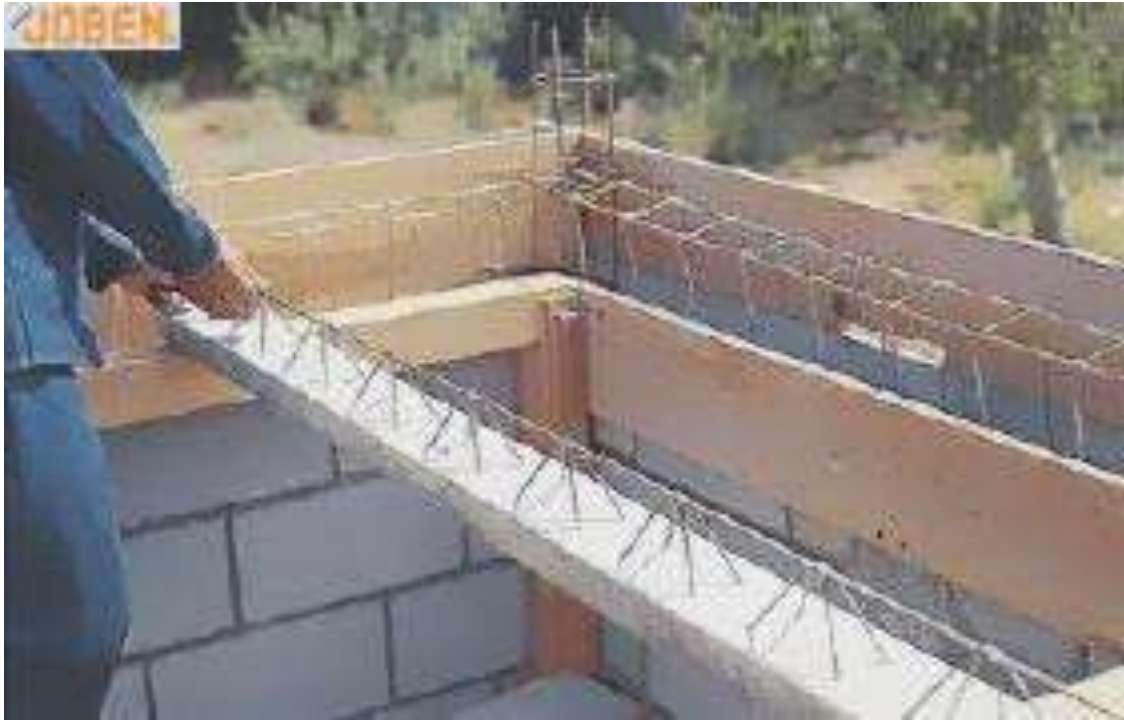
FOTO No. 6 (COLOCACIÓN DE VIGUETAS SOBRE LA CIMBRA).
