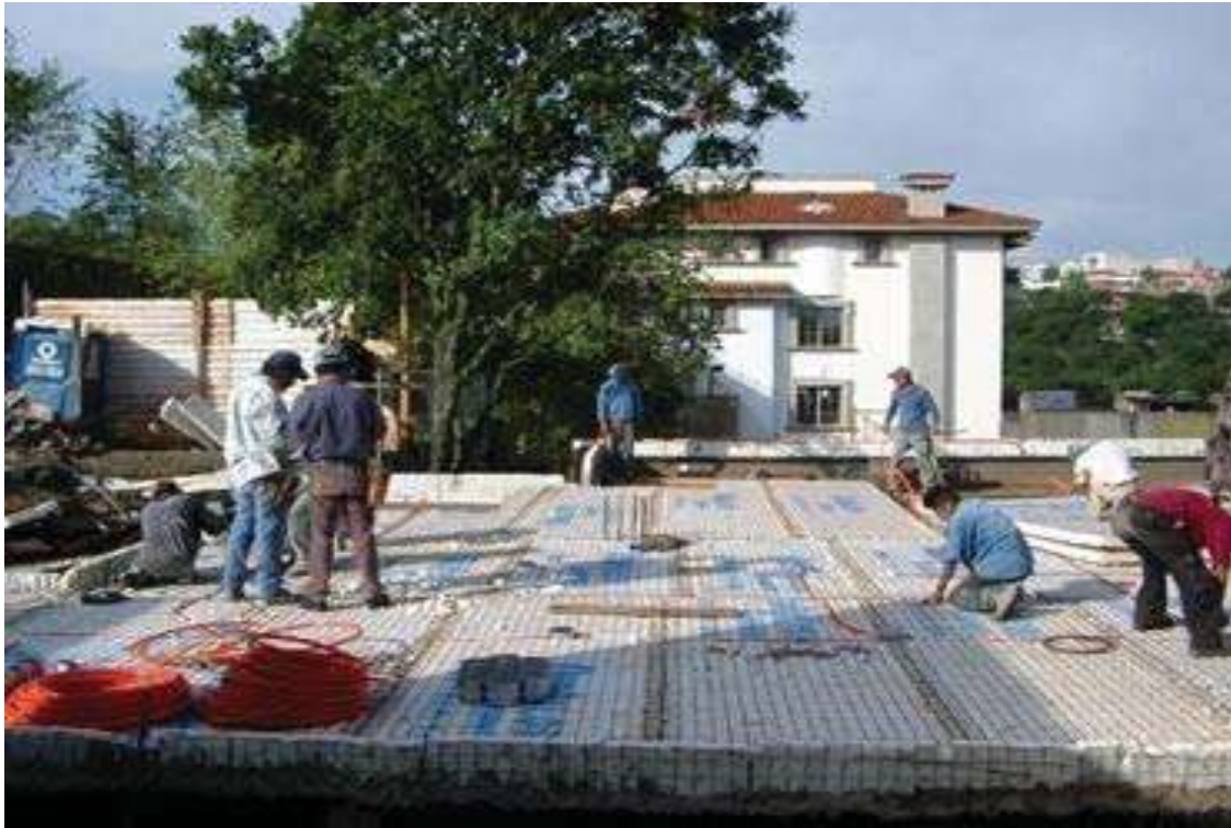
FOTO No. 17 (REFORZADO DEL PANEL A BASE DE MALLA UNIÓN).
