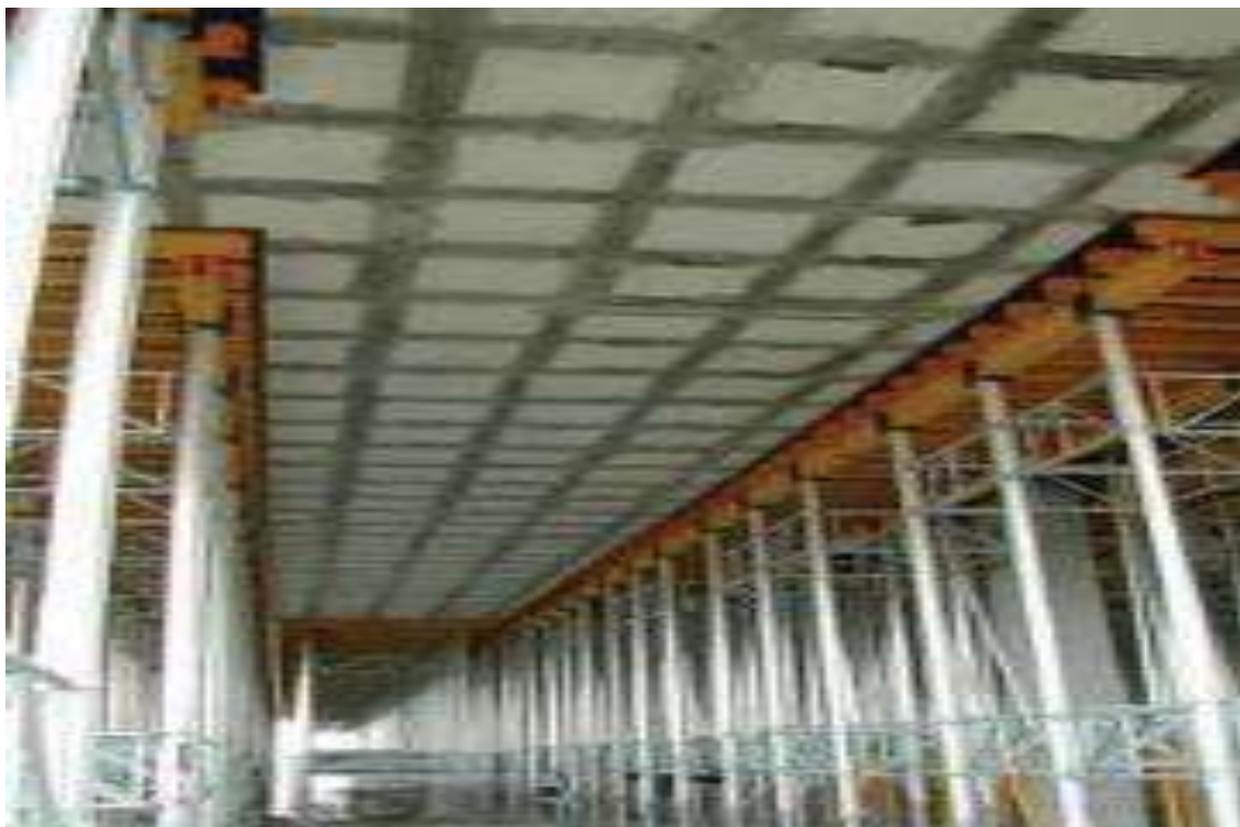
FOTO No. 11 (COLOCACIÓN DE LA CIMBRA, PUEDE SER DE MADERA O METALICA COMO EN LA IMAGEN).
