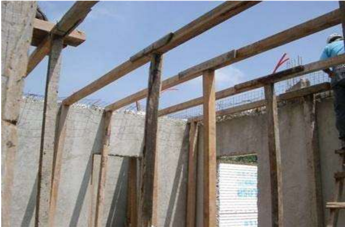
FOTO No. 15 (CIMBRA PARA LA COLOCACIÓN DEL PANEL).
