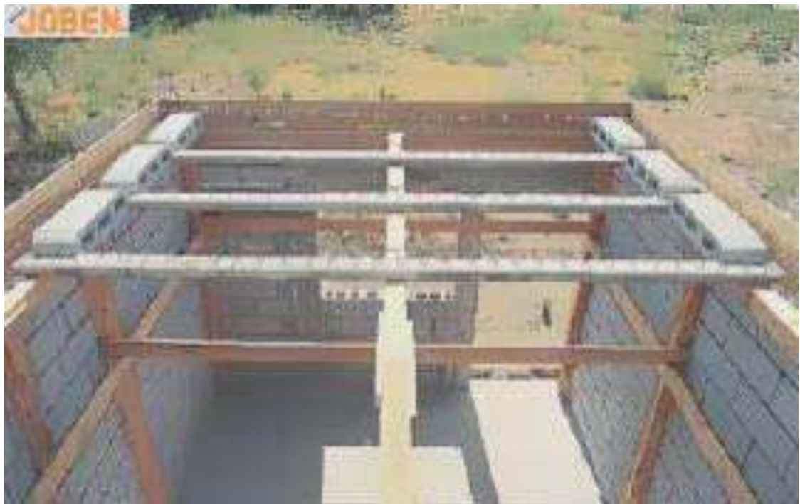
FOTO No. 7 (COLOCACIÓN DE BOVEDILLAS EN LOS EXTREMOS PARA SEPARAR LAS VIGUETAS).
