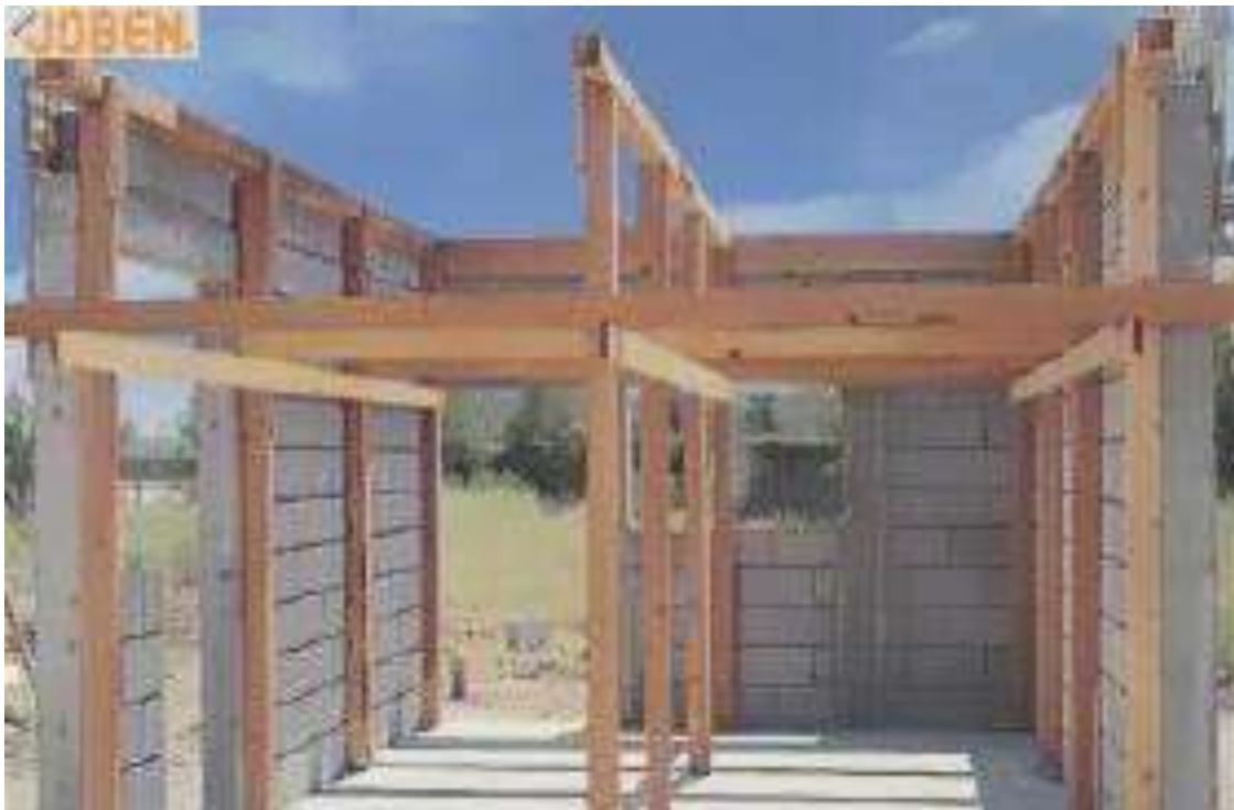
FOTO No. 5 (CIMBRA PARA LA POSTERIOR COLOCACIÓN DE VIGAS).
