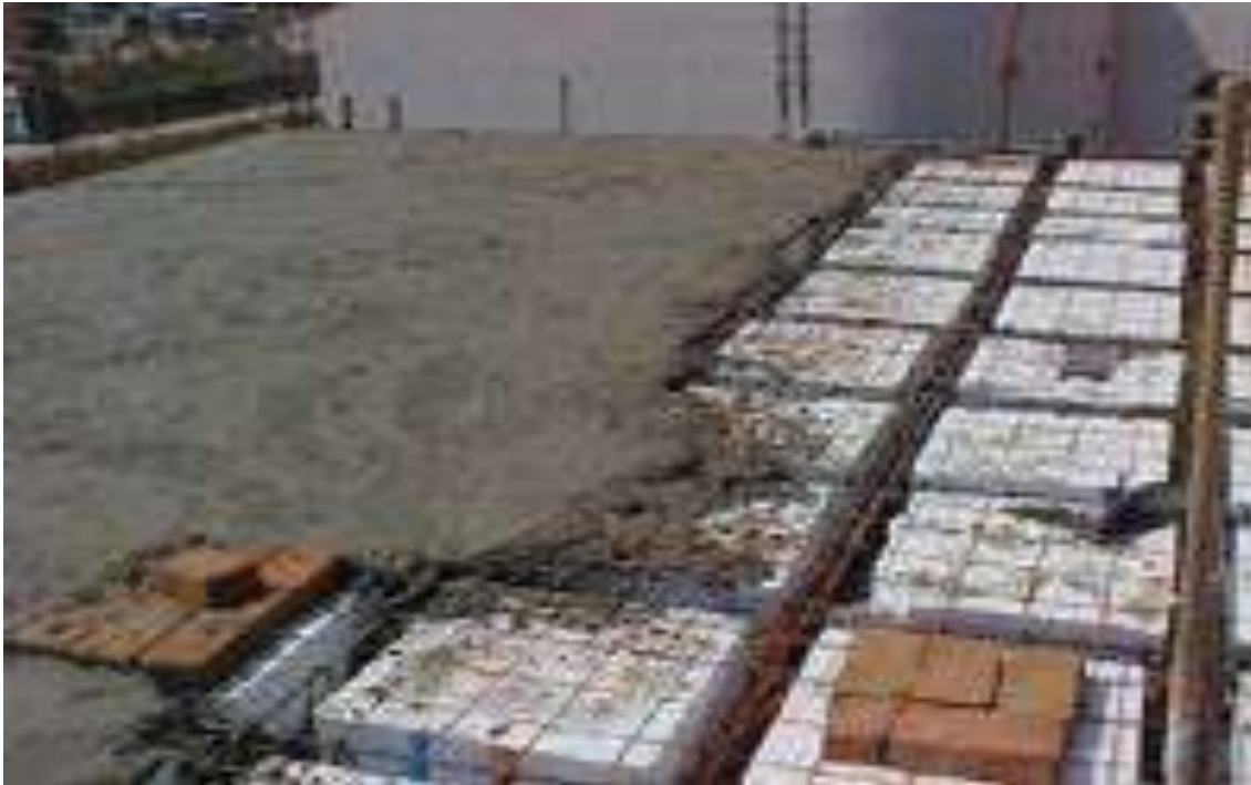
FOTO No. 14 (COLOCACIÓN DEL CONCRETO).
