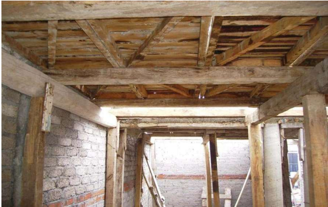
FOTO No. 1 (CIMBRA PARA SOSTENER EL CONCRETO).
