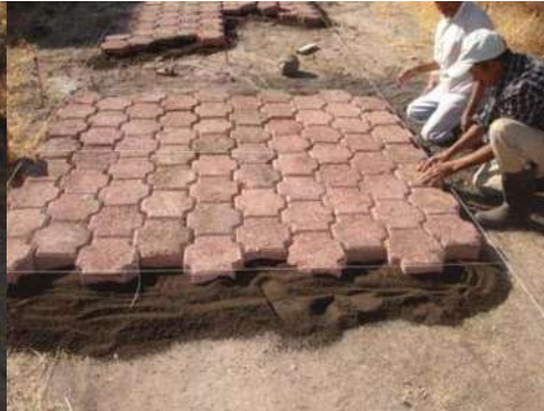
Imagen 10 Colocación transversal de adocreto
