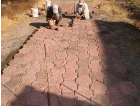
Imagen 9 Colocación longitudinal de adocreto
