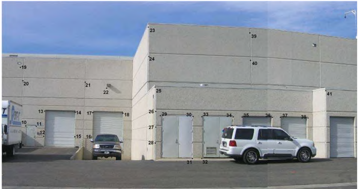
Figura 4-4. Vértices de Estructura con Coordenadas ECEF
