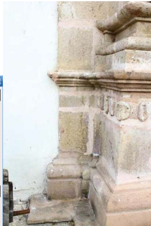
Figuras 33(izquierda) y 33-A(derecha) FI que muestra variaciones de humedad en diferentes alturas. Obsérvese la calidad de la superficie en la fotografía derecha. FI: Autor; FD: Jocelyn Alvarez A.
