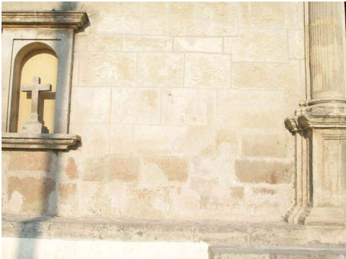
Figuras 40 (arriba) y 40-A (sobre estas líneas) Diferencia de temperaturas en sillares de un mismo elemento. Obsérvese el cambio de color en la FD. Fotografías: autor.
