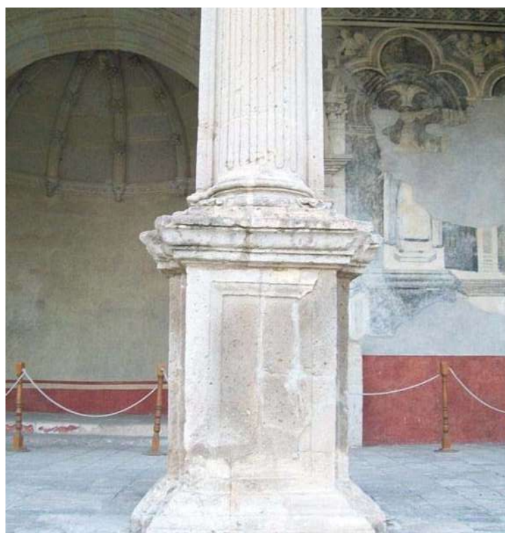
Figuras 38 (arriba izquierda), 38-A (arriba derecha) y 38-B (sobre estas líneas) Observe el fenómeno similar al de la serie de fotografías anteriores. En este caso es posible observar el conjunto de restauraciones que ha recibido el pedestal en su conjunto. Fotografías: autor
