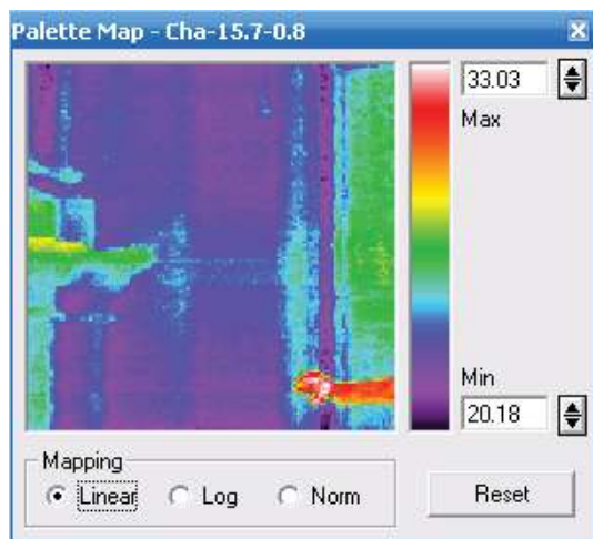
Figura 28 FI que exhibe una mayor uniformidad de temperatura en los sillares del muro, únicamente variante en la junta debido al cambio de material en ella. FI: Autor
