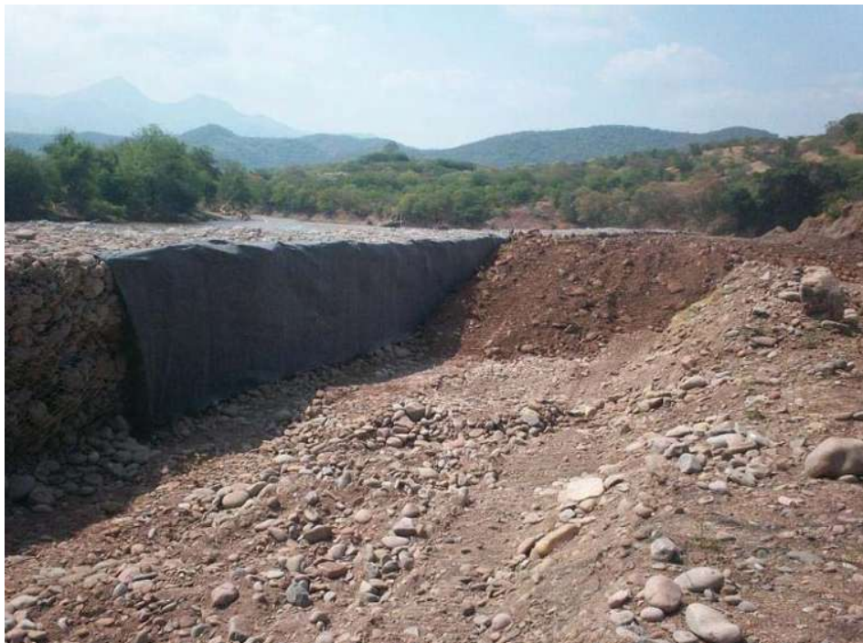
V.2.3.- Imagen 44.- vista de la instalación de geotextil
