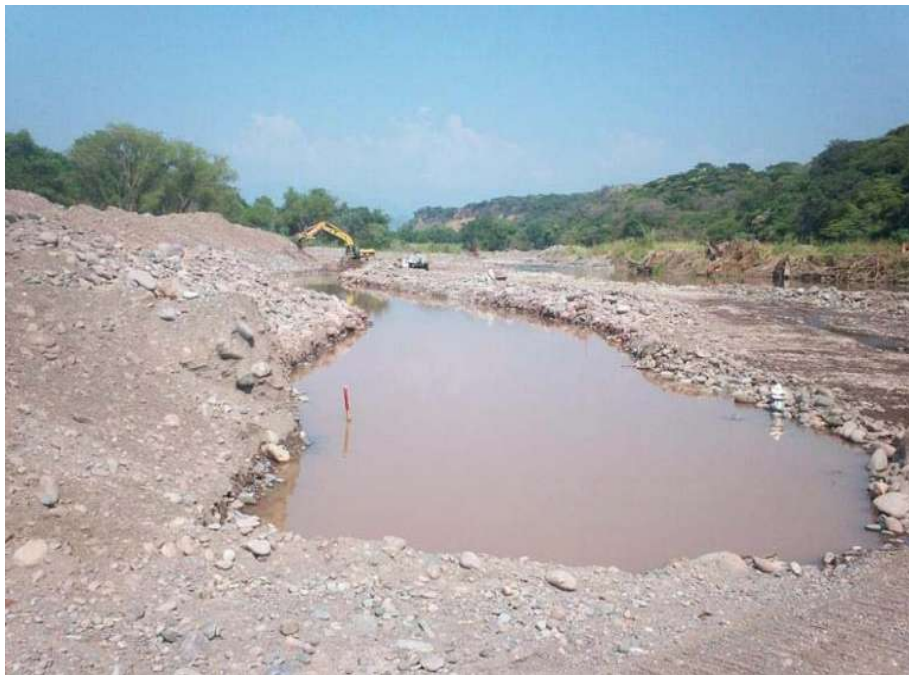
III.2.3.3.- Imagen 3.- Excavación en material tipo II
