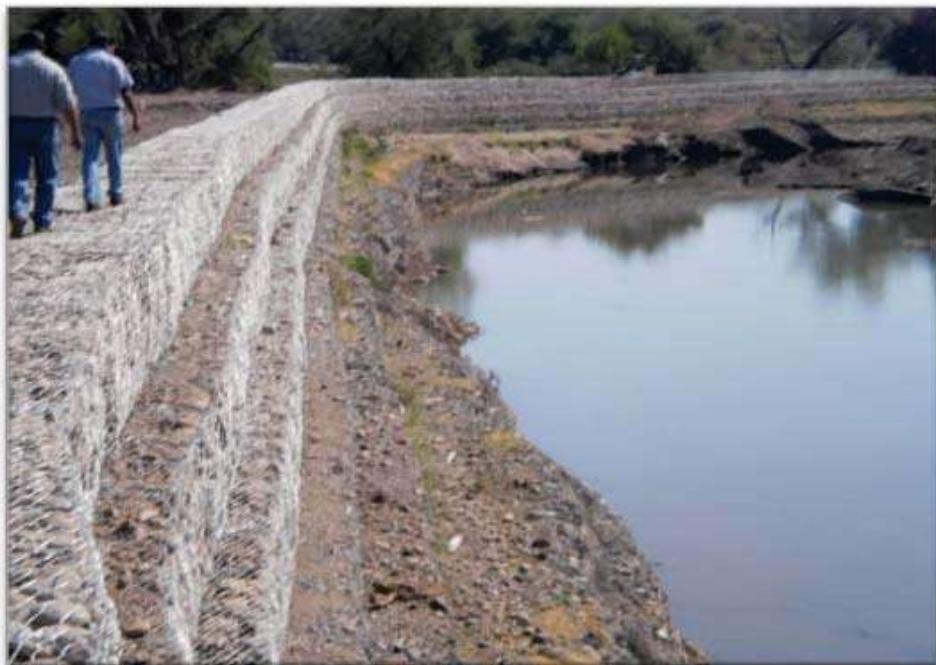
V.4.3.- Imagen 71.- Muro de gavi3n terminado
