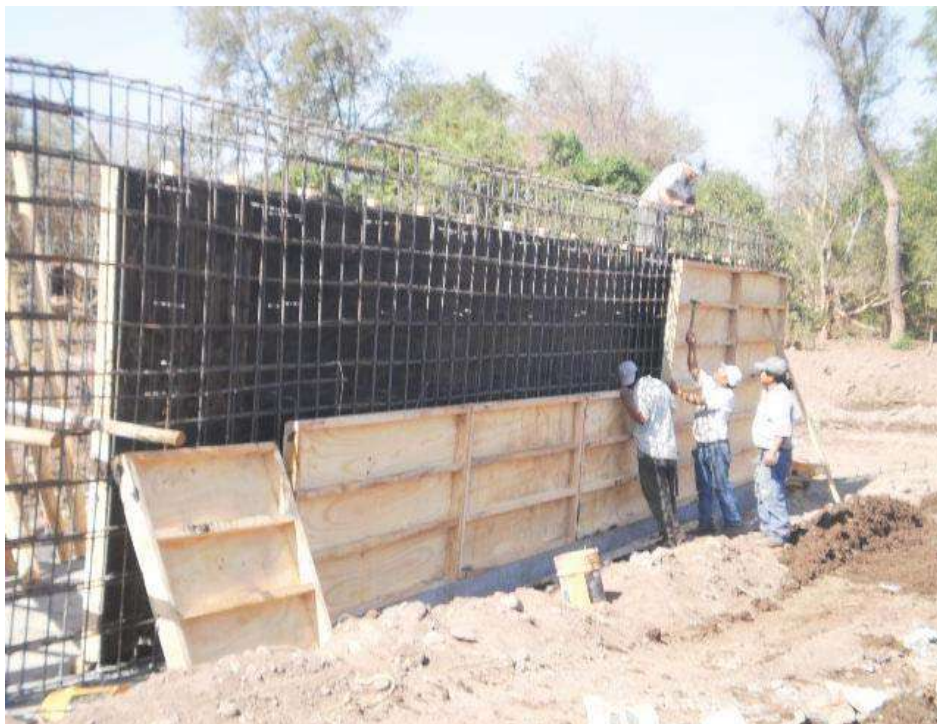
V.3.3.- Imagen 54.- Cimbrado de los muros de la estructura de descarga
