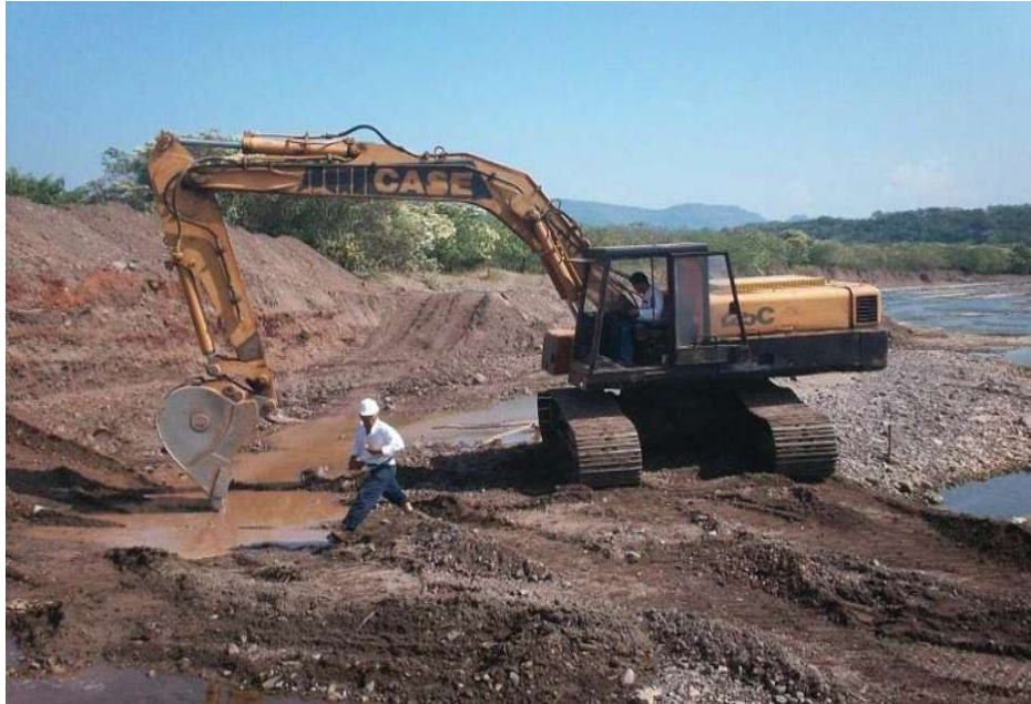
V.2.3.- Imagen 33.- Excavación con equipo para desplatar muro de gavión
