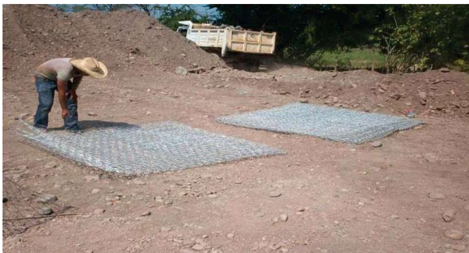
V.1.3.- Imagen 29.- Suministro de malla para armar gaviones
