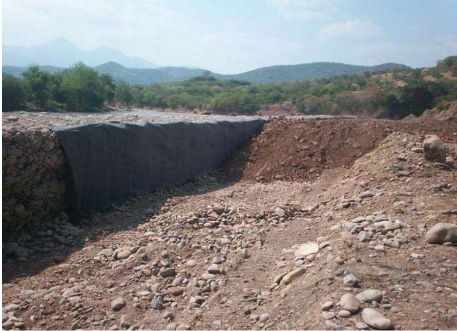
V.2.3.- Imagen 37.- Formación de terraplén compactado para bordos
