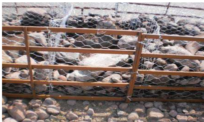
III.2.8.4.4.- Imagen 23.- Relleno
