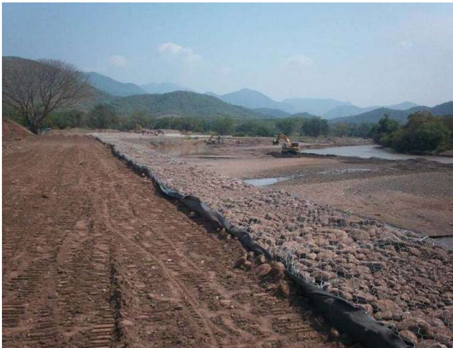
V.4.3.- Imagen 64.- Verificación de terraplén compactado, geotextil y muro de gavión
