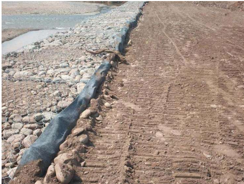
V.4.3.- Imagen 63.- Verificación de terraplén compactado
