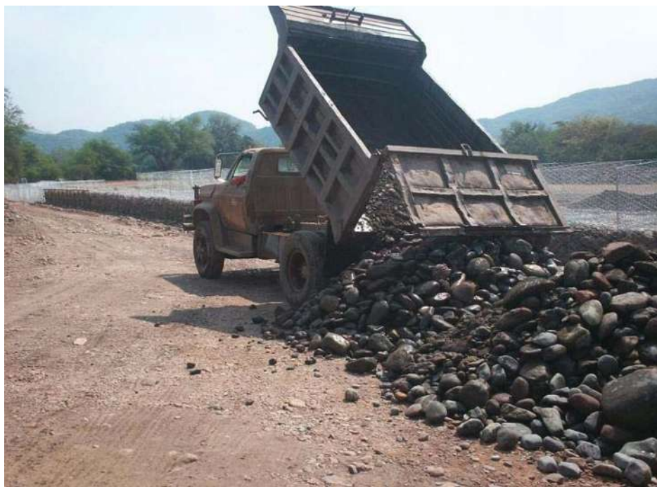
V.2.3.- Imagen 36.- Material roca para el llenado de gaviones
