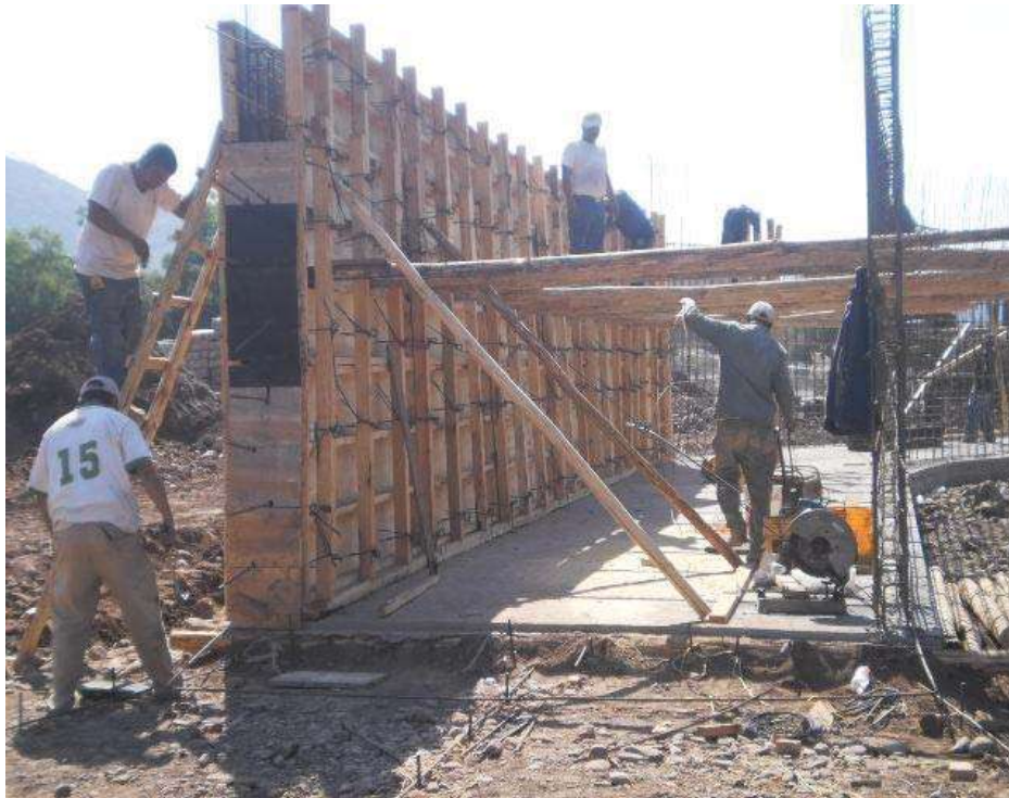
V.3.3.- Imagen 55.- Cimbrado y nivelación de los muros de la estructura de descarga
