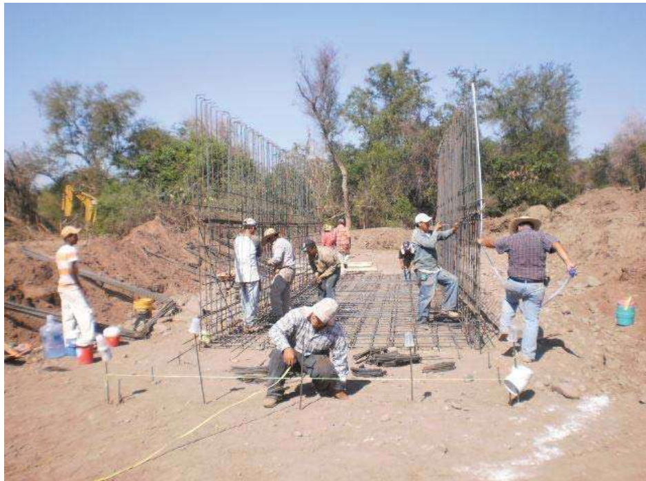
V.3.3.- Imagen 53.- Habilitado y continuación del trazo de la estructura de descarga
