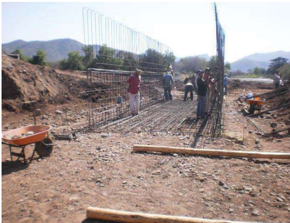
V.3.3.- Imagen 52.- Habilitado de acero para la formación de la estructura de descarga
