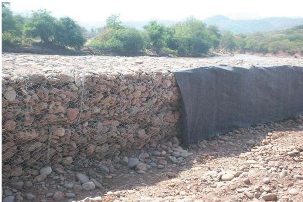
III.2.9.A4.4.2.-Imagen 26.- colocación del geotextil
