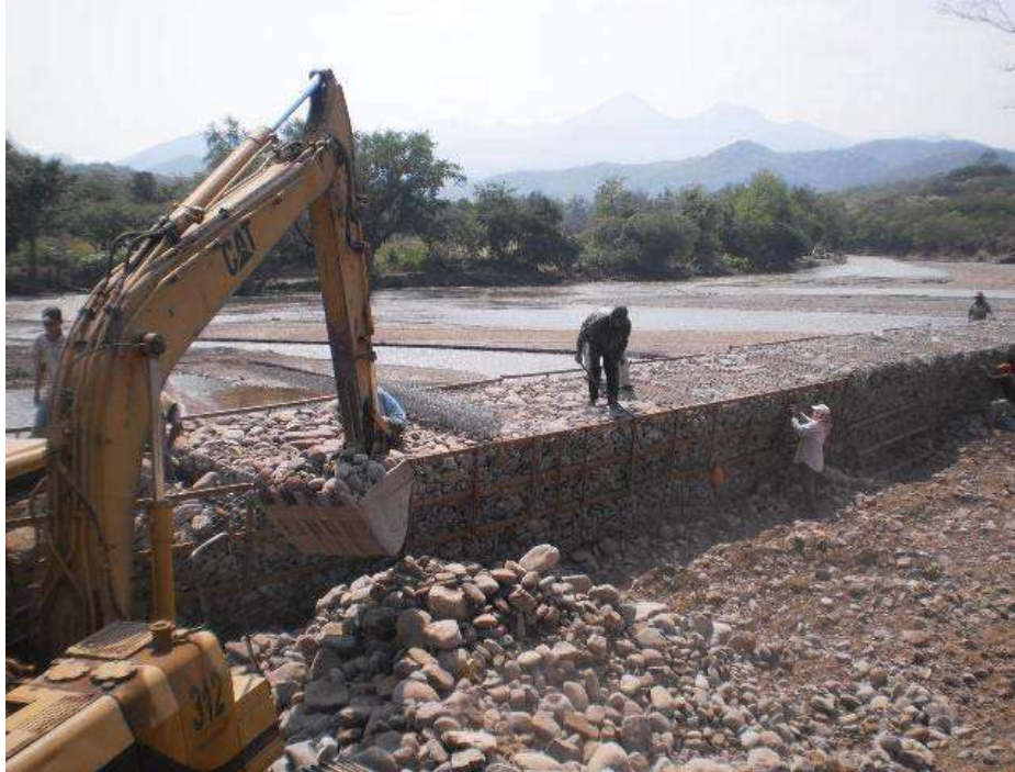
V.3.3.- Imagen 51.- Llenado con roca para formar platea de gavión
