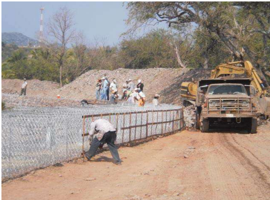
V.1.3.-Imagen 31.- Desplante del primer nivel de plateas, estación 0+500
