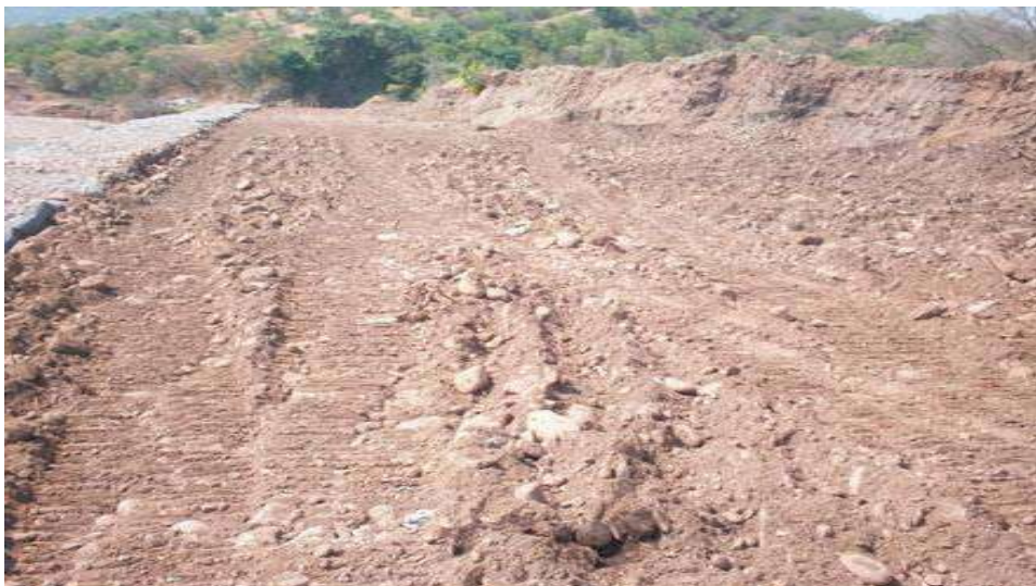
III.2.6.6.-Imagen 10.- Compactación de Terraplenes
