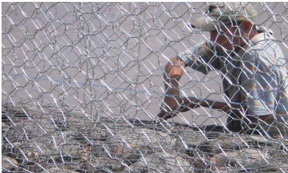
III.2.8.4.3.- Imagen 22.- Amarre de los gaviones
