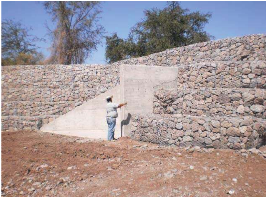
V.4.3.- Imagen 67.- Verificación de muros de concreto de estructura de descarga
