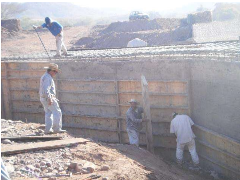
V.3.3.- Imagen 56.- Descimbrado de los muros de la estructura de descarga
