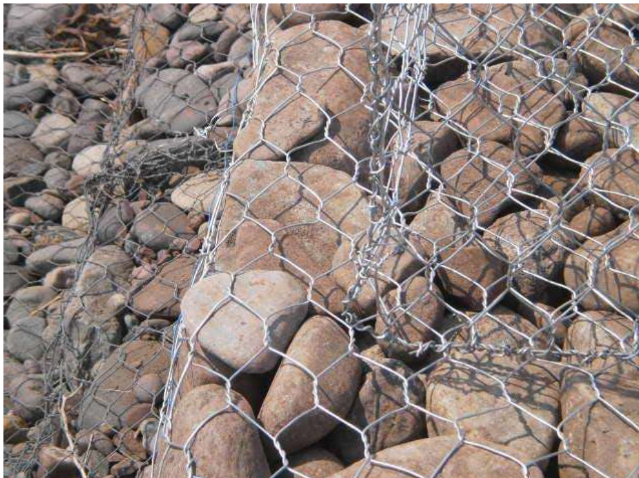
V.2.3.- Imagen 42.- Amarres de las cajas de gavión
