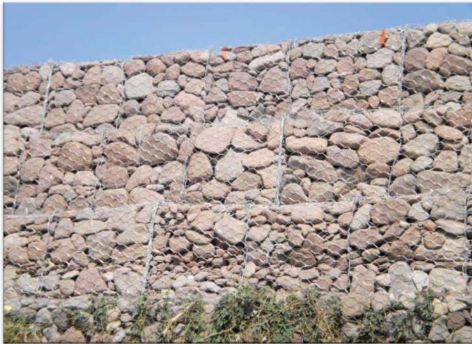
V.4.3.- Imagen 65.- Infraestructura de muro de gavión 2ª etapa
