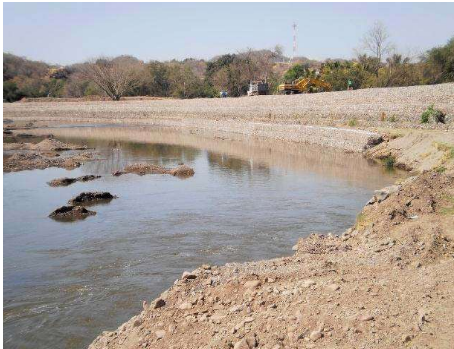
V.4.3.- Imagen 71.- Final de muro de gavi3n terminado margen derecha del R3o Tiquicheo
