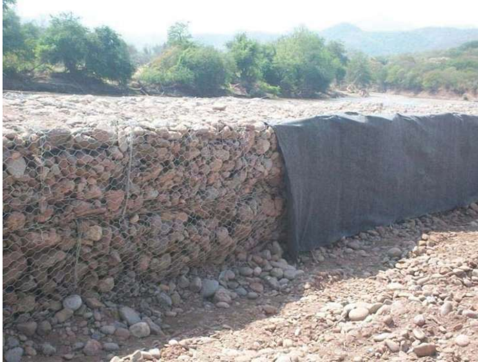
V.2.3.- Imagen 43.- Instalación de geotextil
