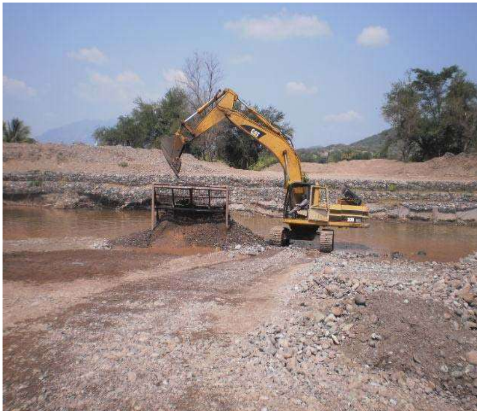
V.3.3.- Imagen 45.- Selección de roca para el cribado
