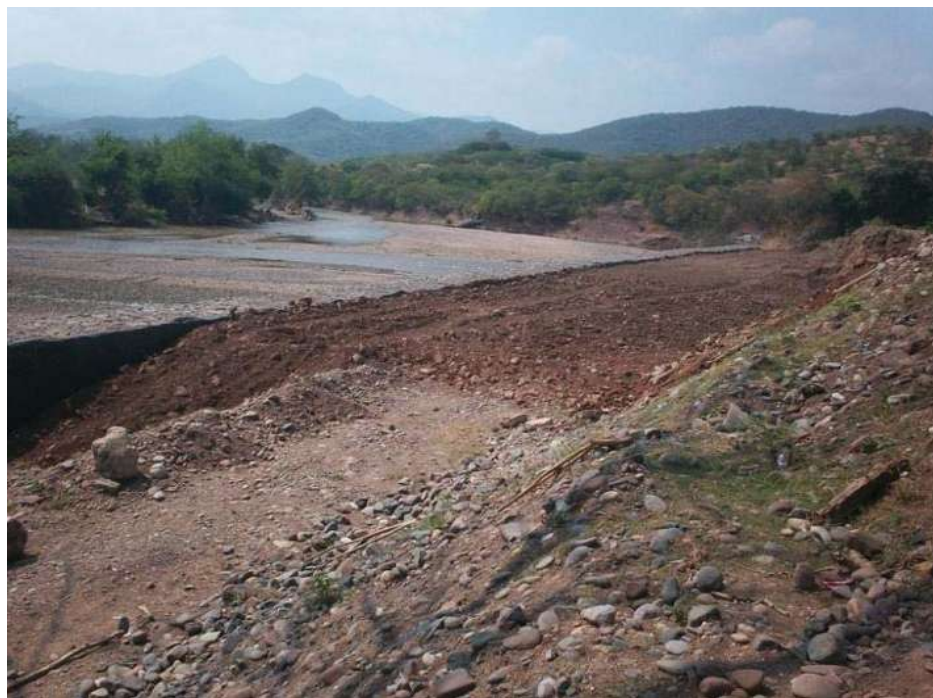
V.4.3.- Imagen 62.- Formación de terraplén compactado
