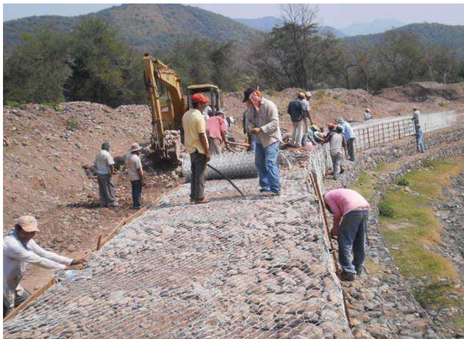
V.3.3.- Imagen 49.- Verificación de amarres, cimbrado y colocación de tensores
