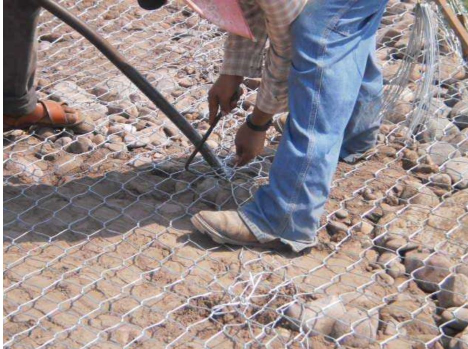
V.3.3.- Imagen 50.- Amarre y tensado de la tapa del gavión
