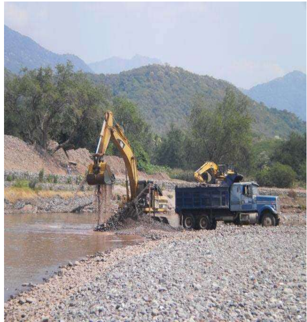
III.2.4.- Imágenes 5 y 6.- Cribado para selección de roca de canto rodado
