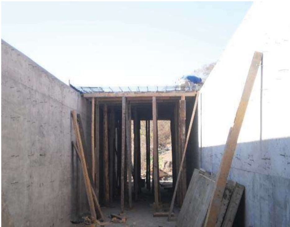
V.3.3.- Imagen 57.- Cimbrado y armado de acero para la losa de la estructura de descarga
