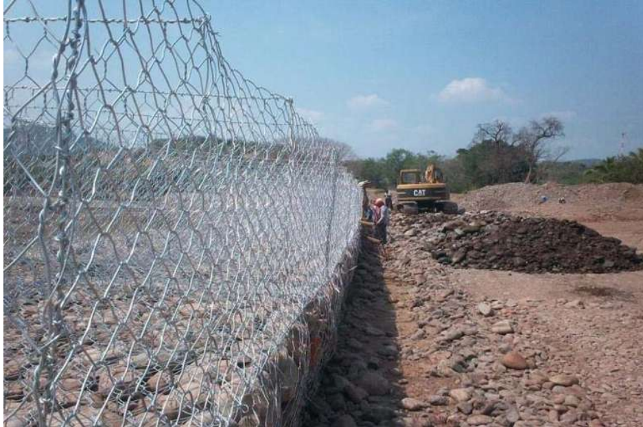
5.1.3.-Imagen 32.- Instalación del gavión
