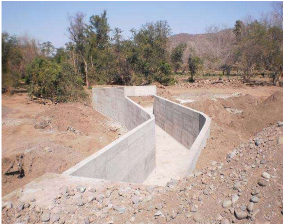
V.4.3.- Imagen 68.- Estructura de descarga
