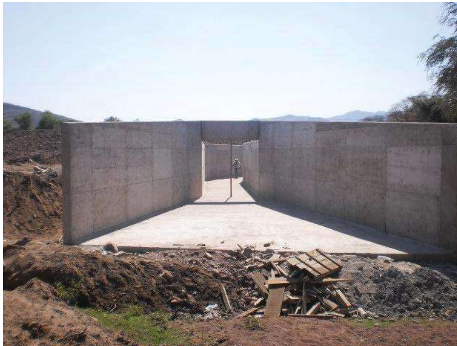
V.4.3.- Imagen 69.- Entrada de la estructura de descarga
