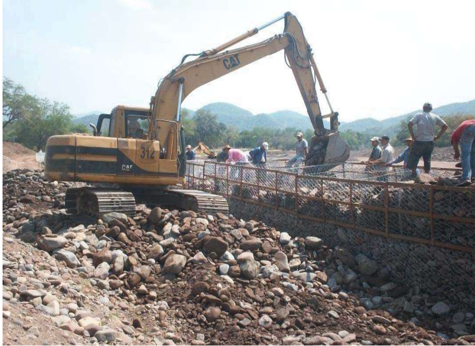
V.1.3.-Imagen 30.- Desplante del primer nivel de plateas, estación 0+400
