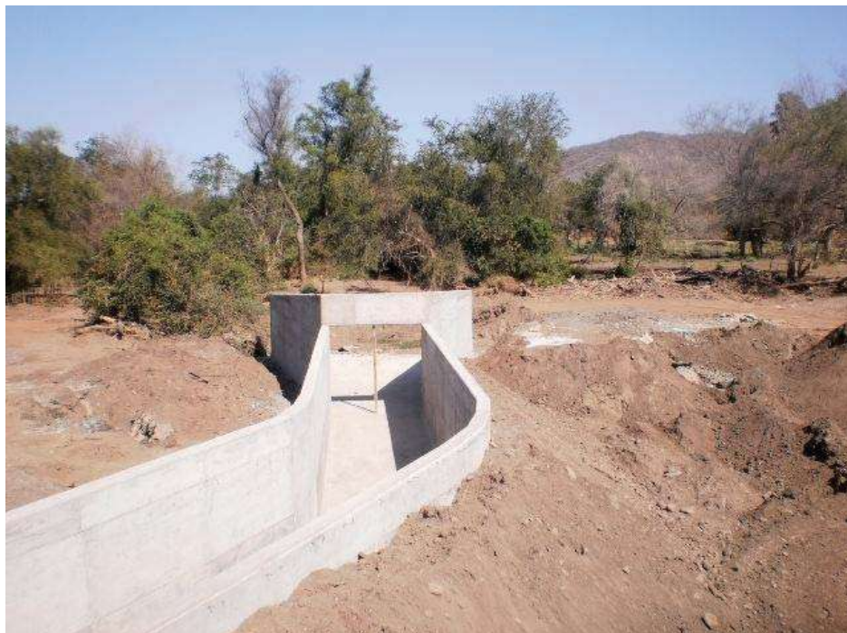
V.4.3.- Imagen 66.- Estructura de descarga margen derecha del Río Tiquicheo
