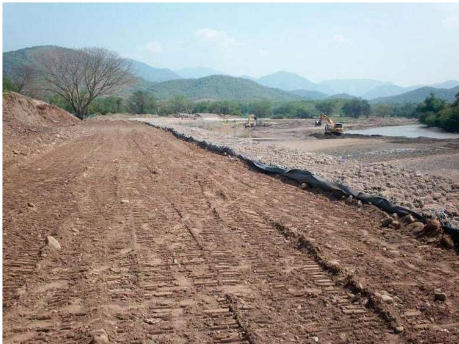
V.2.3.- Imagen 40.- Formación de terraplén compactado para bordos
