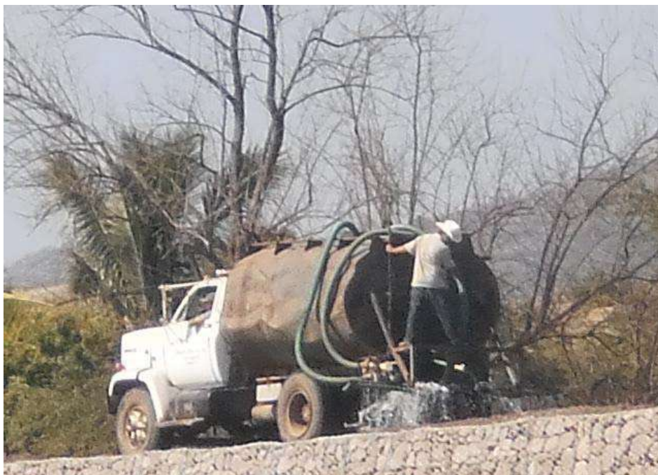
V.3.3.- Imagen 47.- Tratado del material del terraplén para que cumpla con la humedad óptima
