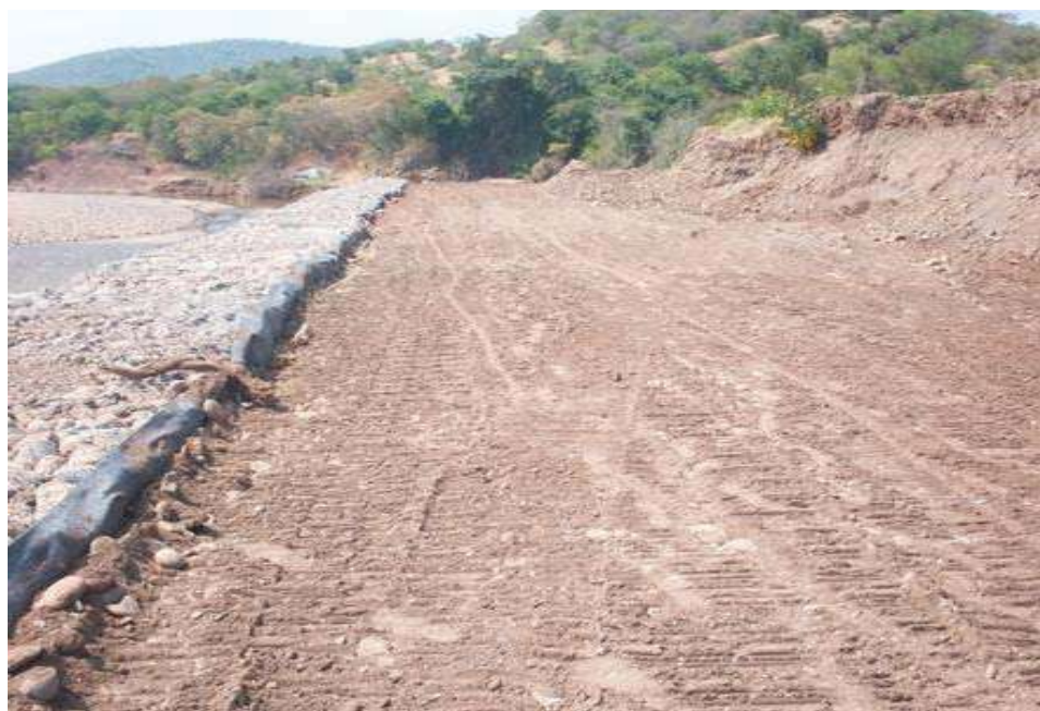
III.2.6.6.-Imagen 12.- Terraplenes compactados-2
