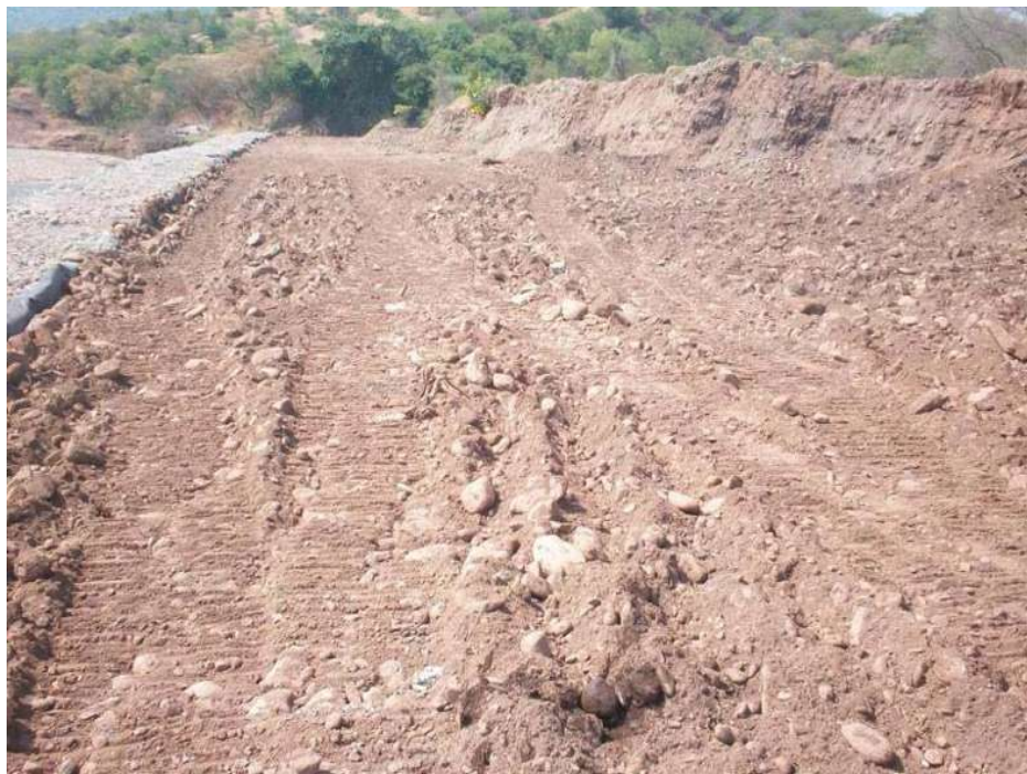
V.2.3.- Imagen 38.- Formación de terraplén compactado para bordos
