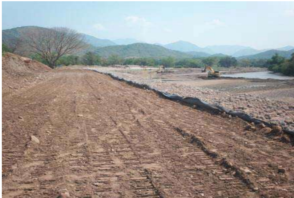
III.2.6.6.- Imagen 11.- Terraplenes Compactados-1
