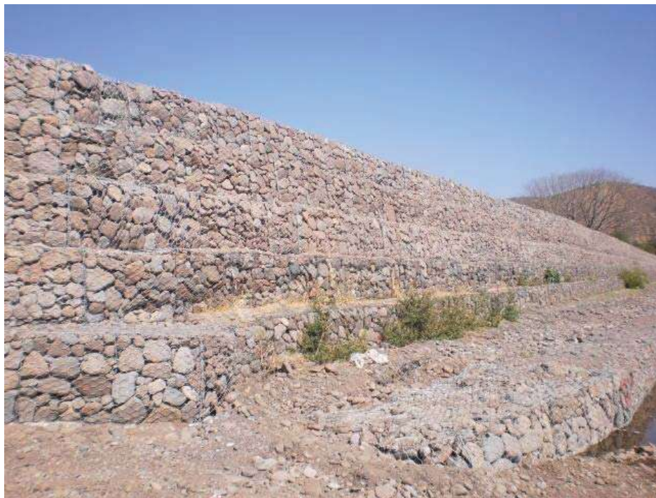
V.4.3.- Imagen 70.- Inicio de muro de gavión terminado, margen derecha
