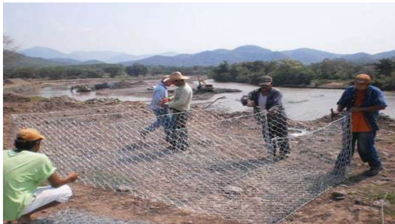
III.2.8.3.4.- Imagen 19.- amarre de la red de gaviones
