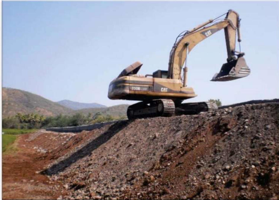
V.2.3.- Imagen 39.- Bando del material para la formación de terraplén compactado
