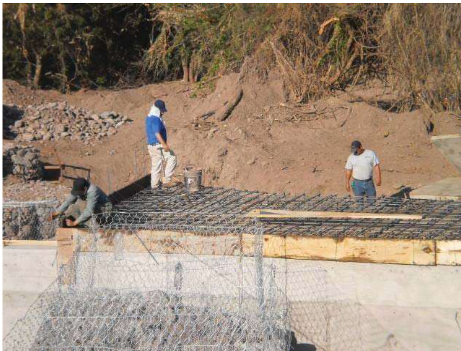
V.3.3.- Imagen 58.- Armado de acero para la losa de la estructura de descarga
