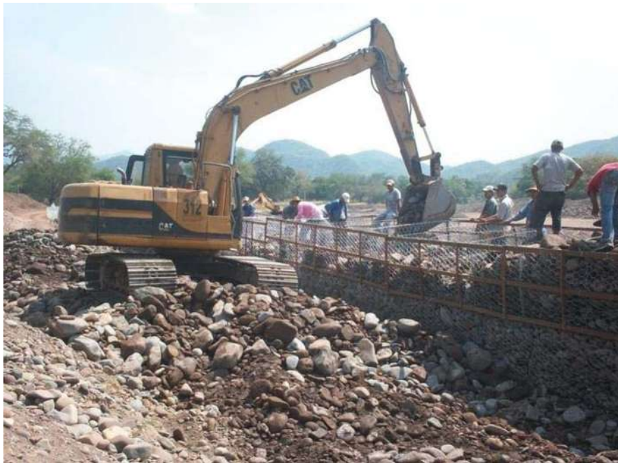
III.2.8.4.4.- Imagen 24.- Relleno
