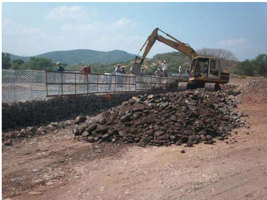
V.3.3.- Imagen 50.- Llenado de las cajas para gavión
