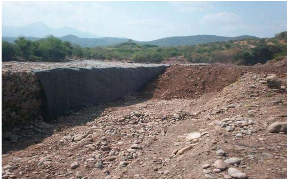
III.2.9.A4.4.2.- Imagen 27.- colocación del geotextil
