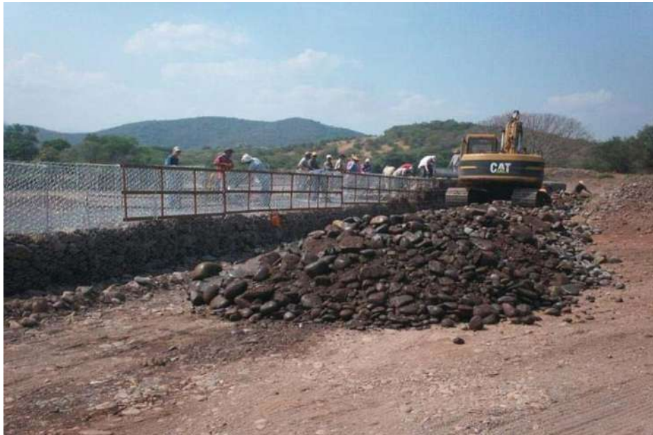
V.4.3.- Imagen 61.- Llenado con roca para formar platea de gavión
