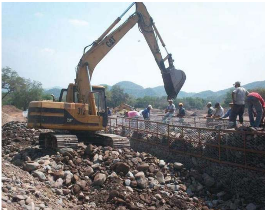
III.2.8.4.4.- Imagen 25.- Relleno
