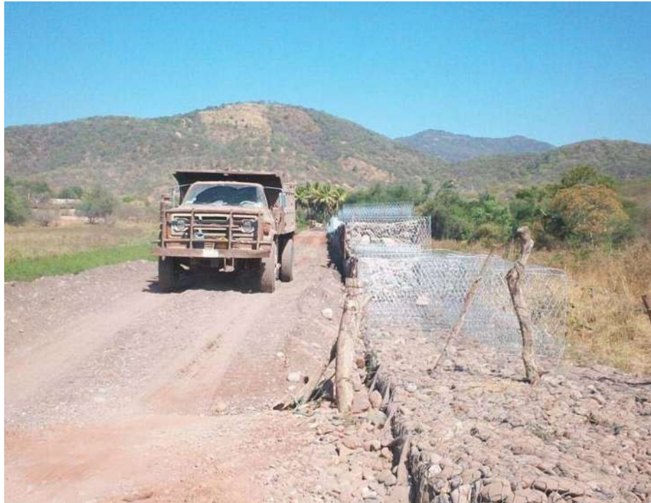
V.2.3.- Imagen 41.- Acarreo de materiales para la formación del terraplén
