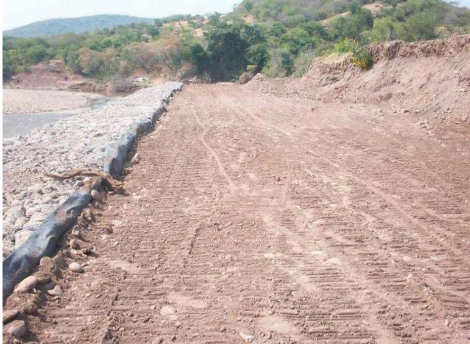
V.3.3.- Imagen 46.- Terraplén compactado
