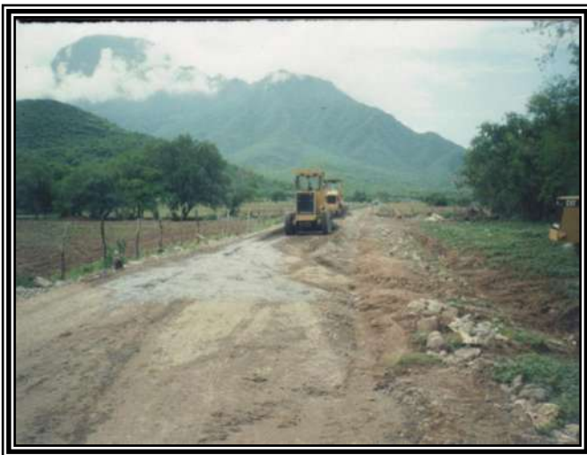
Mezclando cemento con suelo
