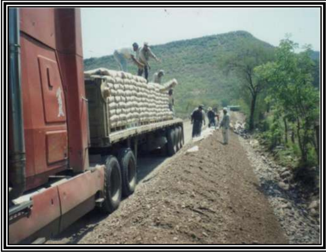
Suministro del cemento
