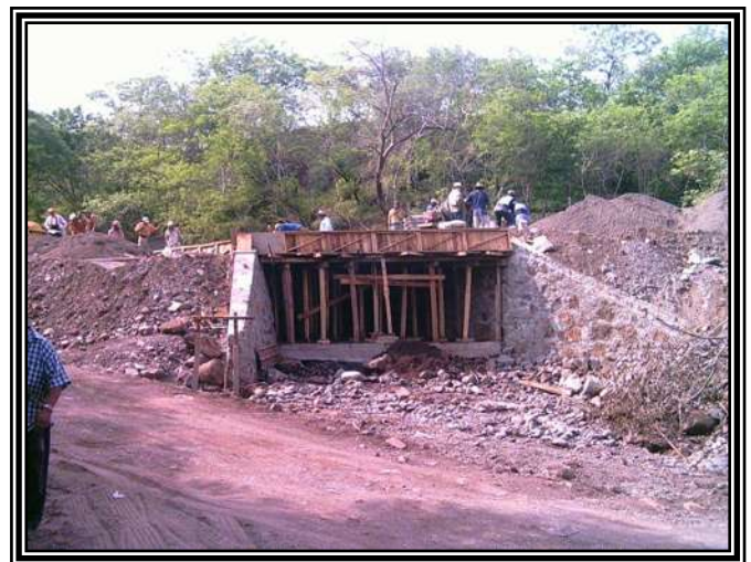
km 4+069 de losa
