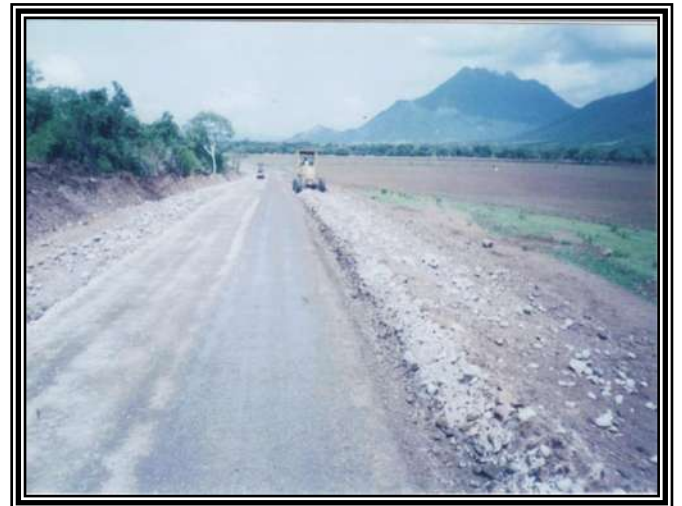
Arrope con motoconformadora
