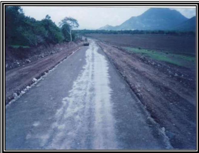
Compactando con humedad
