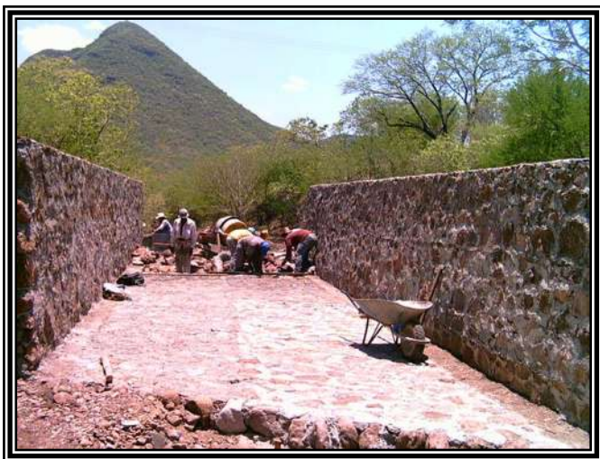
Km 4+951 de losa
