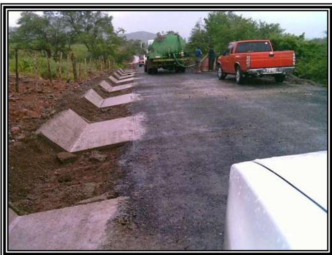
Revestimiento de cunetas
