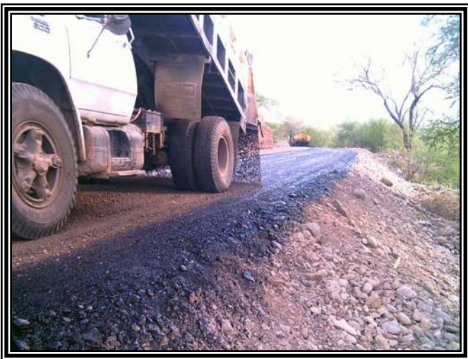
Riego de impregnación
