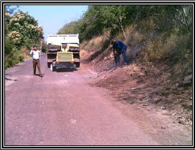
Barrenacion en área cunetas
