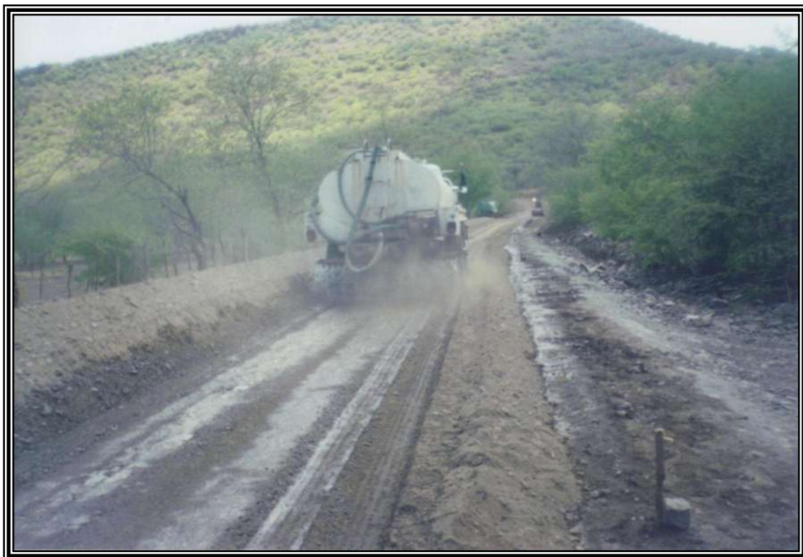
SUMINISTRO DE AGUA A LA MEZCLA SUELO-CEMENTO
