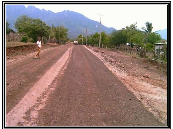
riego de impregnación poreado
