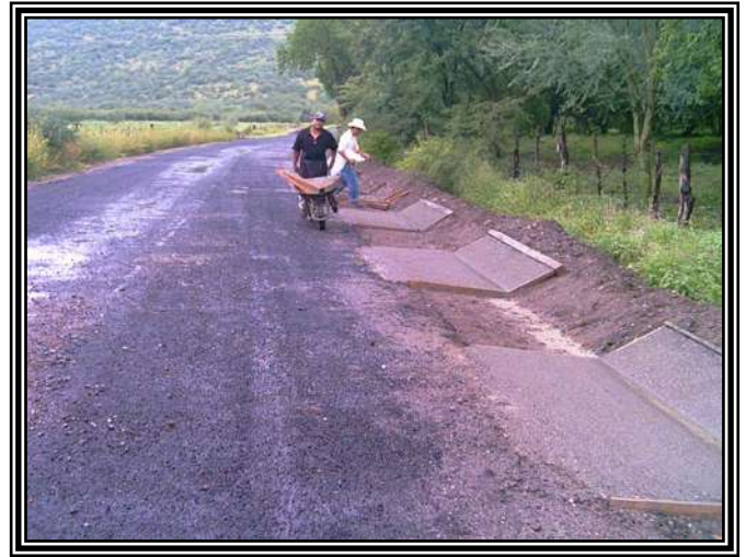
Revestimiento de cunetas
