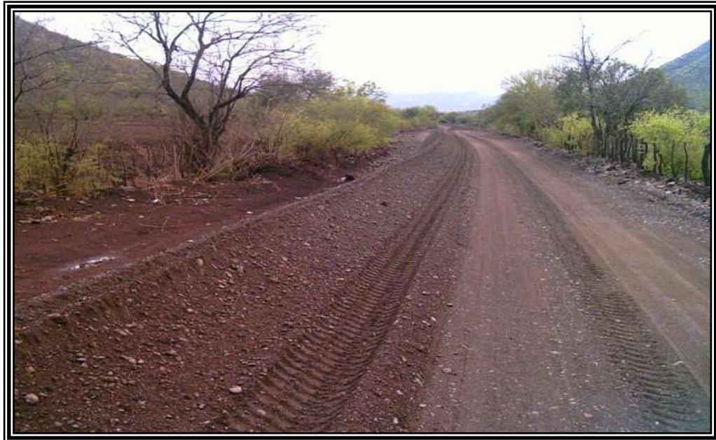
SUELO ESCARIFICADO Y ACAMELLONADO
