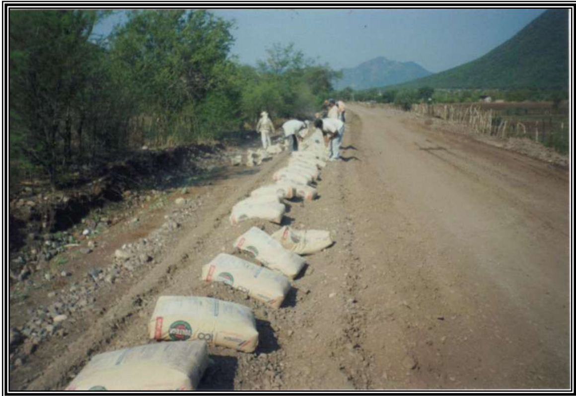
SUMINISTRO DEL CEMENTO EN EL CAMELLON DE SUELO
