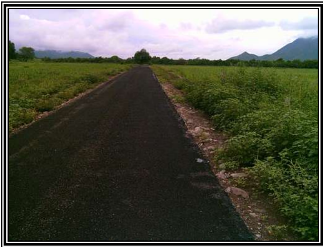
terminado del doble riego
