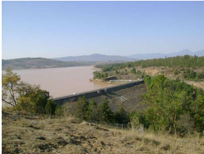
Figura 4.12 Presa Cointzio (CONAGUA 2009b).
