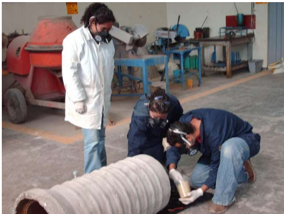
Figura 3.16- Aplicación del concreto polimérico en la tubería (7)
