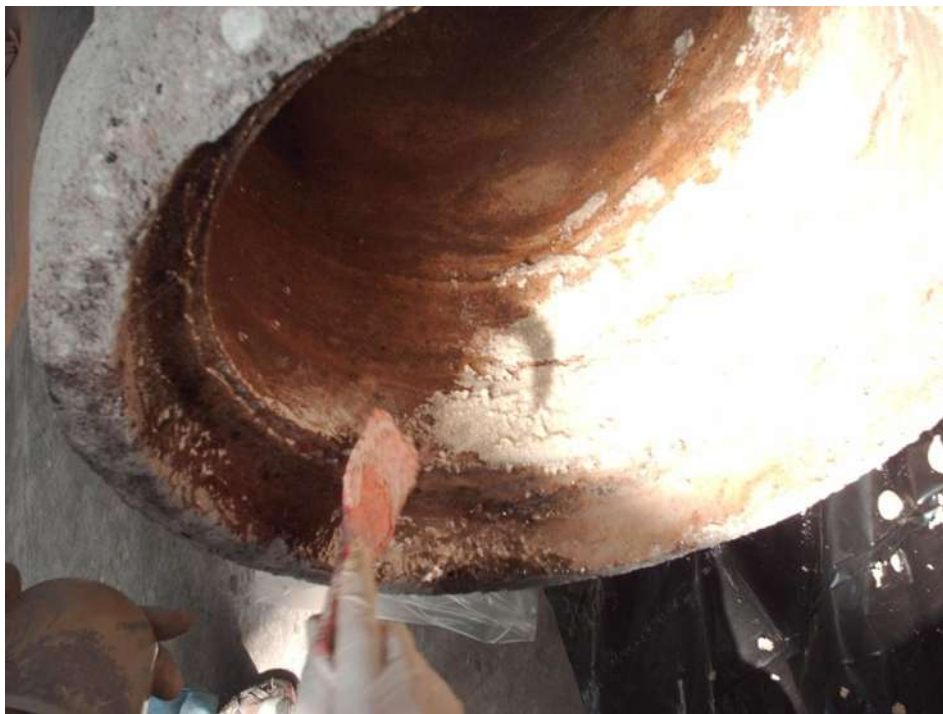
Figura 3.12- Aplicación del concreto polimérico en la tubería (3)
