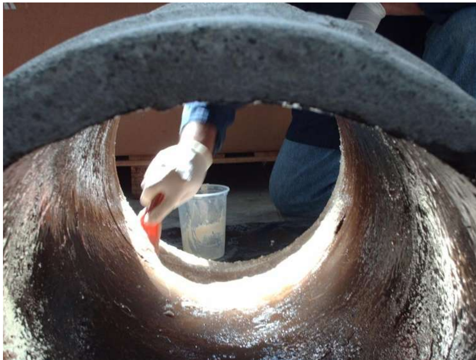
Figura 3.14- Aplicación del concreto polimérico en la tubería (5)
