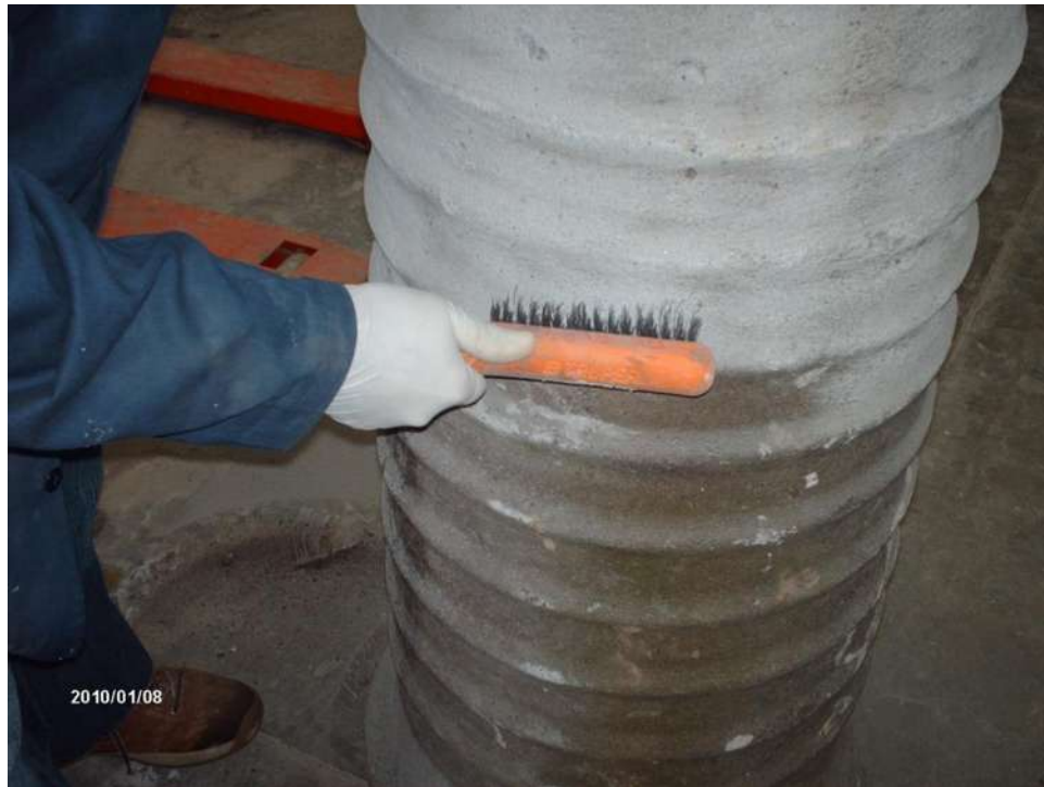
Figura 3.19- Limpieza de tubo de concreto (1)
