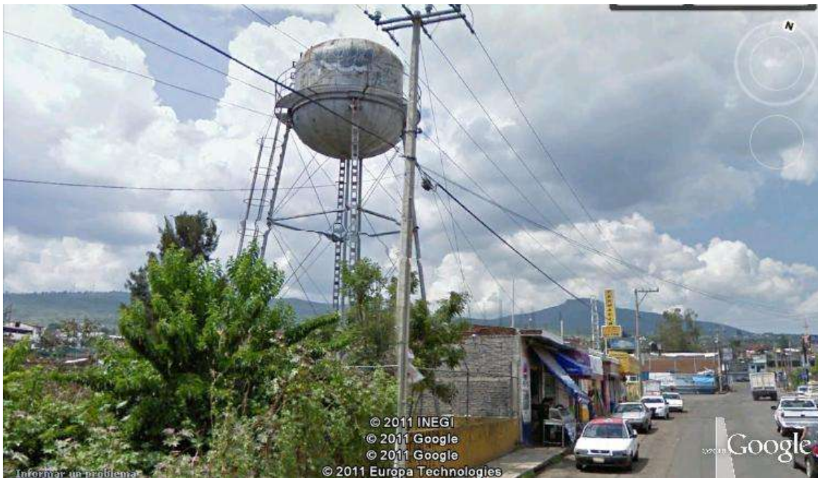
Figura 2.11.- Tanque de Tzindurio. [24]
