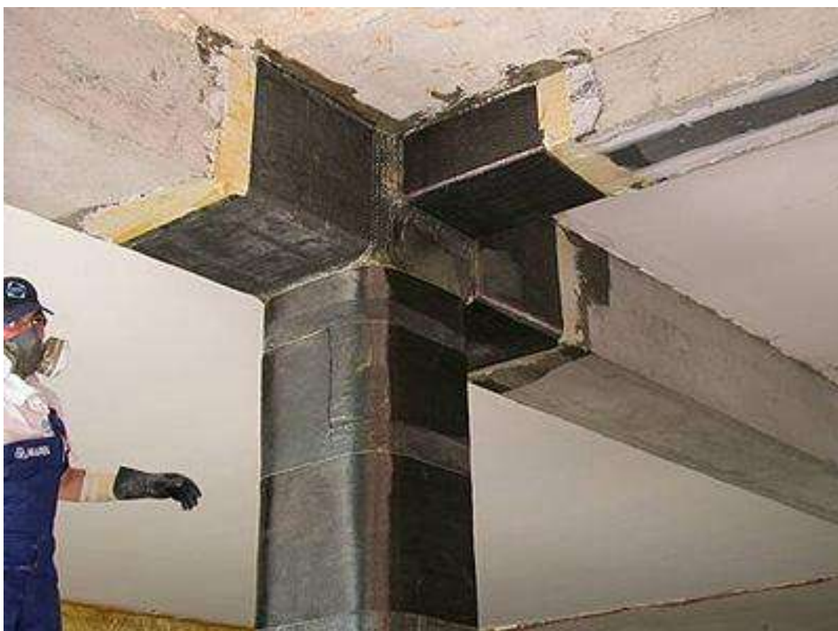
Figura 2.17- Aplicaciones de la fibra de carbono para refuerzo o reparación de un edificio, de manera más práctica [6]
