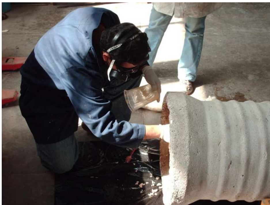
Figura 3.10- Aplicación del concreto polimérico en la tubería (1)
