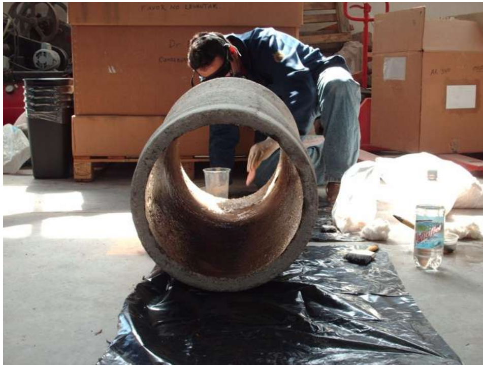
Figura 3.13- Aplicación del concreto polimérico en la tubería (4)
