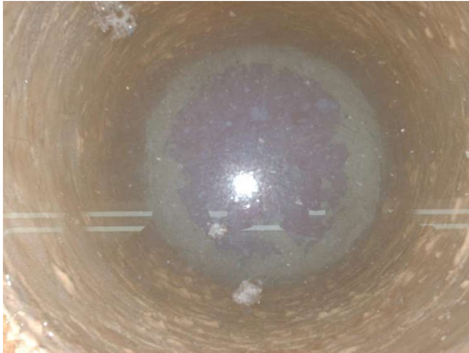
Figura 3.28- Interior del tubo con agua
