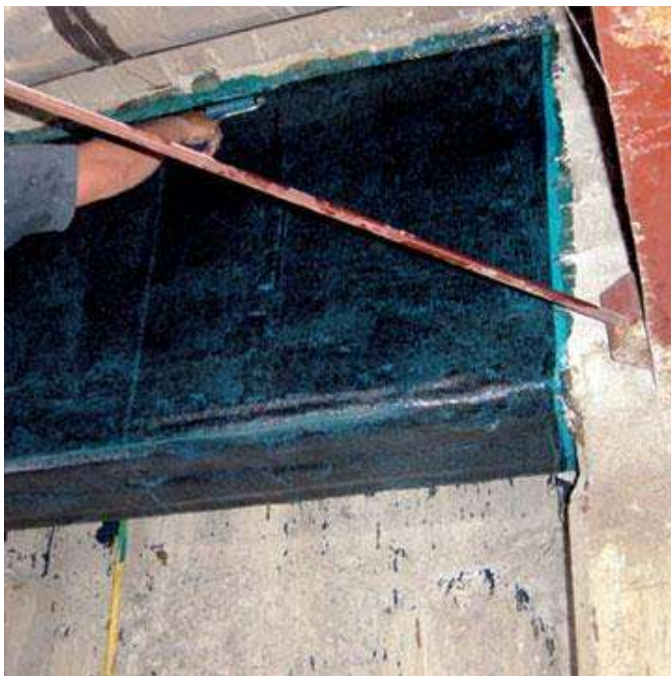
Figura 2.18- Aplicaciones de la fibra de carbono en los elementos estructurales de un edificio [6]
