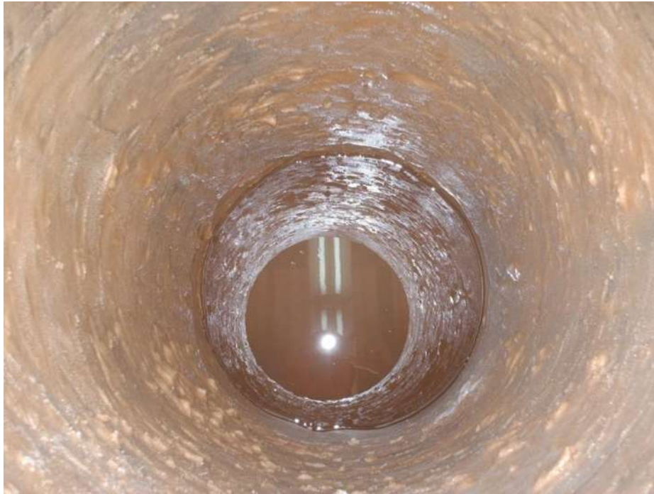
Figura 3.24- Vista en el interior del tubo antes de colocar el agua (1)
