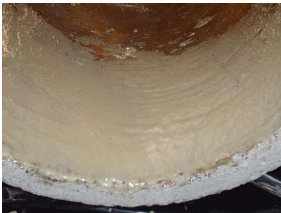
Figura 3.17- Aplicación del concreto polimérico en la tubería (8)
