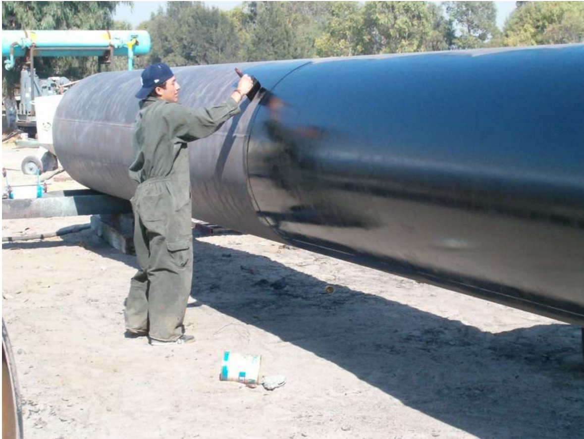
Figura 2.6- Tubería de acero (aplicándosele protección anticorrosiva) [21]
