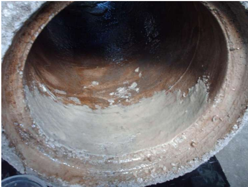
Figura 3.15- Aplicación del concreto polimérico en la tubería (6)
