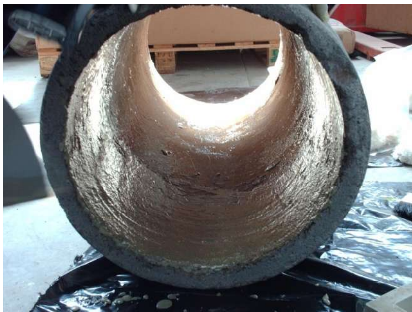
Figura 3.21- Aplicación del composite en la tubería (1)
