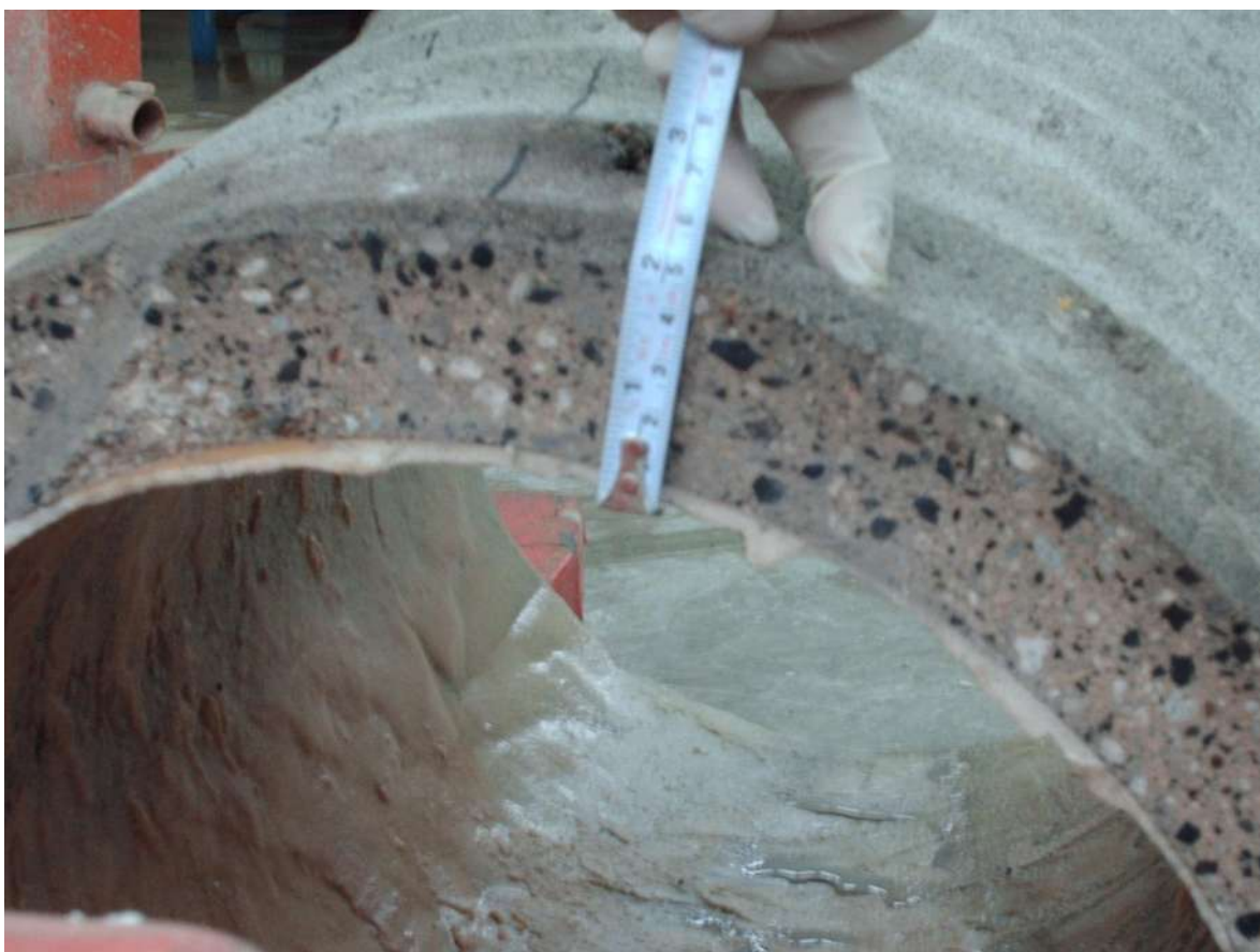
Figura 3.42- espesor de la tubería sin el tapón o fondo
