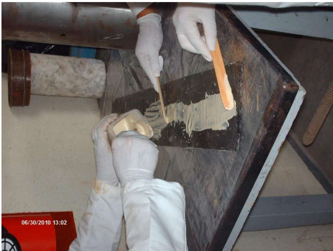
Figura 4.4.- Colocación del adherente para pegar la placa de aluminio sobre la fibra de carbono-vidrio.
