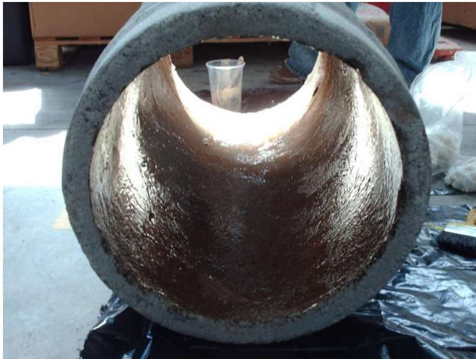
Figura 3.11- Aplicación del concreto polimérico en la tubería (2)
