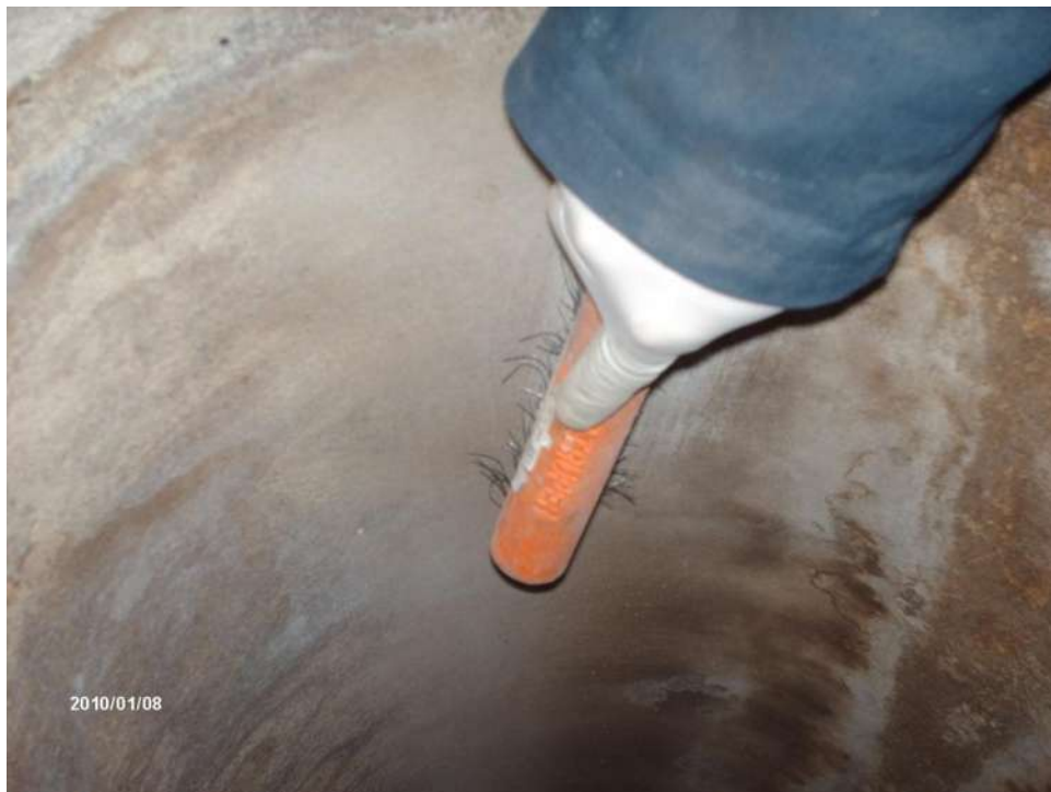
Figura 3.20- Limpieza de tubo de concreto (2)
