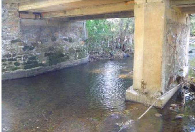
**Figura 3.5** Fotografía del puente donde se ilustra la pila y el estribo.
