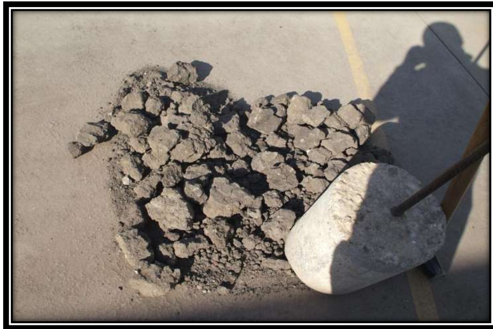
Fig. 3.7.3 Tendido y Secado del material.
