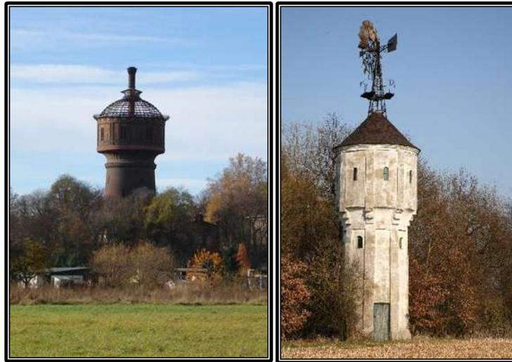
Figura II.3 Torres de agua utilizando el principio de Intze
