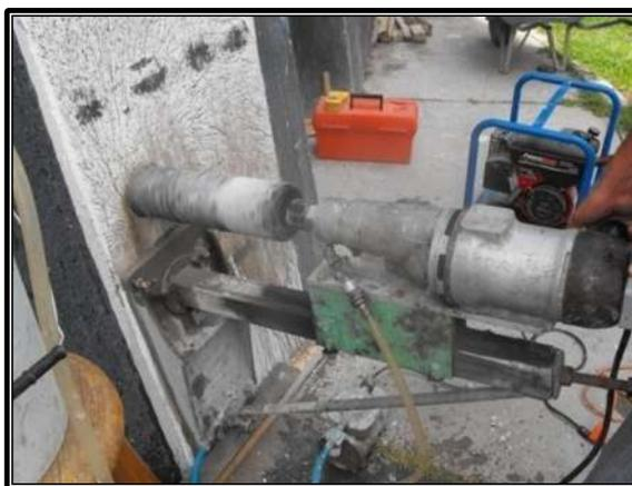
Figura VII.1 Equipo empleado para la extracción de núcleos.
