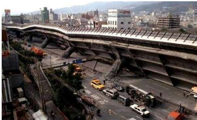
Figura 12 – Puente colapsado por el terremoto de Kobe en 1995. http://alswblog.org/2011/08/27/el-memorial-japones-del-terremoto-de-kobe-de-1995/
