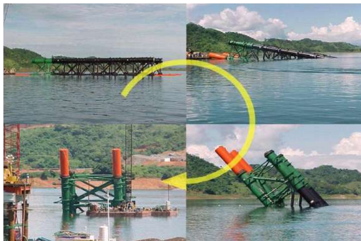
Figura 22 – Proceso constructivo, Puente Chiapas. http://www.triada.com.mx/CURRICULUM%20TRIADA.pdf
