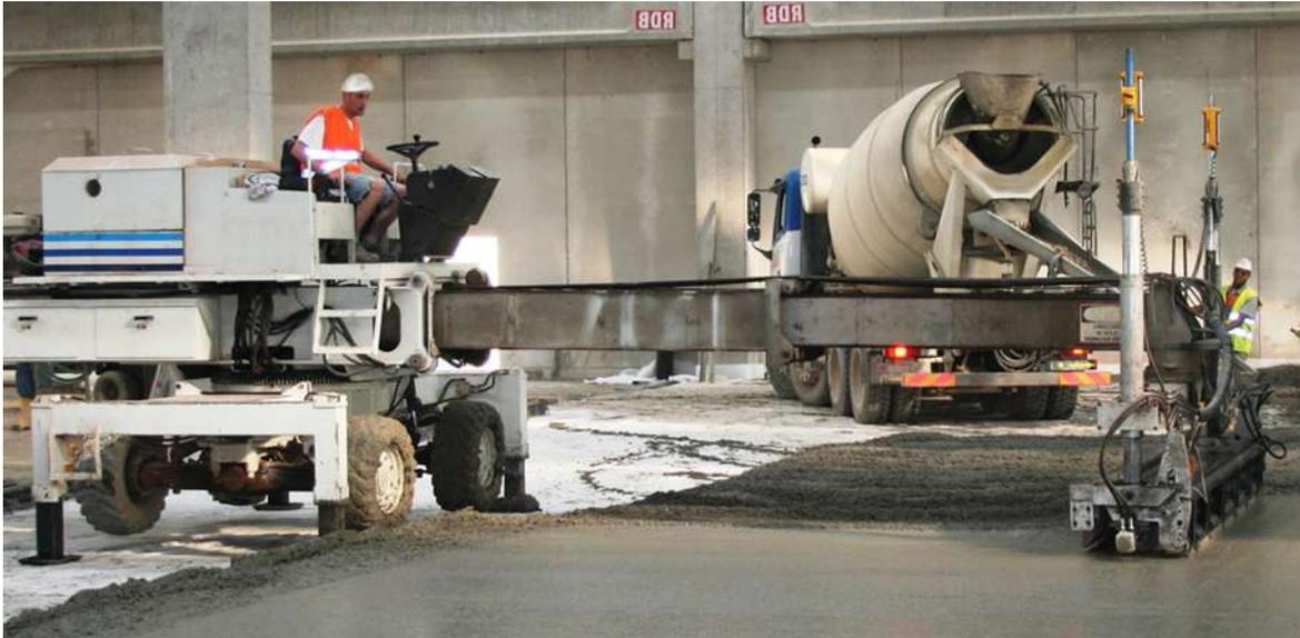
Fotografía 29. Regla compactadora y niveladora orientada mediante unidad laser.
