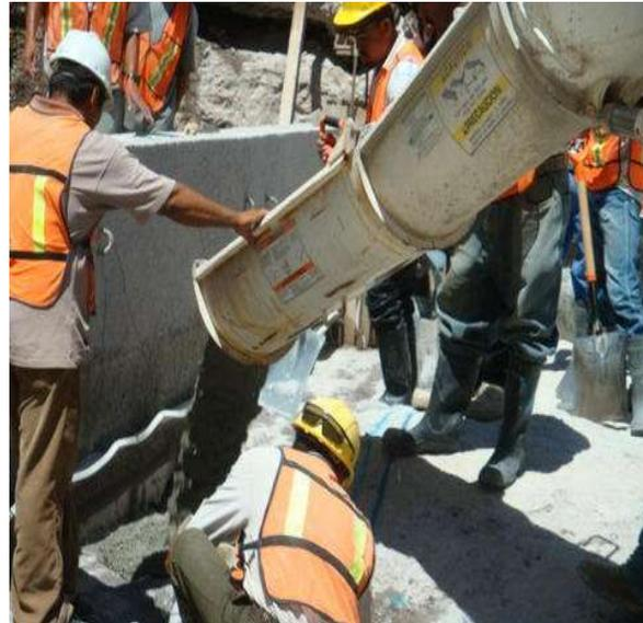
Fotografía 10 y 11. A la derecha se puede apreciar un concreto trabajable pues desciende con facilidad del canalón y no se segrega al caer; en cambio a la izquierda se observa segregación del concreto.
