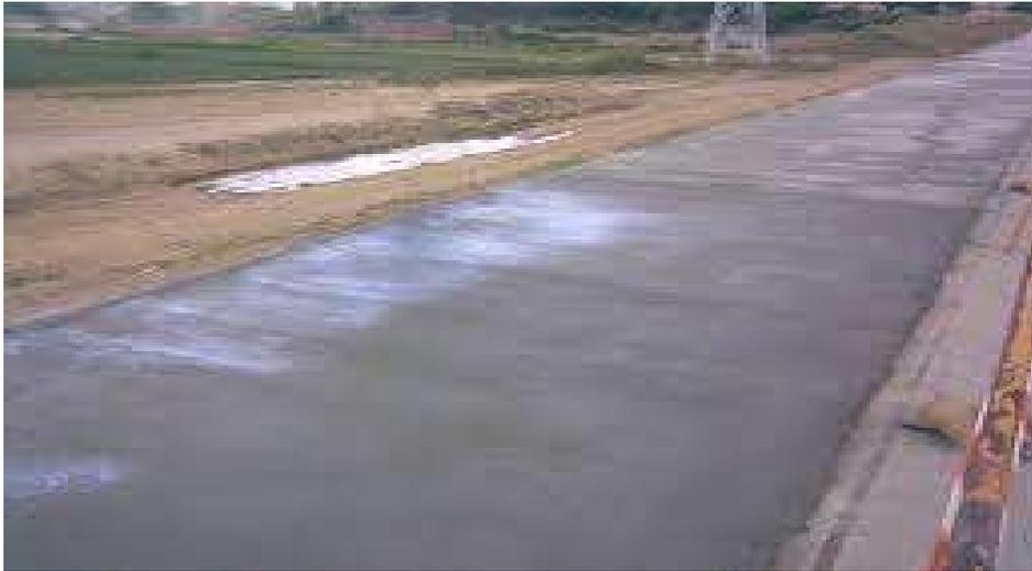
Fotografía 34. El cubrir la superficie con materiales húmedos como arena exige un regado frecuente.
