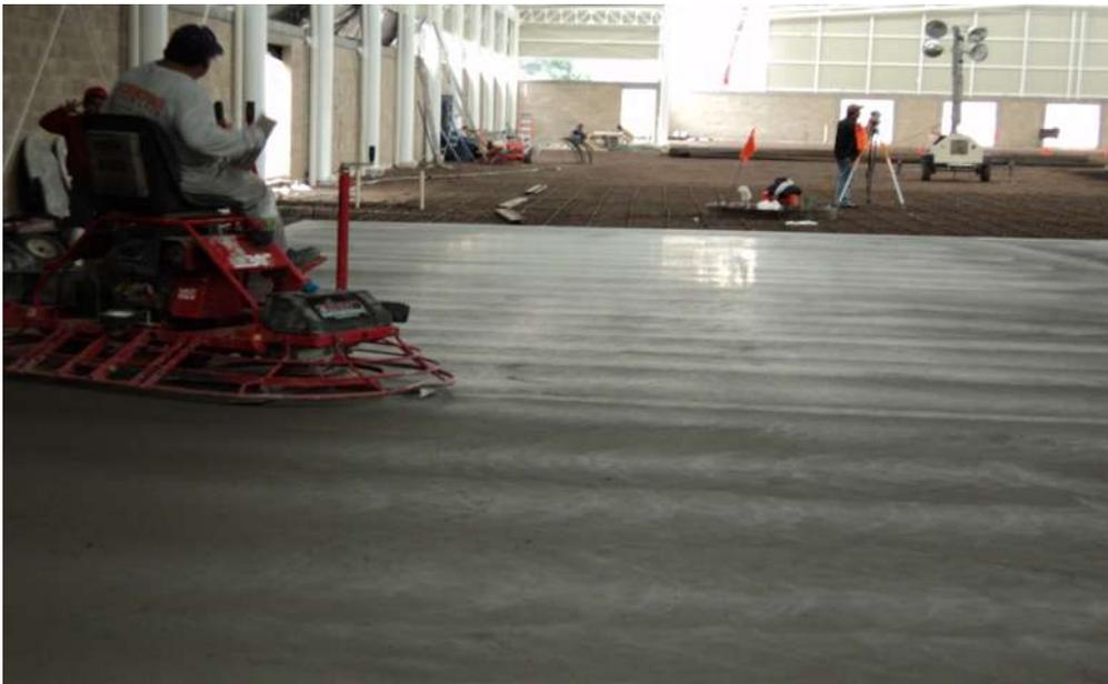
Fotografía 30. Acabado de concreto con helicóptero doble.
