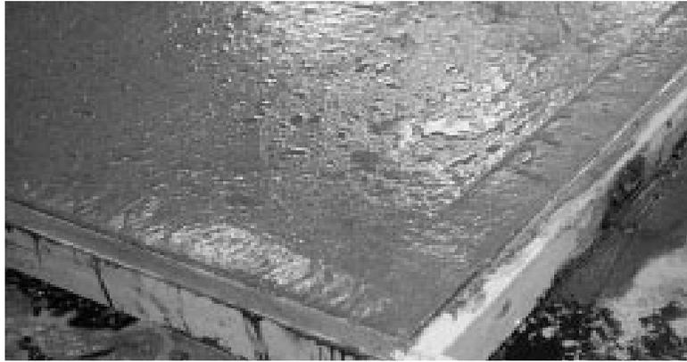
Fotografía 12. Agua de sangrado en la superficie de concreto recién colado en una losa.
