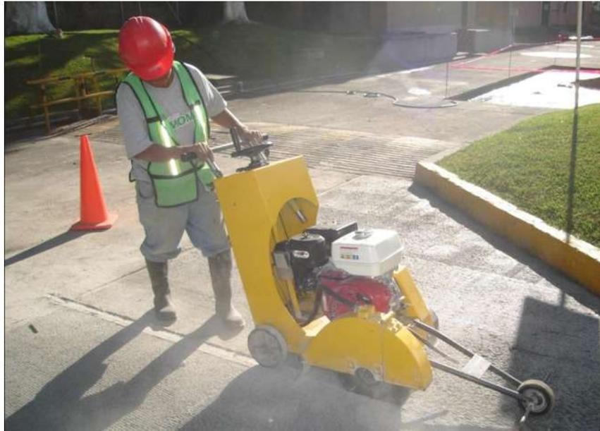
Fotografía 36. El aserrado de juntas debe realizarse tan pronto el concreto esté duro, entre 4 y 8 horas. Generalmente la profundidad del corte debe ser entre  $\frac{1}{3}$  y  $\frac{1}{4}$  del espesor de la losa.
