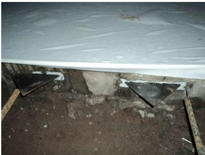
Fotografía 37. Junta de construcción con pasajuntas.
