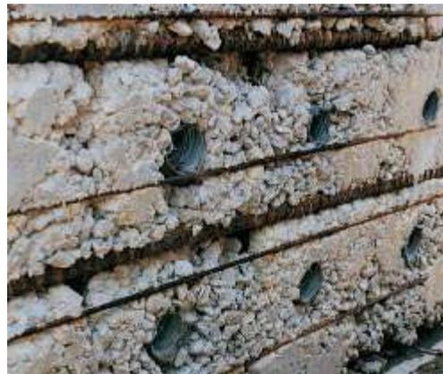
Fotografía 13 y 14. Buena consolidación (izquierda) necesaria para lograr un concreto denso y durable. Mala consolidación (derecha) genera corrosión temprana en la armadura y baja resistencia.
