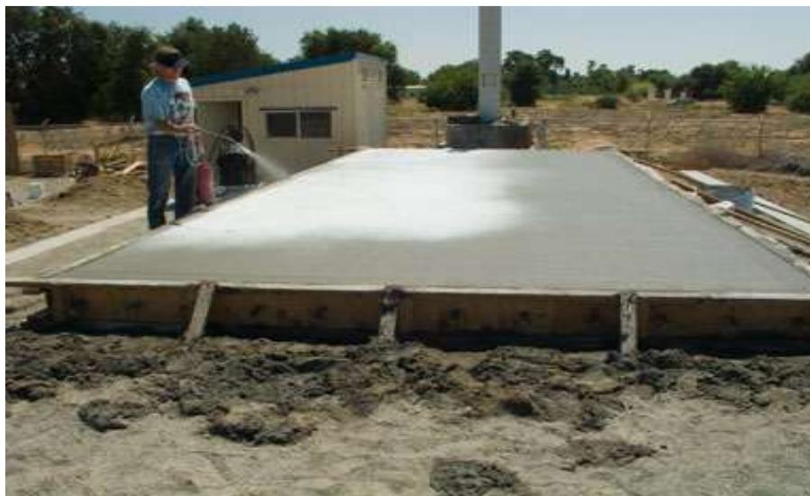
Fotografía 35. Aplicación de membrana de curado utilizando equipo de presión.
