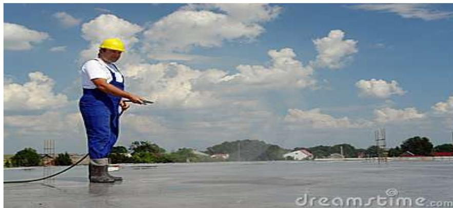
Fotografía 33. El riego con agua es el método de curado más utilizado.
