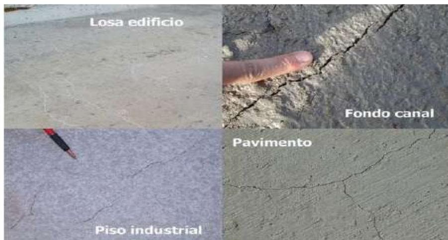
Fotografía 32. Fisuras por contracción plástica.
