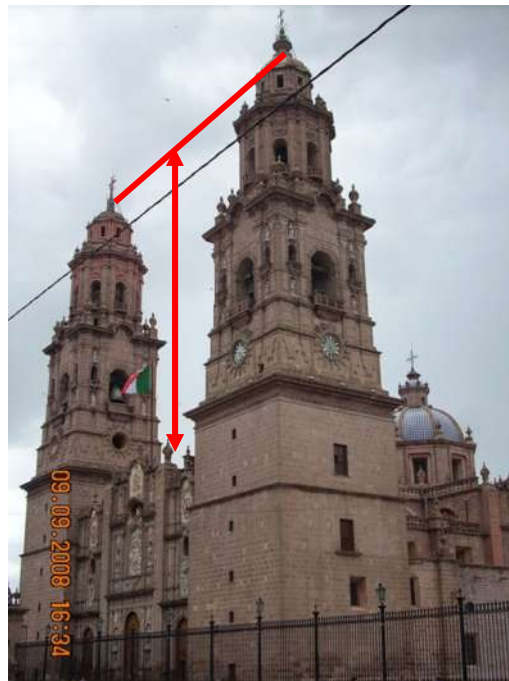
Figura 53 Evidente diferencia de altura entre las Torres y la Nave Principal (O. Segura, 2008).
