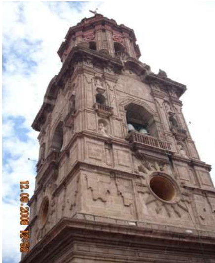
Figura 51 Torre (O. Segura, 2008).
