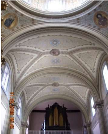
Figura 66 Bóvedas de cañón con lunetos (O. Segura, 2008).
