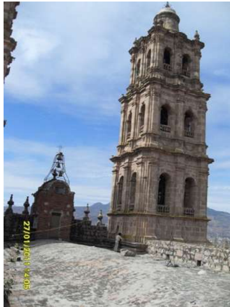
Figura 47 Torre en tres Niveles.
