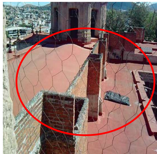
Figura 63 Muro de mampostería.
