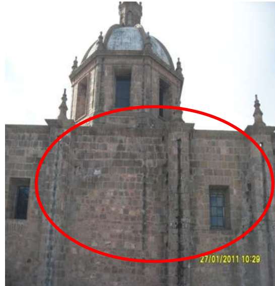
Figura 67 Contrafuertes sobre el muro formero norte.
