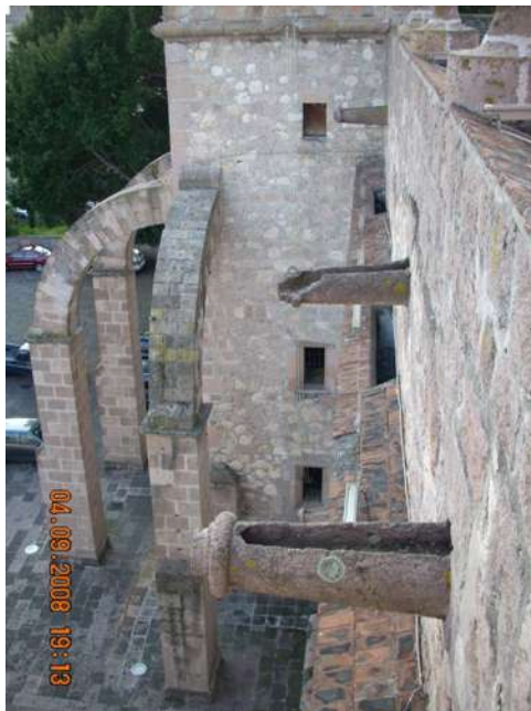
Figura 13 Espadaña sostenida por arcos botareles o arbotantes (O. Segura, 2008).
