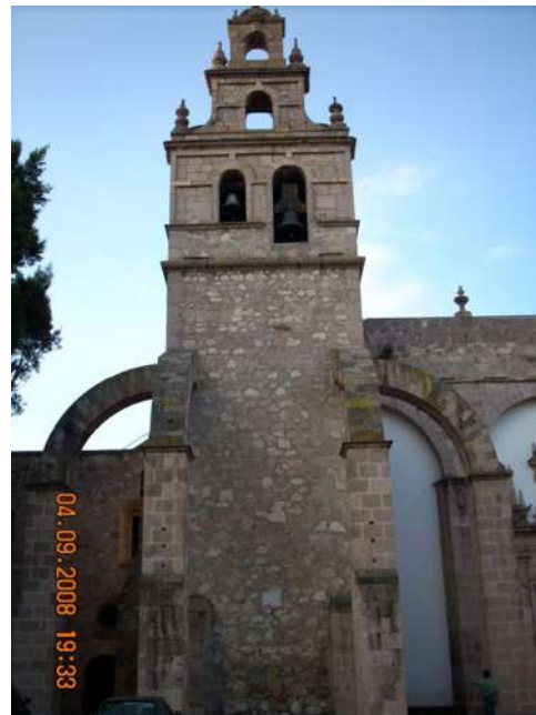
Figura 13 Espadaña sostenida por arcos botareles o arbotantes (O. Segura, 2008).
