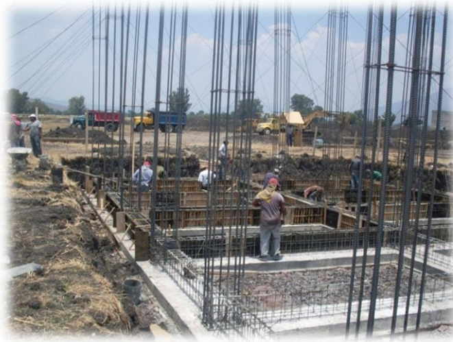
Fig. 3.14. Cimbrado de las contratraves de los edificios de laboratorio y aulas.
