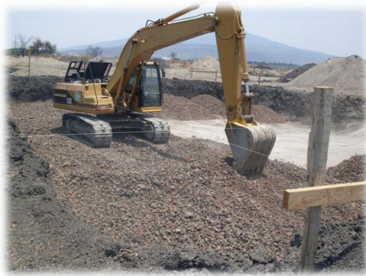
Fig. 3.4. Extendido del material de filtro para el mejoramiento del terreno en el edificio de laboratorio.
