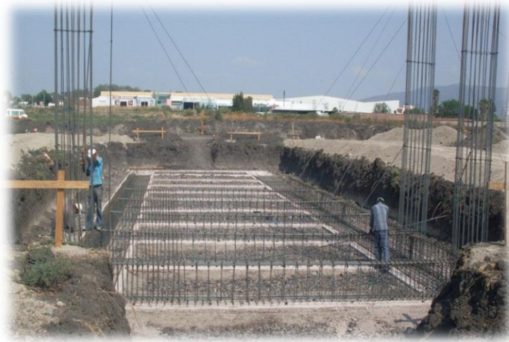
Fig. 3.11. En el edificio de aulas, se armaron las zapatas y se amarraron a ellas las varillas de las columnas y de las contratraveses.
