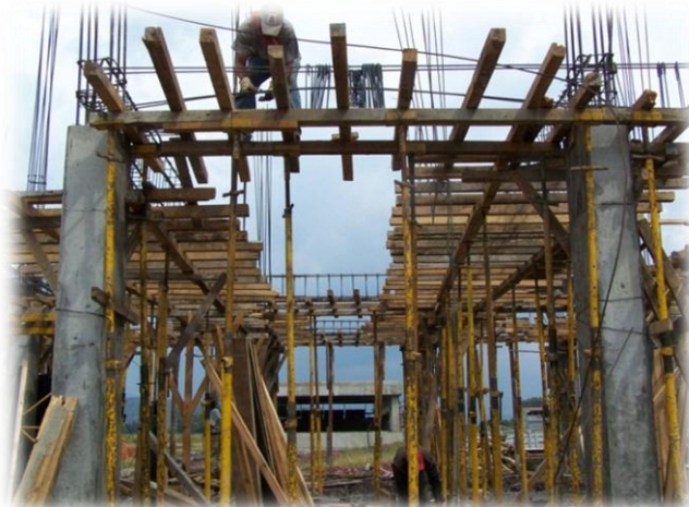
Fig. 3.22. Armado de las trabes de la losa de entrepiso de la biblioteca sobre la cimbra antes colocada.
