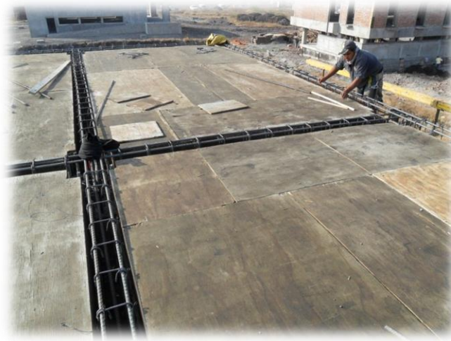
Fig. 3.23. Vista superior de la cimbra de la losa del edificio de laboratorio.
