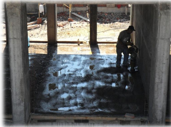
Fig. 3.33. Compactado de la capa de tepetate sobre la que se construiría el firme de concreto del edificio de aulas.
