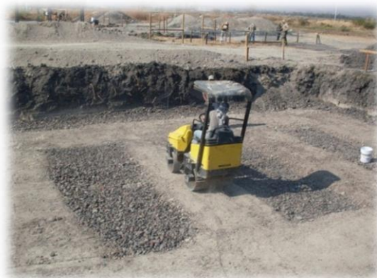
Fig. 3.7. Compactación de la capa de material fino cementante con ayuda de un rodillo pequeño del edificio de aulas.
