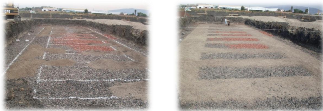
Fig. 3.6. Tendido del material fino denominado tepetate sobre las áreas de cimentación trazadas sobre la capa de filtro del edificio de aulas.
