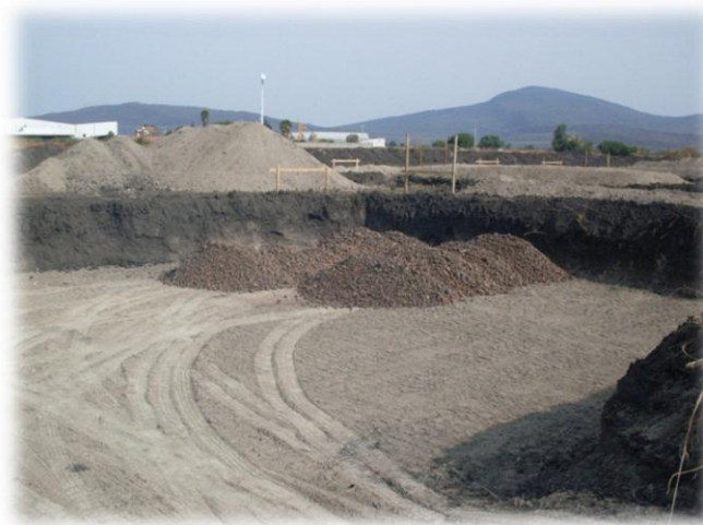
Fig. 3.3. Suministro del material de filtro clasificado con el que se mejoraría el terreno en el edificio de laboratorio.
