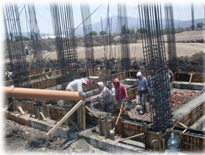
Fig. 3.15. Colado de las contratraves del edificio de aulas.
