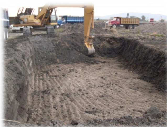
Fig. 3.1. Excavación de las cajas para cada edificio con excavadora del edificio de laboratorio.
