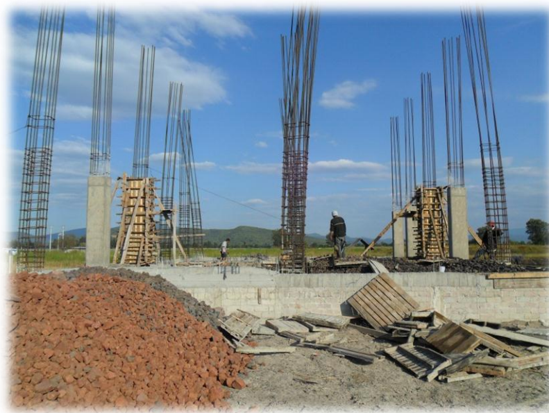
Fig. 3.20. Colado de las columnas de planta baja siguiendo el sistema de rotación de cimbra del edificio de laboratorio.
