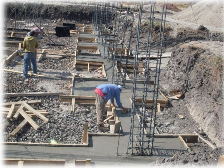
Fig. 3.13. Zapatas aisladas del edificio de biblioteca.
