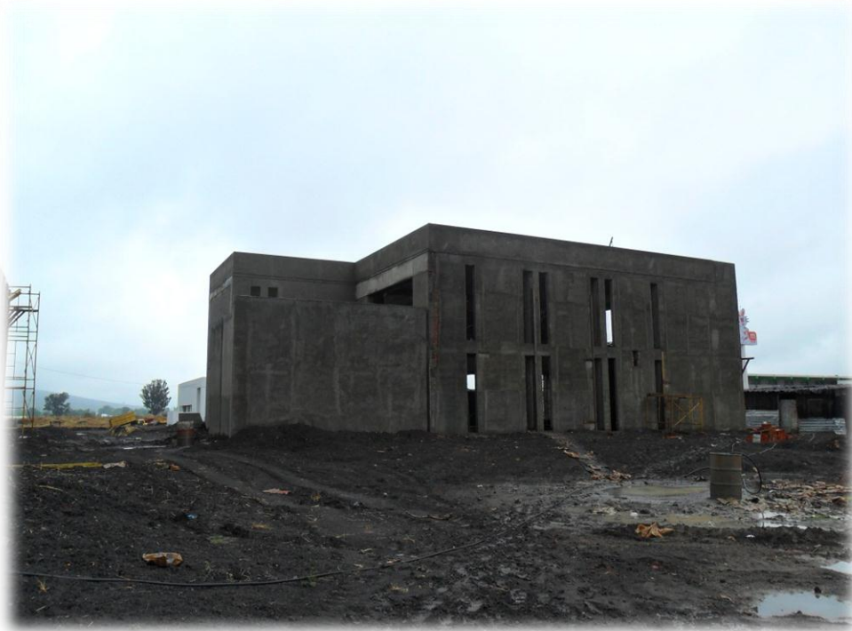
Figura 3.40. Edificio de biblioteca en su estado actual.
