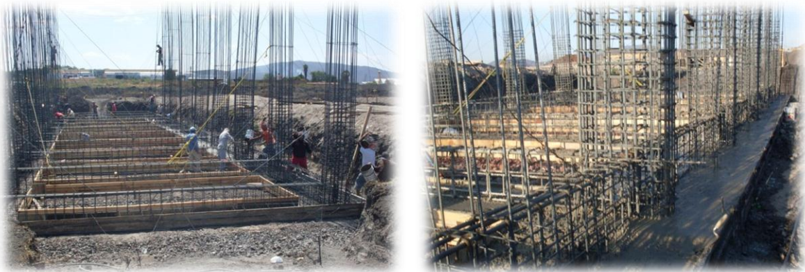
Fig. 3.12. Al terminar el cimbrado de las zapatas, se procedió al colado de las mismas.
