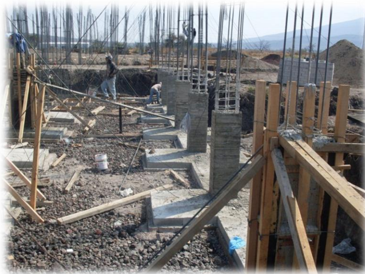
Fig. 3.17. En la imagen se muestra un grupo de columnas de las cuales unas ya están coladas y descimbradas y otras que están aun cimbradas del edificio de biblioteca.
