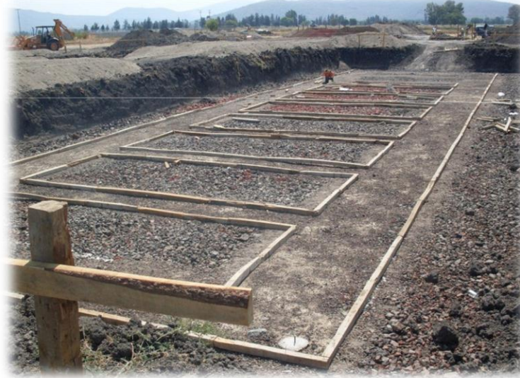
Fig. 3.8. Colocación de cimbra para la plantilla de concreto simple en el edificio de aulas.
