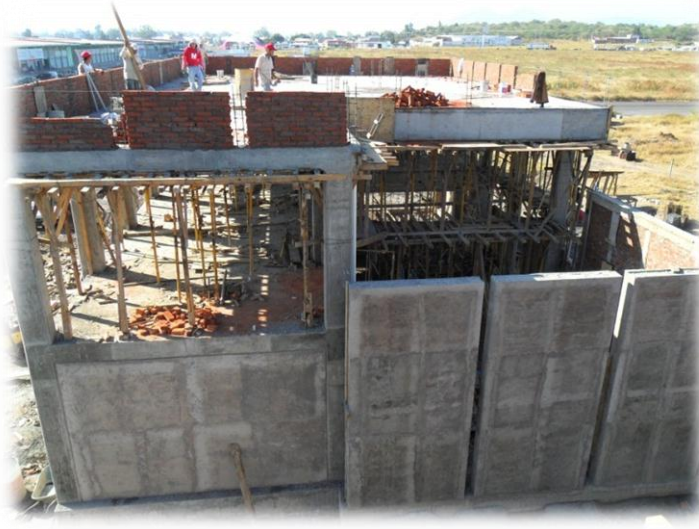
Fig. 3.30. Levantamiento de los muros para el pretil de la azotea de la biblioteca.
