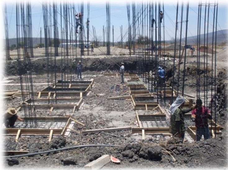
Fig. 3.10. Armado y cimbrado de las zapatas, además del armado de las columnas del edificio de biblioteca.
