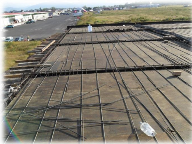
Fig. 3.24. Colocación del armado de la losa de la biblioteca.
