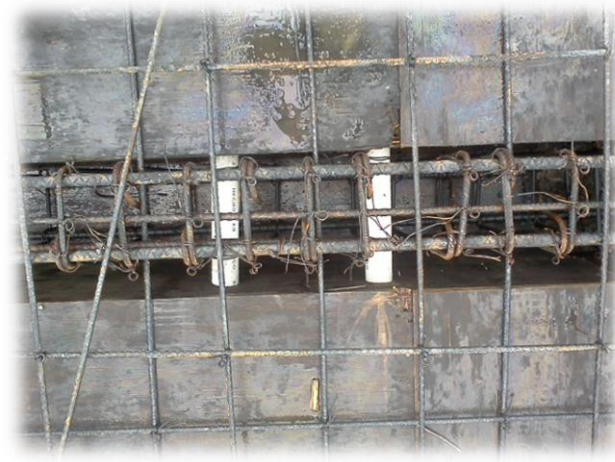
Fig. 3.26. En la imagen pueden apreciarse los tubos de PVC que sirven como paso de un lado a otro de la trabe para el cableado eléctrico que irá oculto con falso plafón.
