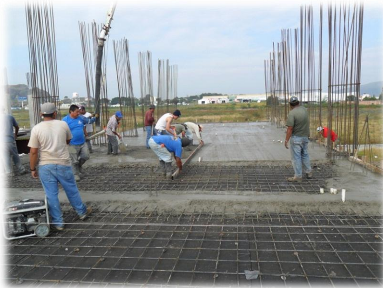
Fig. 3.28. En la figura se aprecia como se colaron primero las trabes y después se fue colando la demás superficie, además de como se pasa la regla metálica para dar el acabado liso a la losa.
