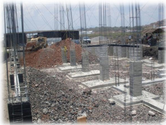
Fig. 3.19. Acomodo del material de relleno dentro de la cimentación con ayuda de un mini cargador frontal, mejor conocido como Bocat (Por la marca Bobcat) en la biblioteca.
