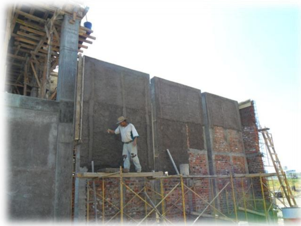
Fig. 3.31. Repellado de los muros de tabique terminados, mientras se termina el proceso constructivo de la losa de azotea en el edificio de biblioteca.
