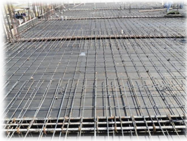
Fig. 3.25. Vista del armado de la losa de entrepiso del edificio de aulas.
