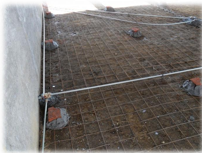
Fig. 3.35. Colocación de la tubería conductora para el cableado eléctrico en el edificio de aulas.
