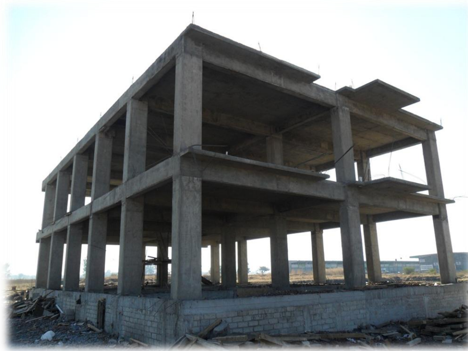
Fig. 3.41. Edificio de laboratorio en su estado actual.
