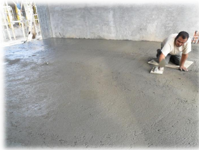
Fig. 3.36. Acabado del firme con una llana de madera en el edificio de aulas. Al fondo de la imagen se aprecia una de las ranuras hechas al muro como preparación para la instalación eléctrica.
