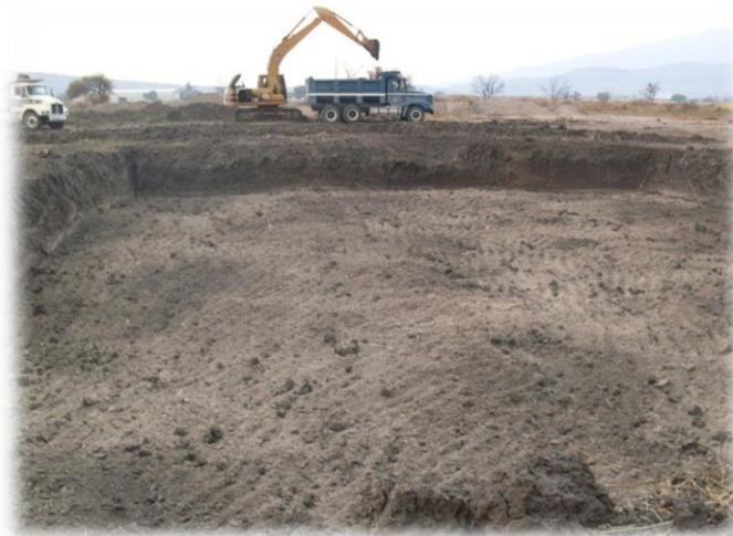
Fig. 3.2. Vista de una caja de excavación terminada del edificio de laboratorio.
