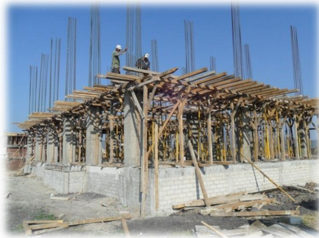
Fig. 3.21. Colocación de la cimbra solo donde había trabes en cada edificio.
