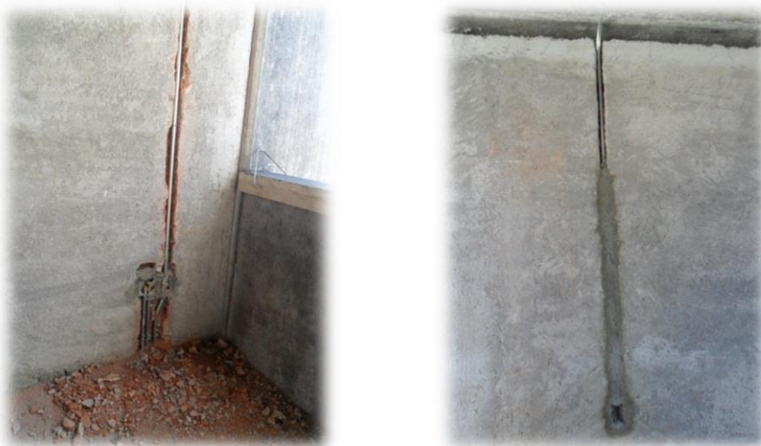
Fig. 3.38. Las figuras muestran un ejemplo de las ranuras hechas para colocar los elementos de preparación para la instalación eléctrica así como el recubrimiento de las mismas.
