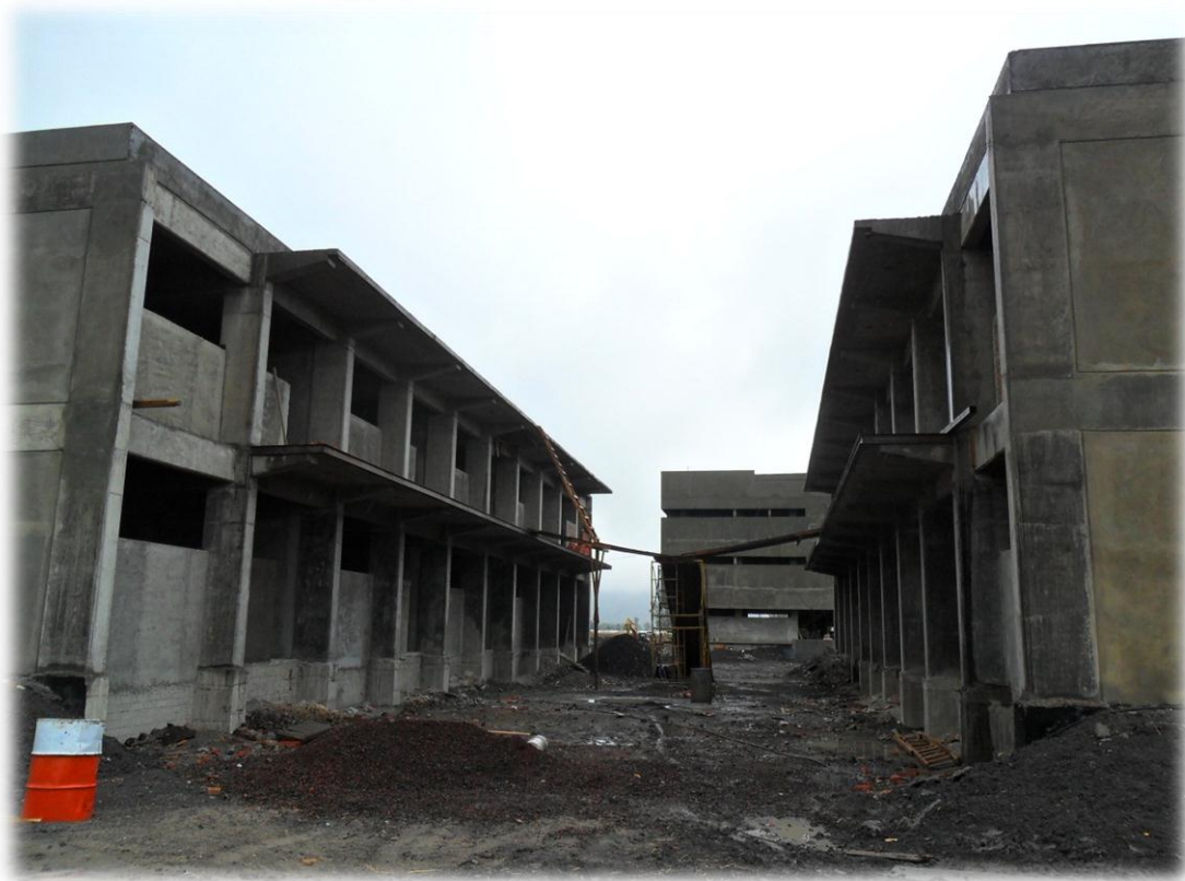
Fig. 3.39. Edificio de aulas en su estado actual.
