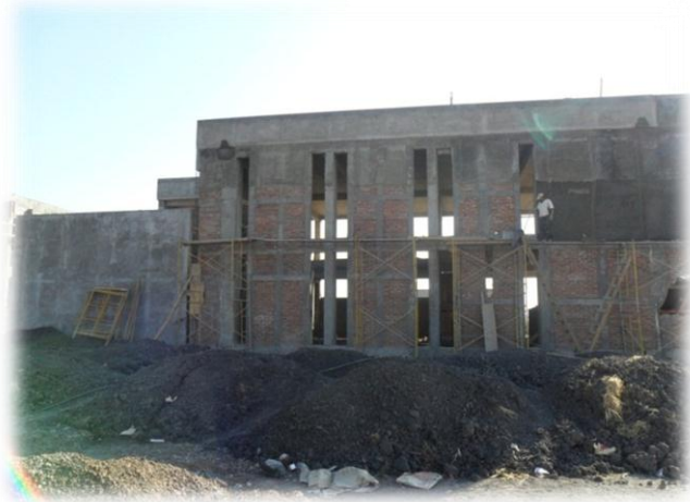
Fig. 3.37. En la imagen se aprecia como se espero hasta tener los muros terminados desde la planta baja hasta el pretil de la azotea para aplicar el repellado.
