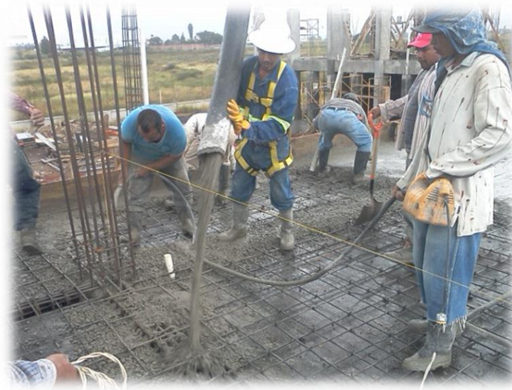
Fig. 3.27. Colado de la losa de entrepiso de la biblioteca con ayuda de una bomba para concreto.
