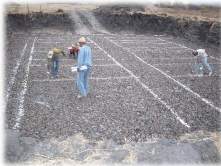
Fig. 3.5 Trazo de la cimentación del edificio de laboratorio.
