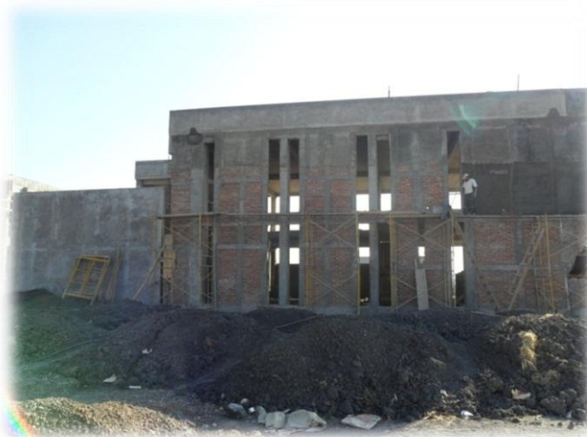
Fig. 3.32. Repellado de los muros de tabique terminados que van desde la planta baja hasta el pretil de la azotea de la biblioteca.
