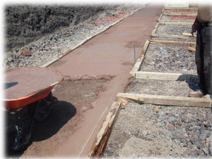
Fig. 3.9. Colado de la plantilla del edificio de aulas con carretillas. En la imagen puede apreciarse el poco espesor de la plantilla de (6 cm).
