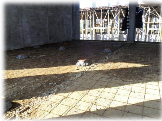
Fig. 3.34. Malla electro soldada 6X6"-10/10 del firme de concreto de la planta baja. Edificio de aulas.
