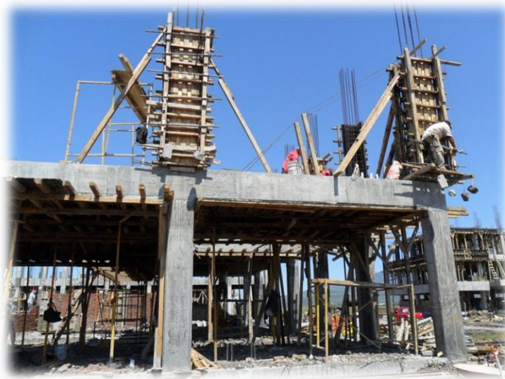
Fig. 3.29. Se inició el cimbrado y colado de las columnas de la planta alta al día siguiente del colado de la losa de biblioteca. Puede apreciarse como aun esta cimbrada la losa.
