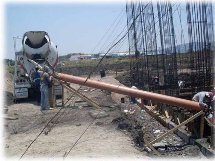
Fig. 3.16. Esta imagen muestra un ejemplo de lo que a veces se tiene que inventar cuando las condiciones de la obra no permiten ciertas comodidades en algunas actividades, como el colado de contratraves, por ejemplo.
