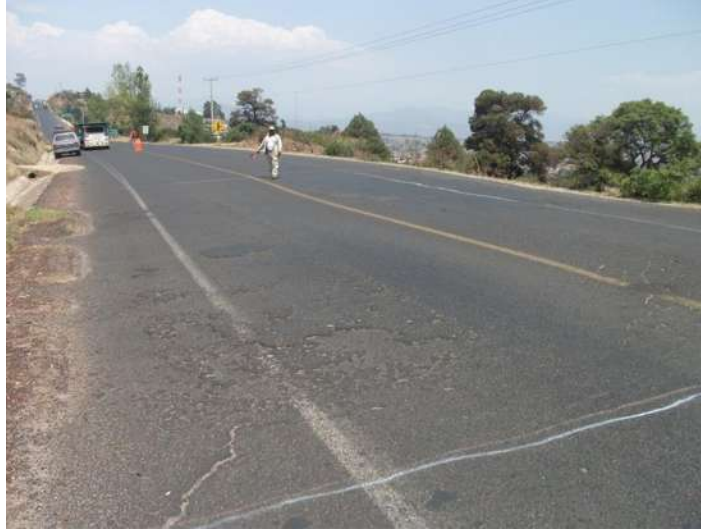
Imagen: IX.III.I.Demarcación del área a renivelar.
