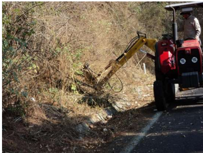
Imagen: VII.X.II. Limpieza de maleza con deshierbadora
