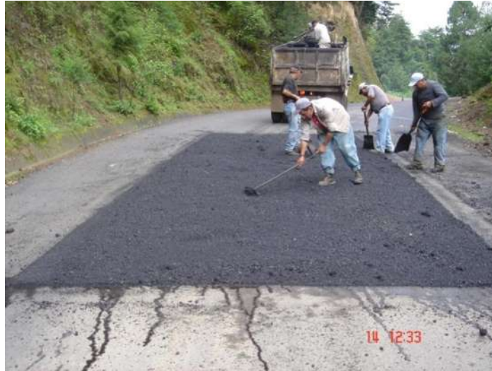
Imagen: V.I.III. Colocación del material de bacheo
