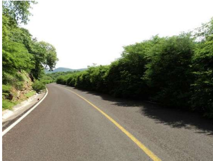
Imagen: V.X.I. Maleza que invade gran parte de la vía.
