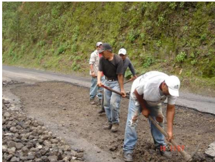
Imagen: V.I.II. Remoción del área afectada
