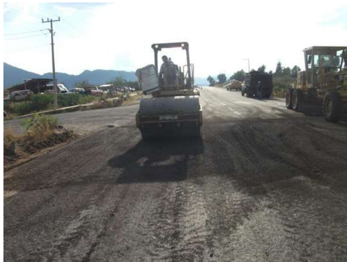
Imagen: IX.III.III. Compactación con rodillo liso
