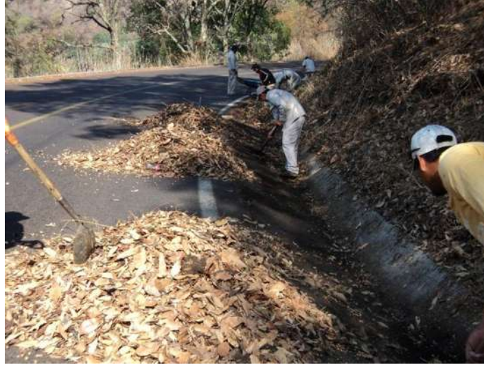
Imagen: VII.III.I. Limpieza de cunetas
