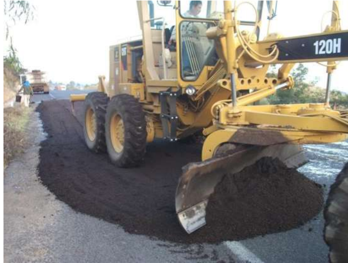
Imagen: IX.III.II. Nivelación de material de carpeta con motoconformadora
