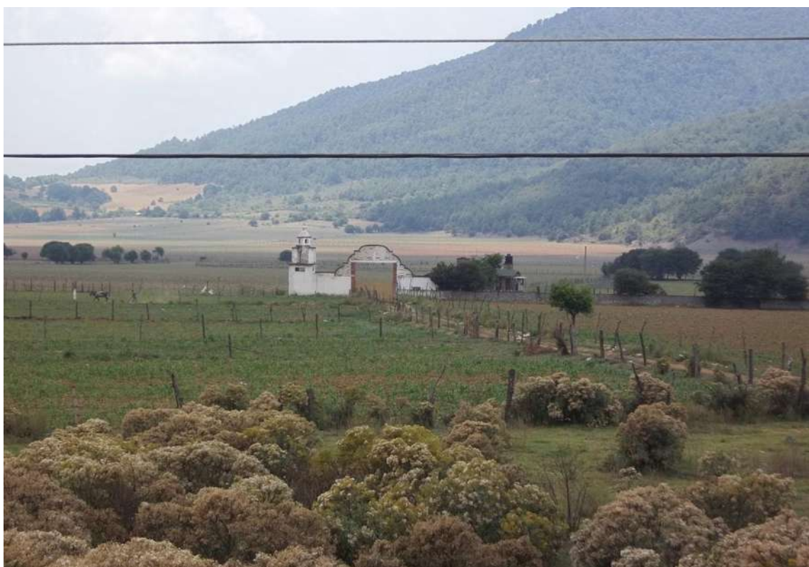
Figura N° 4: Microlocalización de la Planta de Tratamiento de Aguas Residuales.
