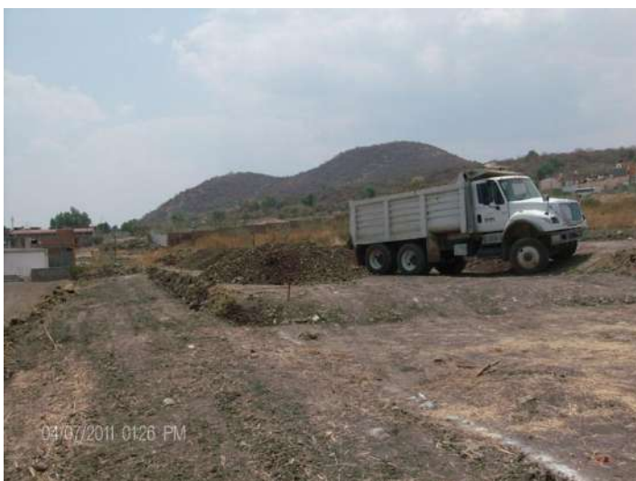
FOTO 2.11: TIRO DE MATERIAL FILTRO EN CANCHA DE USOS MULTIPLES
