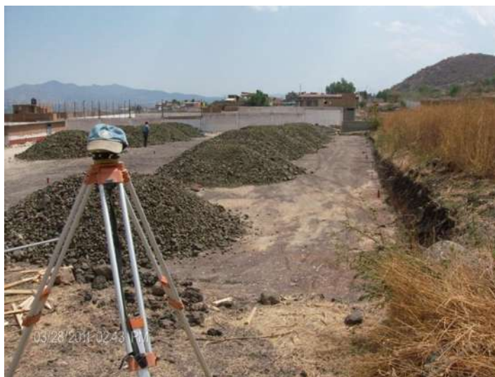
FOTO 1.4: NIVELACION CANCHA USOS MULTIPLES
