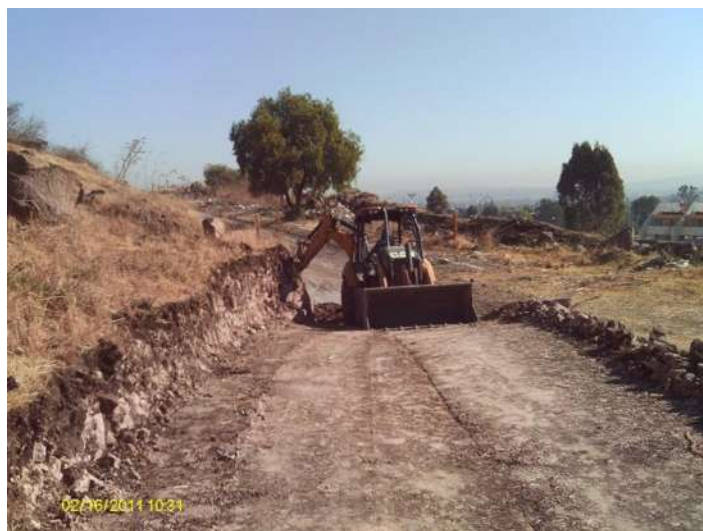
Foto 1.6: AFINE DE TALUDES
