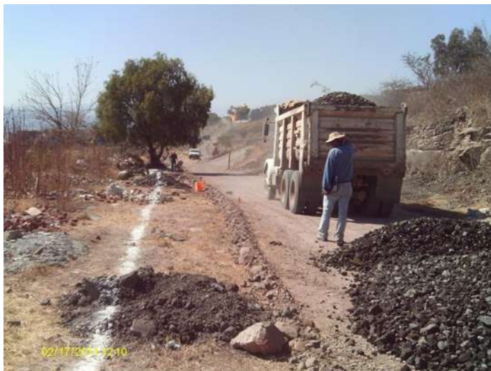
FOTO 2.6: TIRO DE MATERIAL DE BANCO
