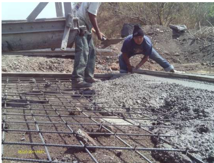
FOTO 3.7: TENDIDO DE CONCRETO EN CRUCE GASODUCTO
