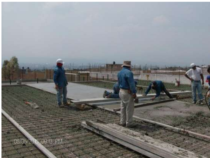
FOTO 4.6: COLADO EN FRANJAS DE PISO DE CONCRETO
