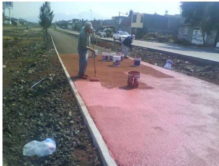
FOTO 5,8: PINTURA Y PROTECCIÓN EN TROTAPISTA
