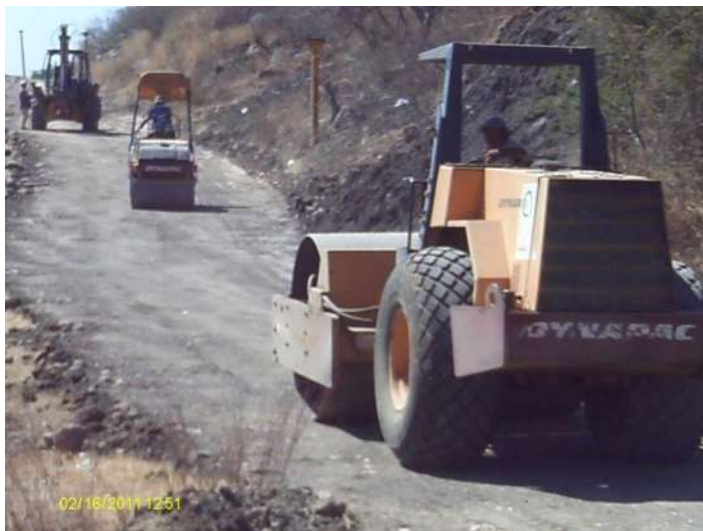
FOTO 2.9: COMPACTACION TERRENO NATURAL
