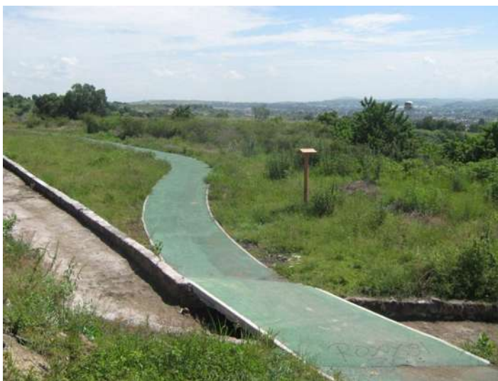
FOTO 2.18: ESTRUCTURA DE CRUCE PLUVIAL
