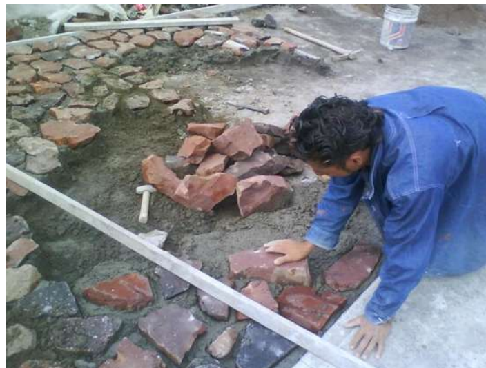
FOTO 5.16: EMPEDRADO AHOGADO EN CONCRETO
