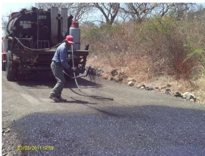
FOTO 2.17: RIEGO DE IMPREGNACIÓN EN CICLOPISTA
