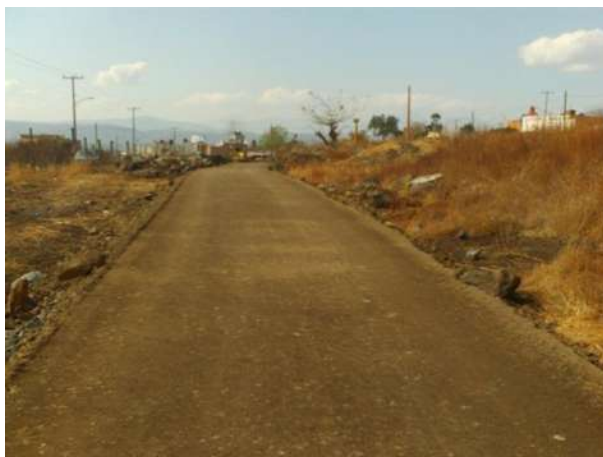
FOTO 2.14: COMPACTACION CAPA DE BASE
