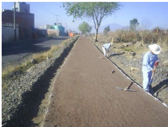
FOTO 3.3: EXCAVACIONES PARA CONSTRUCCIÓN DE GUARNICIONES
