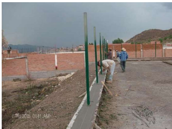
FOTO 5.14: POSTES PARA REJACERO EN CERCO PERIMETRAL
