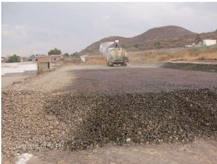
FOTO 2.12: INCORPORACION DE HUMEDAD CAPA DE FILTRO
