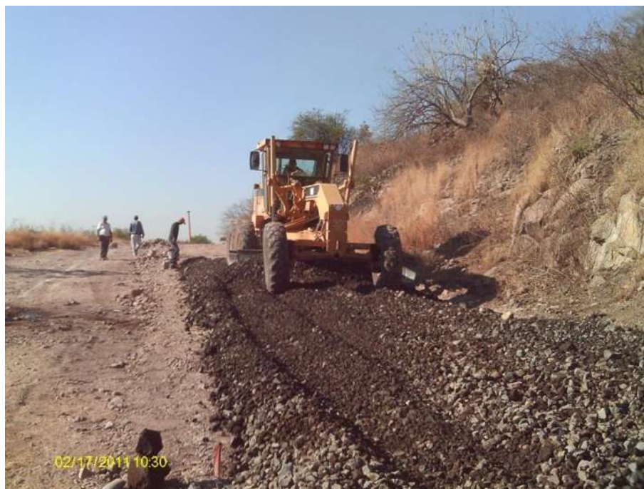
FOTO 2.15: ELABORACION DE MATERIAL PARA CAPA DE BASE
