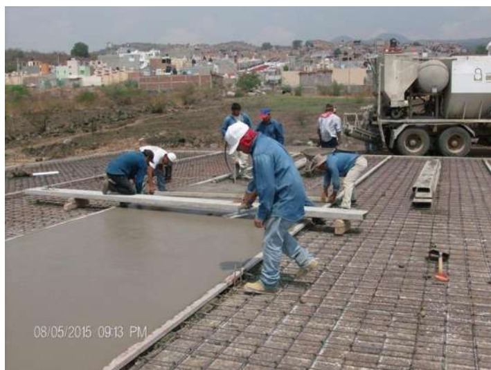
FOTO 4.5: COLADO DE PISO DE CONCRETO ARMADO EN CANCHA
