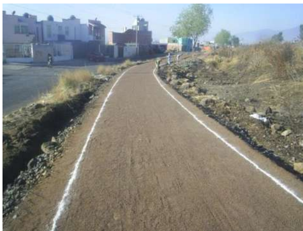
FOTO 3.2: TRAZO DE GUARNICIONES
