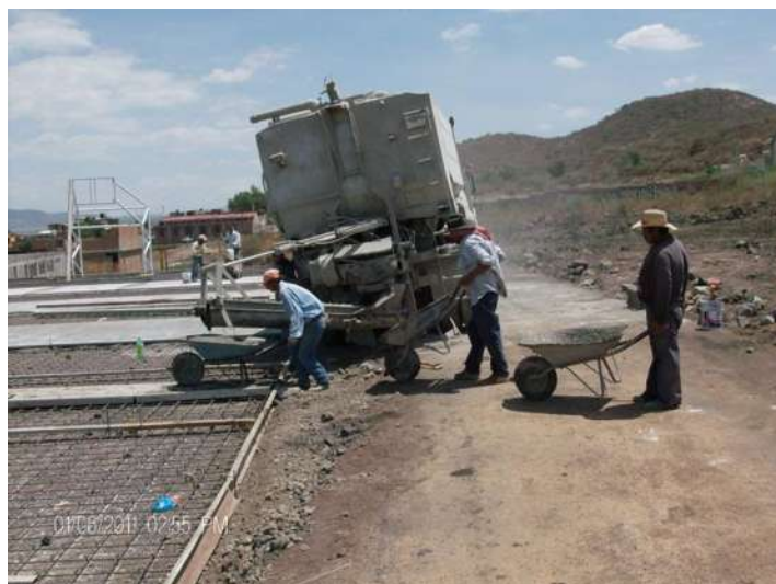
FOTO 4.7: DOSIFICADORA DE CONCRETO EN COLADO DE PISO
