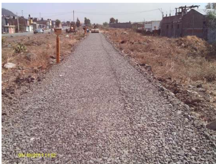
FOTO 2.10: COMPACTACION MATERIAL DE FILTRO
