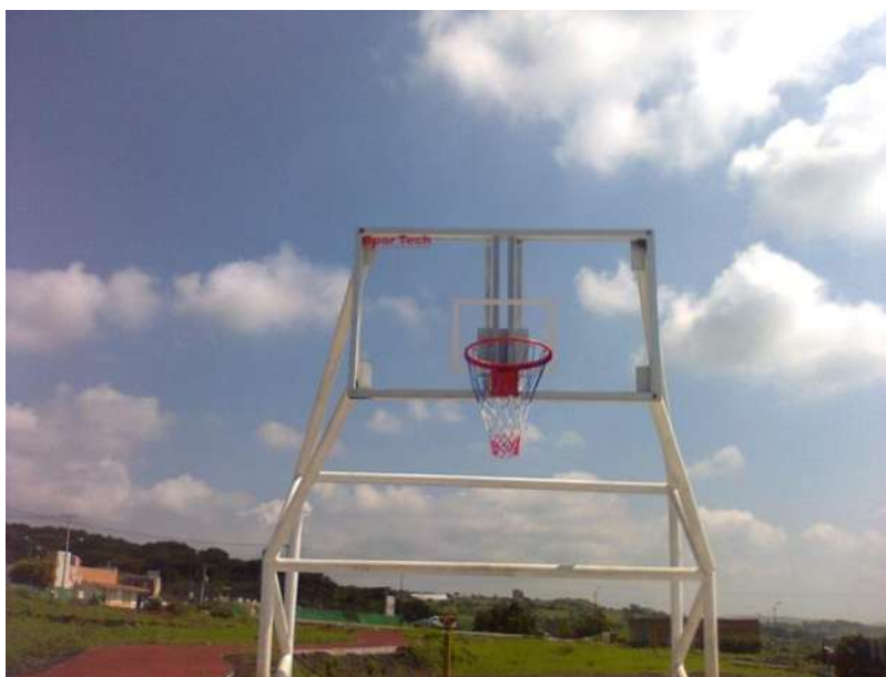
FOTO 5.12: ESTRUCTURA Y TABLERO EN CANCHA DE USOS MULTIPLES
