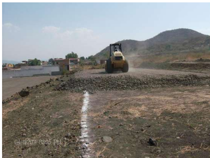
FOTO 4.3: COMPACTACIÓN DE TERRACERIAS EN CANCHA
