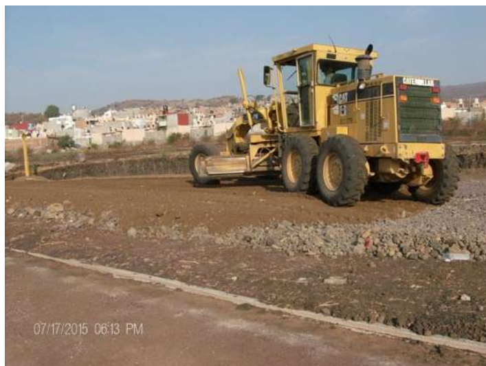
FOTO 4.2: ELABORACION DE BASE EN CANCHA DE FUT BOL
