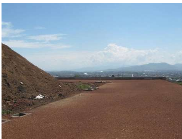
FOTO 2.16: CAPA DE BASE EN PLAZA
