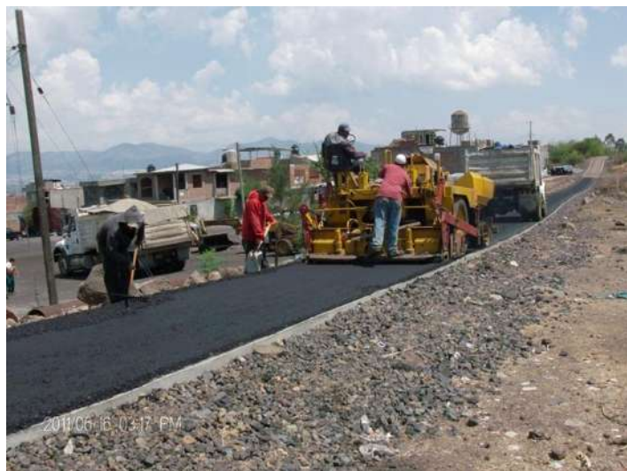
FOTO 5.1: TENDIDO DE CARPETA EN TROTAPISTA
