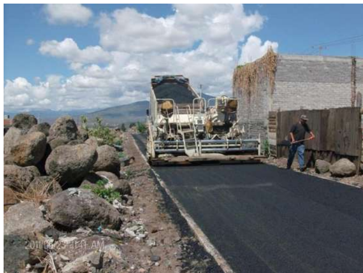
FOTO 5.2: TENDIDO DE CARPETA ASFALTICA EN CICLOPISTA
