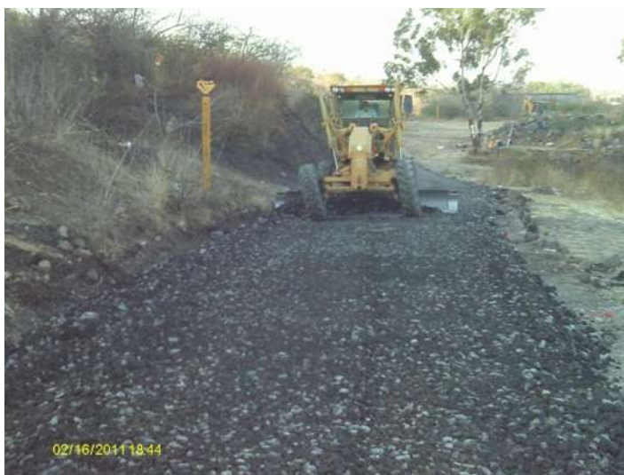
FOTO 2.8: TENDIDO DE LA CAPA DE FILTRO
