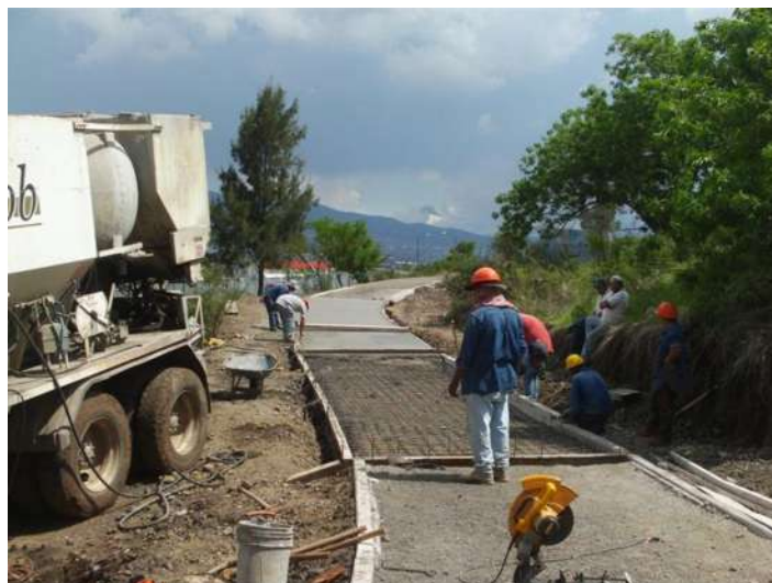
FOTO 3.6: COLADO DE ESTRUCTURA SOBRE GASODUCTO
