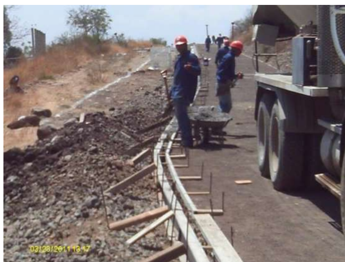
FOTO 3.4: COLADO DE GUARNICIONES DE CONCRETO
