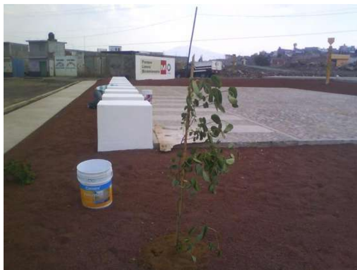
FOTO 4.15: PINTURA DE BANCAS, MURO DE IDENTIFICACIÓN Y PLAZA
