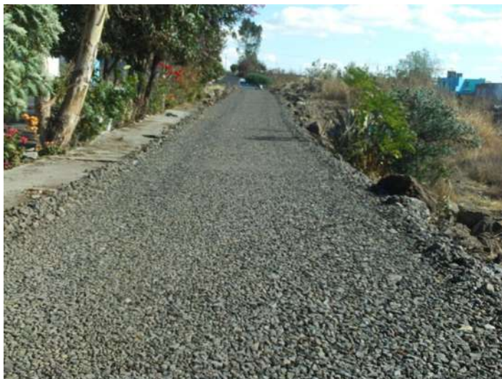
FOTO 2.3: TENDIDO DE MATERIAL FILTRO
