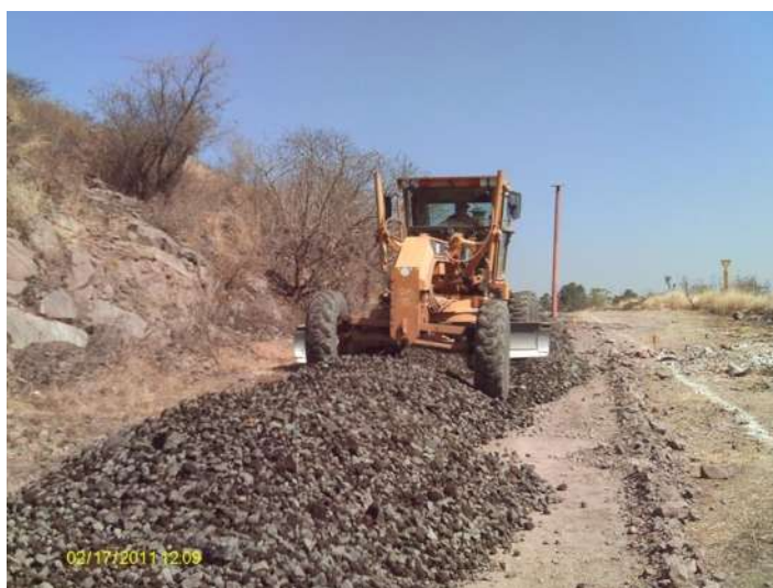
FOTO 2.7: TENDIDO DE MATERIAL FILTRO
