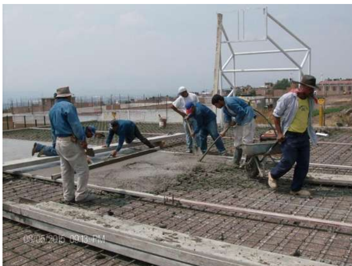
FOTO 4.10: COLADO DE LOZA EN CANCHA DE USOS MULTIPLES
