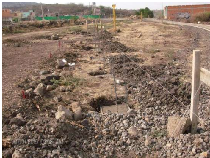
FOTO 3.8: SEMBRADO DADO DE CONCRETO ARMADO
