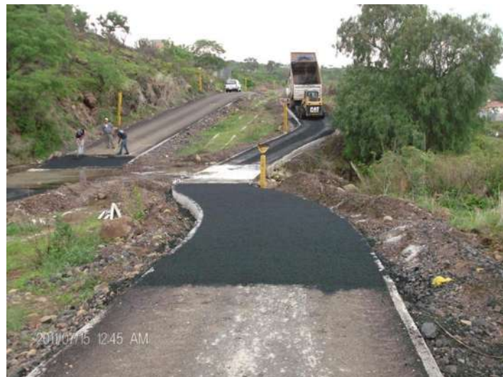
FOTO 5.4: TENDIDO DE CARPETA EN TROTAPISTA Y CICLOPISTA
