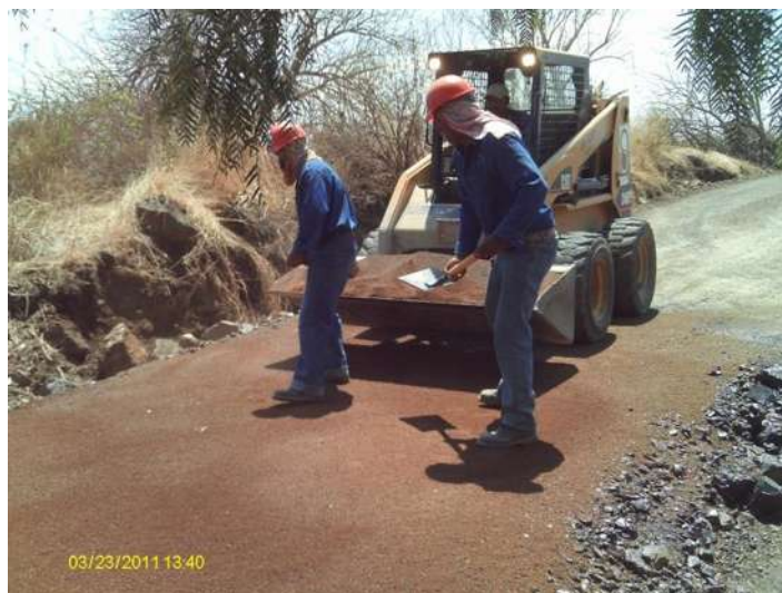
FOTO 3.1: PROTECCION CON ARENA RIEGO DE IMPREGNACIÓN
