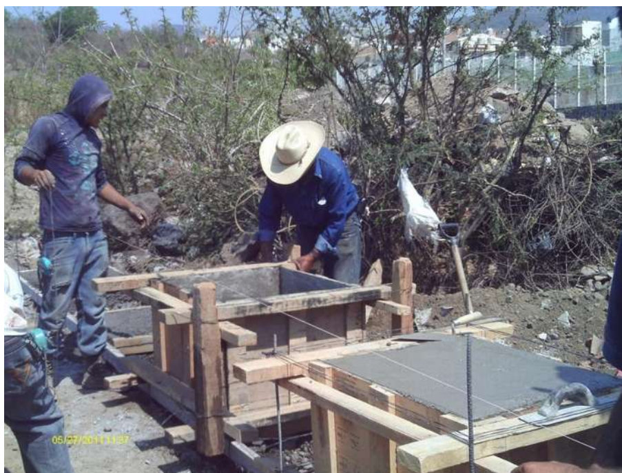
FOTO 4.13: CONSTRUCCION DE BANCAS
