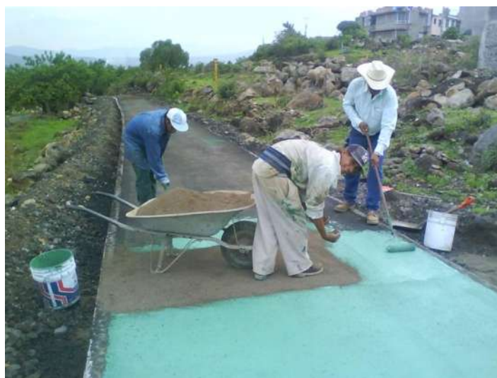
FOTO 5.7: PINTURA Y PROTECCIÓN EN CICLOPISTA
