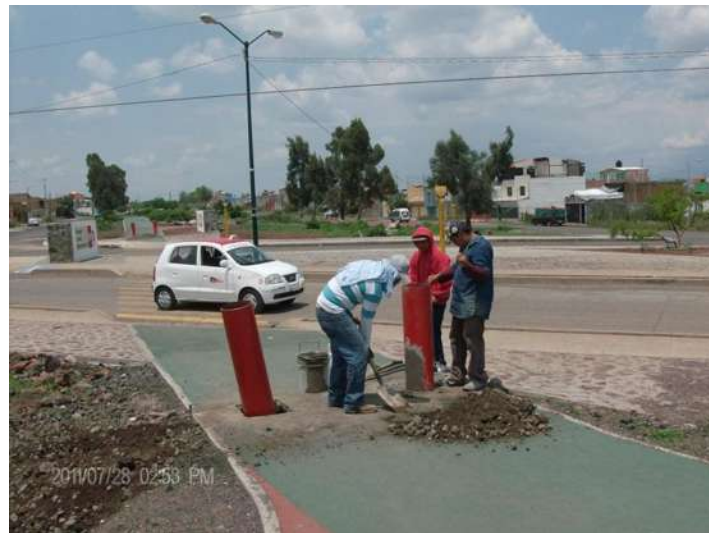
FOTO 5.10: COLOCACIÓN DE GUARDACANTONES EN CICLOPISTA
