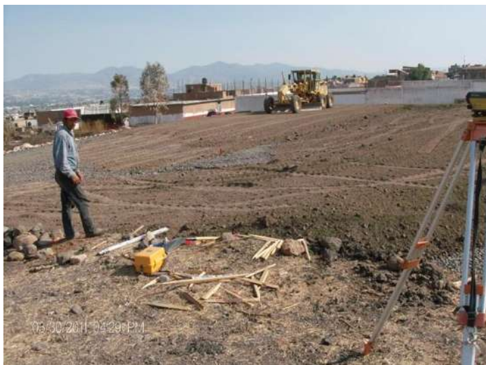
FOTO 2.13: TENDIDO CAPA DE BASE
