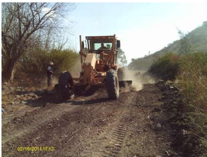
FOTO 2.5: NIVELACION TERRENO NATURAL
