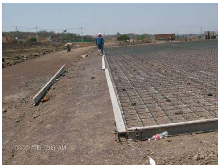
FOTO 4.4: ACERO DE REFUERZO EN PISO EN CANCHA
