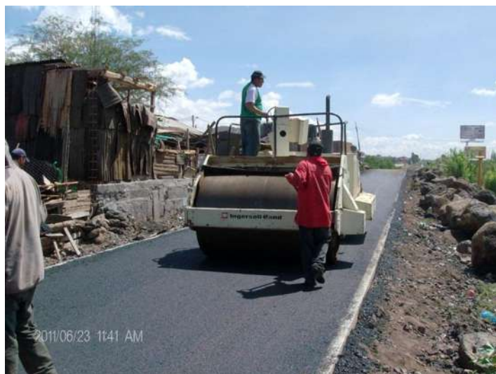
FOTO 5.3: COMPACTACION DE CARPETA ASFALTICA EN CICLOPISTA
