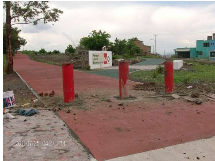
FOTO 5.9: COLOCACIÓN DE GUARDACANTONES EN TROTAPISTA
