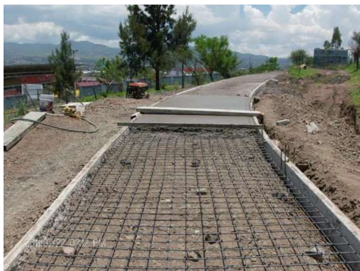
FOTO 3.5 : ACERO DED REFUERZO EN CRUCE DE GASODUCTO
