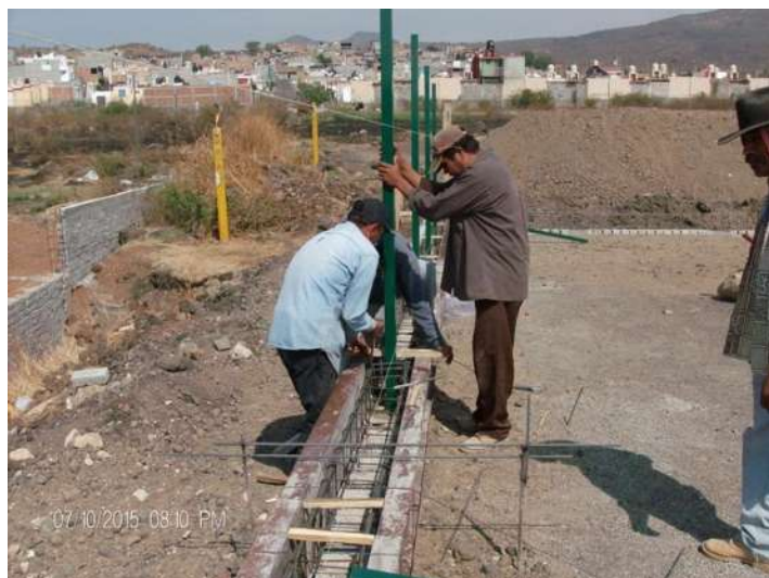
FOTO 4.9: COLOCACION REJA ACERO Y MURO DE CONCRETO
