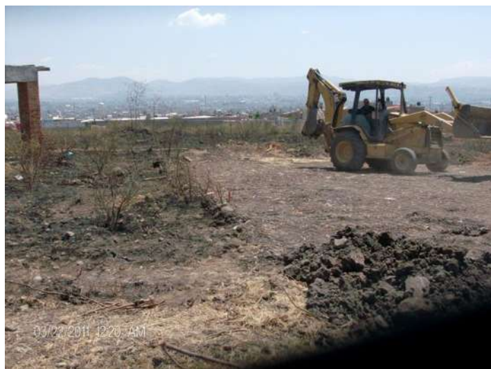
FOTO 4.1: APERTURA DE CAJA CANCHA DE FUT BOL
