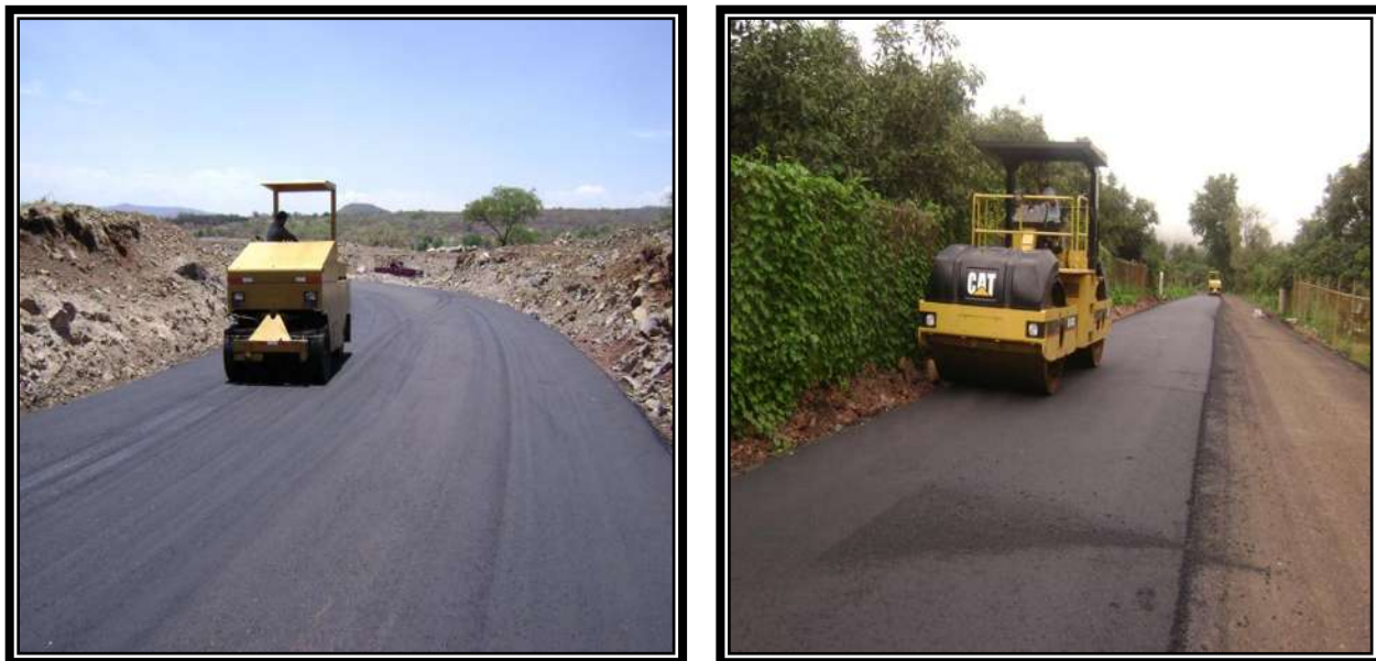
Fig. 3.56 COMPACTACION CON NEUMATICO TANDEM Y VIBROCOMPACTADOR.
