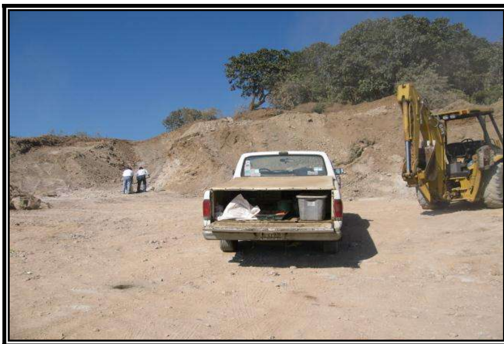
Fig. 3.18 TOMA DE MUESTRAS DEL BANCO DE MATERIAL.
