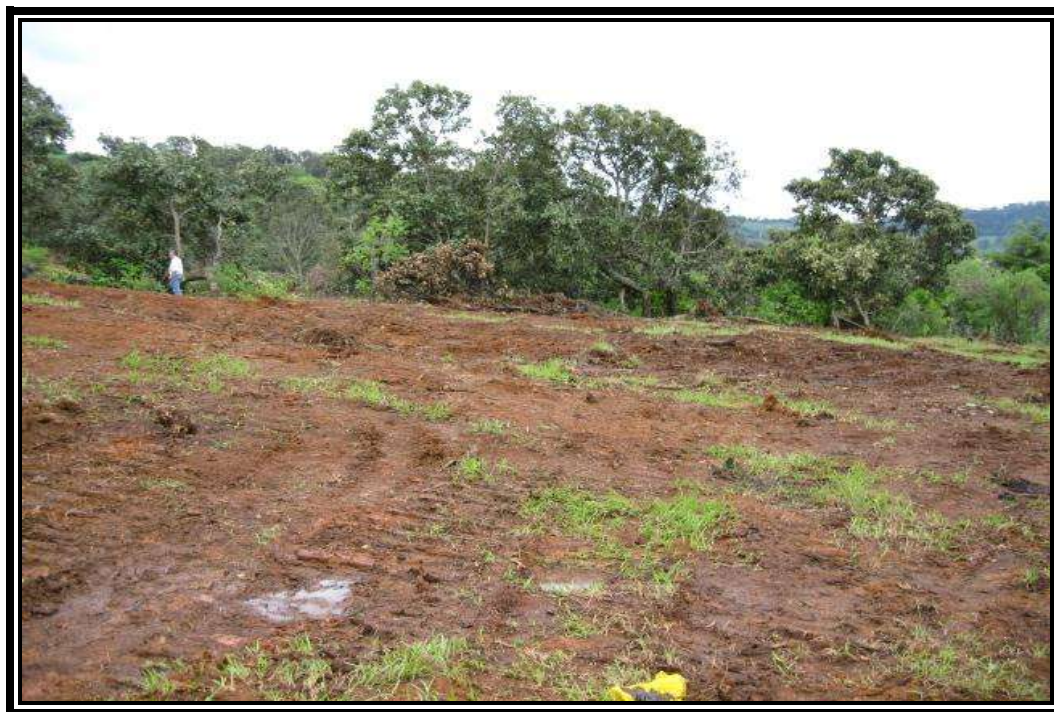
Fig.3.6 RETIRO DEL DESMONTE.
