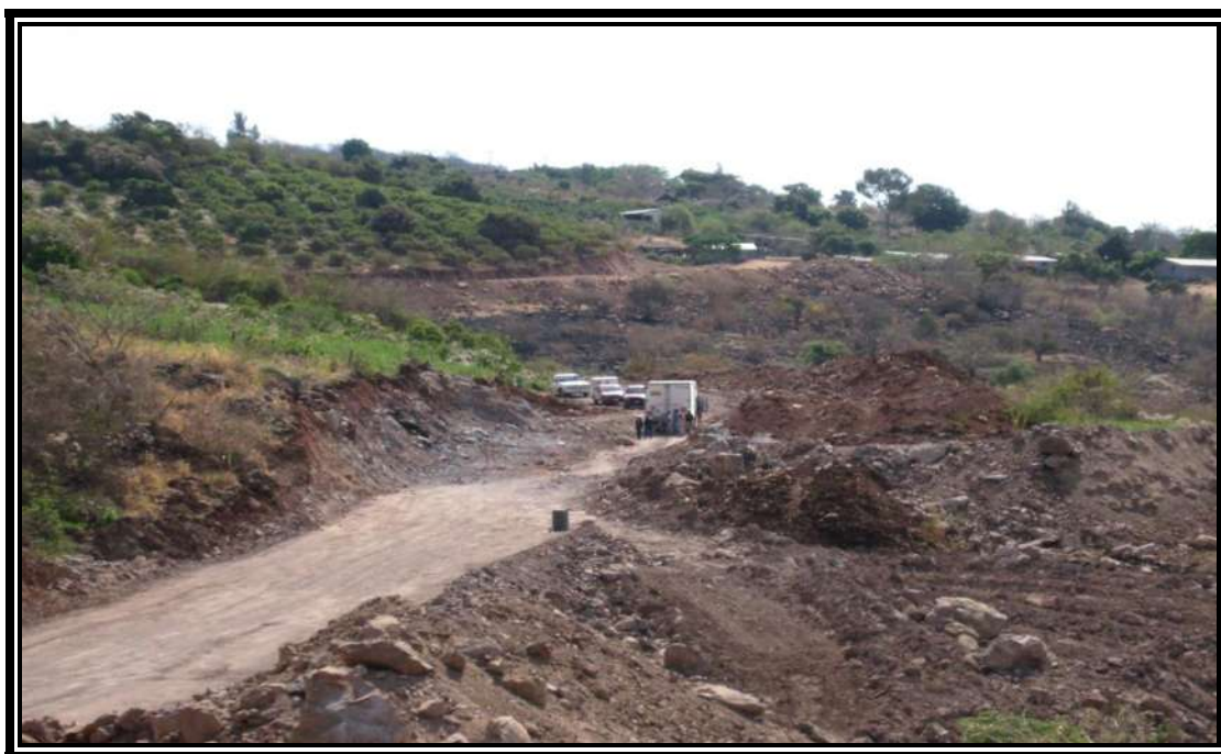
Fig. 3.15 PREPARACION DE EXPLOSIVOS EN EL MATERIAL.
