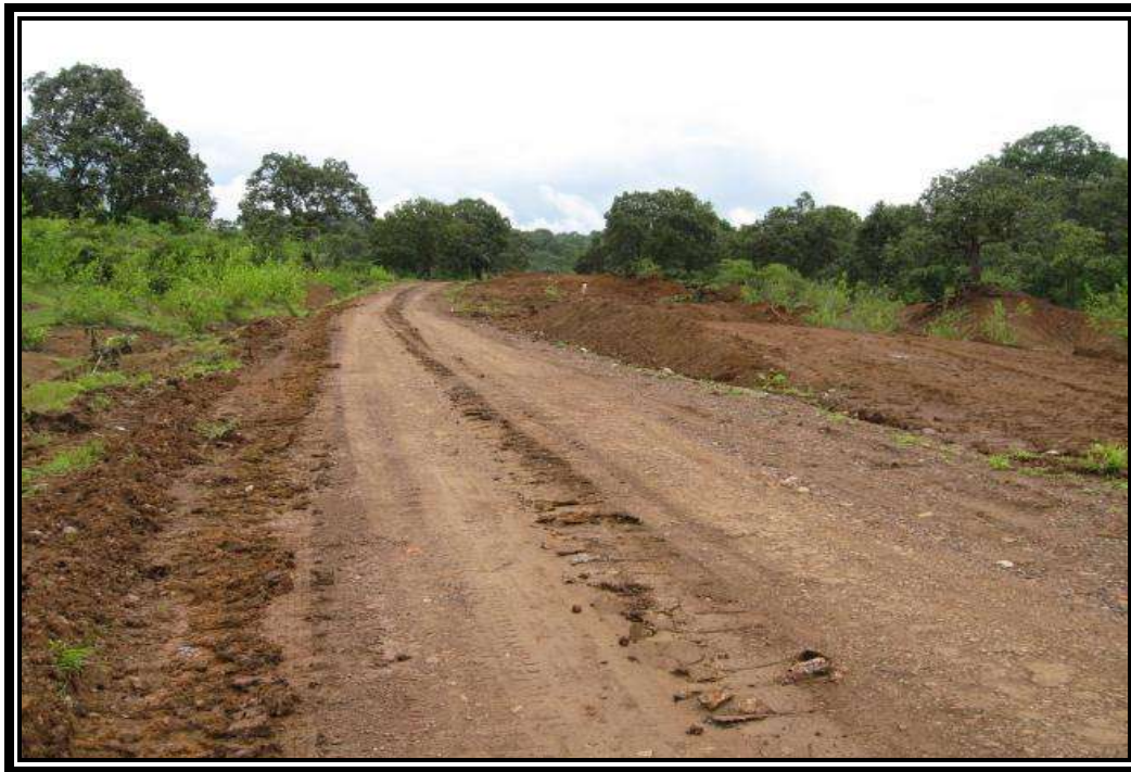
Fig. 3.8 DESPALME EN TERRAPLEN.
