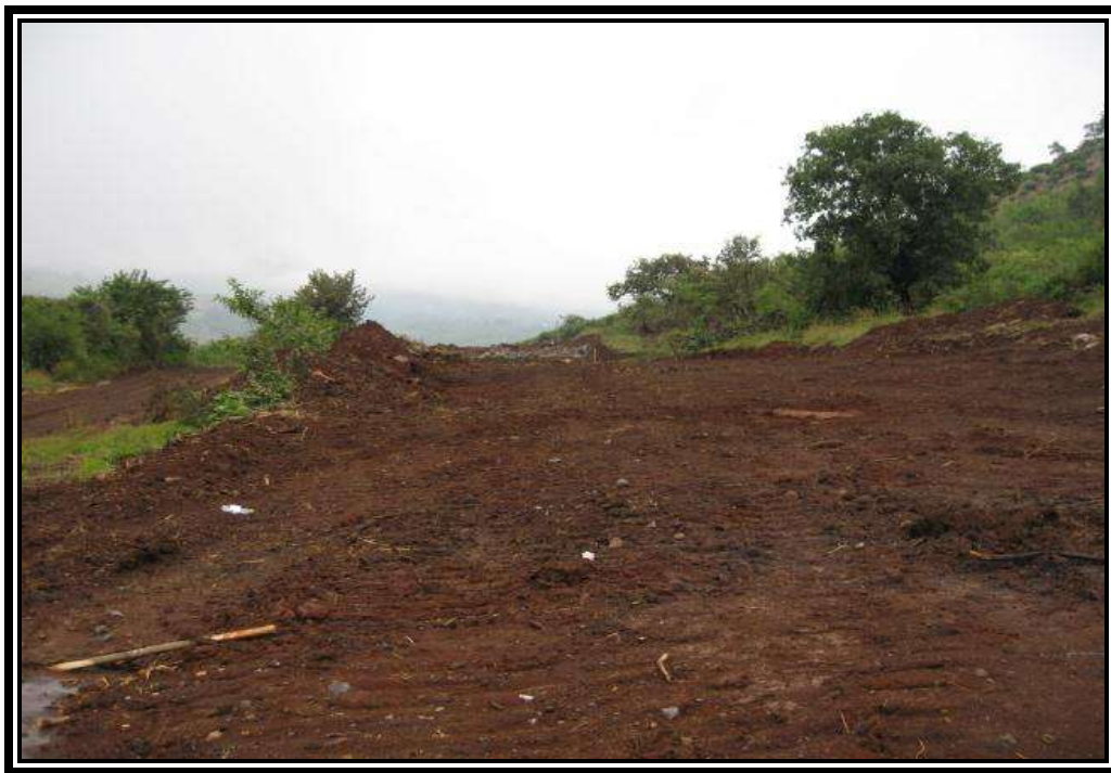
Fig. 3.7 DESPALME EN CORTE.
