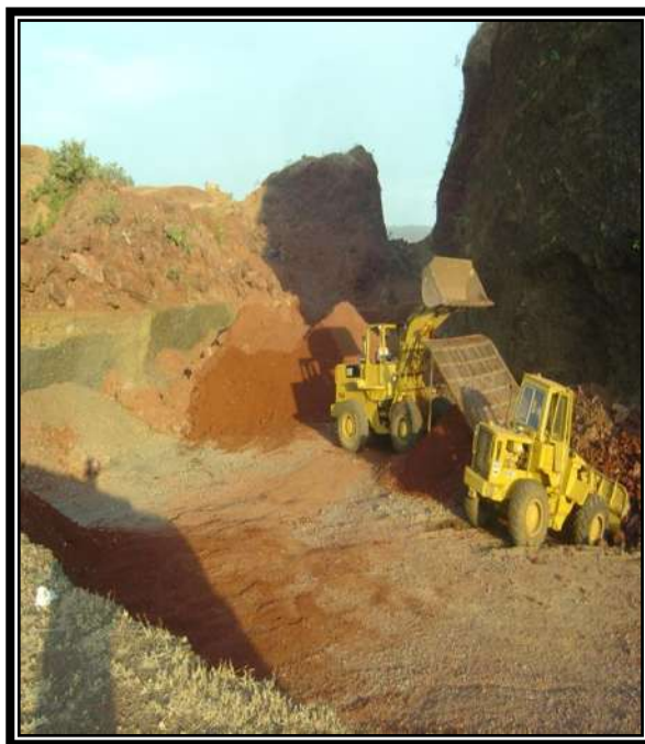
Fig. 3.45 MATERIAL PARA LA BASE HIDRAULICA.
