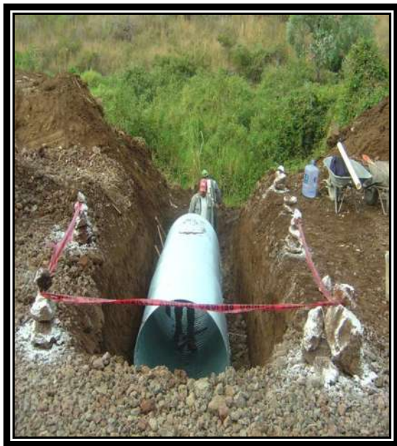
Fig.3.34 EXCAVACION PARA OBRA DE RENAJE.
