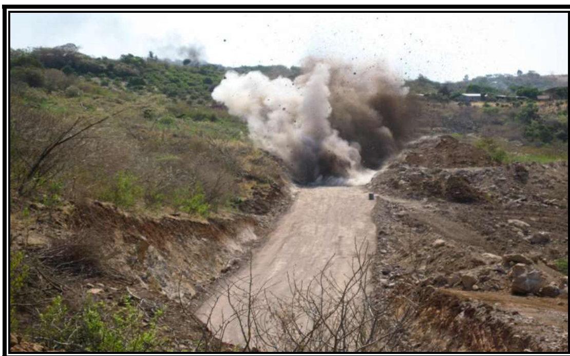
Fig. 3.16 VOLADURA EN MATERIAL TIPO "C" PARA VACIAR CORTE.
