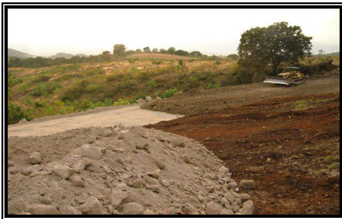
Fig. 3.22 FORMACION DE TERRAPLEN.
