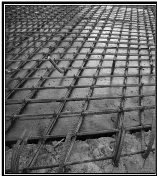
Fig. 3.40 ACERO PARA ESTRUCTURAS DE CONCRETO REFORZADO.
