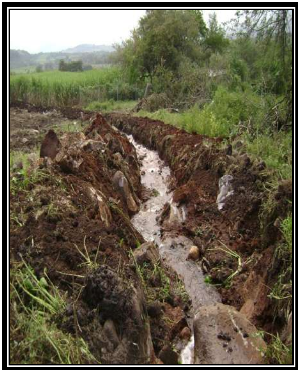
Fig. 3.25 DESVIO DEL CAUCE DEL AGUA.
