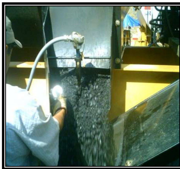
Fig. 3.54 VERIFICACION DE TEMPERATURA DE LA MEZCLA ASFALTICA.
