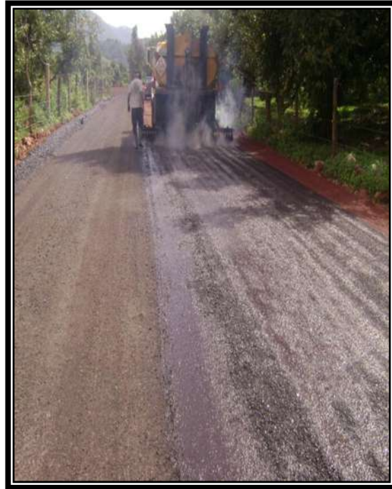
Fig. 3.48 LA PETROLIZADORA APLICANDO EL RIEGO DE IMPREGNACION.
