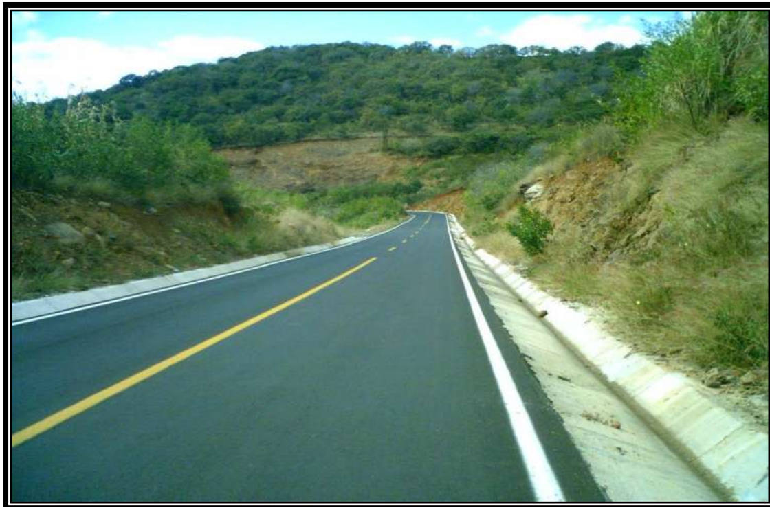
Fig.3.72 SEÑALAMIENTO HORIZONTAL LINEA CONTINUA Y DISCONTINUA.
