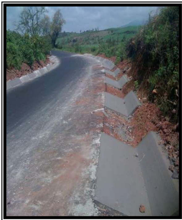
Fig. 3.42 CONSTRUCCION DE CUNETAS.
