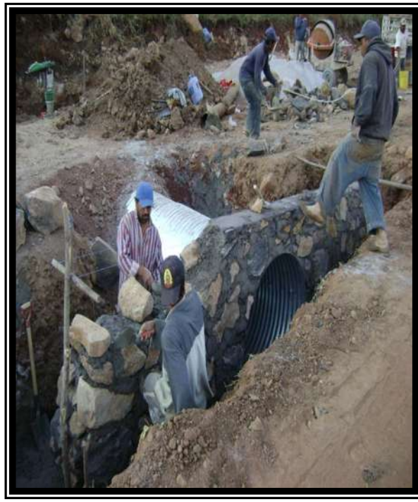
Fig. 3.43 OBRA DE DRENAJE DE \varnothing = 0.90 m. EN EL KM 11+839.53 Y EN EL KM 12+300
