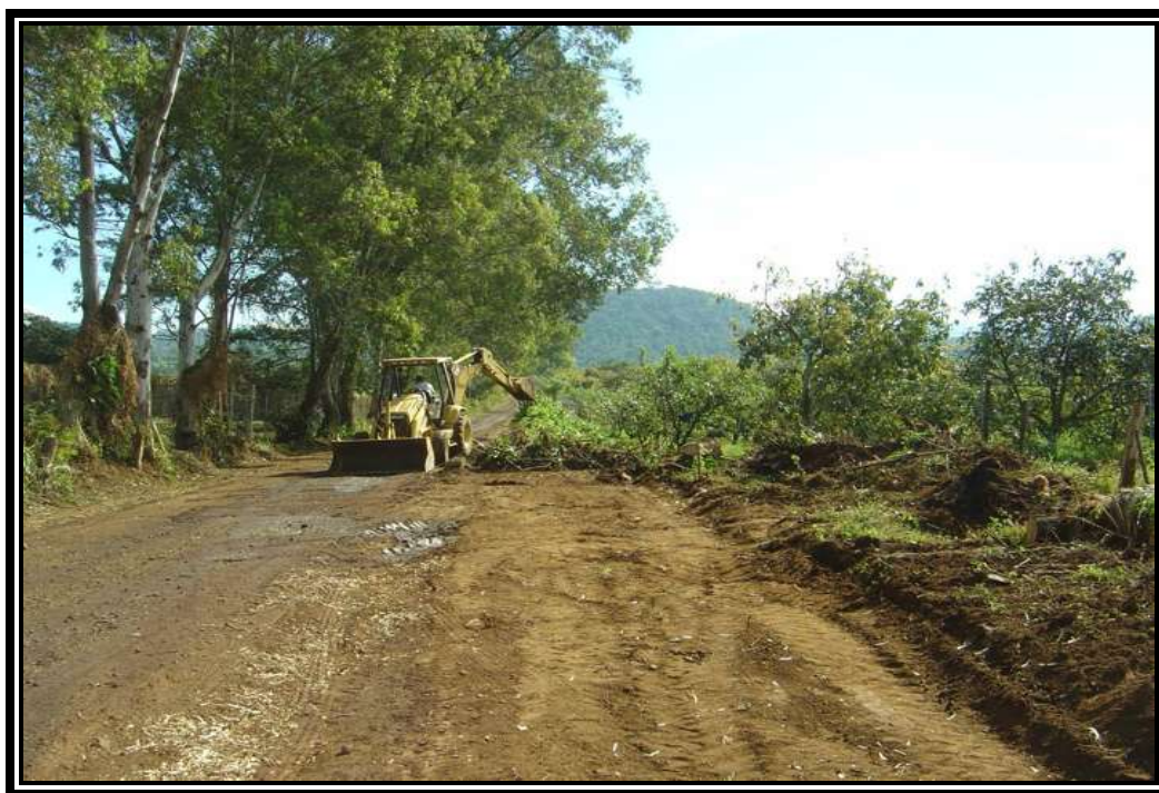
Fig. 3.5 DESMONTE DE ÁRBOLES Y ARBUSTOS.
