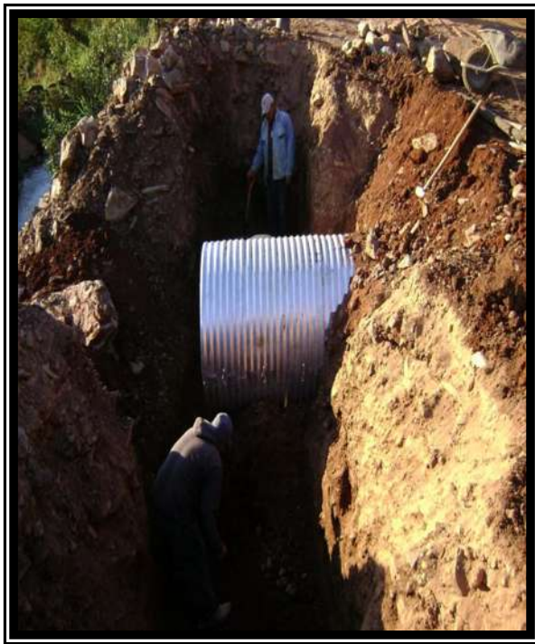
Fig. 3.43 OBRA DE DRENAJE DE \varnothing = 0.90 m. EN EL KM 11+839.53 Y EN EL KM 12+300
