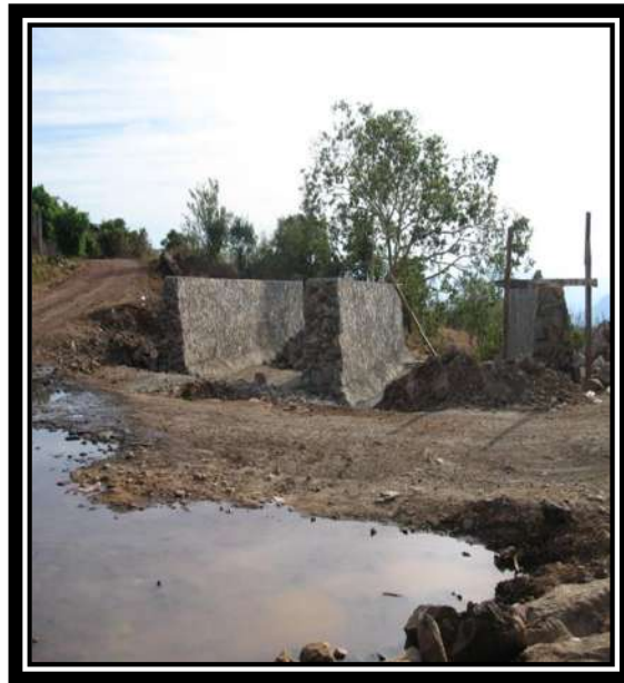
Fig. 3.38 MURO DE MAMPOSTERIA.
