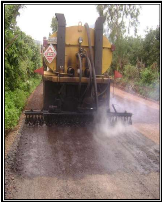
Fig. 3.48 LA PETROLIZADORA APLICANDO EL RIEGO DE IMPREGNACION.
