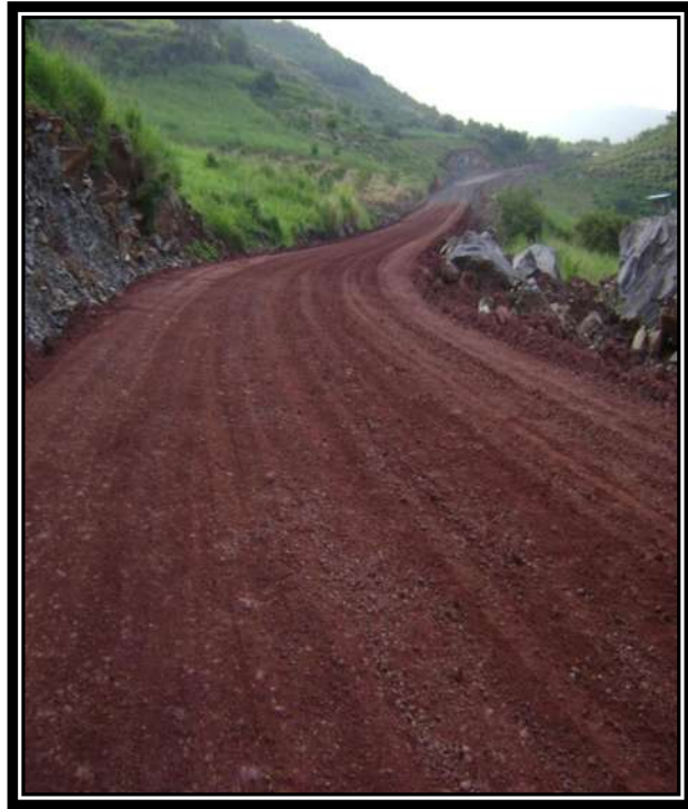
Fig. 3.28 TENDIDO DE LA CAPA DE SUBRASANTE.
