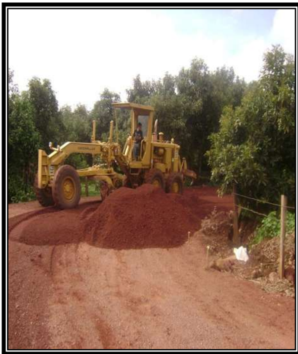
Fig. 3.46 ACAMELLONAMIENTO Y TENDIDO DE MATERIAL – COMPACTACION DE BASE HIDRAULICA.
