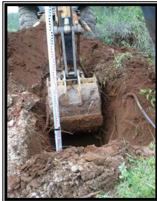
Fig. 1.2 EXCAVACION DE SONDEOS PRELIMINARES.
