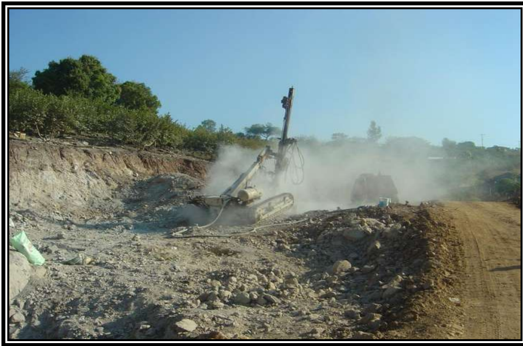
Fig. 3.12 PREPARACION DE VOLADURA EN MATERIAL TIPO “C” PARA VACIAR CORTE.
