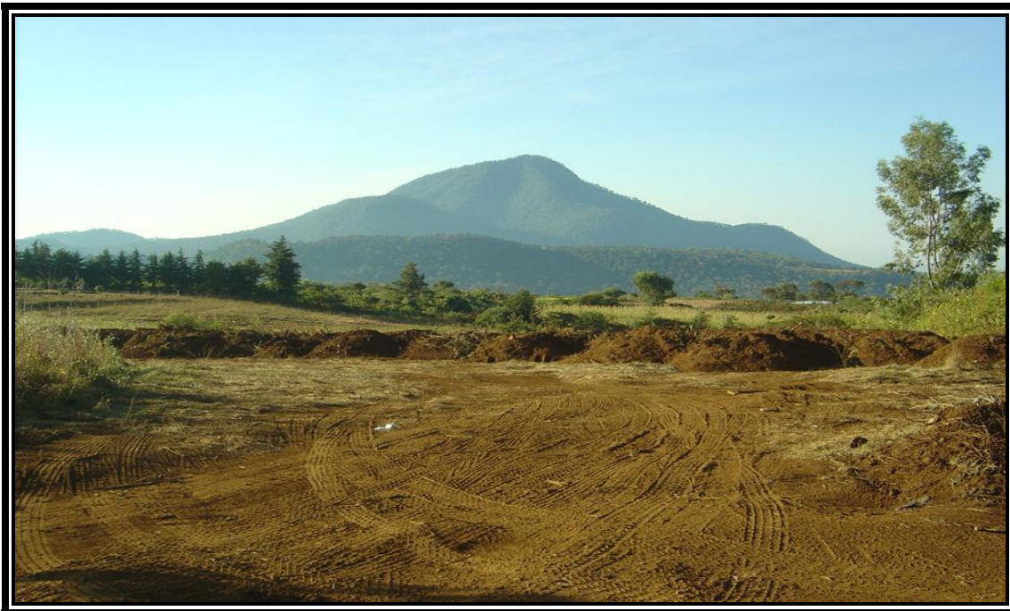
Fig. 3.20 ALMACENAMIENTO DEL MATERIAL A DESPERDICIO EN EL BANCO.
