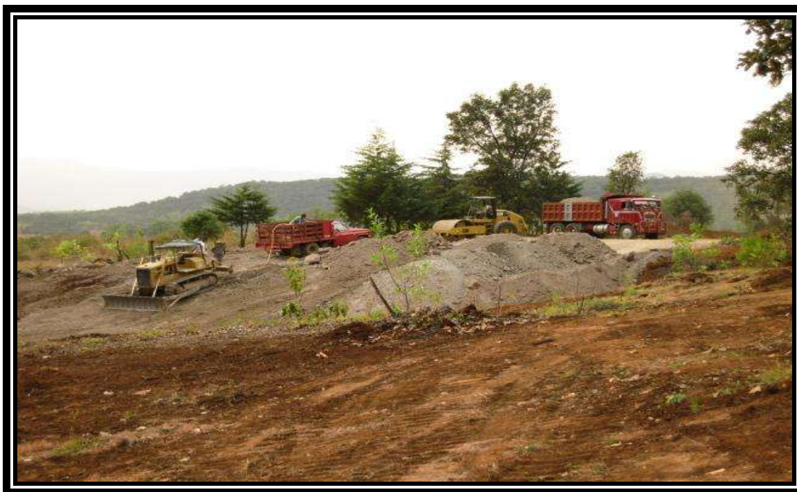
Fig. 3.23 TENDIDO DE MATERIAL PARA LA FORMACIÓN DE TERRAPLENES.
