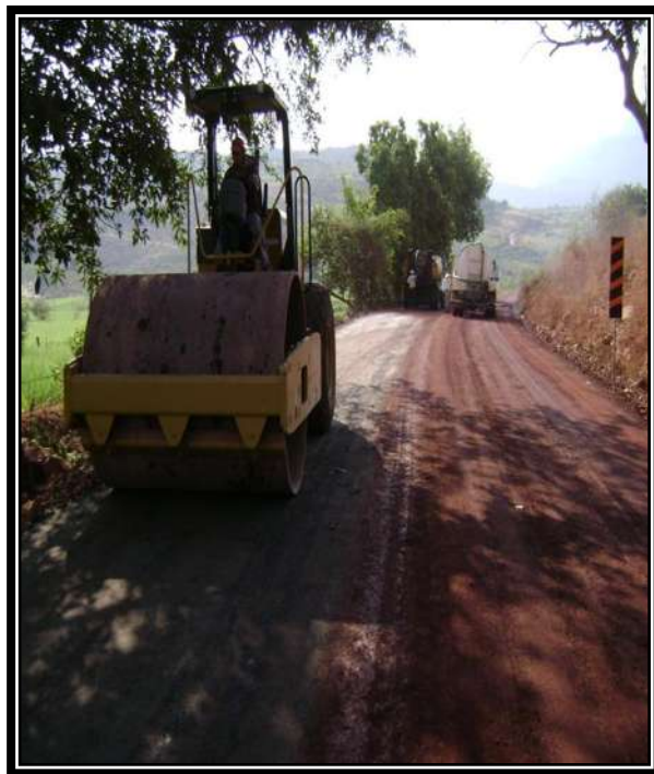
Fig. 3.46 ACAMELLONAMIENTO Y TENDIDO DE MATERIAL – COMPACTACION DE BASE HIDRAULICA.
