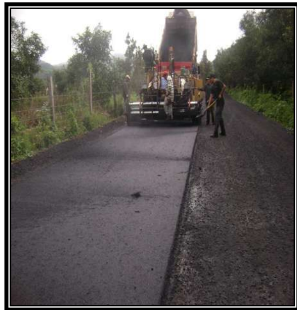
Fig. 3.55 TENDIDO DE LA CARPETA ASFALTICA.
