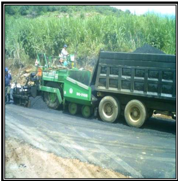
Fig. 3.55 TENDIDO DE LA CARPETA ASFALTICA.
