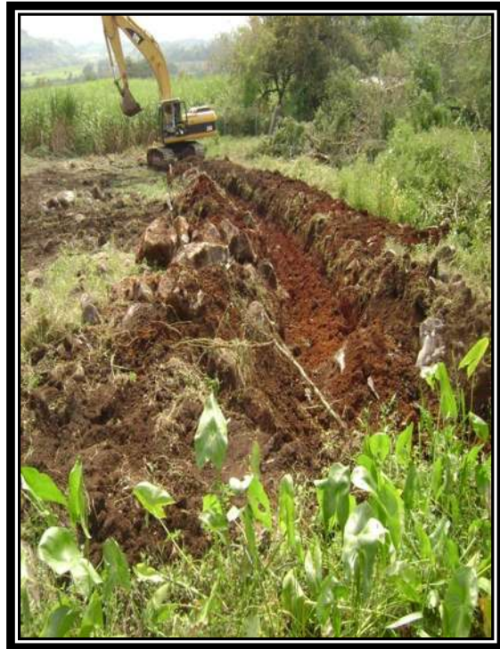
Fig. 3.24 EXCAVACION DEL CANAL.
