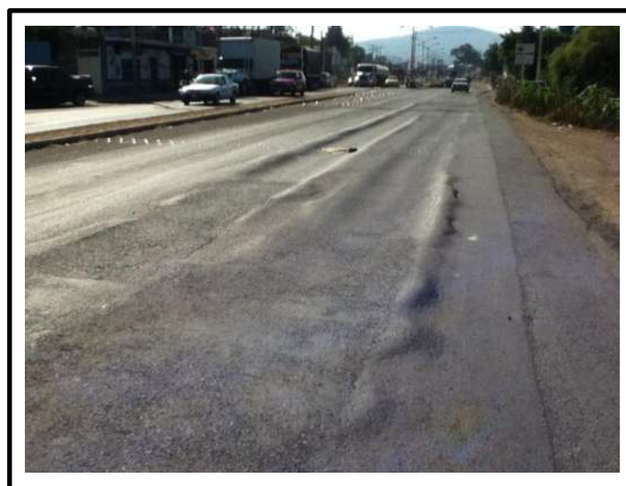
Figura 9. Formación de roderas en la superficie de rodamiento. José Eduardo García Servín.
