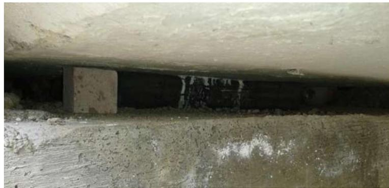
Figura 39. Colocación de los neoprenos
