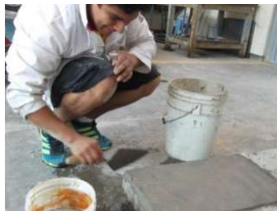
Ilustración 45. Colocación de la mezcla sobre la losa de concreto.
