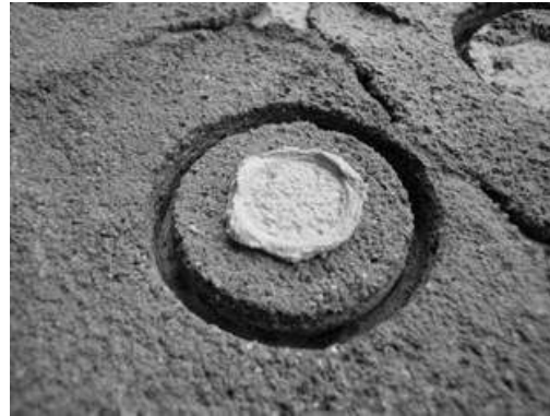
Ilustración 72. Falla entre epóxico y el dolly metálico.
