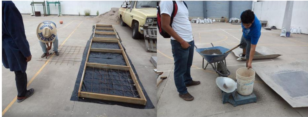
Ilustración 34. Molde de losas y peso de materiales.
