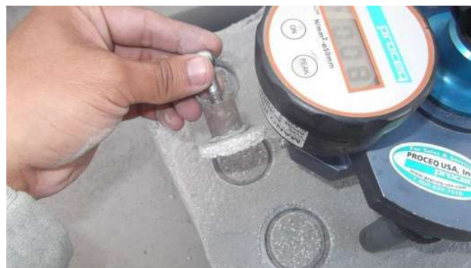
Ilustración 73. Falla entre revestimiento y el estrato. Tipo (3). Material Poliestireno.
