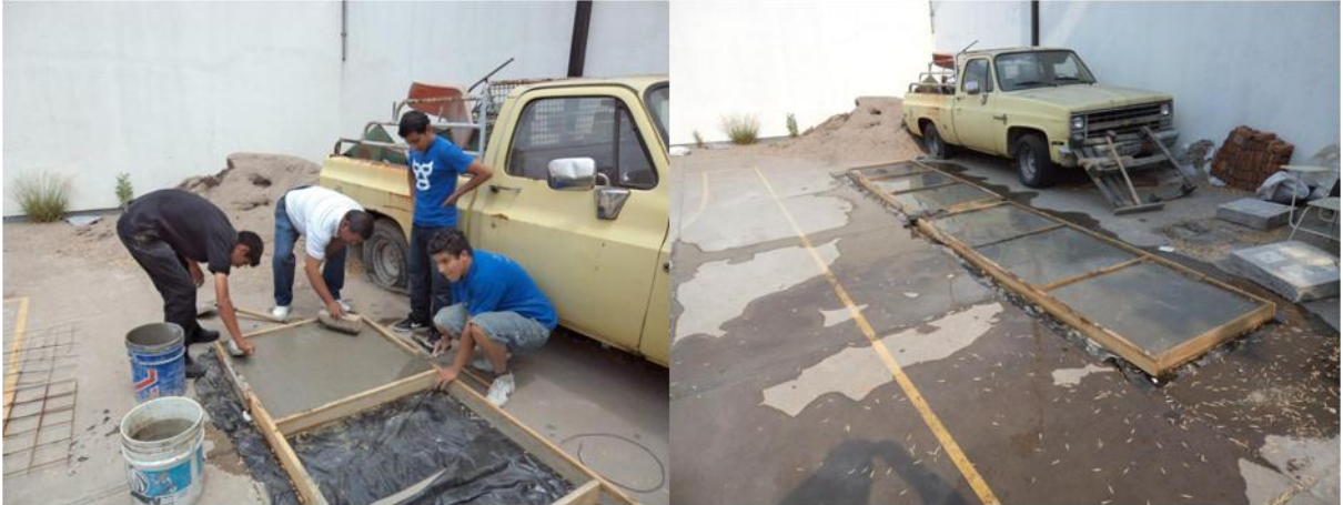
Ilustración 35. Acabado a las losas y curado hasta los 28 días.
