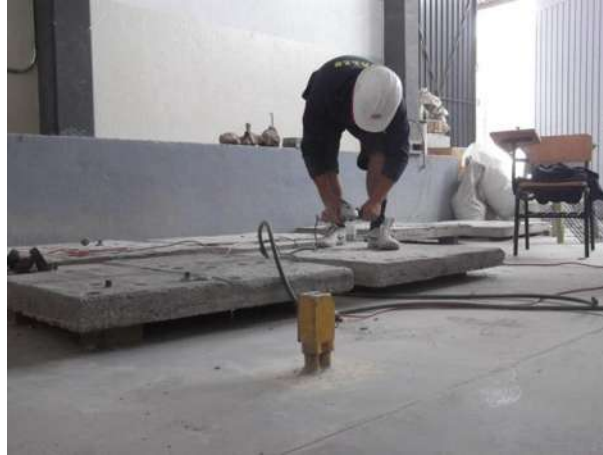
Ilustración 65. Perforación de las losas para la prueba de adherencia.
