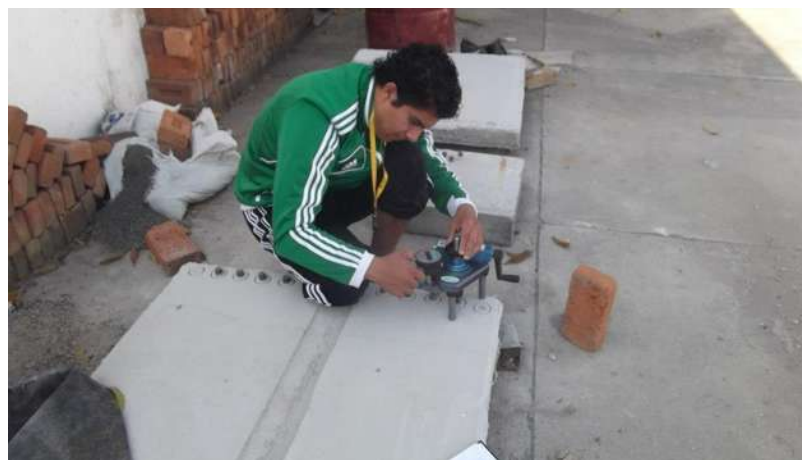
Ilustración 68. Realización de la prueba de adherencia, mediante el equipo de Pull Off.
