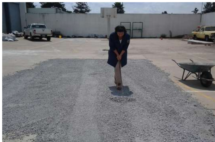
Ilustración 5 Tendido del Material fino.
