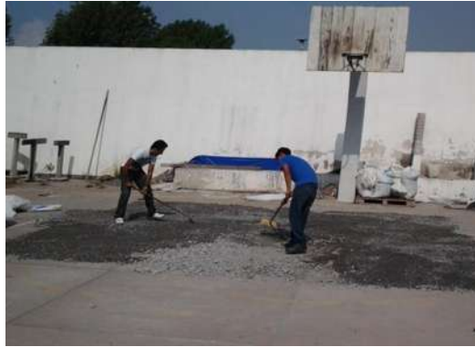
Figura 21. Tendido del material grueso reciclado.
