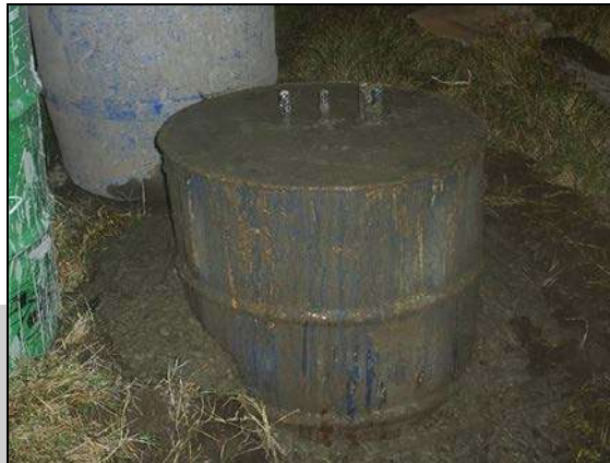
MUERTO COLADO EN OBRA PARA DOBLEZ DE VARILLA.
