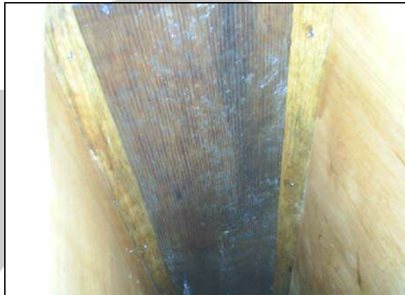
COLOCACION DE TIRAS DE RELLENO.
