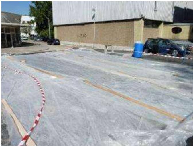
Figura 286. Protección. (PAVIMENTOS DE HORMIGÓN POROSO – HYDROMEDIA™, Efficient Building™ system, 8.2.2 – CAMINOS Y PAVIMENTOS, ESPAÑA, Marzo 2013.) Consultada el 26 de septiembre del 2013.
