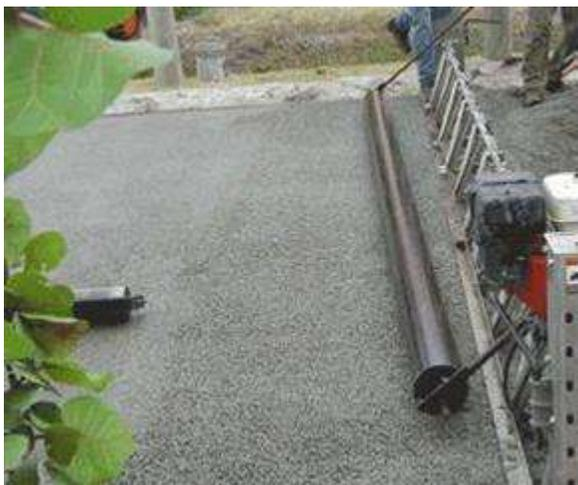
Figura 285. Compactación. (PAVIMENTOS DE HORMIGÓN POROSO – HYDROMEDIA™, Efficient Building™ system, 8.2.2 – CAMINOS Y PAVIMENTOS, ESPAÑA, Marzo 2013.) Consultada el 26 de septiembre del 2013.
