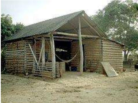
Figura 1. Rancho en el Llano Venezolano construida mediante bahareque. (<http://www.monografias.com/trabajos94/evolucion-historica-materiales-construccion-viviendas/evolucion-historica-materiales-construccion-viviendas.shtml>). Consultada el 29 de agosto del 2013.
