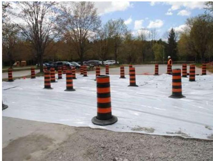
Figura 289. Dada la porosidad del material, no es adecuado usar líquido de curado. En su lugar, debemos cubrir la superficie con una película de polietileno de 7 a 10 días. (PAVIMENTOS DE HORMIGÓN POROSO – HYDROMEDIA™, Efficient Building™ system, 8.2.2 – CAMINOS Y PAVIMENTOS, ESPAÑA, Marzo 2013.) Consultada el 26 de septiembre del 2013.
