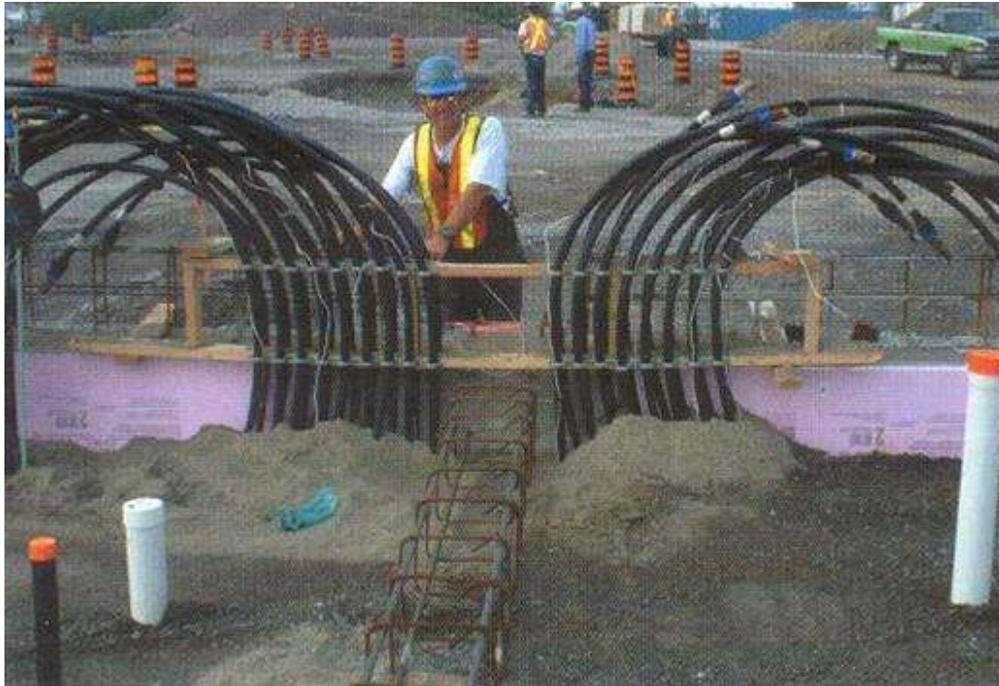
Figura 188. Ductos para circulación de agua dentro de cimentaciones térmicas. (Walter I. Paniagua Z., Pilotec, S.A. de C.V./ Alberto Jaime Paredes, División de Ingeniería Civil, Topográfica y Geodesia, UNAM. Tendencias en la construcción de cimentaciones profundas, Trends in deep foundations construction) consultada el 23 de septiembre del 2013.
