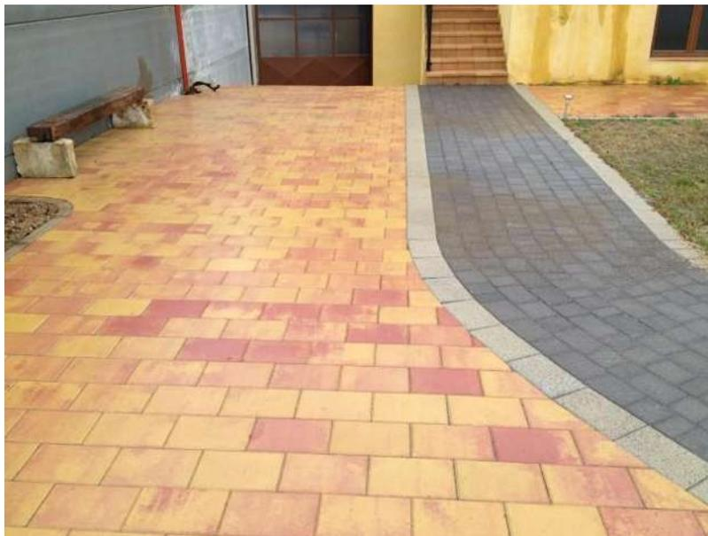
Figura 95. Patio adoquinado con tipo rectangular. (<http://prefabricadosjara.com/rectangular.html>) consultada el 26 de septiembre del 2013.
