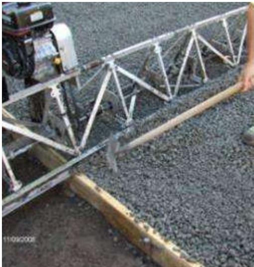
Figura 284. Nivelación. (PAVIMENTOS DE HORMIGÓN POROSO – HYDROMEDIA™, Efficient Building™ system, 8.2.2 – CAMINOS Y PAVIMENTOS, ESPAÑA, Marzo 2013.) Consultada el 26 de septiembre del 2013.
