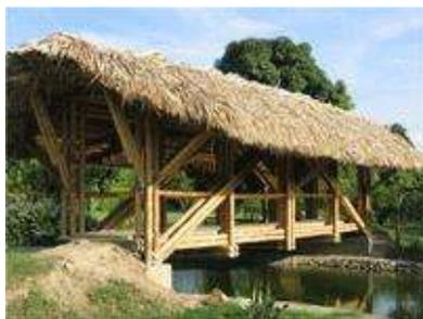
Figura 75. Construcción hecha con el sistema timagua. ([http://www.arqsustentable.net/ecoarq\\_guagua.html](http://www.arqsustentable.net/ecoarq_guagua.html)) consultada el 8 de septiembre del 2013.
