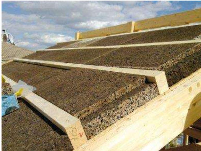
Figura 155. Aislante térmico dentro del cerramiento. (<http://www.construccion-y-reformas.vilssa.com/articulos/los-materiales-aislantes-termicos>) consultada el 19 de septiembre del 2013.
