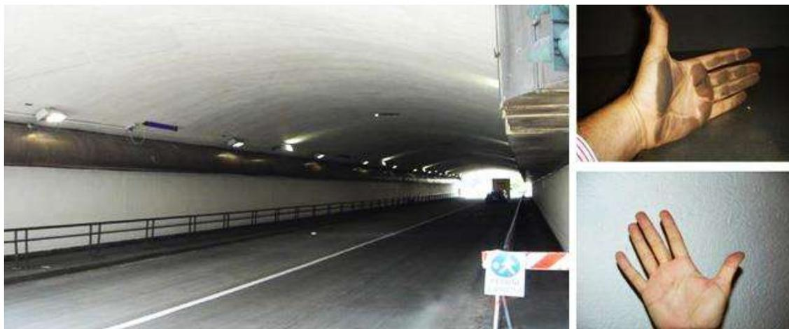
Figura 106. Diferencias un mes después de aplicar un recubrimiento fotocatalítico en base agua en el interior de un túnel. (<http://www.mimbrea.com/guia-practica/pinturas-fotocataliticas-para-purificar-el-aire>) consultada el 10 de septiembre del 2013.
