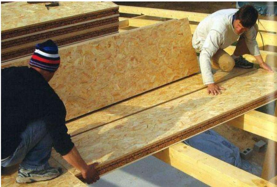
Figura 173. Montaje de paneles sándwich de corcho natural Selva Cuber. (<http://www.mimbrea.com/guia-practica/materiales-aislantes-fabricados-con-productos-reciclados>) consultada el 19 de septiembre del 2013.
