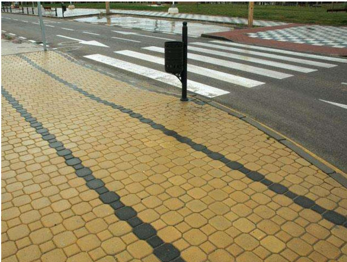
Figura 93. Banqueta adoquinada con adoquín tipo Uni jara.
