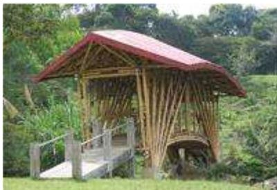
Figura 77. Pequeño puente hecho con el sistema timagua.
