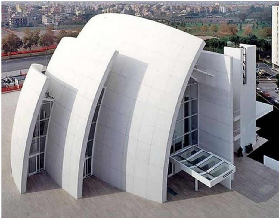
Figura 100. Radiante. Paneles de cemento blanco con nanopartículas que atrapan la suciedad y la descomponen, Iglesia del Jubileo, diseñada por Richard Meier en Roma. ([http://arq.clarin.com/construccion/Materiales-verdes-nanotecnologia\\_0\\_580142201.html](http://arq.clarin.com/construccion/Materiales-verdes-nanotecnologia_0_580142201.html)) consultada el 10 de septiembre del 2013.
