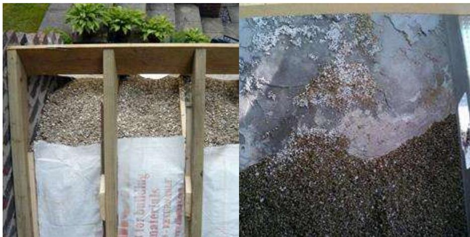
Figura 166. Perlita / vermiculita como aislantes térmicos.
