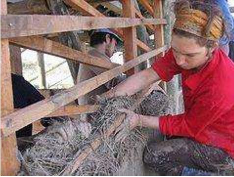
Figura 2. Embarrado de la trama de madera para elaborar un muro de fajina o bahareque. (Progreso, Uruguay).
