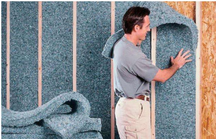
Figura 172. Algodón como aislante acústico y térmico. ((<http://www.mimbrea.com/guia-practica/materiales-aislantes-fabricados-con-productos-reciclad0s>) consultada el 19 de septiembre del 2013.
