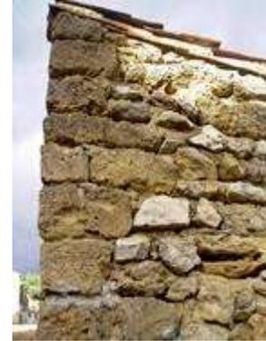
Figura 46. Piedra para refuerzo de cuevas esquinera Piedra y argamasa para muros Piedra de toba como refuerzo de esquinas.
