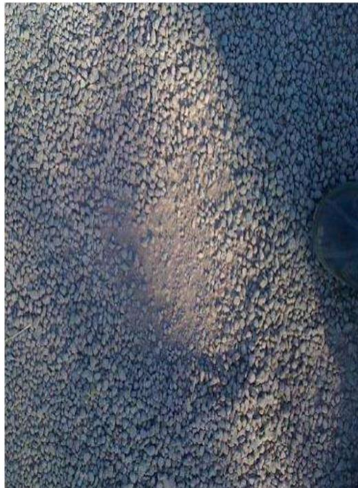
Figura 281. Ejemplo de una superficie permeable deshilachada. (PAVIMENTOS DE HORMIGÓN POROSO – HYDROMEDIA™, Efficient Building™ system, 8.2.2 – CAMINOS Y PAVIMENTOS, ESPAÑA, Marzo 2013.) Consultada el 26 de septiembre del 2013.
