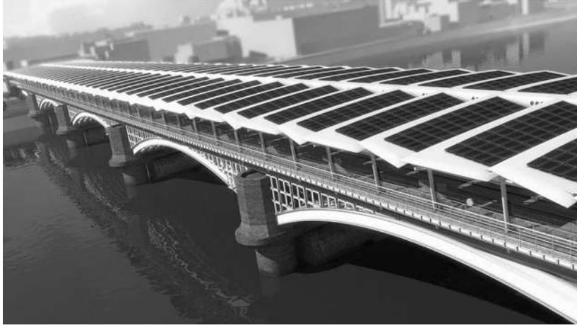
Figura 301. El puente Victoriano con paneles fotovoltaicos. (<http://www.evwind.com/wp-content/uploads/2013/02/london-pv.jpg>) consultada el 30 de septiembre del 2013.
