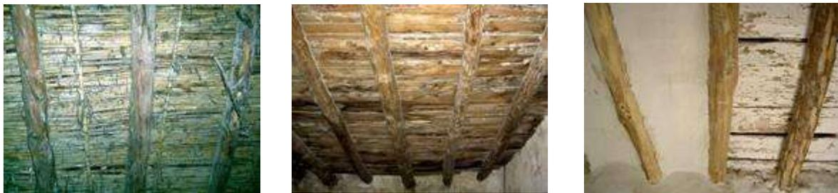
Figura 52. Cubierta de caña y madera      Cubierta con madera      Transición de madera a revoltón.
