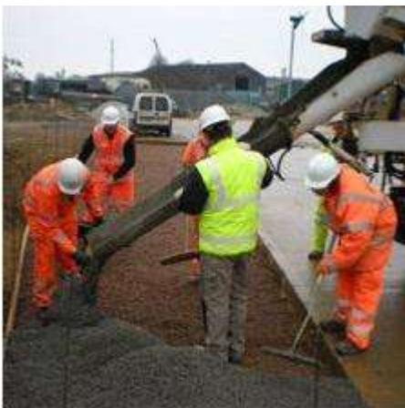
Figura 283. Ejecución. (PAVIMENTOS DE HORMIGÓN POROSO – HYDROMEDIA™, Efficient Building™ system, 8.2.2 – CAMINOS Y PAVIMENTOS, ESPAÑA, Marzo 2013.) Consultada el 26 de septiembre del 2013.
