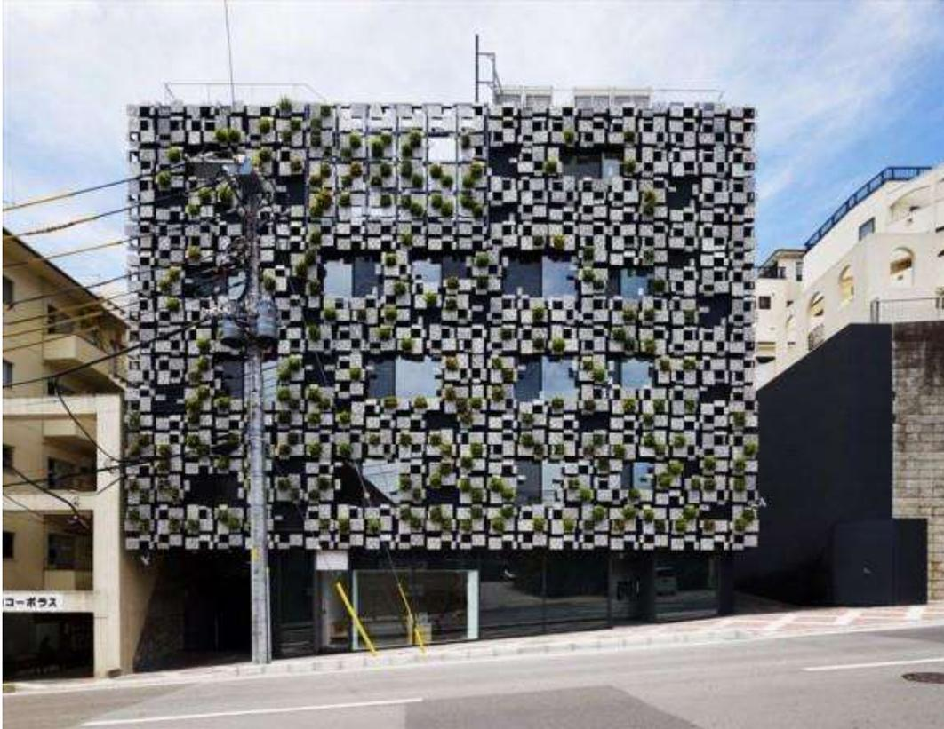
Figura 151. Paneles de aluminio de la fachada del 'Green Cast' (<http://alpolice.com/es/arquitectura/brotos-de-plantas-a-traves-de-una-fachada-de-aluminio-perforado-en-japon/#comment-2747>) consultada el 03 de octubre del 2013.
