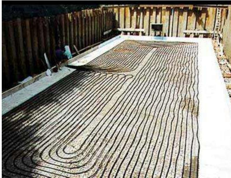
Figura 187. Ductos para circulación de agua dentro de cimentaciones térmicas. (Walter I. Paniagua Z., Pilotec, S.A. de C.V./ Alberto Jaime Paredes, División de Ingeniería Civil, Topográfica y Geodesia, UNAM. Tendencias en la construcción de cimentaciones profundas, Trends in deep foundations construction) consultada el 23 de septiembre del 2013.
