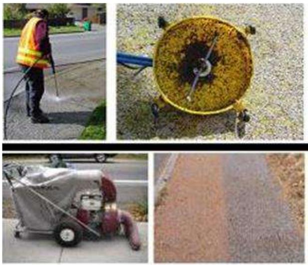
Figura 290. Lavado por presión y aspiración. (PAVIMENTOS DE HORMIGÓN POROSO – HYDROMEDIA™, Efficient Building™ system, 8.2.2 – CAMINOS Y PAVIMENTOS, ESPAÑA, Marzo 2013.) Consultada el 26 de septiembre del 2013.
