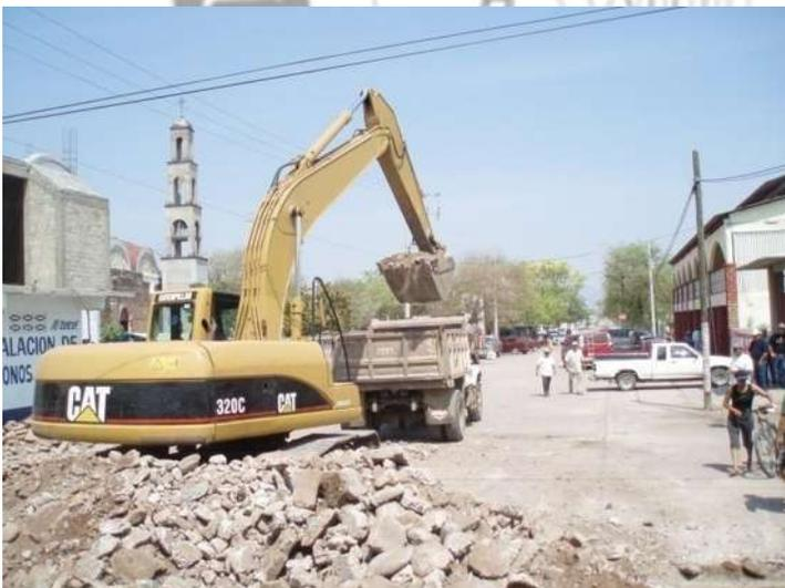
La reconstrucción del pavimento de la avenida de referencia consiste en sustituir la estructura actual por otra, mejorando los materiales recuperados o sustituyéndolos por material de banco en las condiciones recomendadas en este trabajo.
