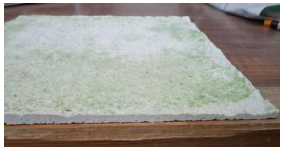
Imagen 5.42. Falta uniformidad [propia].
