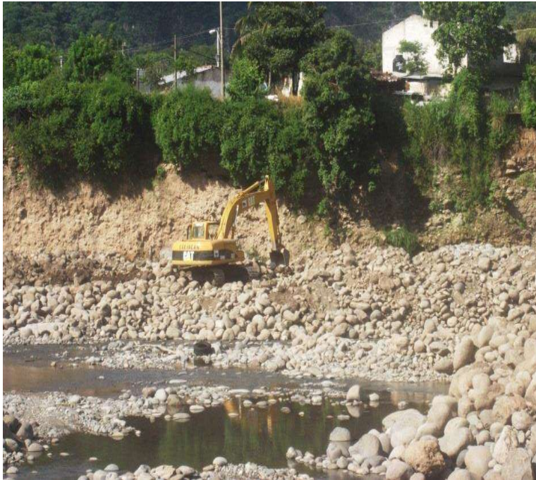
Imagen III.32 Excavadora 320c acomodando material para formación de pedraplén en el km 0+000 al km 0+302.
