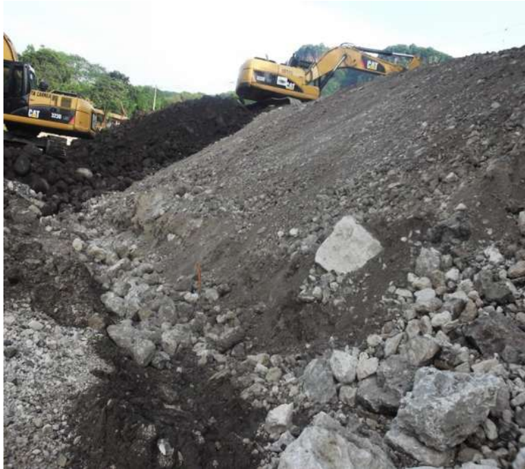
Imagen III.19 Colocación de capa de material grava-arena (greña).
