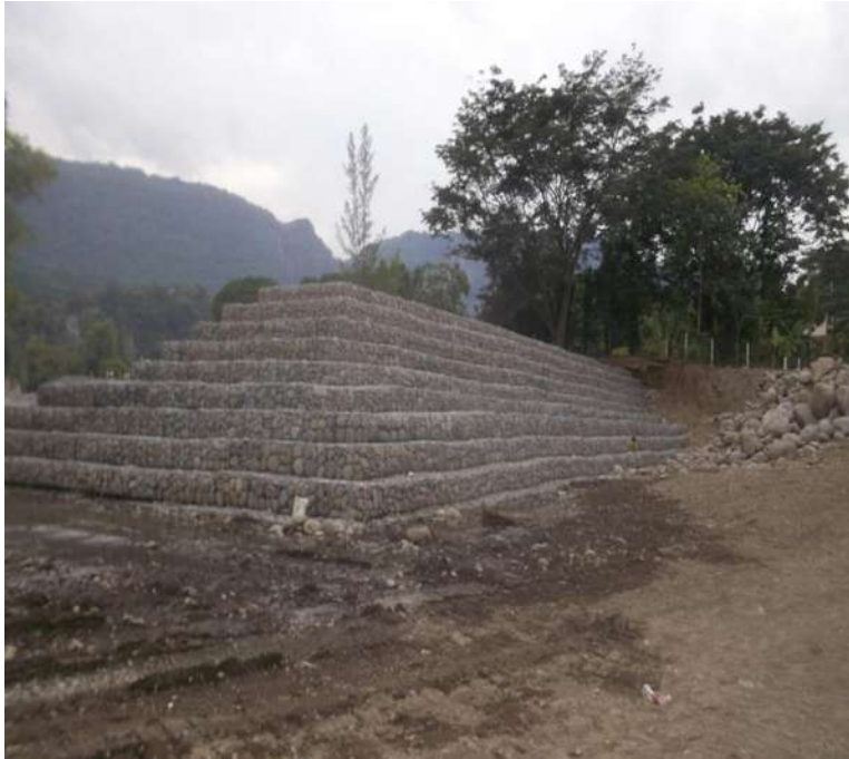
Imagen III.45 Espigón a base de gaviones terminado.
