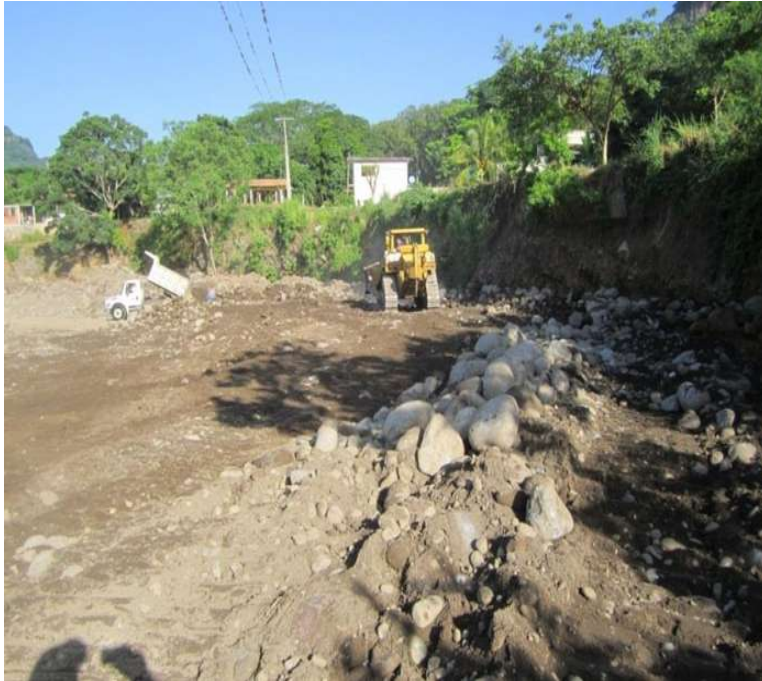
Imagen III.31 tractor D8R acomodando material en el pedraplén en el km 0+000 al km 0+302.
