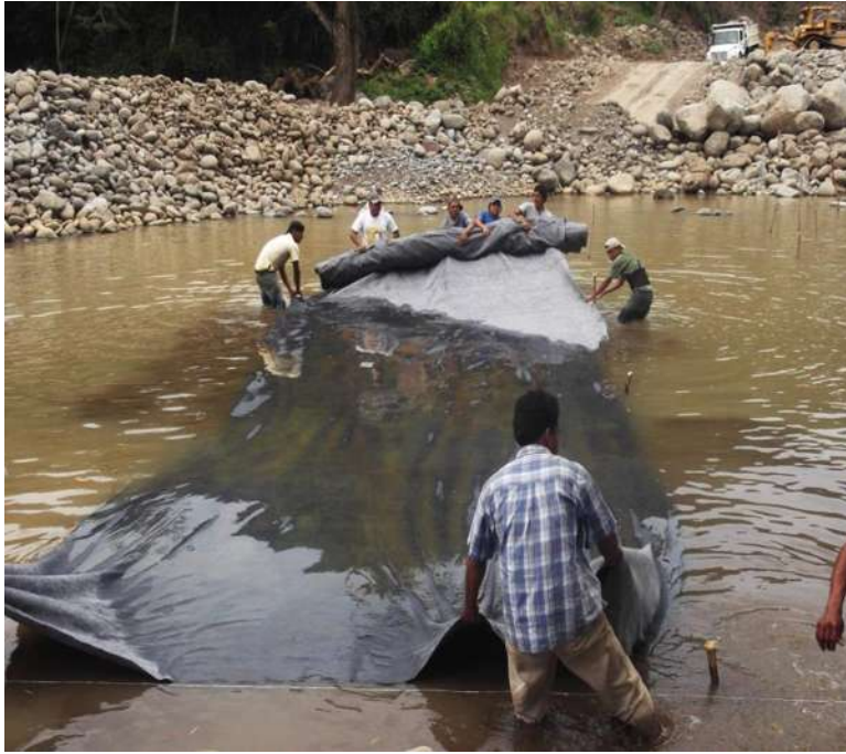
Imagen III.37 Colocación del geo textil en el espigón número 2 interpuesto en el bordo enrocado en el km 0+260 al 0+300.
