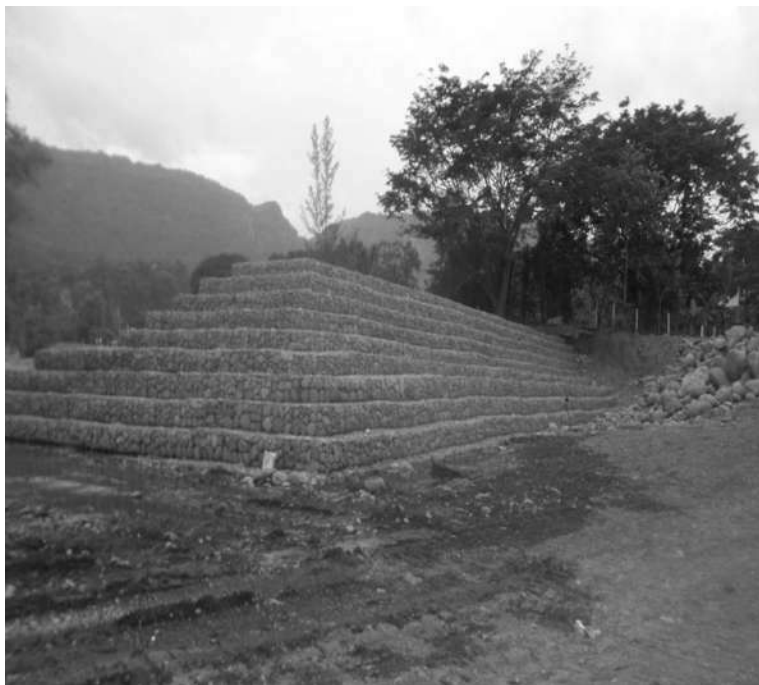
Imagen II.II.1 Espigón a base de gaviones.
