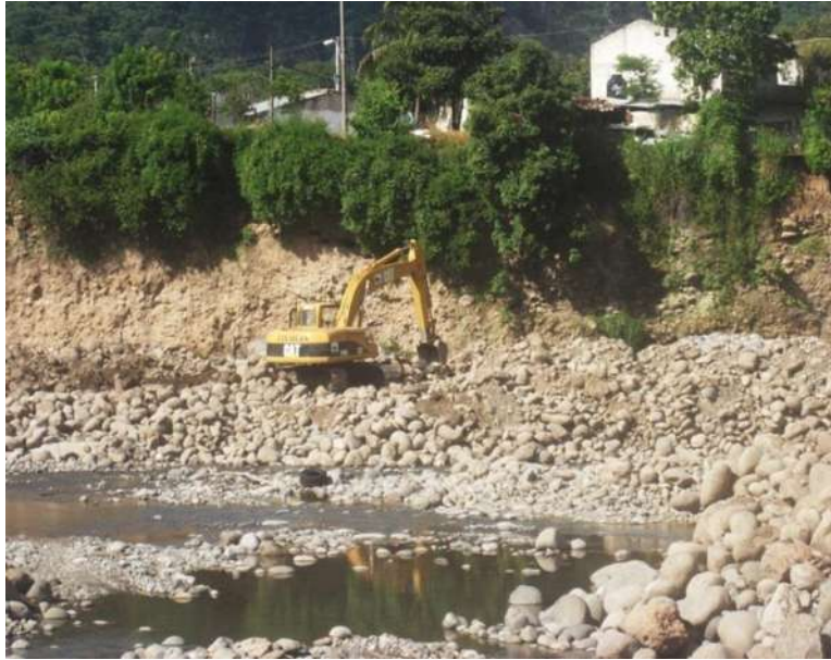
Imagen III.3 Excavadora 320c acomodando material para pedraplén en donde se construirá bordo enrocado en el km 0+000 al 0+302.
