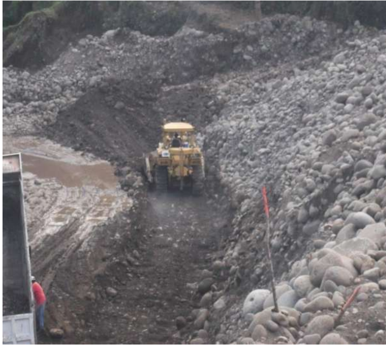
Imagen III.34 Tractor D8R acomodando material en el pedraplén del km 0+000 al km 0+302.
