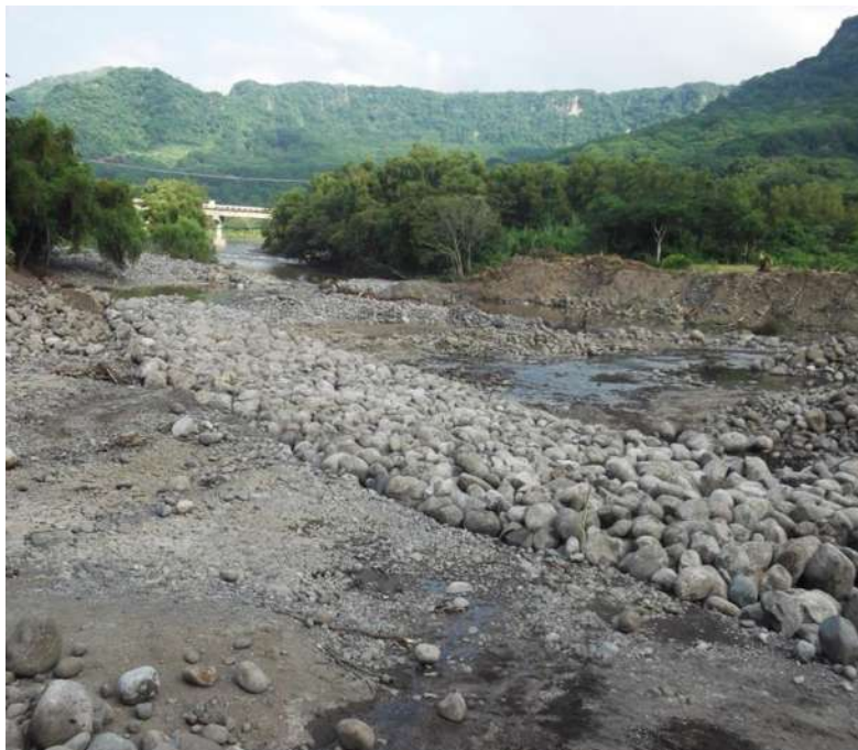
Imagen III.8 Trinchera rellena de piedra de diámetro de 0.4 m a 0.8 m de diámetro en el km 0+000 al km 0+102.
