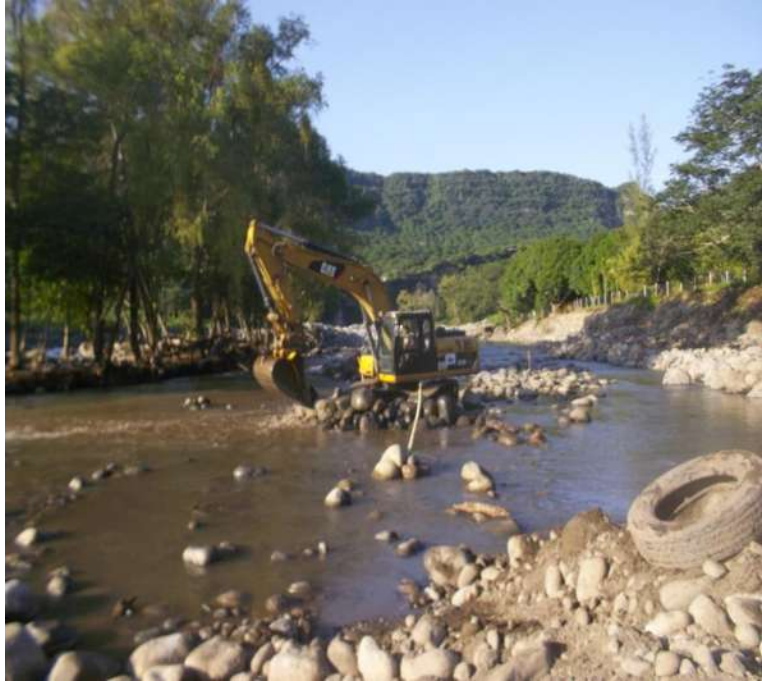
Imagen III.36 Excavadora 320c excavando material para llegar a nivel de desplante del espigón número 2 en el km 0+260 al km 300.
