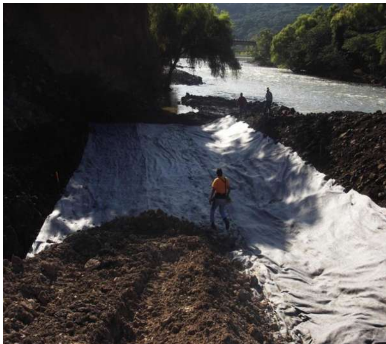
Foto III.10 Obreros colocando geo textil en el desplante del bordo de arcilla en el km 0+102.
