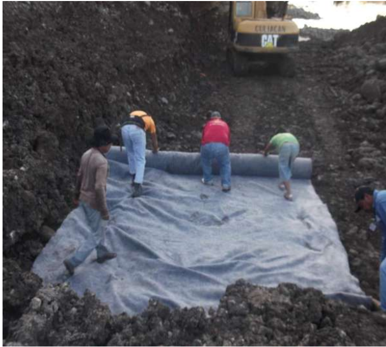
Imagen III.9 Obreros colocando geo textil en el desplante del bordo de arcilla en el km 0+102.
