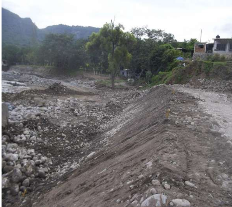
Imagen III.20 Capa de grava-arena (greña) terminada.
