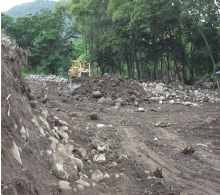
Imagen III.1 Tractor D8-R. Extrayendo material en el encausamiento del km 0+000 al km 0+360.
