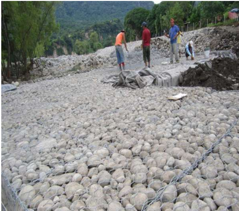
Imagen III.44 Colocación de gaviones.
