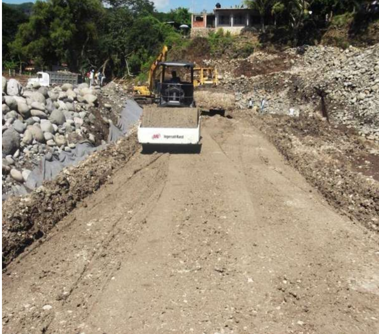
Imagen III.13 Formación de bordo de arcilla.
