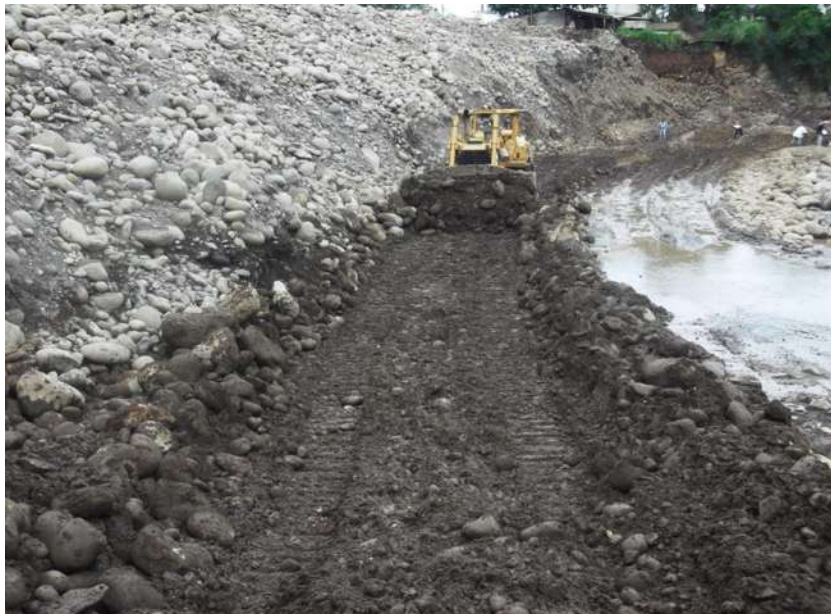
Imagen III.14 tractor D8R Empujando material en donde se formara bordo de arcilla en el km 0+102.
