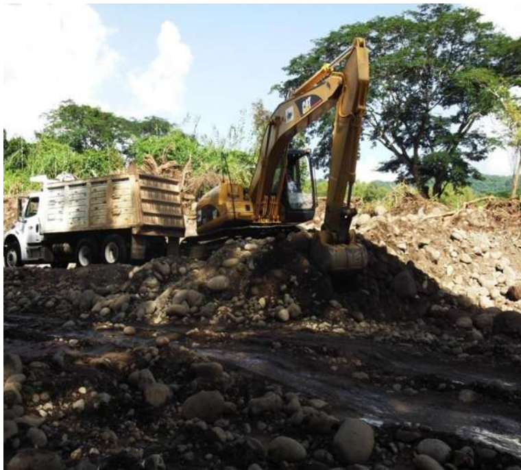
Imagen III.5 Excavadora 320c extrayendo material en el encausamiento del km 0+000 al km 0+380.
