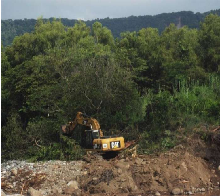
Imagen III.30 excavadora 320c realizando desmonte para fines de construcción en el km 0+000 al km 0+360
