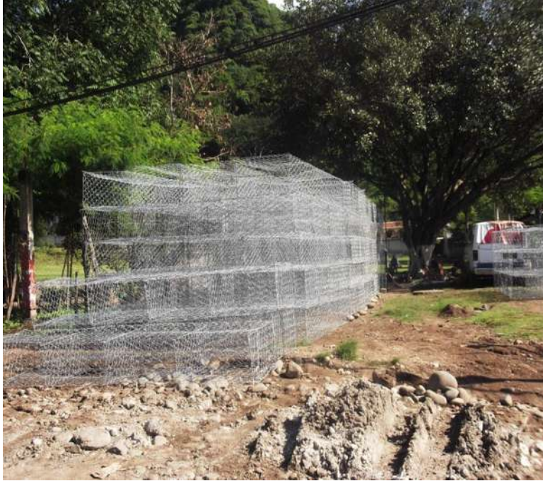
Imagen III.41 Armado de gaviones.
