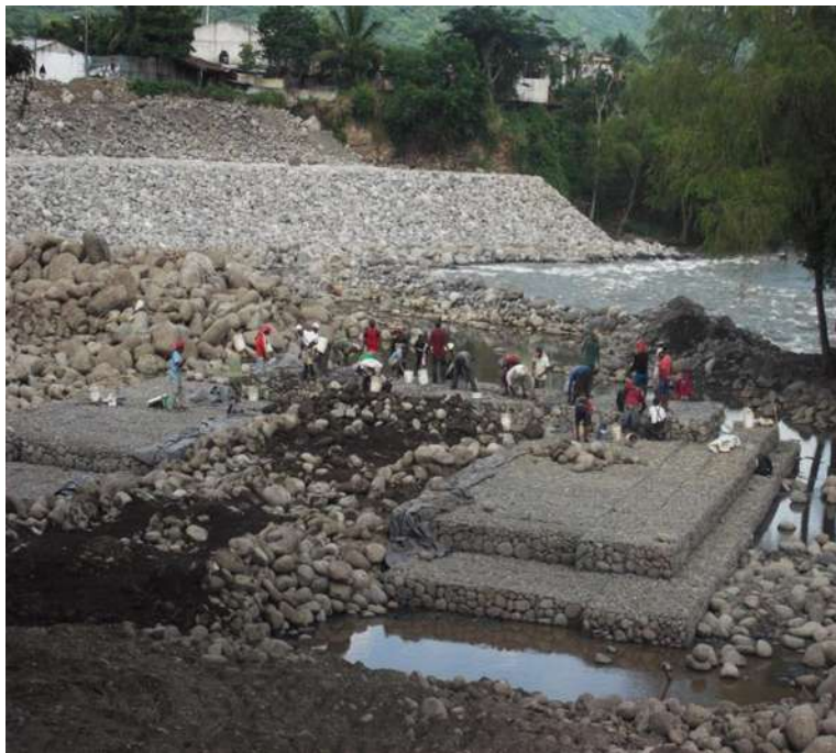
Imagen III.43 Formación del espigón a base de gaviones.
