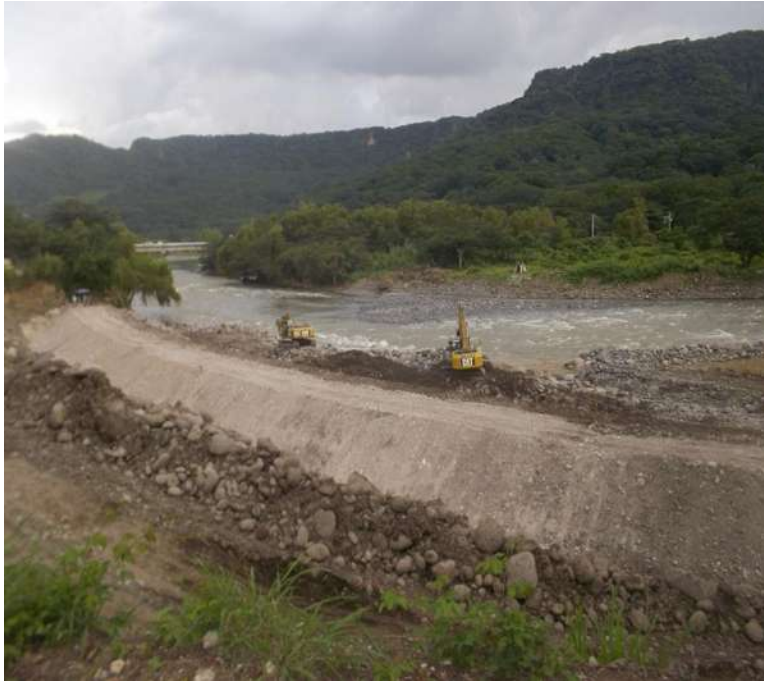
Imagen III.18 Terminado de bordo y listo para colocación de material.
