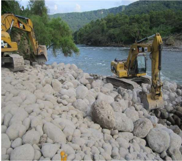
Imagen III.24 Material de roca de 0.80m a 1 m.
