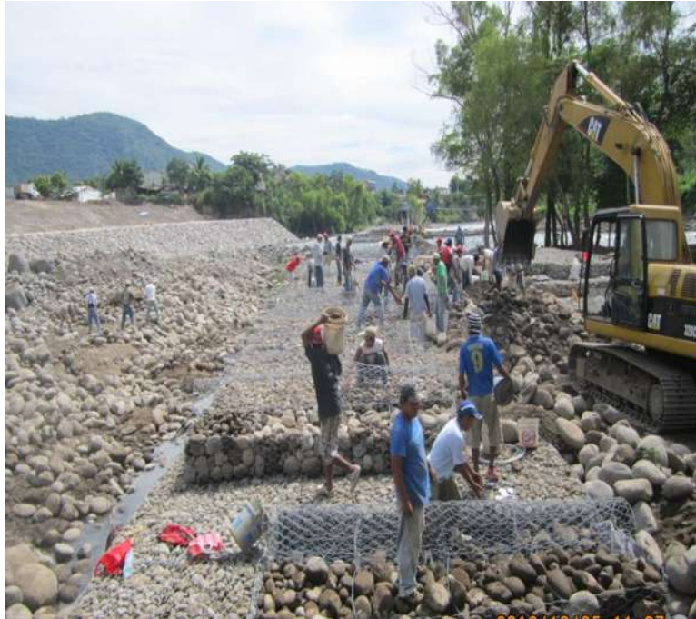
Imagen III.42 Llenado de gaviones con piedra bola de 10 cm a 25 cm.
