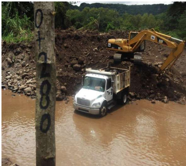
Imagen III.2 Excavadora 320c extrayendo material en el km 0+280 del encausamiento.
