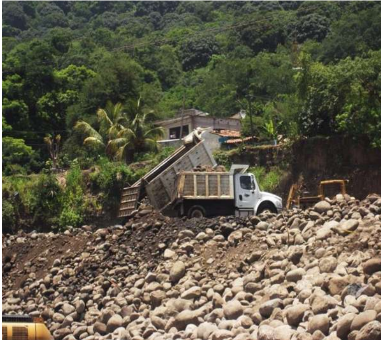
Imagen III.33 Volteo de 7 m 3 acomodando material en el pedraplén del km 0+000 al km 0+302.
