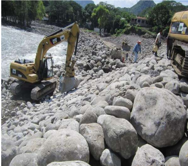
Imagen III.25 Colocación de material de roca.
