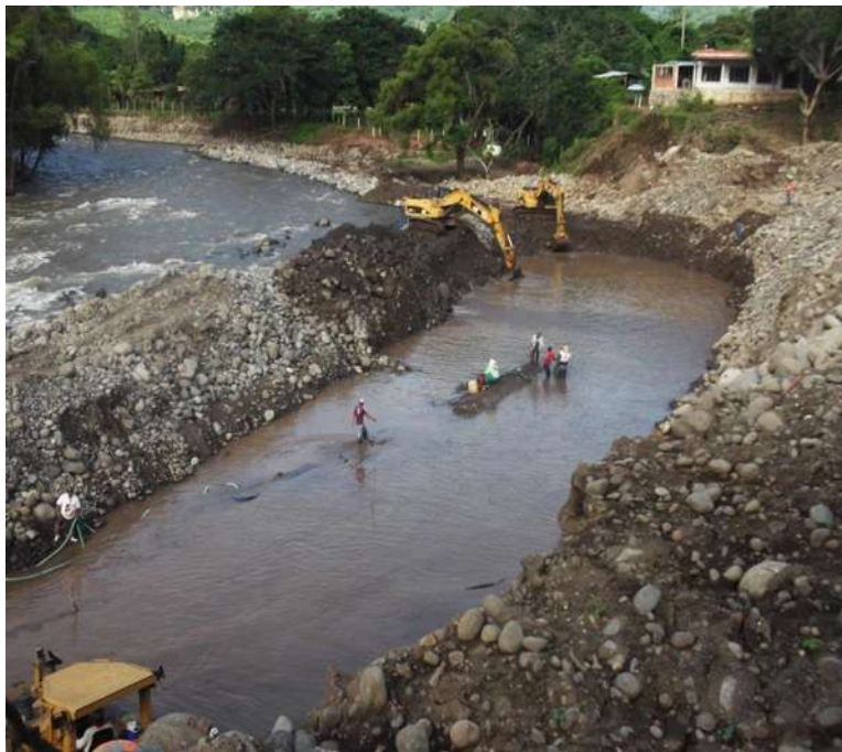
Imagen III.6 Extracción de agua de la zona donde se colocara el geo textil y se formara el bordo de arcilla del km 0+000 al km 0+102.
