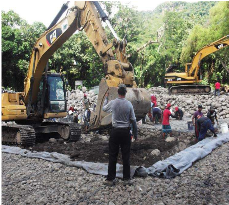
Imagen III.38 Terminación de tendido de geo textil.
