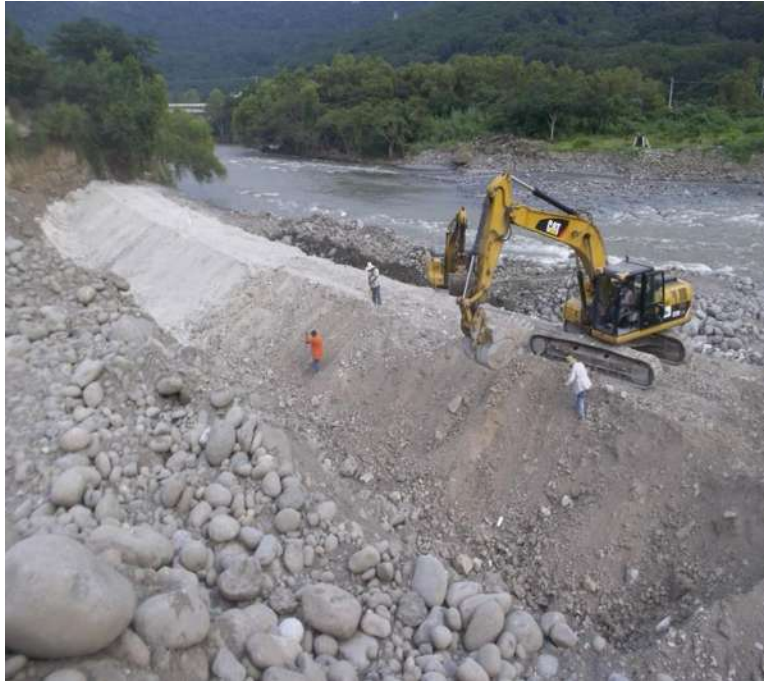
Imagen III.16 preparación de superficies a revestir.
