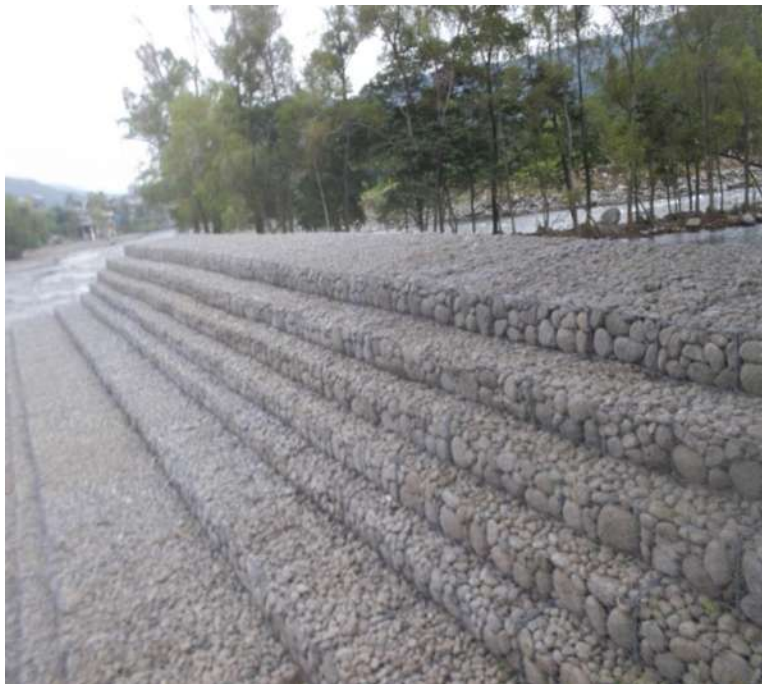
Imagen III.46 Espigón a base de gaviones terminado.
