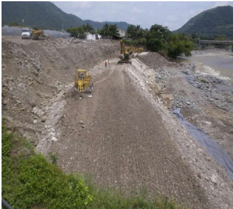
Imagen III.15 Revestimiento de taludes.
