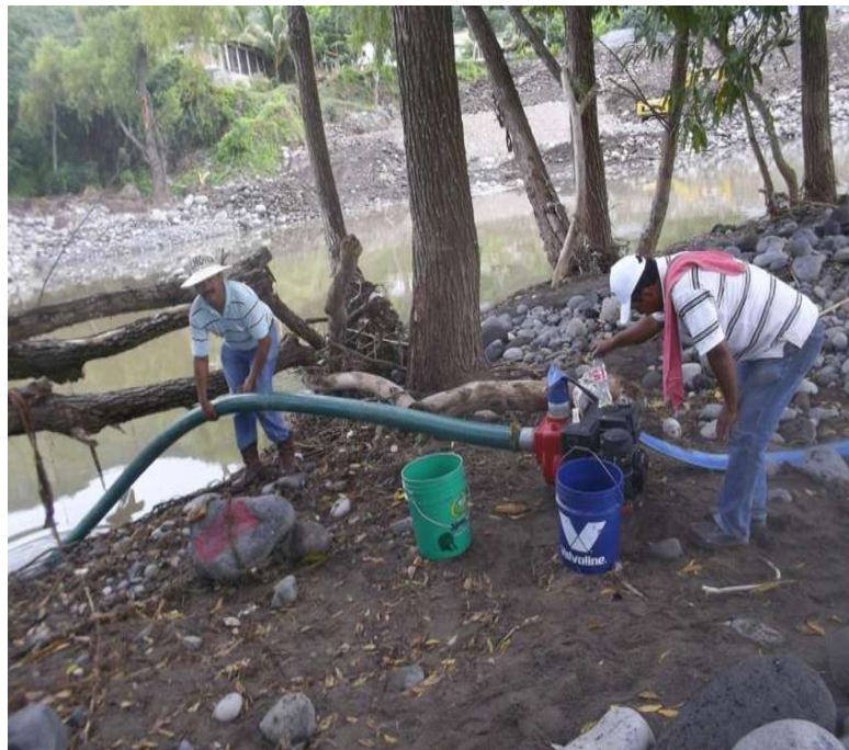
Imagen III.35 Extracción de agua donde se construirá el espigón número 2 en el km 0+270 al km 300
