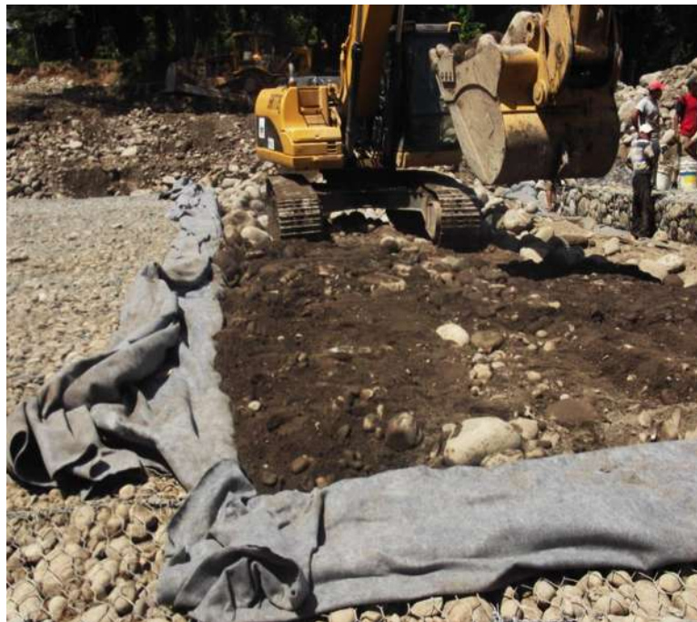
Imagen III.40 Colocación del corazón de los espigones.
