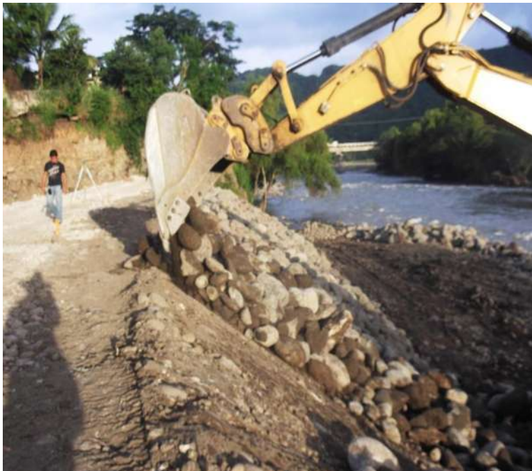
Imagen III.22 Colocación de material en rezaga.
