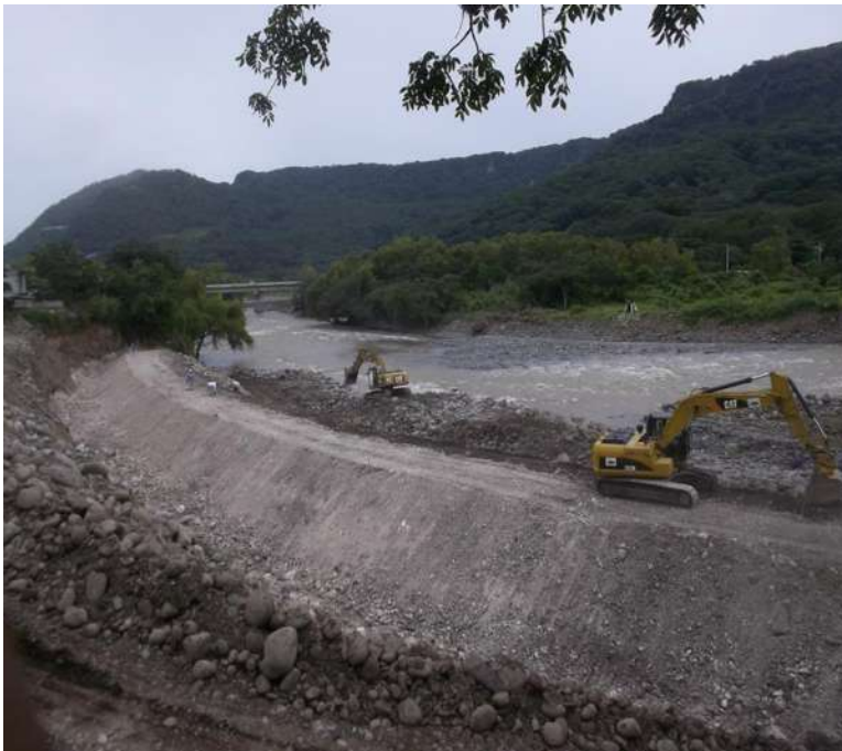
Imagen III.17 vista preliminar de taludes del bordo.
