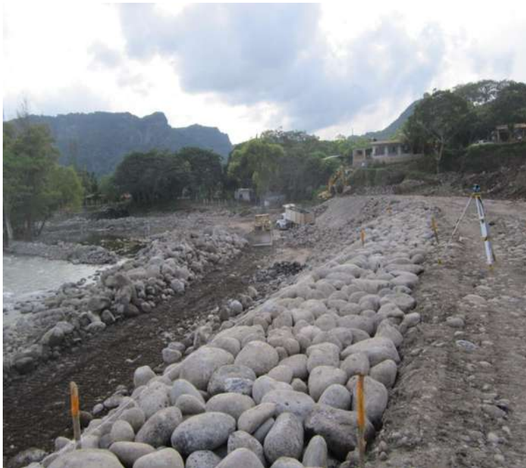
Imagen III.23 Terminado de la Colocación de material en rezaga.
