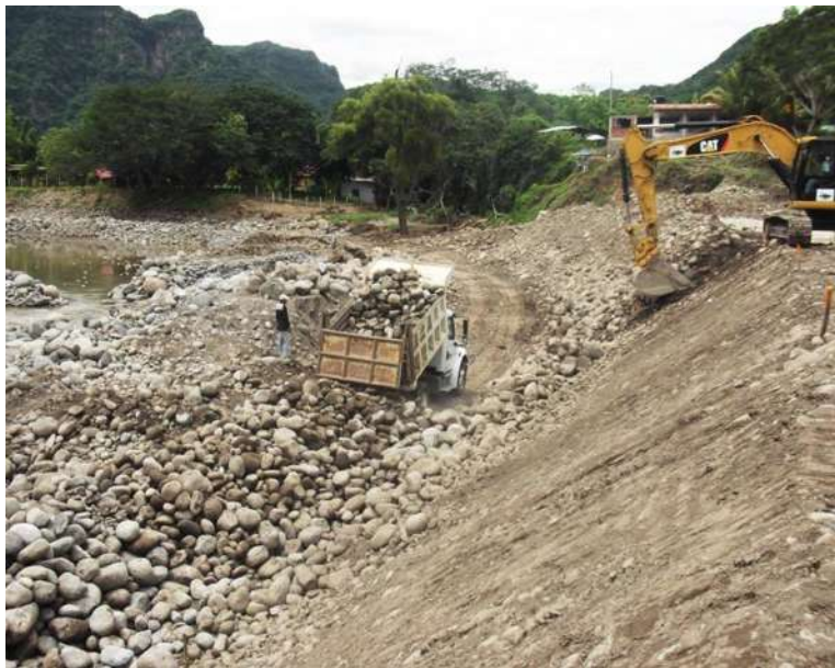
Imagen III.21 Colocación de material en rezaga.
