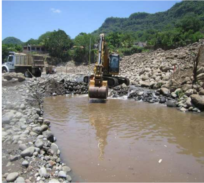
Imagen III.7 Excavadora 320c excavando la trinchera en el km 0+000 al km 0+102
