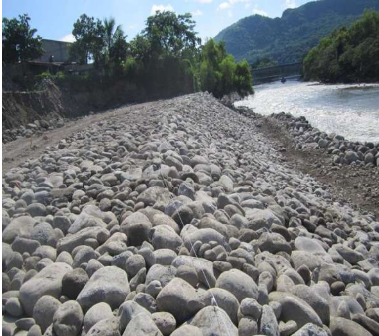
Imagen III.26 Terminado de colocación de material de roca.
