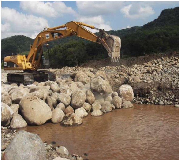
Imagen III.7 Excavadora 320c relleno de trinchera con piedra de 0.4 m a 0.80 m en el km 0+000 al km 0+302
