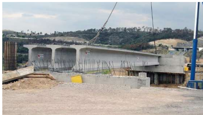
Figura 2.5 - Colocación de traveses prefabricados [MIBOSA S.A. de C.V.]
