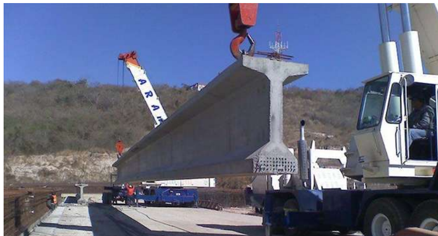
Figura 4.2 - Trabe AASHTO pretensada, patio de fabricación [TENSA PRESFUERZO S.A. de C.V., León Gto.]
