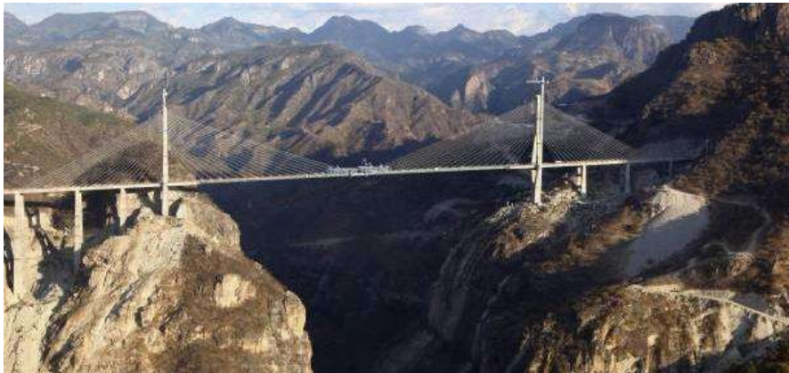
Figura 2.6 - Puente “Baluarte”, entre los Estados de Durango y Sinaloa
