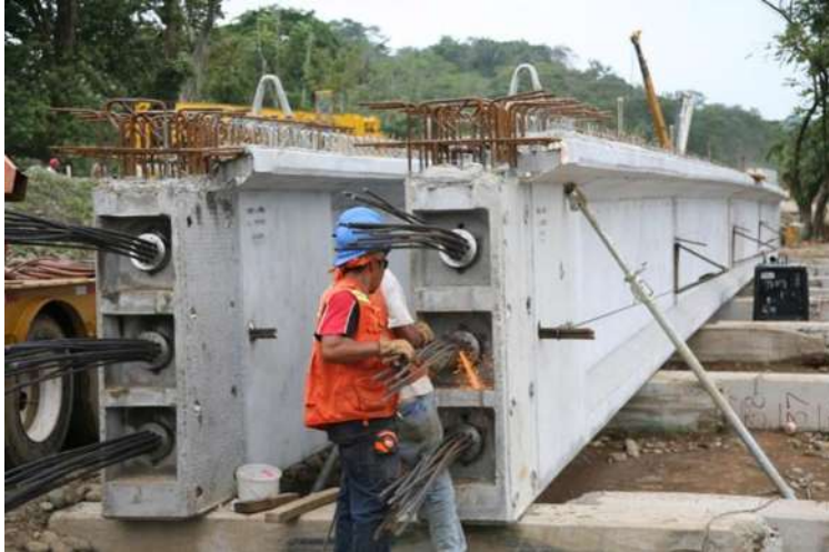
Figura 1.12 - Trabe postensada para el puente La Perla Costanera Sur, Costa Rica
