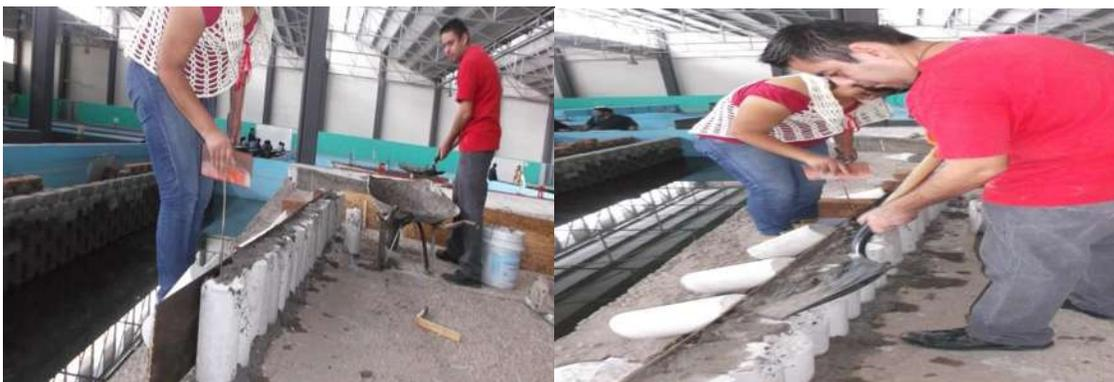
*Imagen 4.8. Colocación de concreto frente a los cilindros.*
