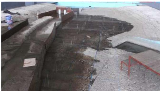
*Imagen 4.11. Infiltración por todas las paredes.*
