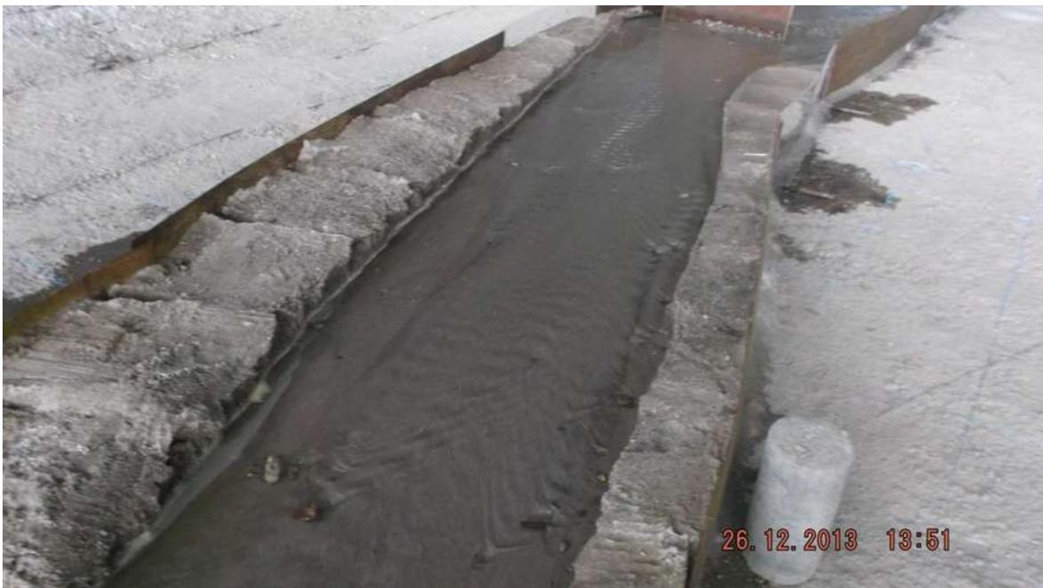
*Imagen 5.18. Deformación de los bordos entre las estaciones 0+560 a 0+300.*
