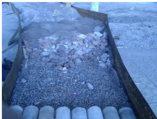
*Imagen. 4.14. Colocación de material de relleno.*
