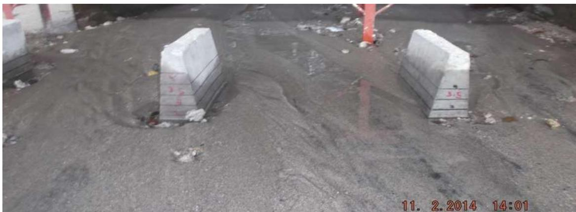
Imagen. 5.31 Vista de frente foso de socavación en las pilas.
