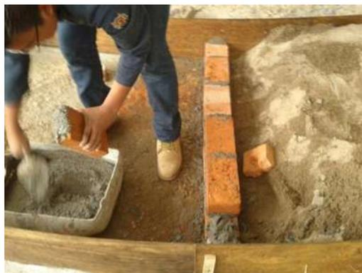
*Imagen 4.15. Colocación de muro*
