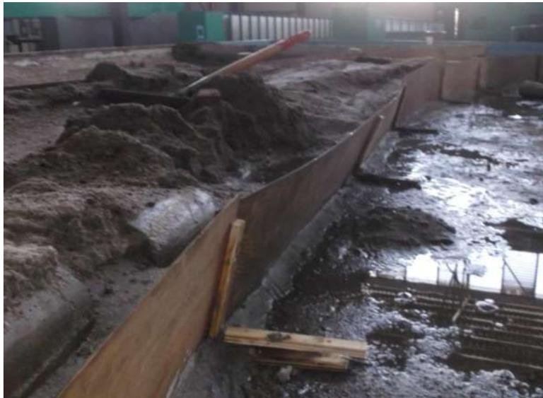
*Imagen 5.10. Muros deformados por la acción del flujo.*
