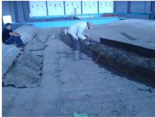
*Imagen 4.12. Ranuración del piso para la colocación de las paredes.*
