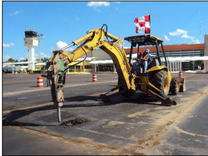
RETROEXCAVADORA CON MARTILLO
