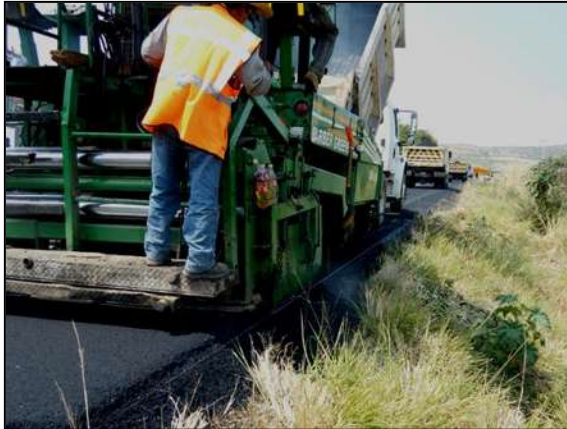
EXTENDEDORA (FINISHER) Y CAMIÓN VOLTEO
