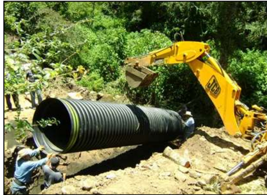
INSTALACIÓN DE TUBERÍA EN OBRA DE DRENAJE
