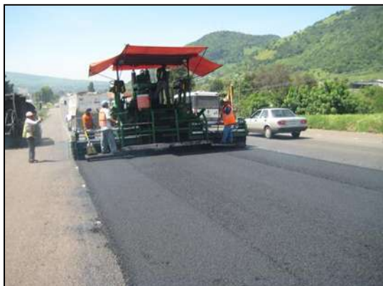
EXTENDEDORA (FINISHER) Y CAMIÓN VOLTEO
