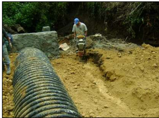
RELLENO EN OBRA DE DRENAJE
