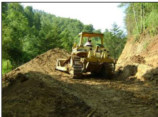
EXCAVACIÓN EN CORTE
