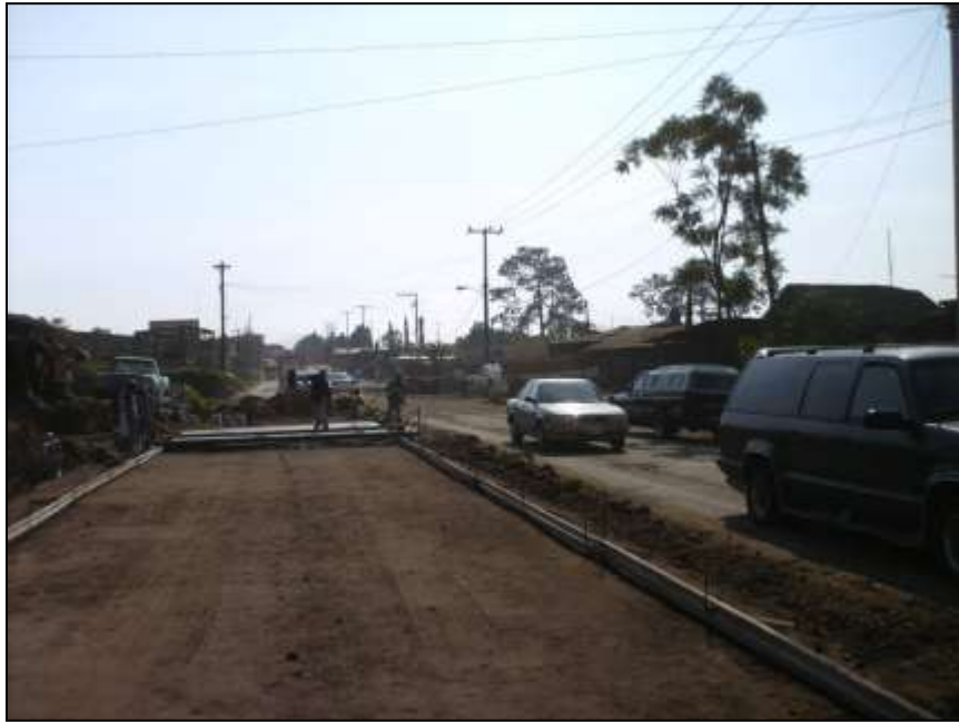
Imagen 1.4.- Colocación de la cimbra sobre la capa de base, para recibir el concreto hidráulico.
