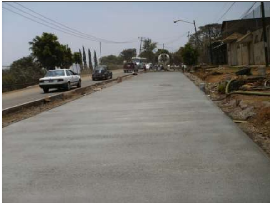
Imagen 1.5.- Tendido del concreto hidráulico.
