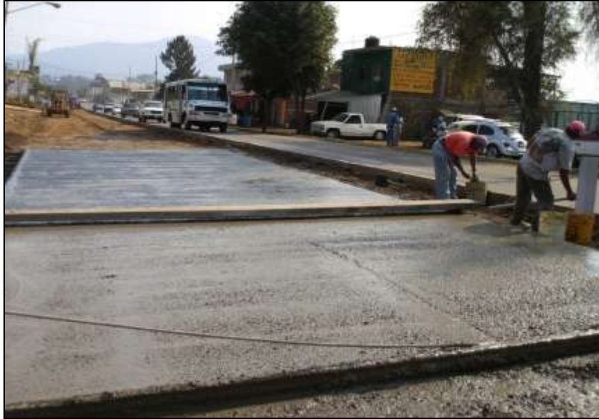
Imagen 4.3.- Construcción de losas de concreto hidráulico.
