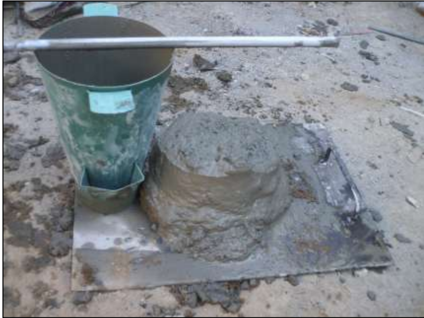
Imagen 3.15.- Realización ensaye de revenimiento en obra.
