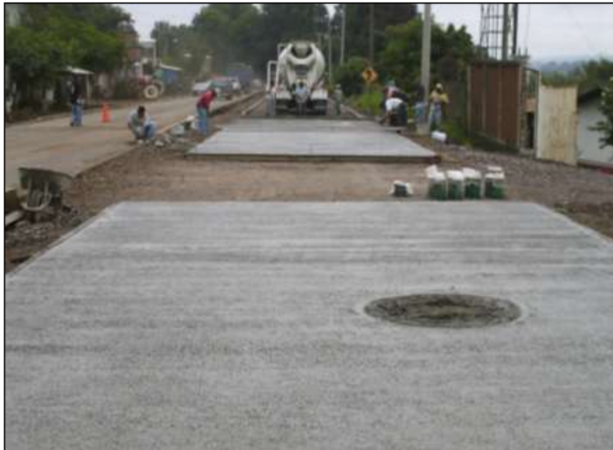
Imagen 3.16.- Cilindros y vigas de concreto hidráulico fresco, realizados en obra.
