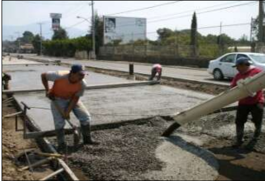
Imagen 3.13.- Extendido de concreto hidráulico en obra.
