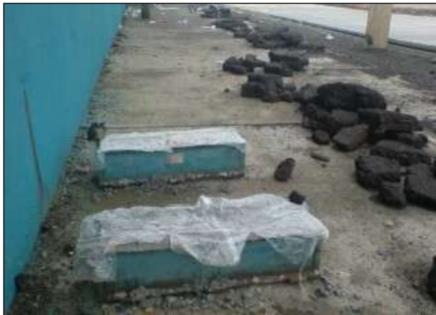
Imagen 4.4.- Vigas de concreto hidráulico realizadas en obra.
