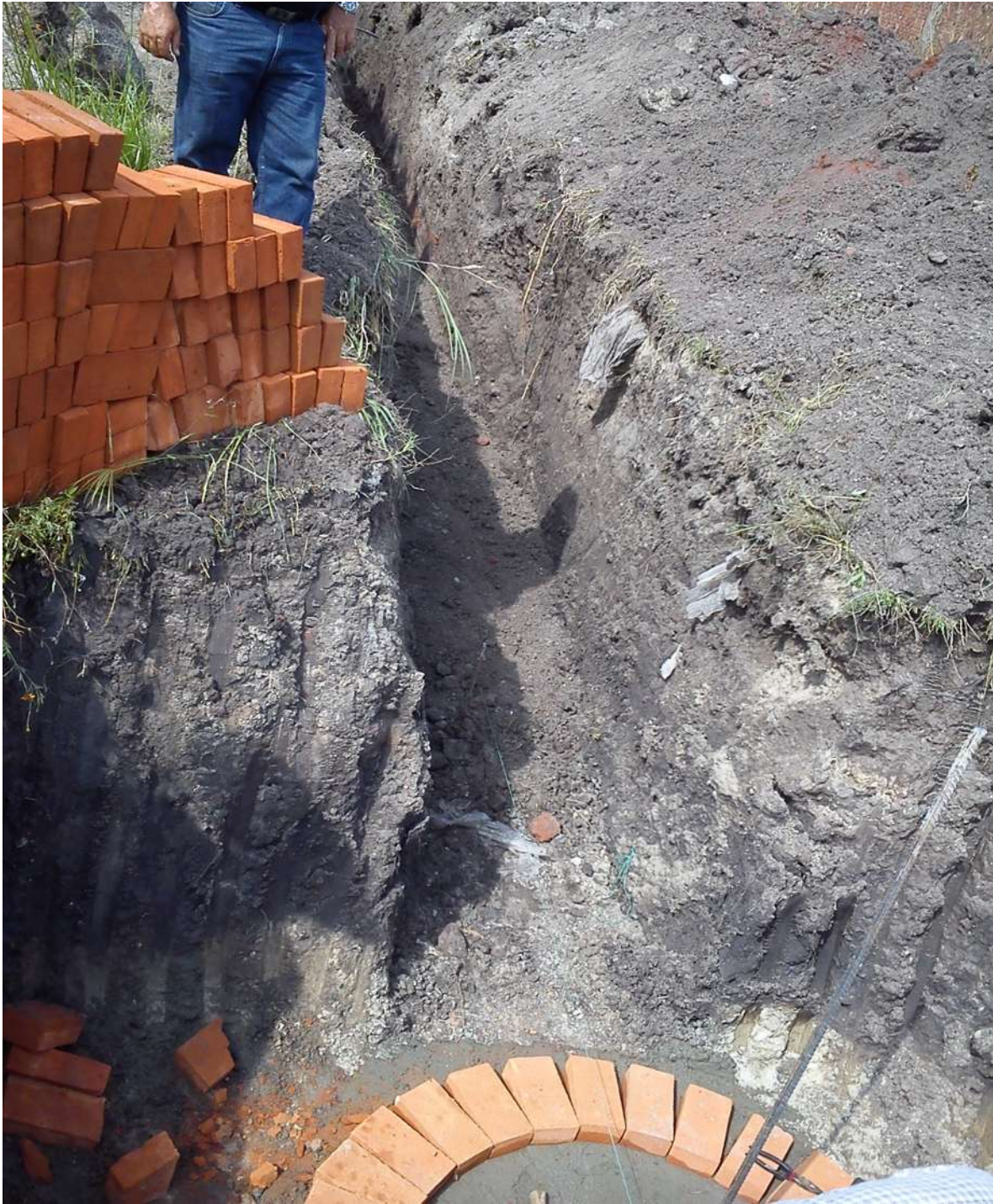
Excavación, trazo y nivelación de la línea de drenaje principal y pozo de visita.
