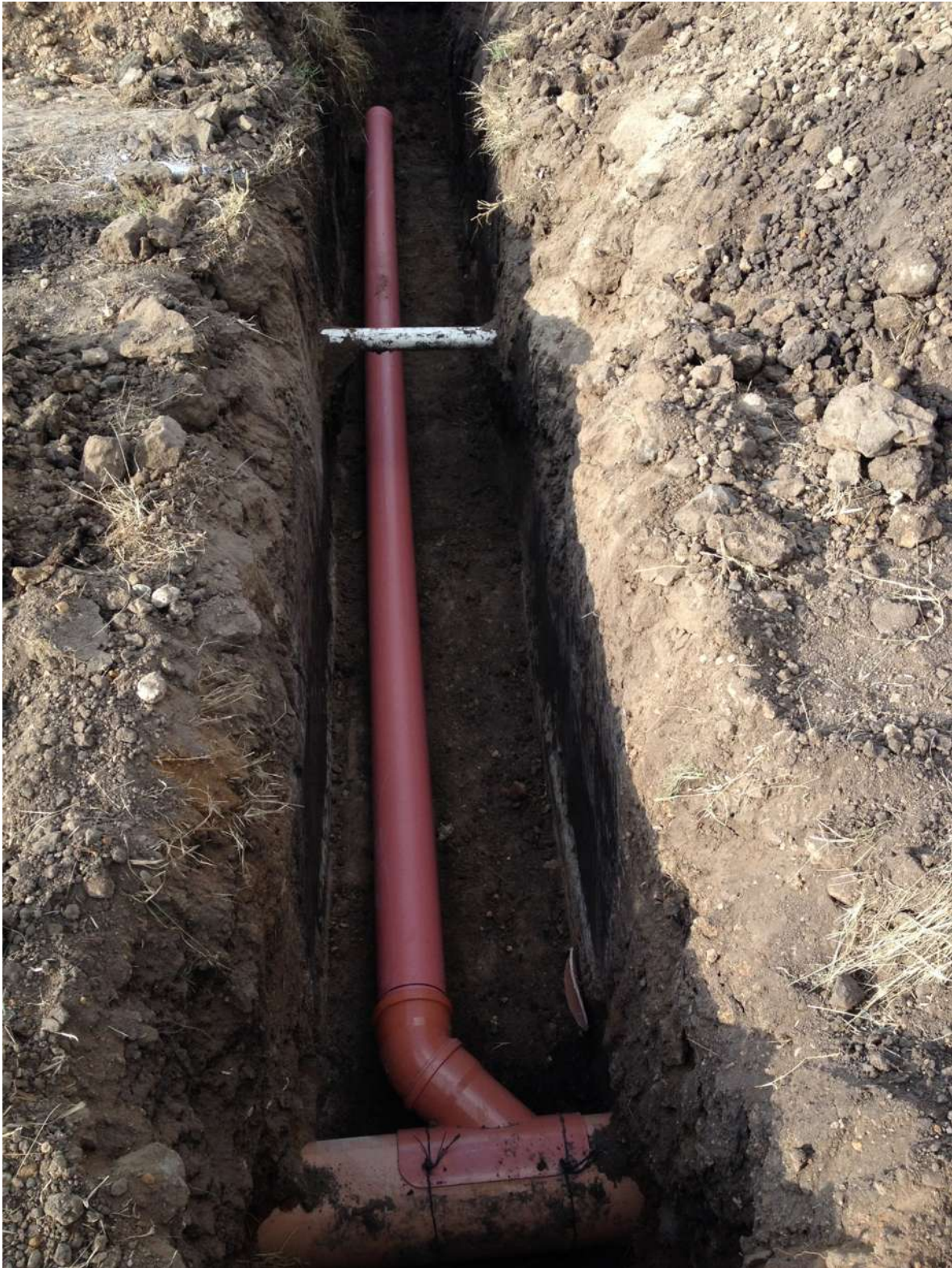
Colocación de la tubería de la descarga domiciliaria del drenaje sanitario.
