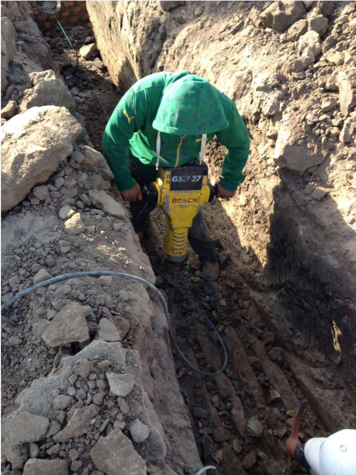
Ruptura de roca encontrada en la excavación de la tubería y evitar algún daño a la misma.
