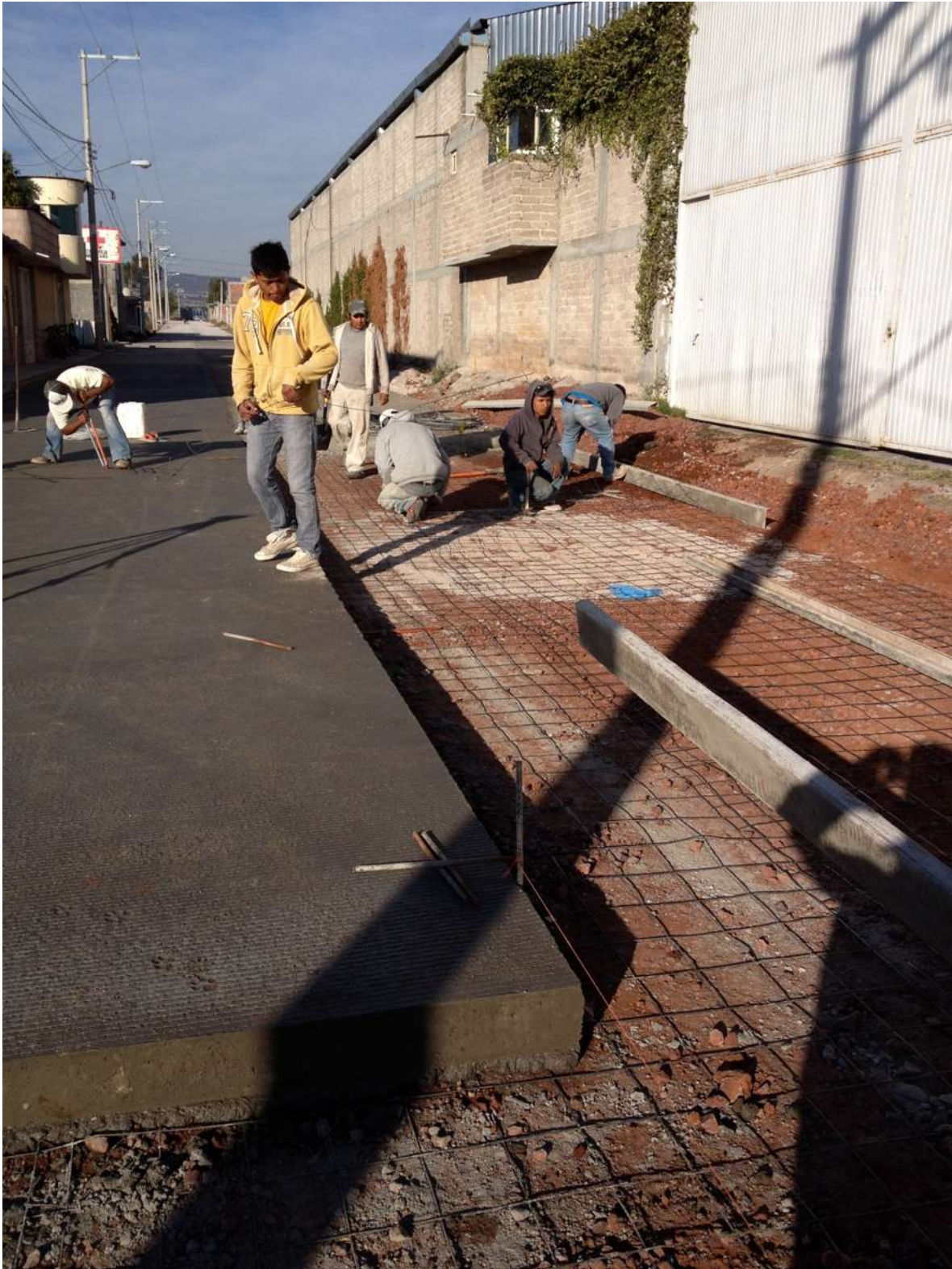
Cimbrado, colocación de malla y colado del concreto hidráulico.
