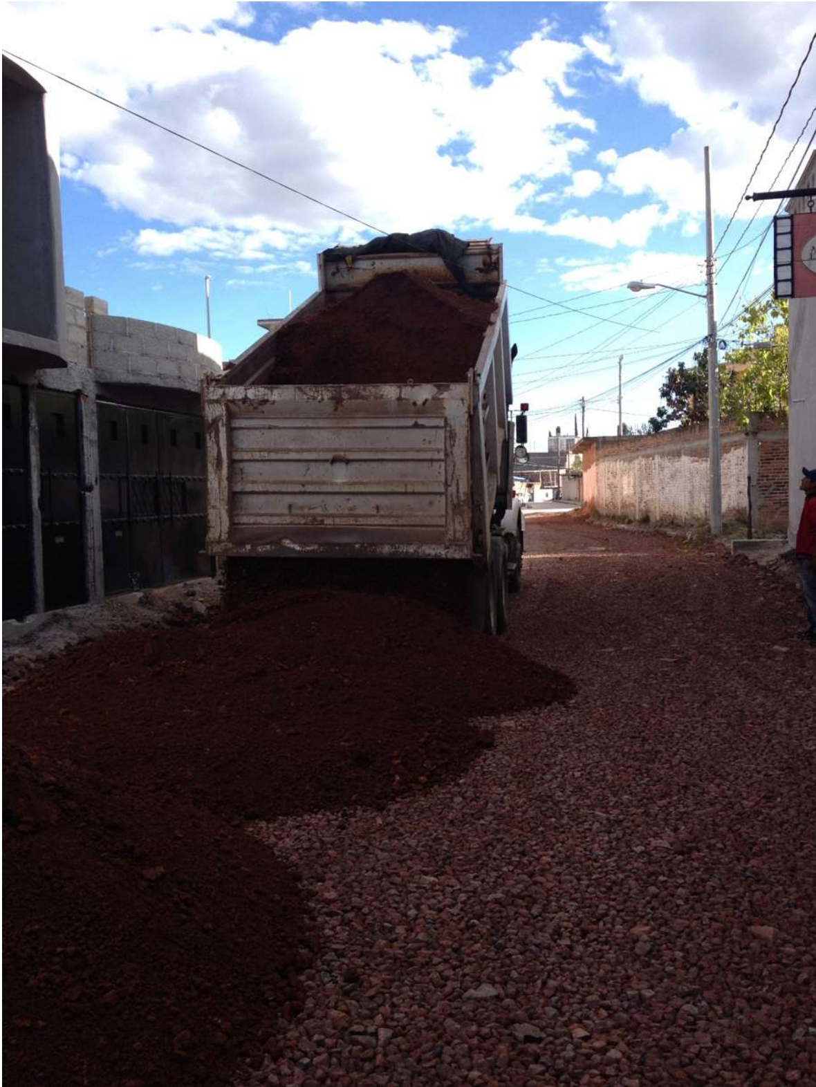
Acarreo del material tipo base al sitio.
