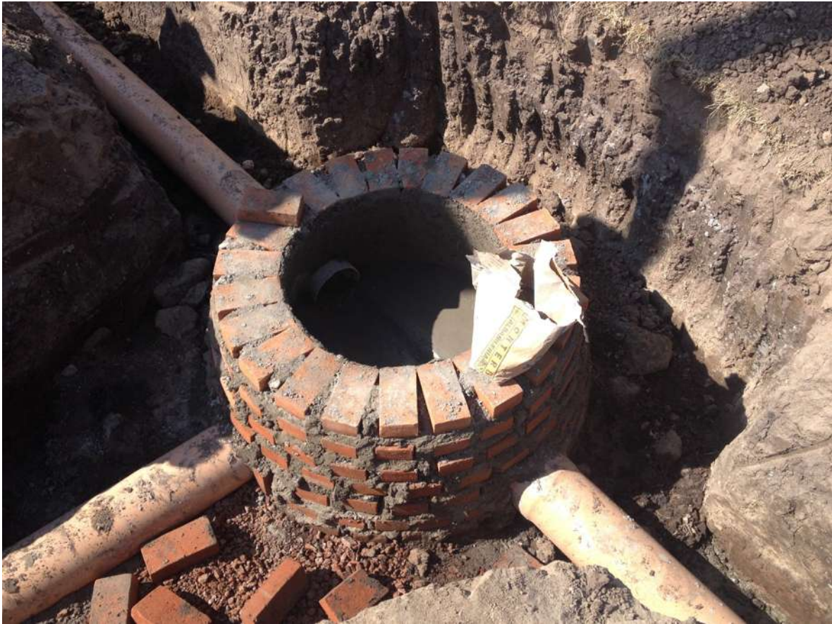
Construcción de los pozos de visita incluyendo la descarga de las bocacalles.
