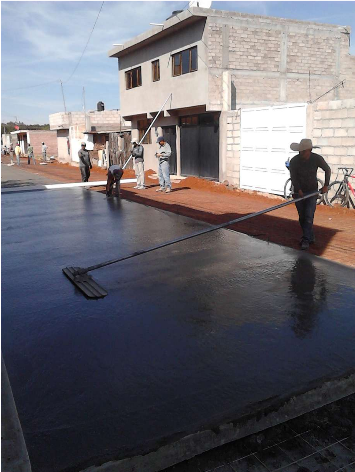
Detallado del concreto hidráulico con fraguado inicial al término de la jornada.
