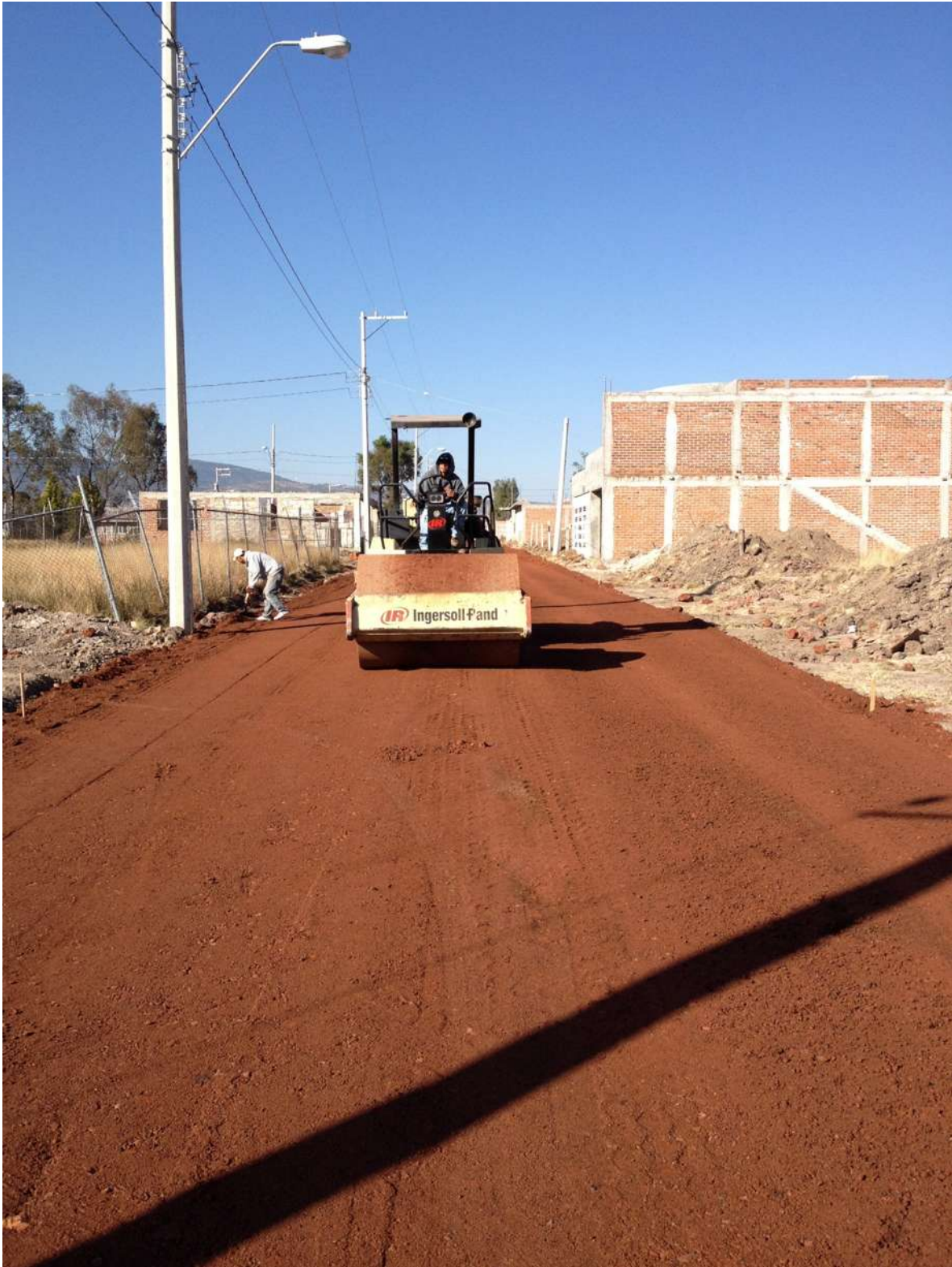
Acomodo de la capa de base con vibrocompactador.
