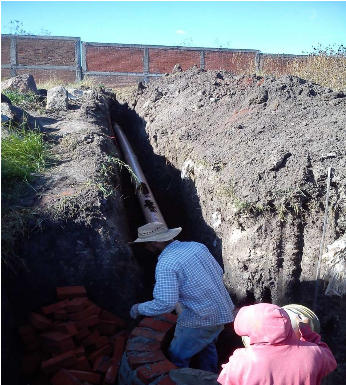
Colocación de la tubería del drenaje principal y construcción del pozo de visita.
