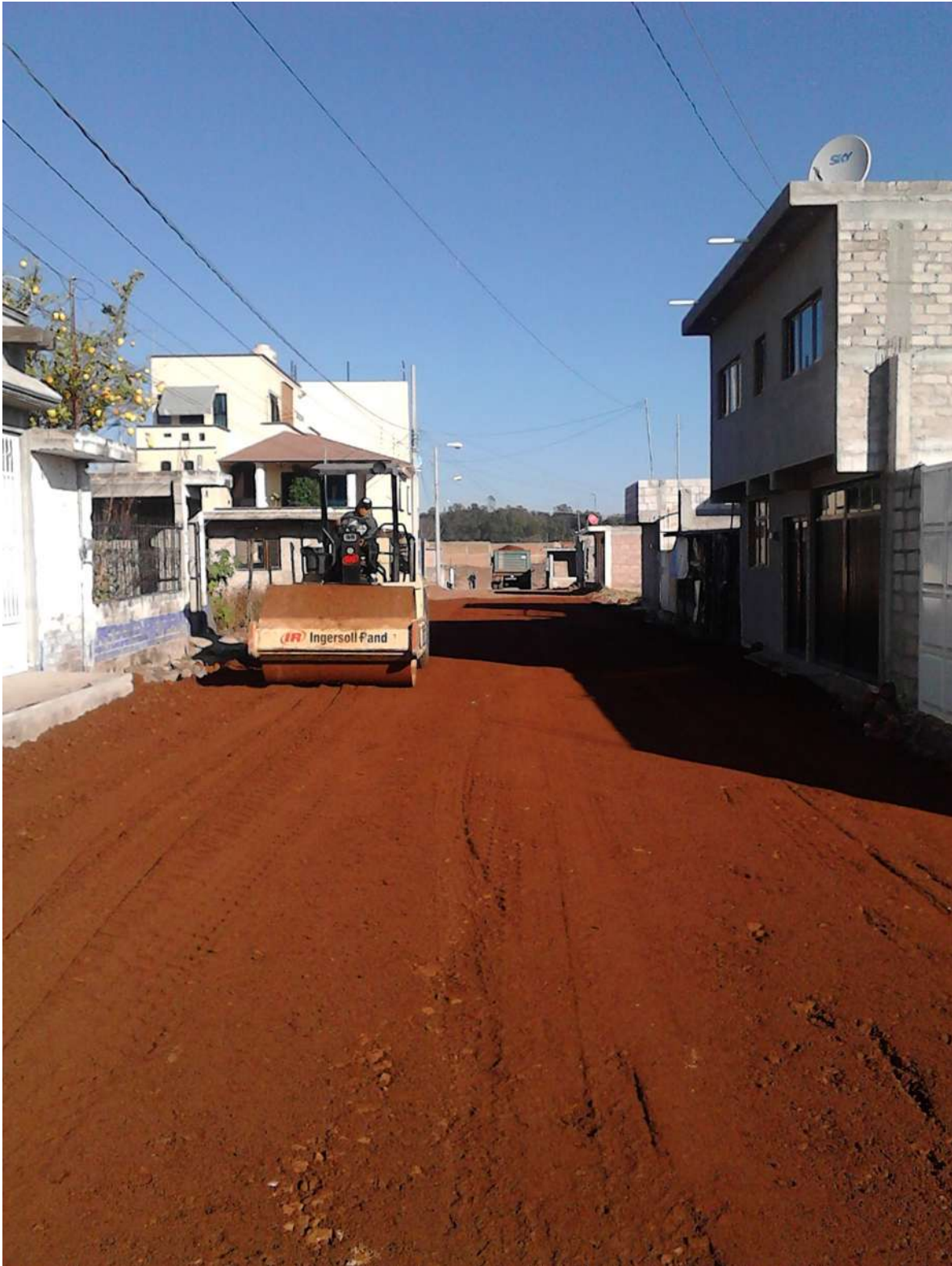
Armado de la capa de material tipo base, previo a checar niveles de piso terminado.
