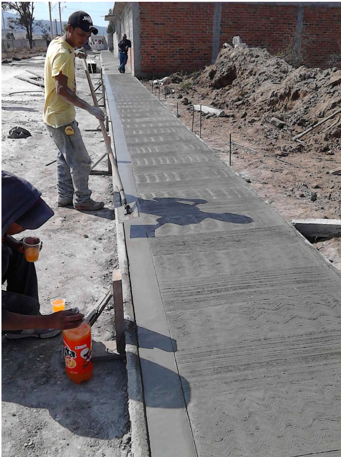
Colado y tratado de las banquetas y guarniciones.
