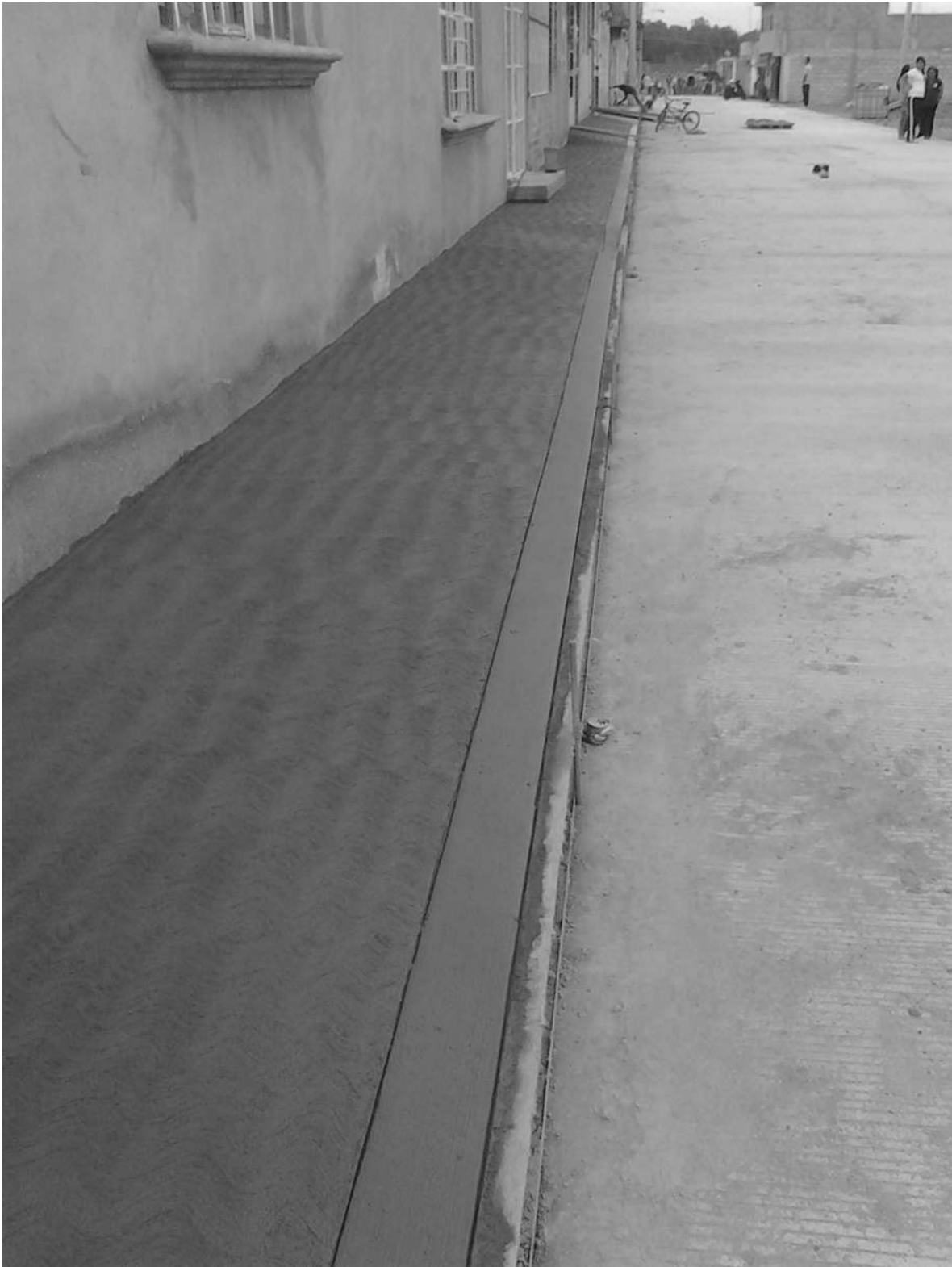
Cimbrado, colado y detallado de las banquetas y guarniciones.
