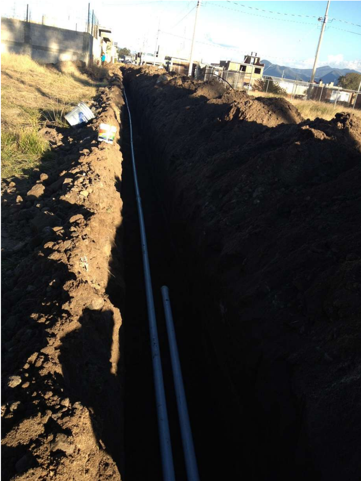
Encamado y colocación de la tubería de la red de agua potable.
