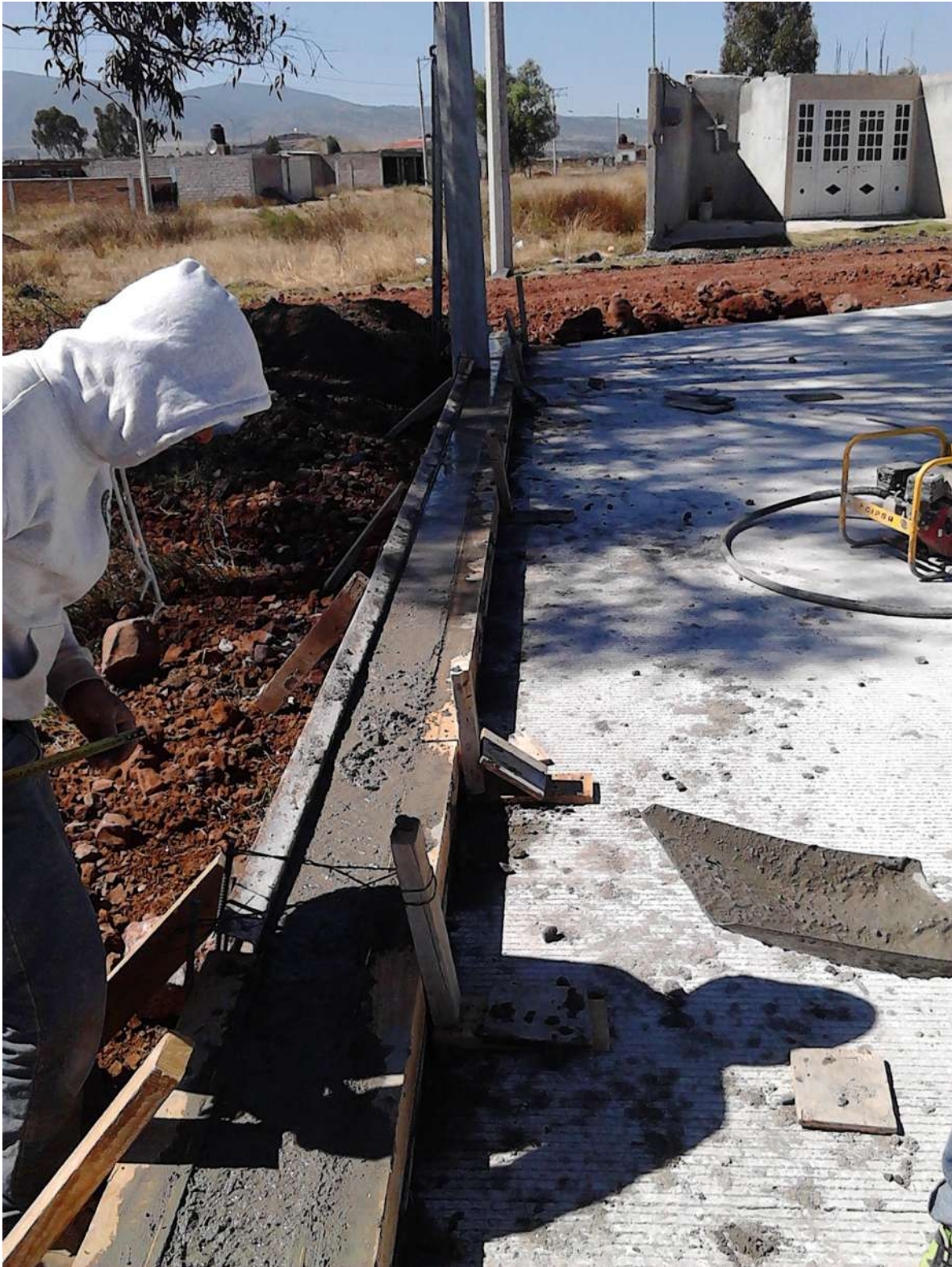
Colado de las guarniciones.
