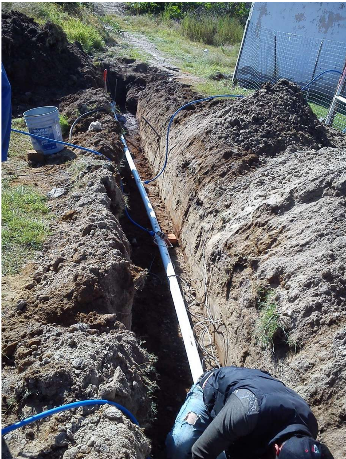
Excavación, instalación de la línea del agua potable e instalación de las tomas domiciliarias.
