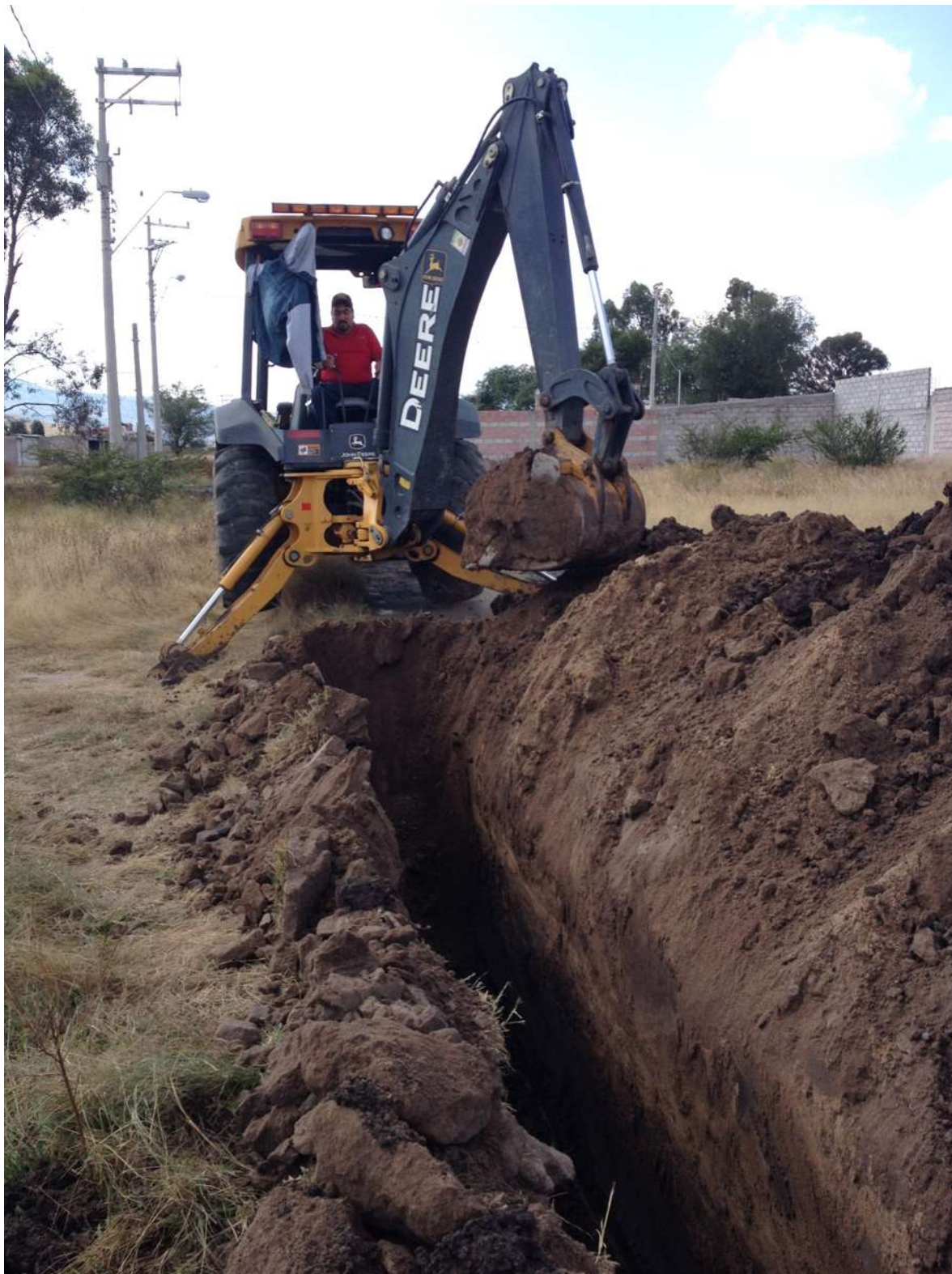
Excavación para introducir la tubería del drenaje sanitario.
