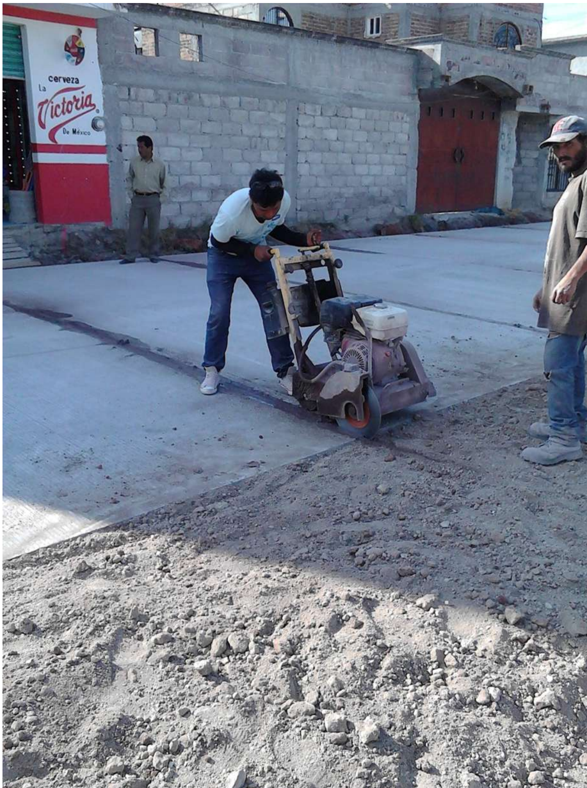
Corte de las piedras de concreto para evitar agrietamiento.
