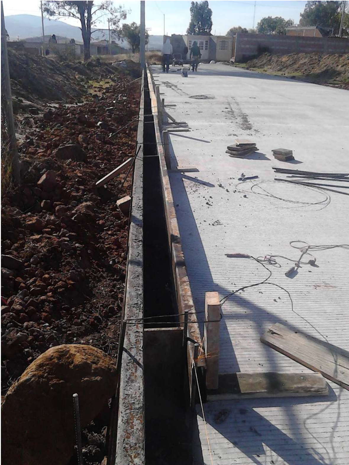
Cimbrado de guarniciones.
