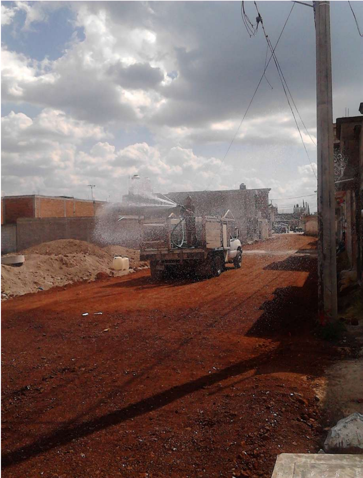
Riego de la base para proporcionar la humedad requerida para obtener el grado de compactación deseado.
