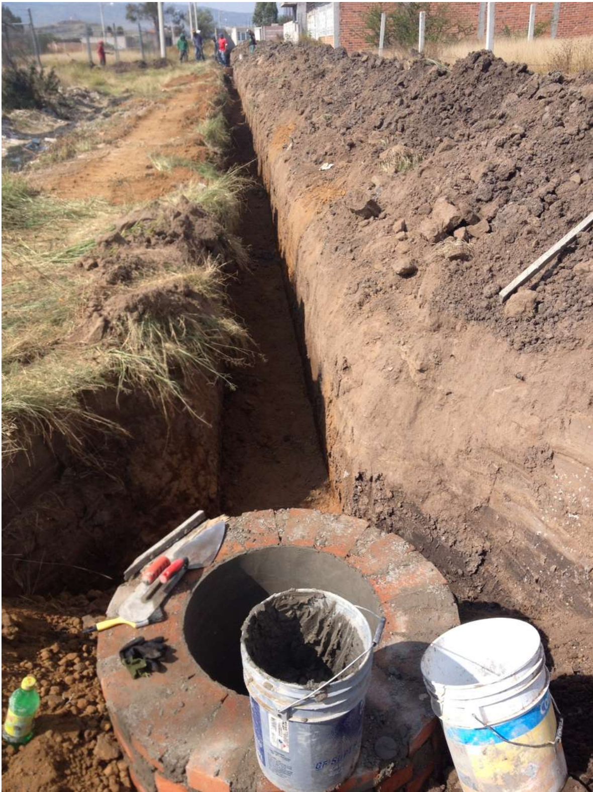
Encamado y encostillado del drenaje principal del drenaje sanitario.
