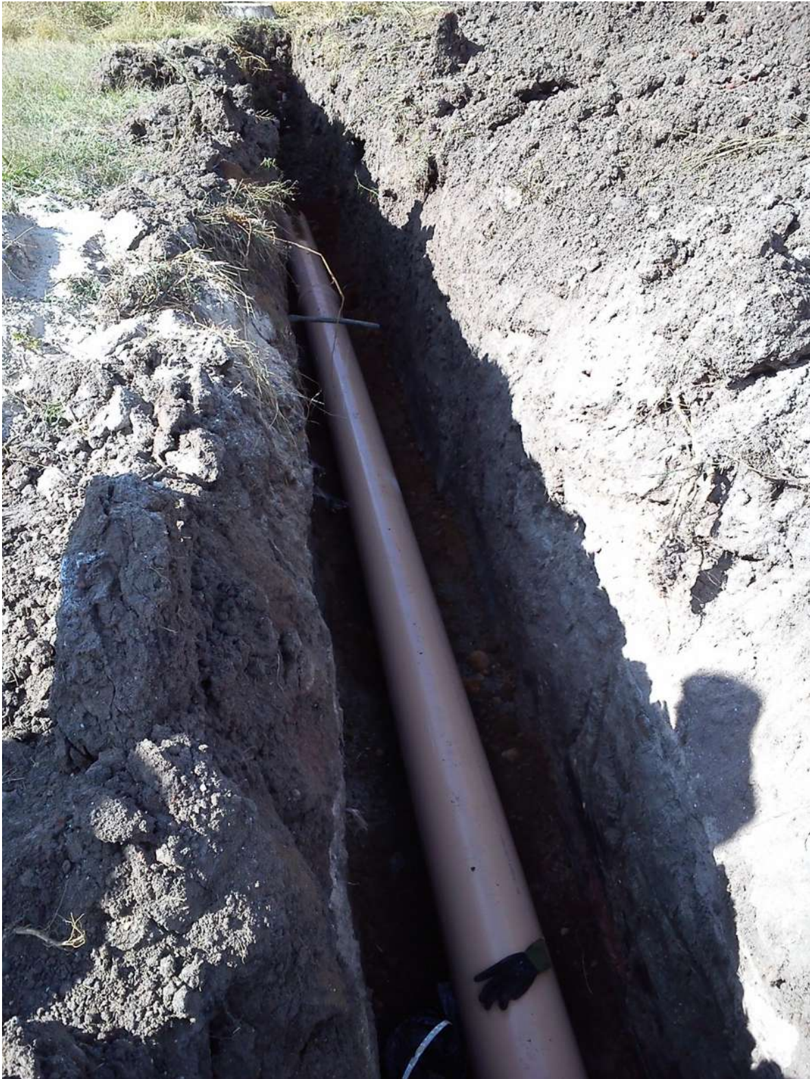
Instalación de las descargas domiciliarias de drenaje.
