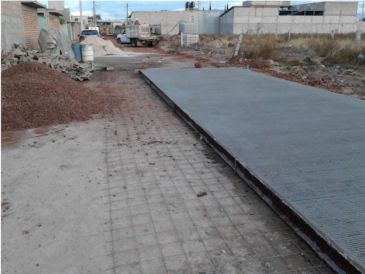
Concreto hidráulico con un fraguado inicial.
