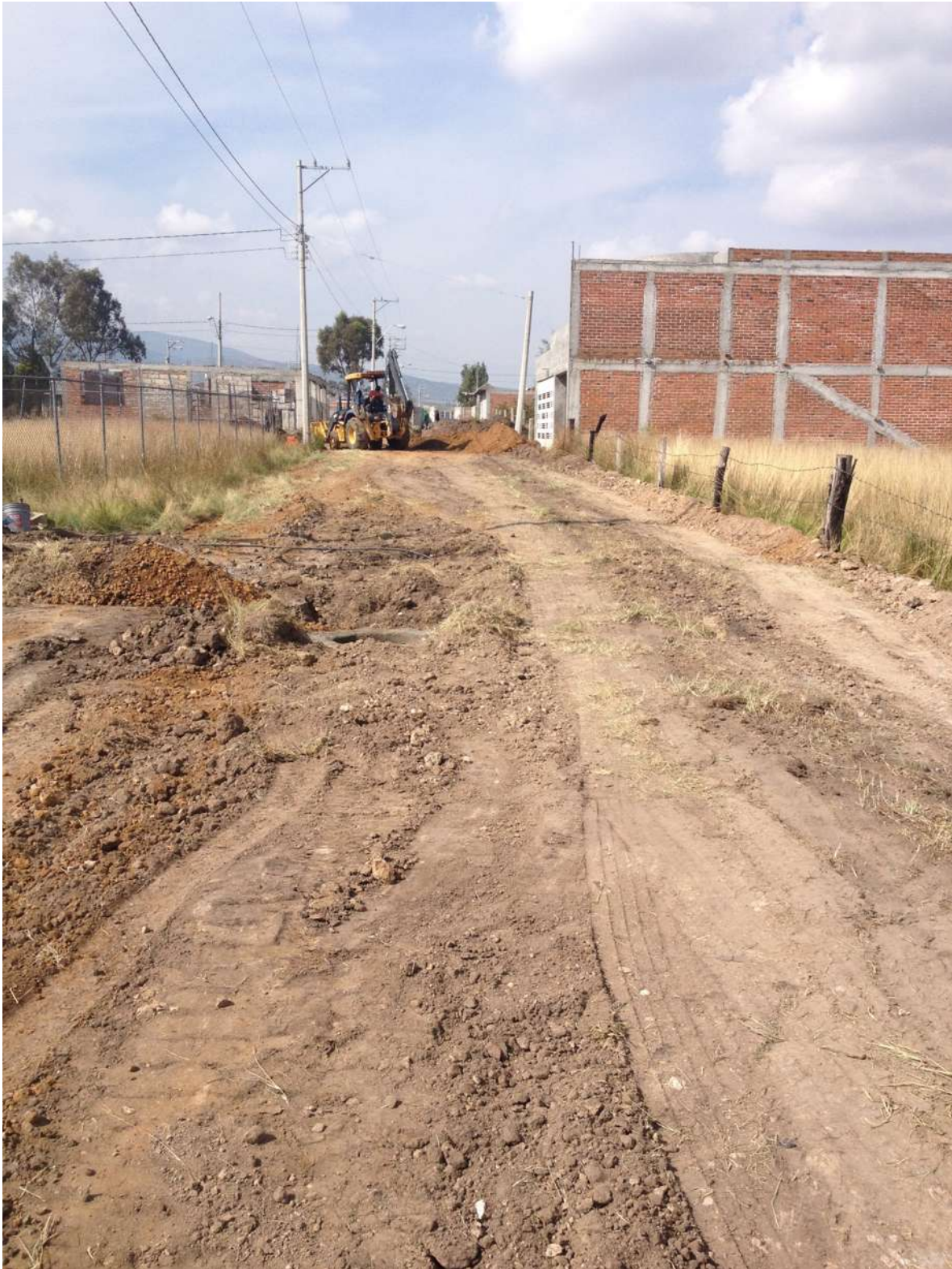
Relleno de excavación del drenaje sanitario.
