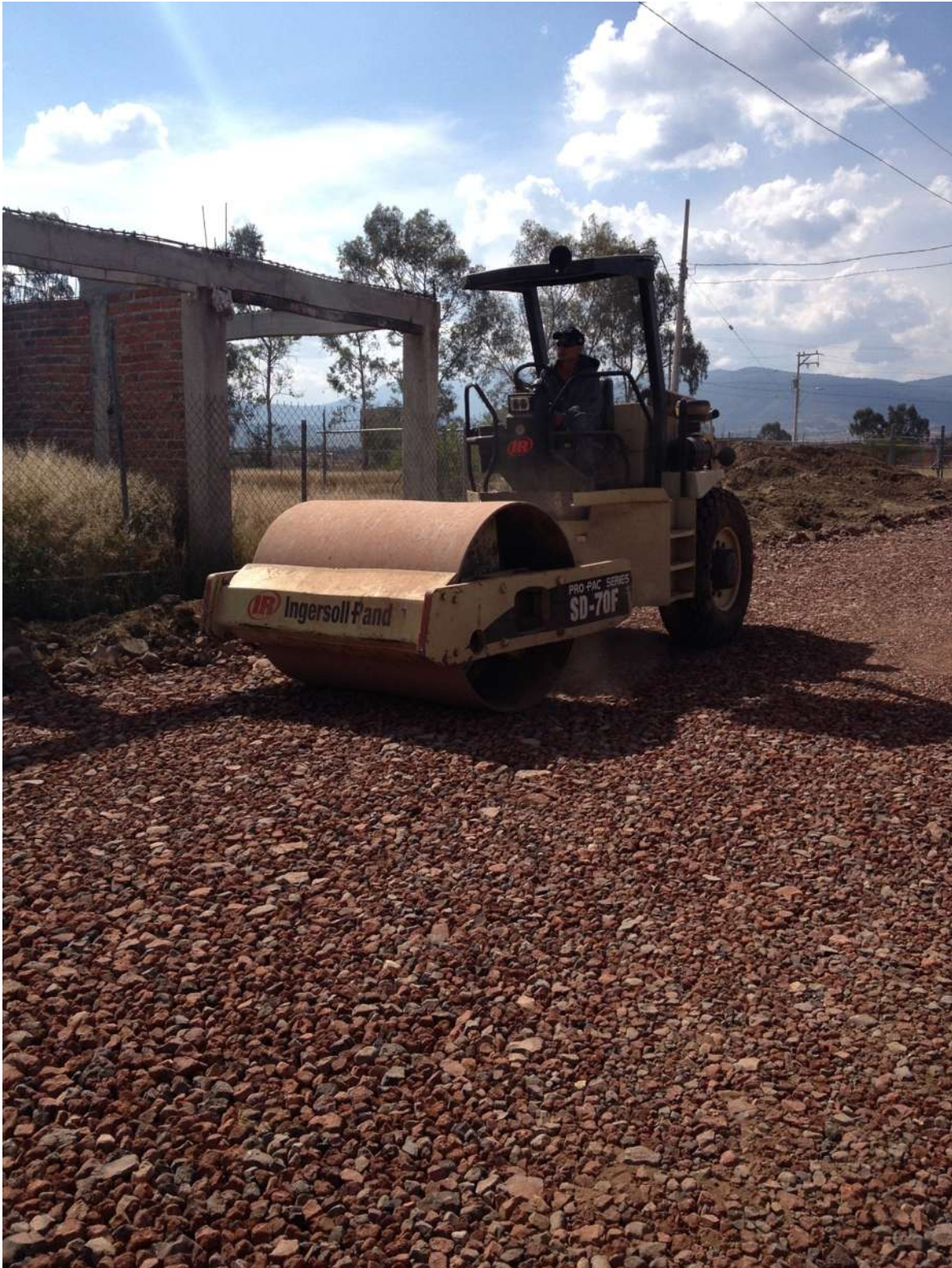
Acomodo de la capa de filtro con vibrocompactador.
