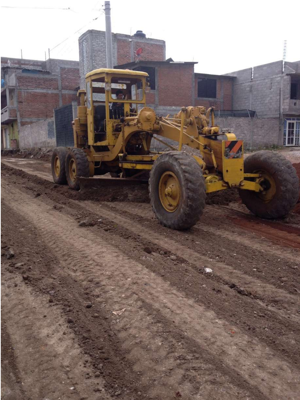
Limpieza y preparación del terreno para el acarreo del filtro.
