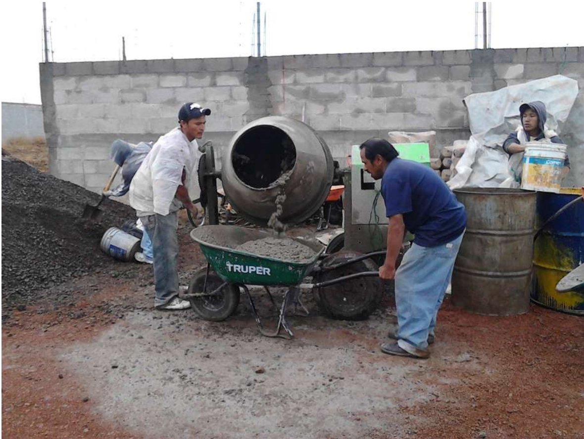
Fabricación del concreto hidráulico en sitio.
