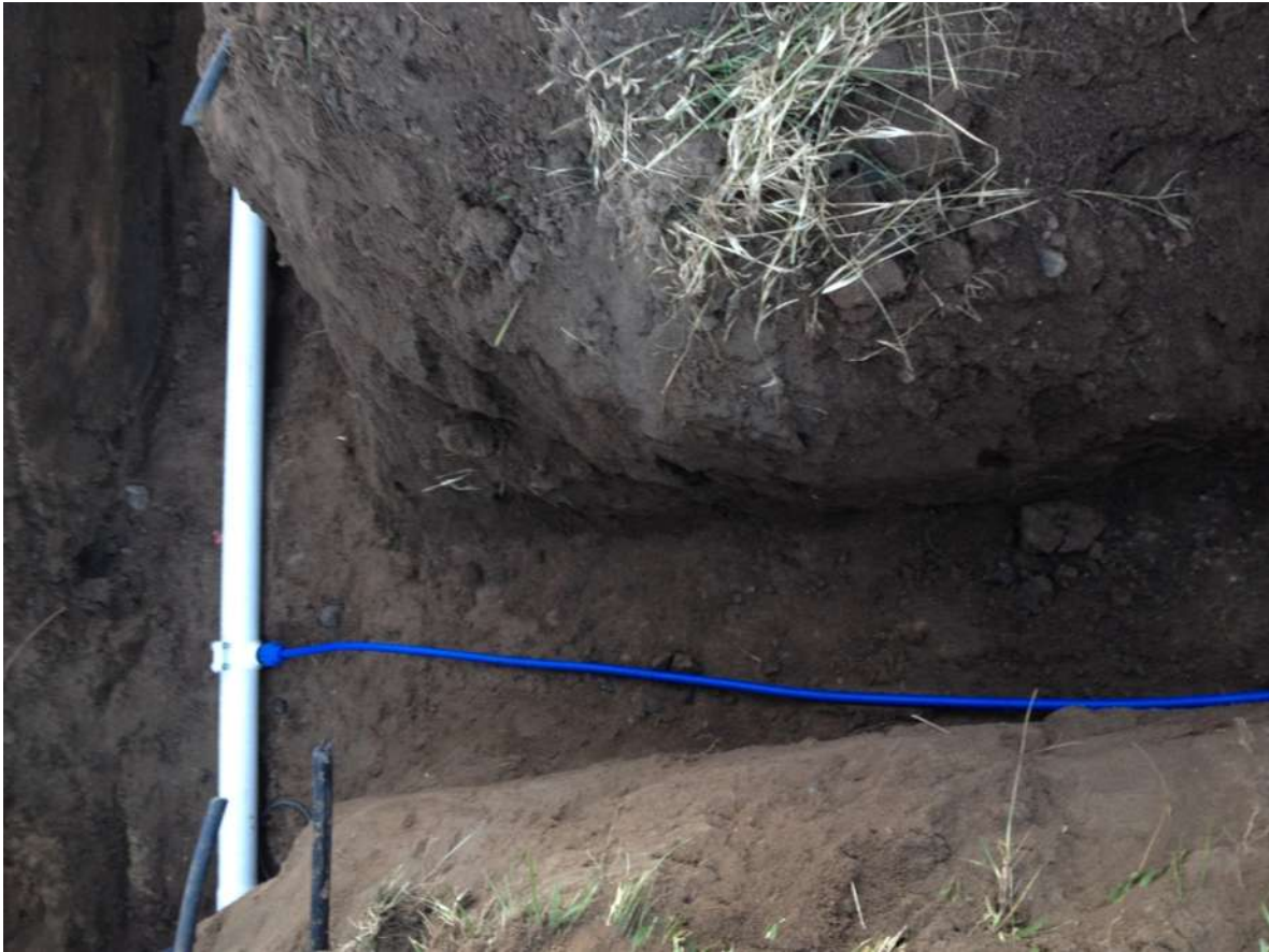
Elaboración de la toma domiciliaria de agua potable.
