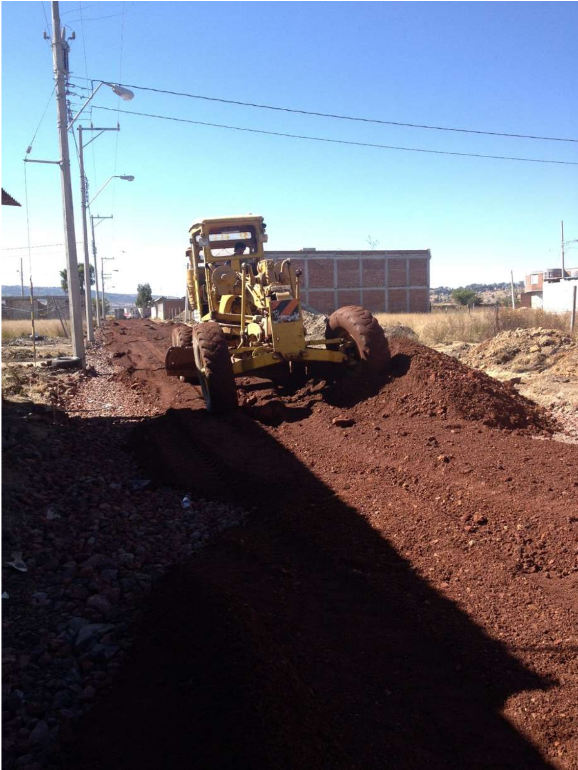
Tendido del material de base.
