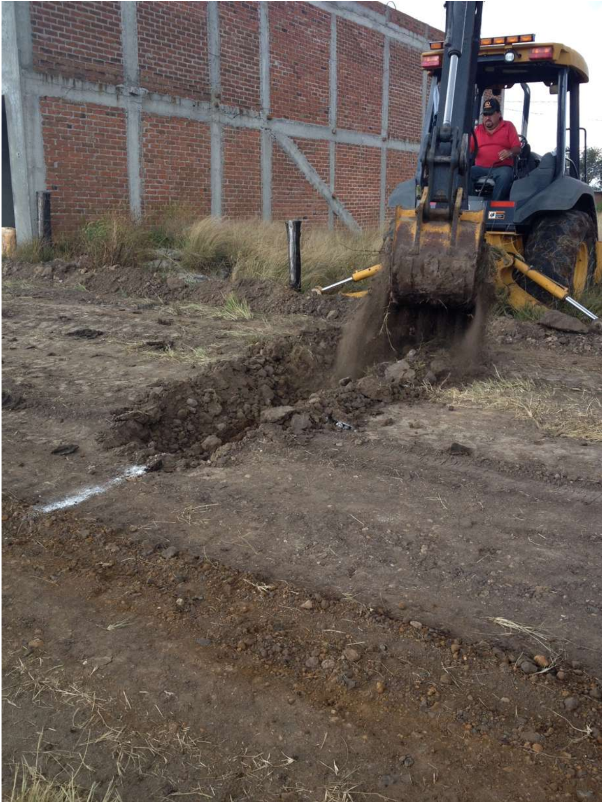
Excavación para la descarga domiciliaria del drenaje sanitario.
