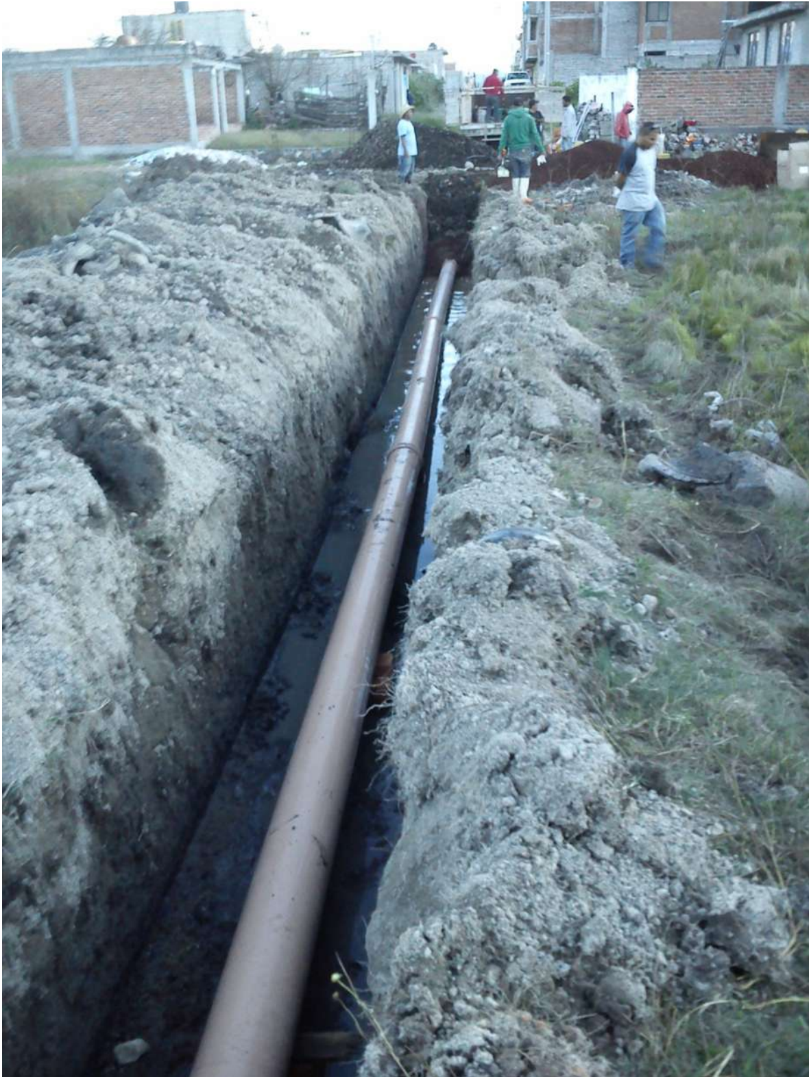
Línea del drenaje principal.
