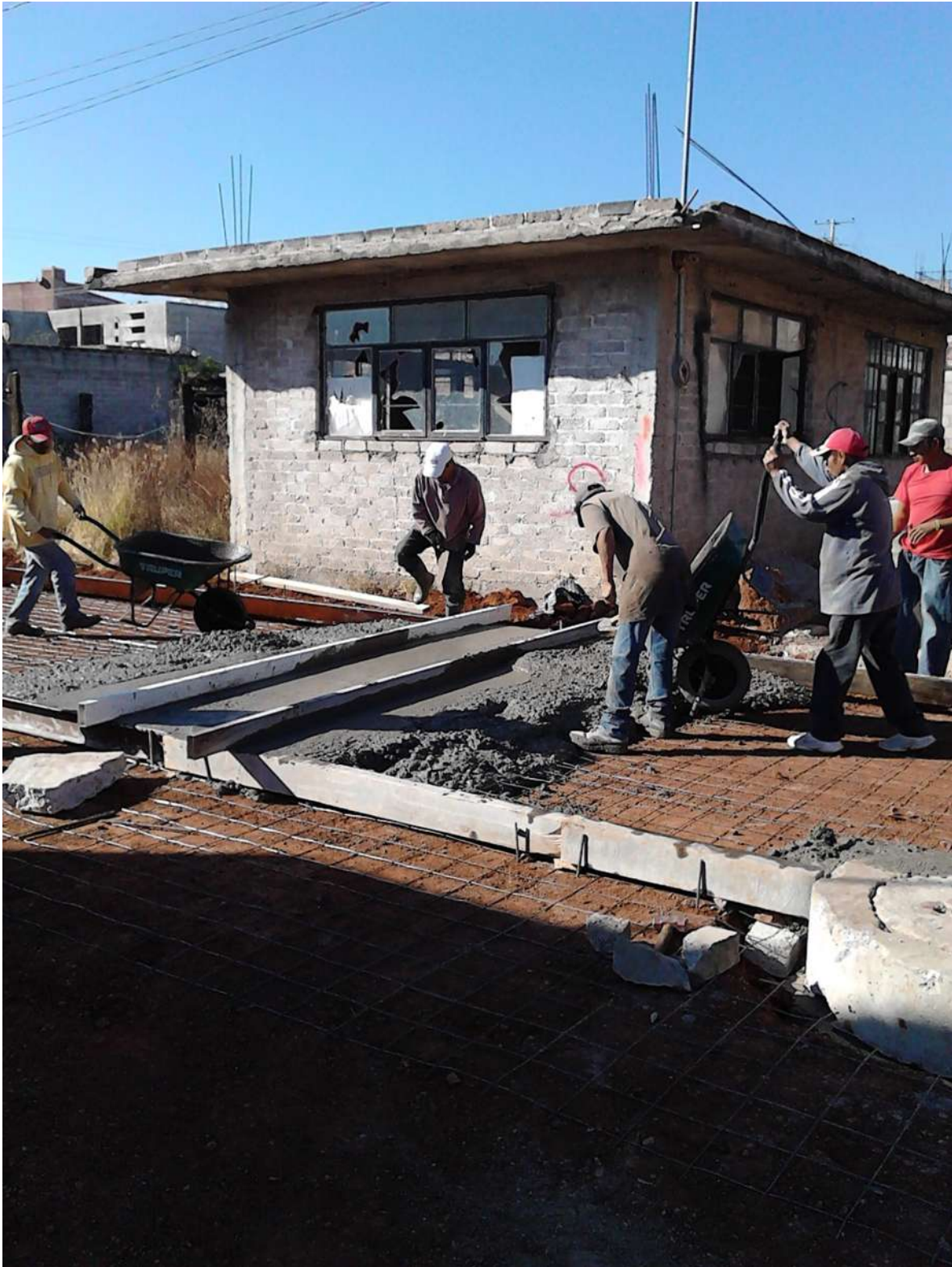
Las dos brigadas comenzando con el tendido del concreto hidráulico.
