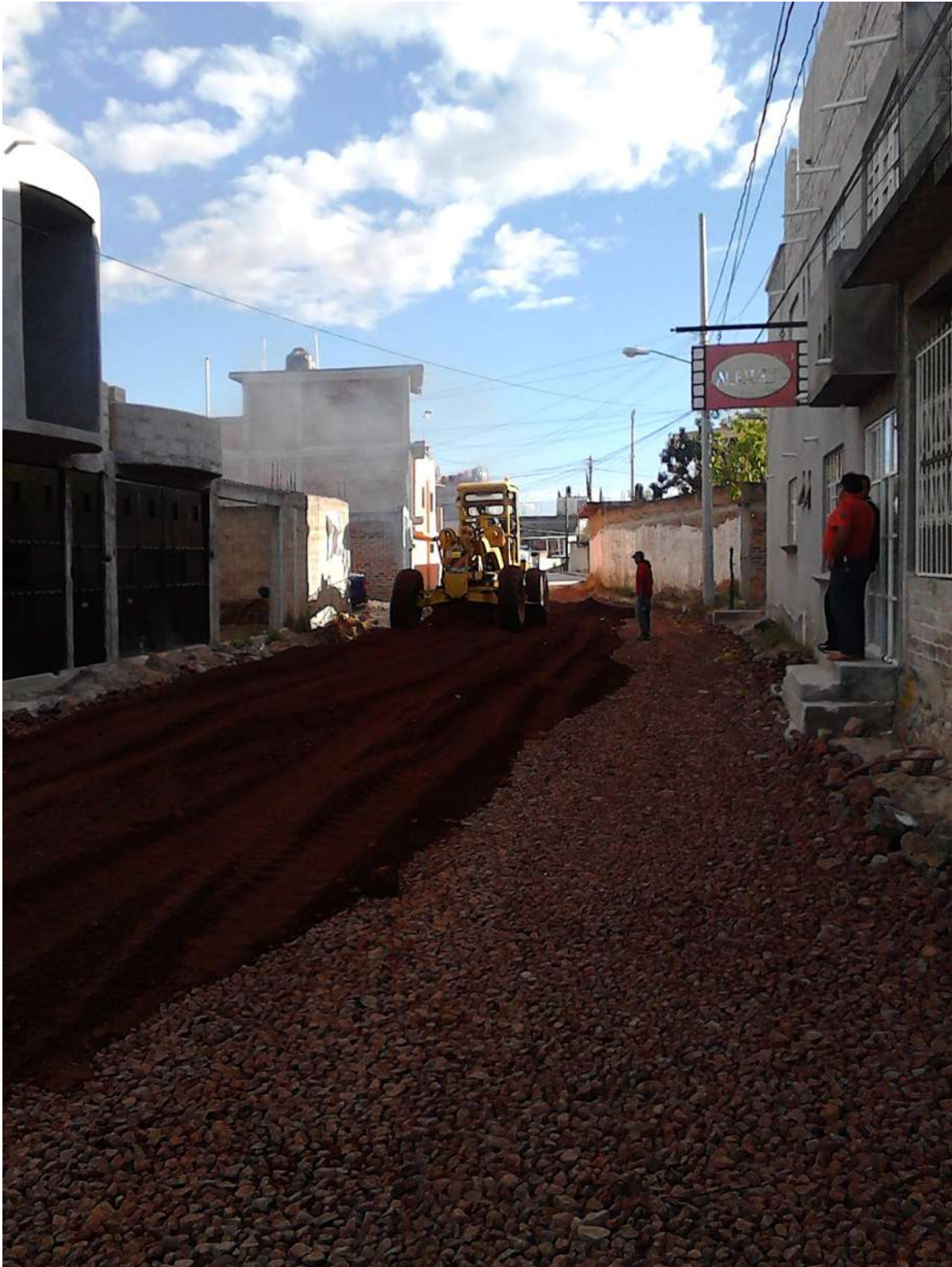
Tendido del material tipo base con la motoconformadora.
