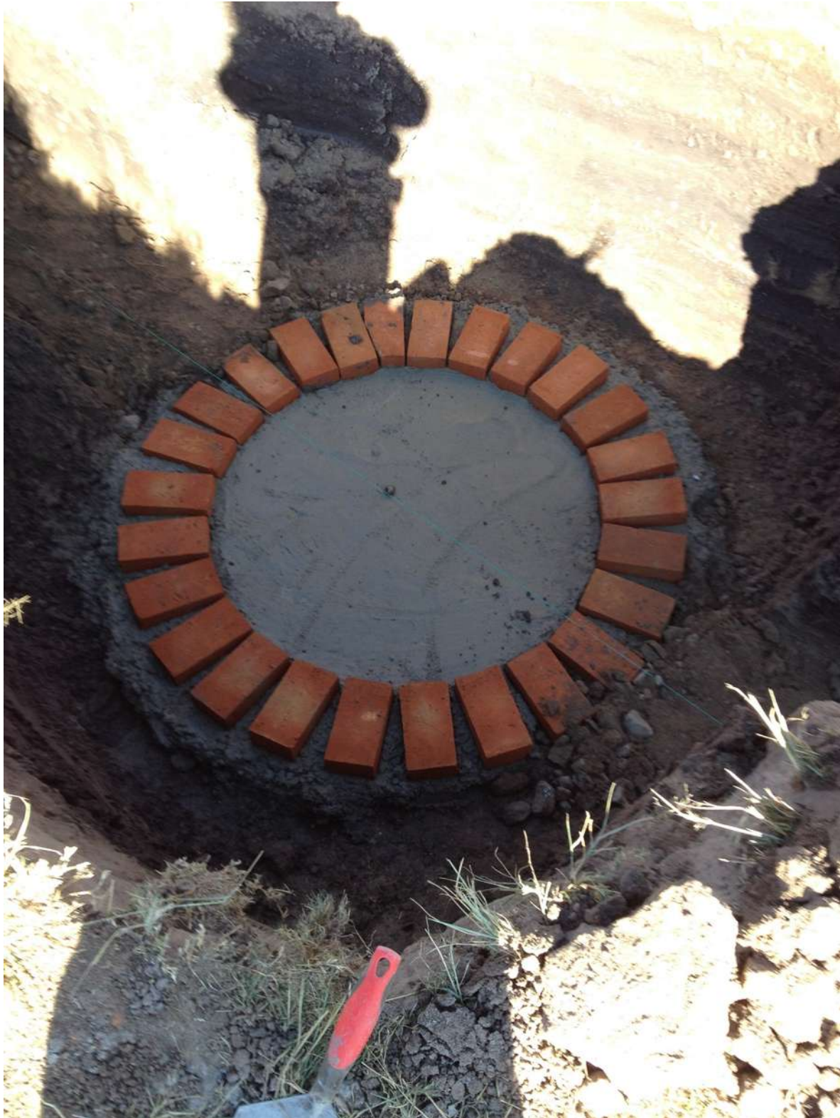
Trazo y nivelación para la construcción de los pozos de visita.
