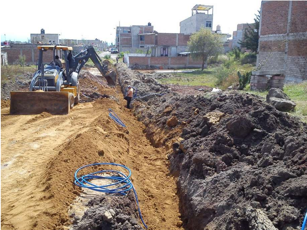
Encamado y encostillado de la tubería del agua potable.
