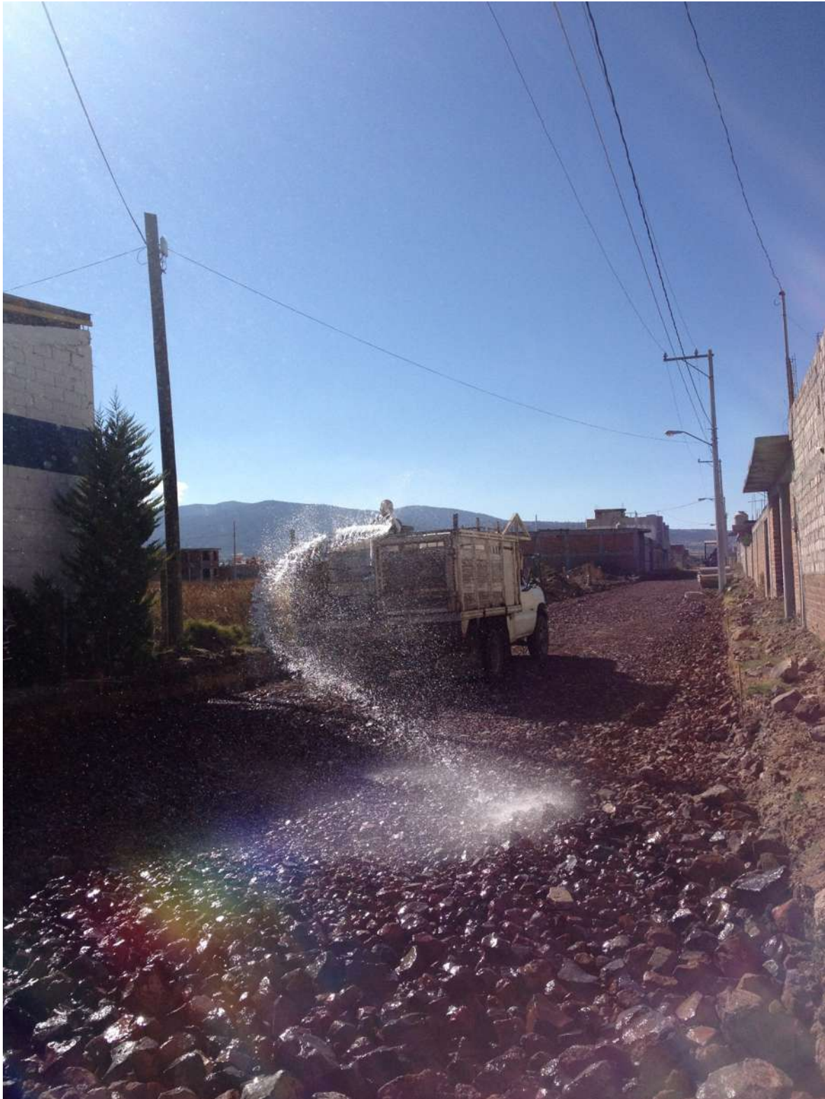
Riego de la capa de filtro para obtener la humedad requerida para su acomodo.
