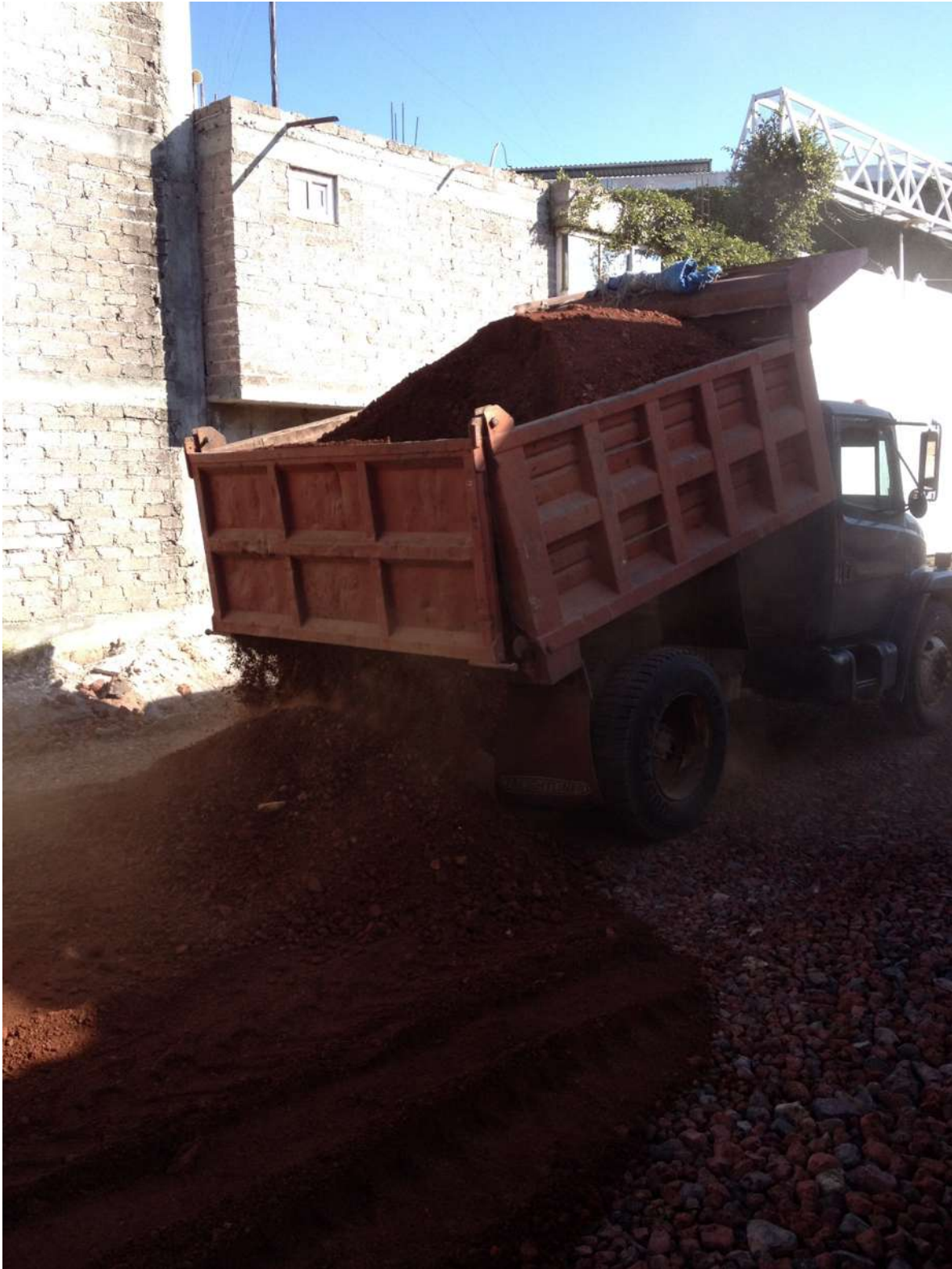
Acarreo del material de base.
