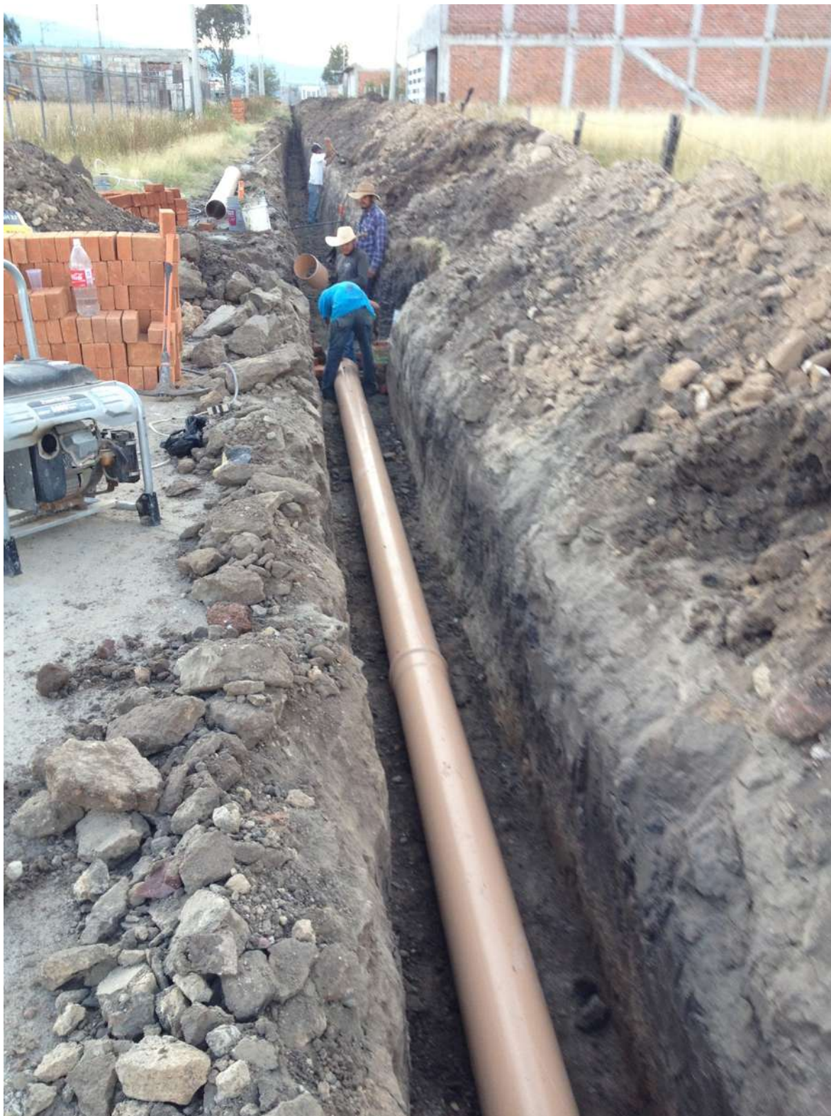
Colocación de la tubería del drenaje sanitario.
