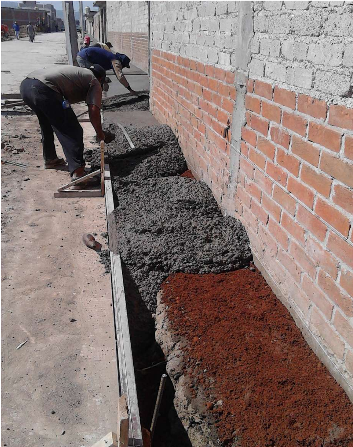
Detallado del concreto de las banquetas.
