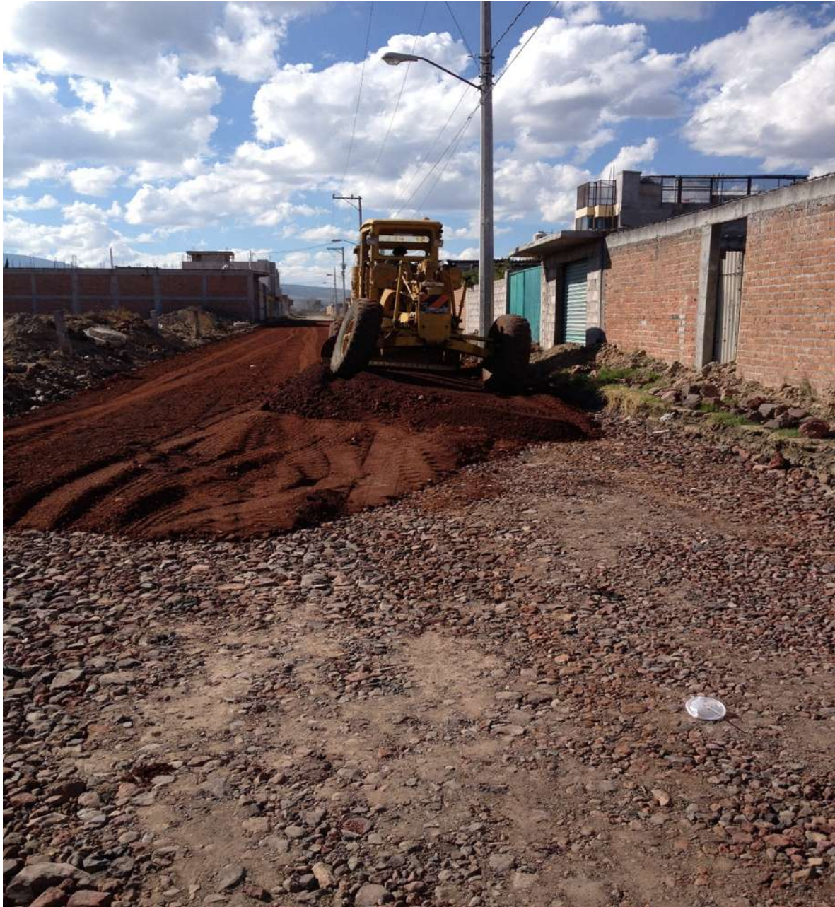
Tendido de la capa de base con una motoconformadora.
