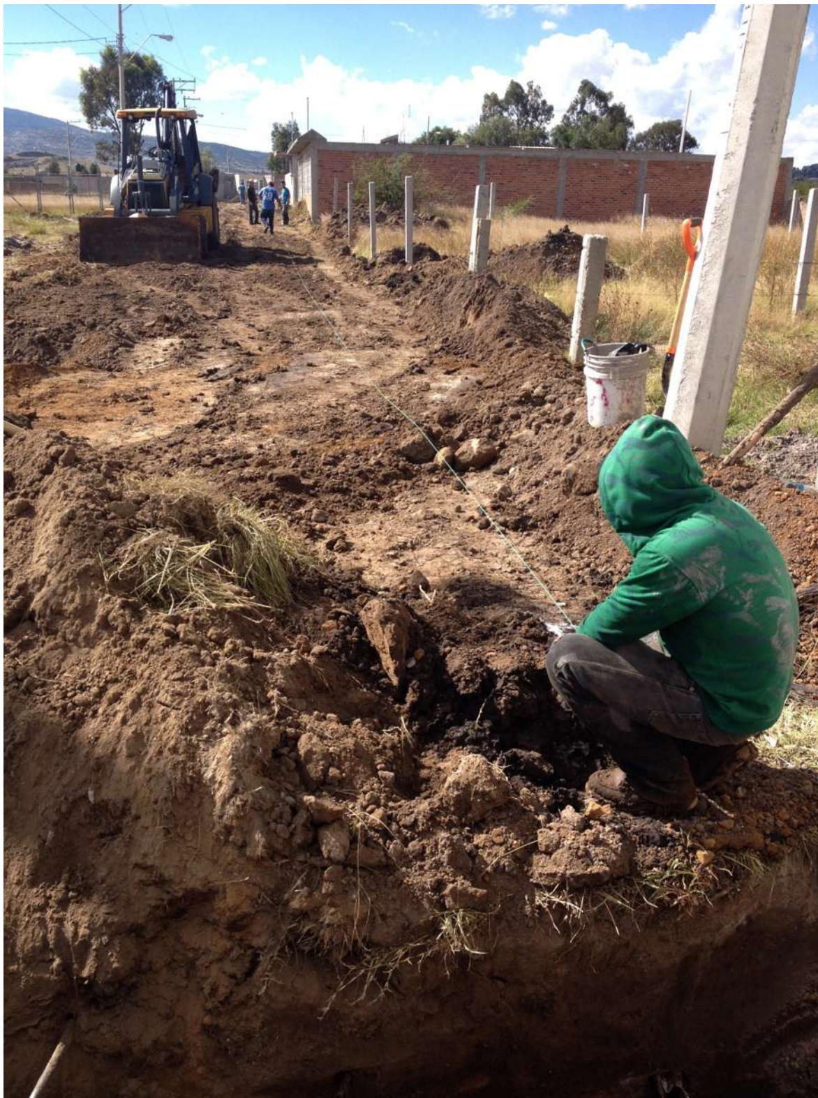
Trazo y nivelación para la excavación de la red de agua potable.
