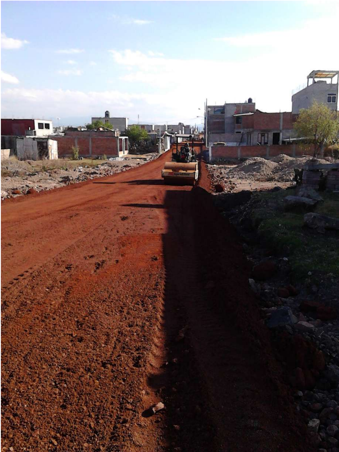
Vibrocompactador compactando la base.
