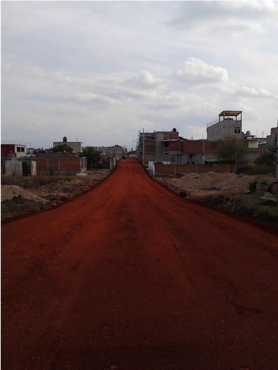
Capa de base con proceso de compactación terminado.
