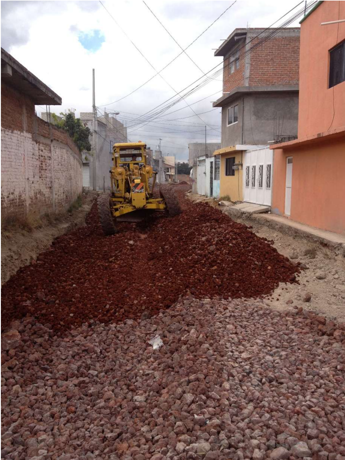
Tendido del filtro para el acomodo de la capa.
