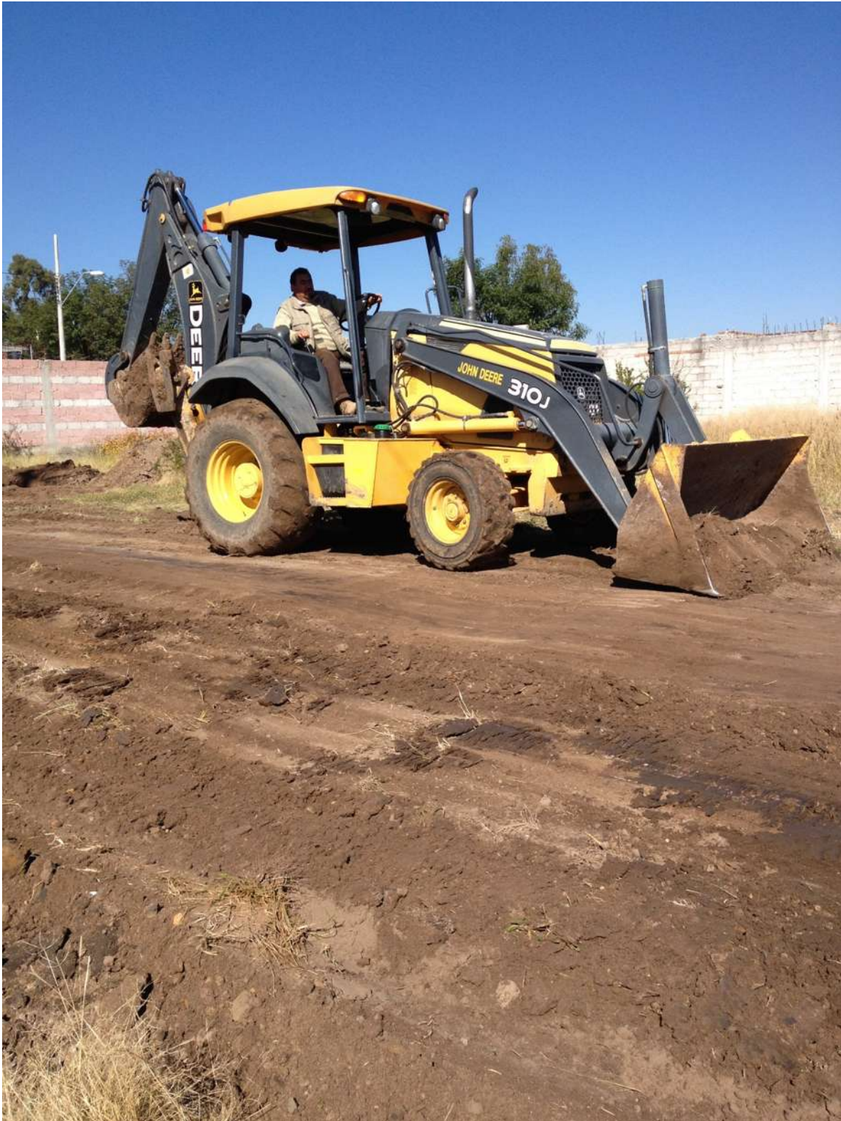
Limpieza del terreno natural para la excavación de la caja estructural.
