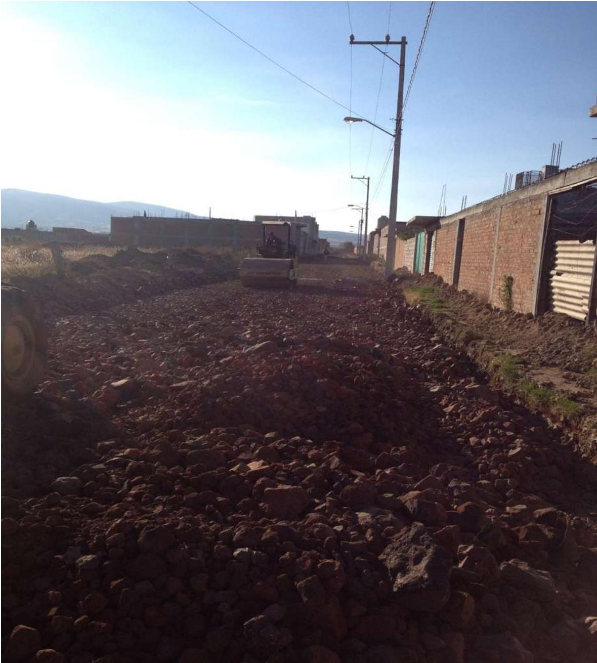
Acomodo de la capa de filtro
