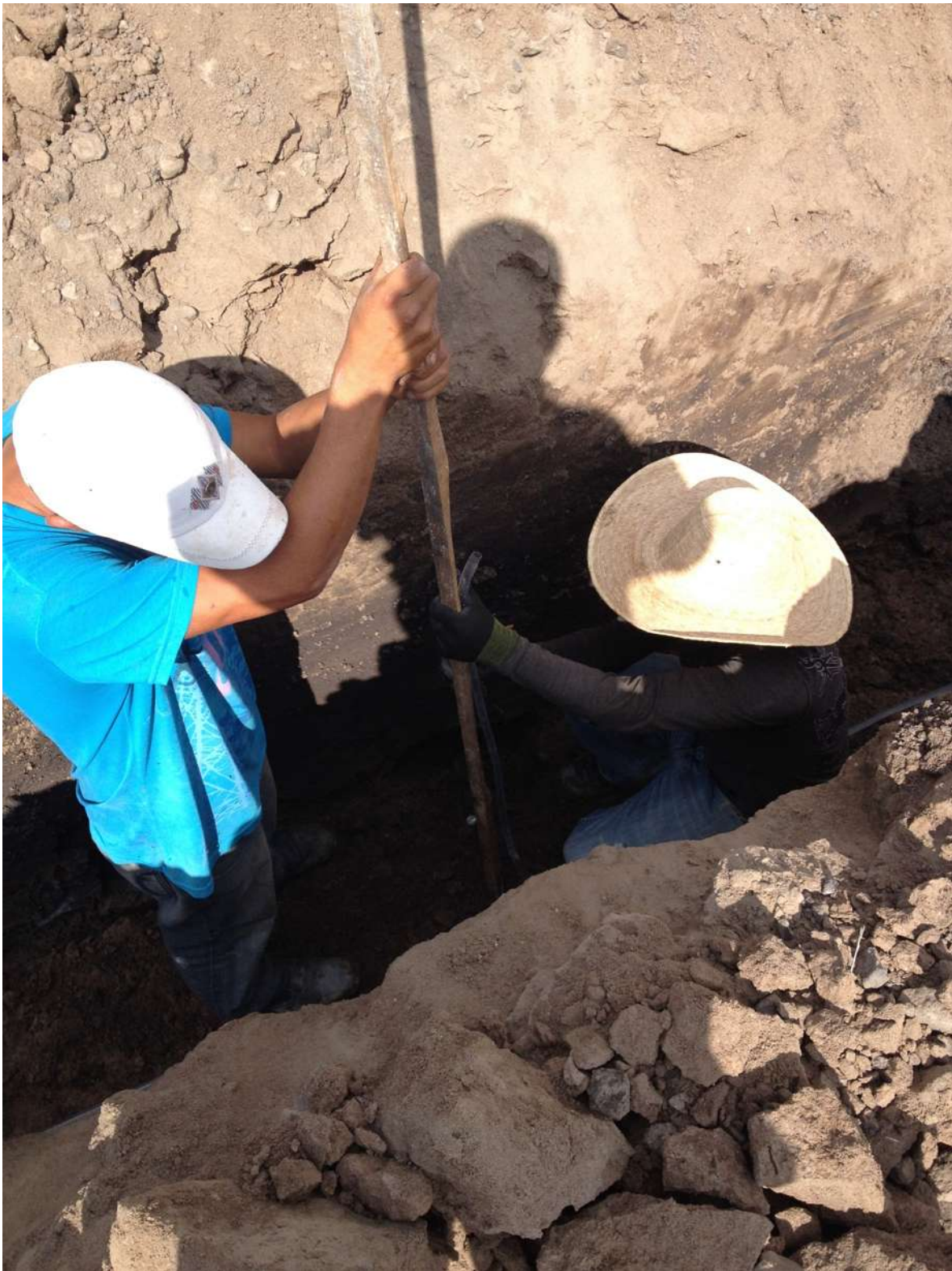
Nivelación de la excavación para la tubería de la red de drenaje sanitario.
