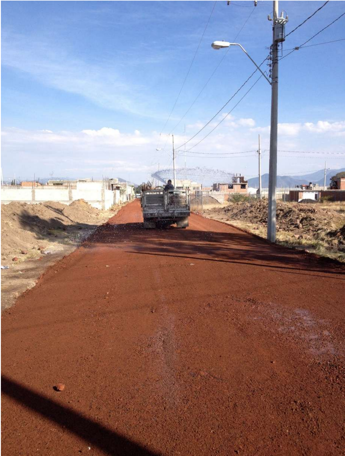
Riego de la capa de base para proporcionarle humedad para obtener su grado de compactación deseado.
