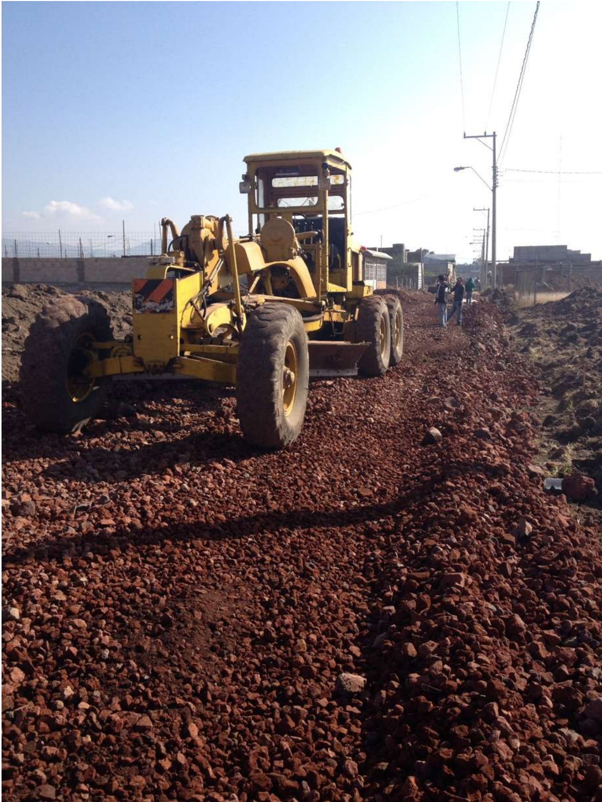
Inicio del tendido de la capa de filtro.
