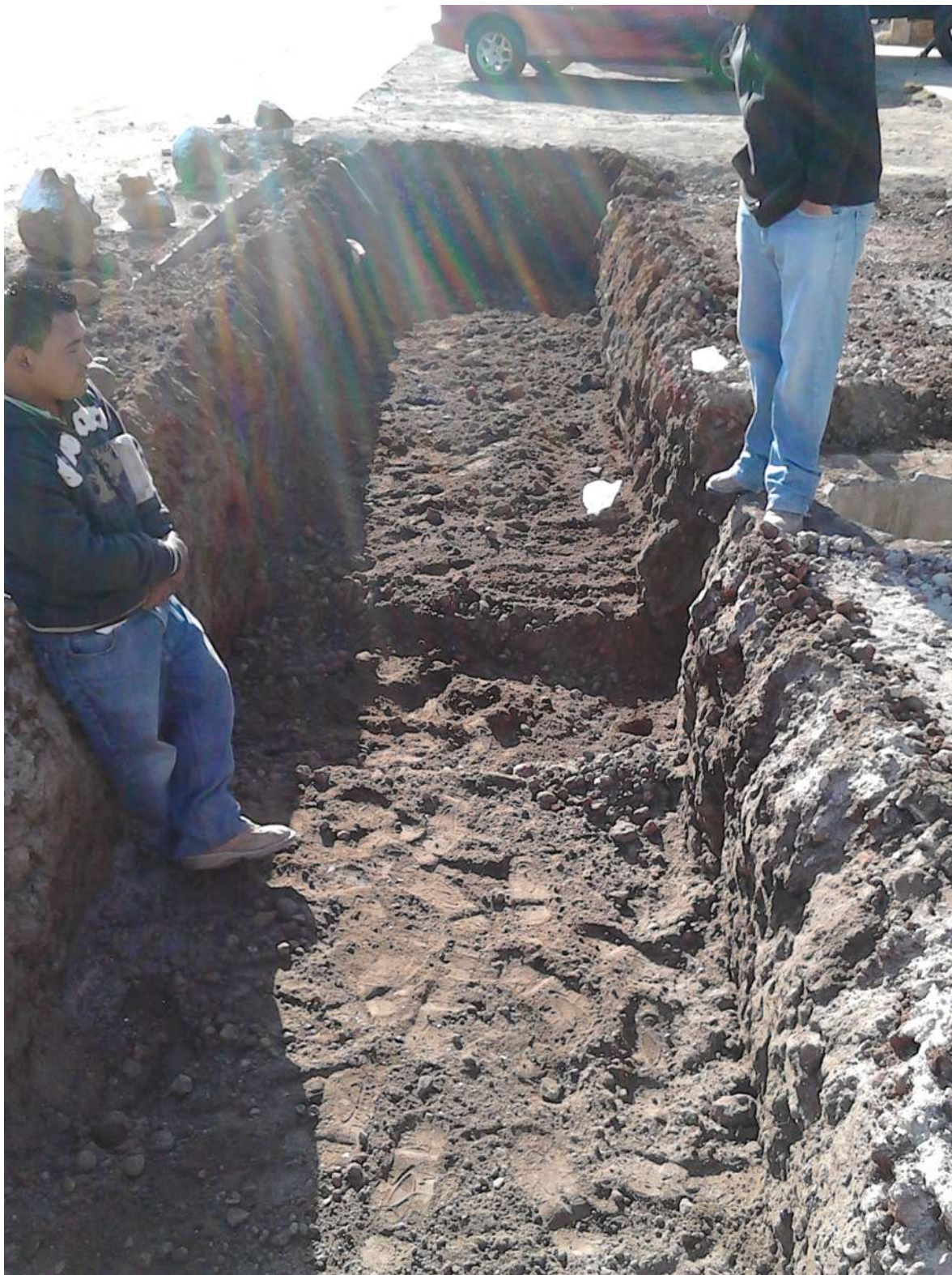
Excavación para la construcción de la rejilla.
