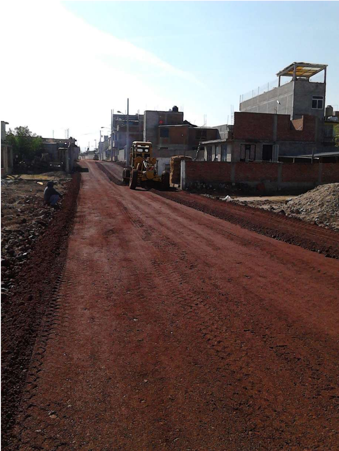
Motoconformadora realizando trabajos para dar niveles de piso terminado.
