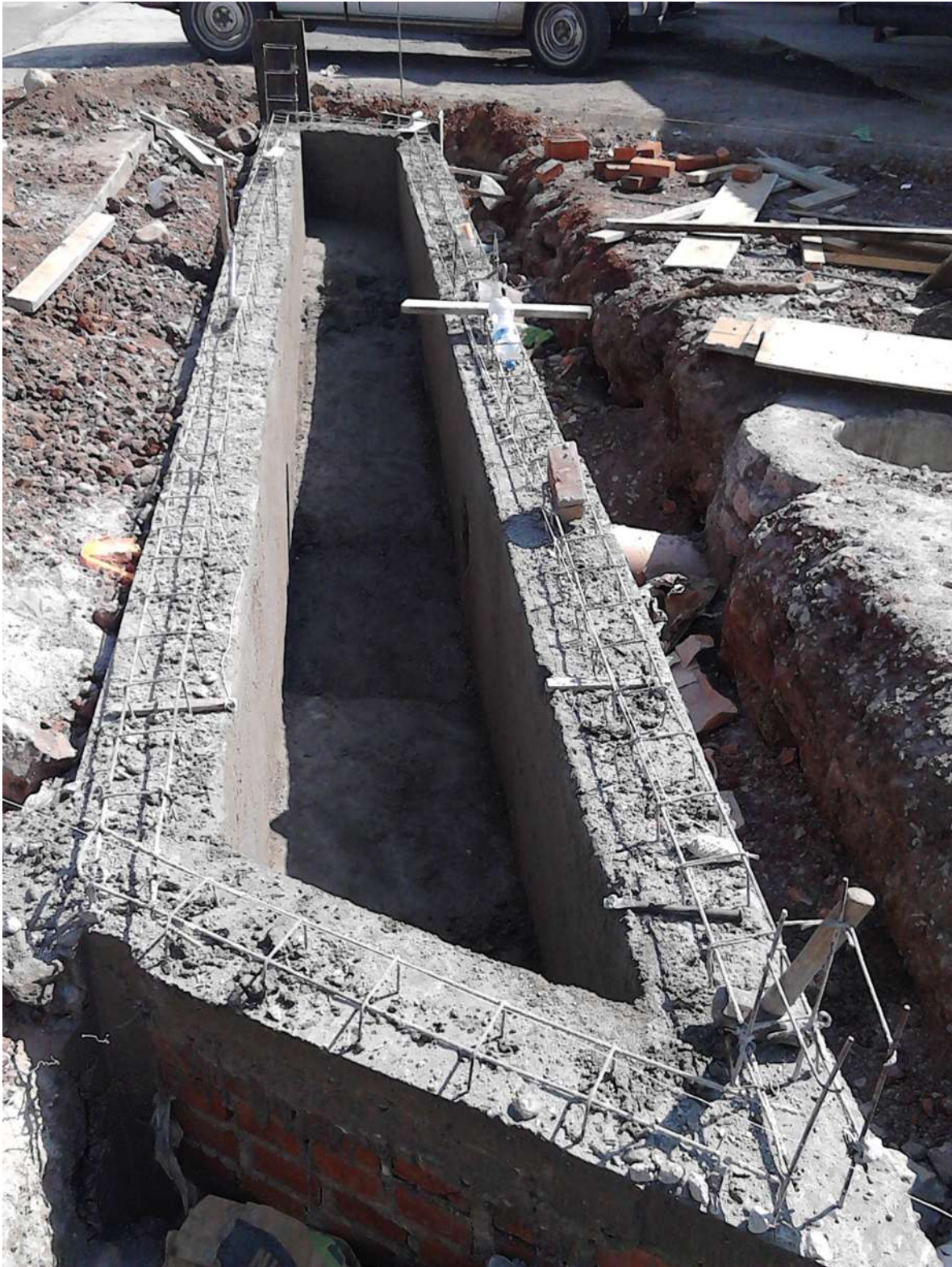
Rejilla terminada faltante de colar su perímetro y colocar su herrería.
