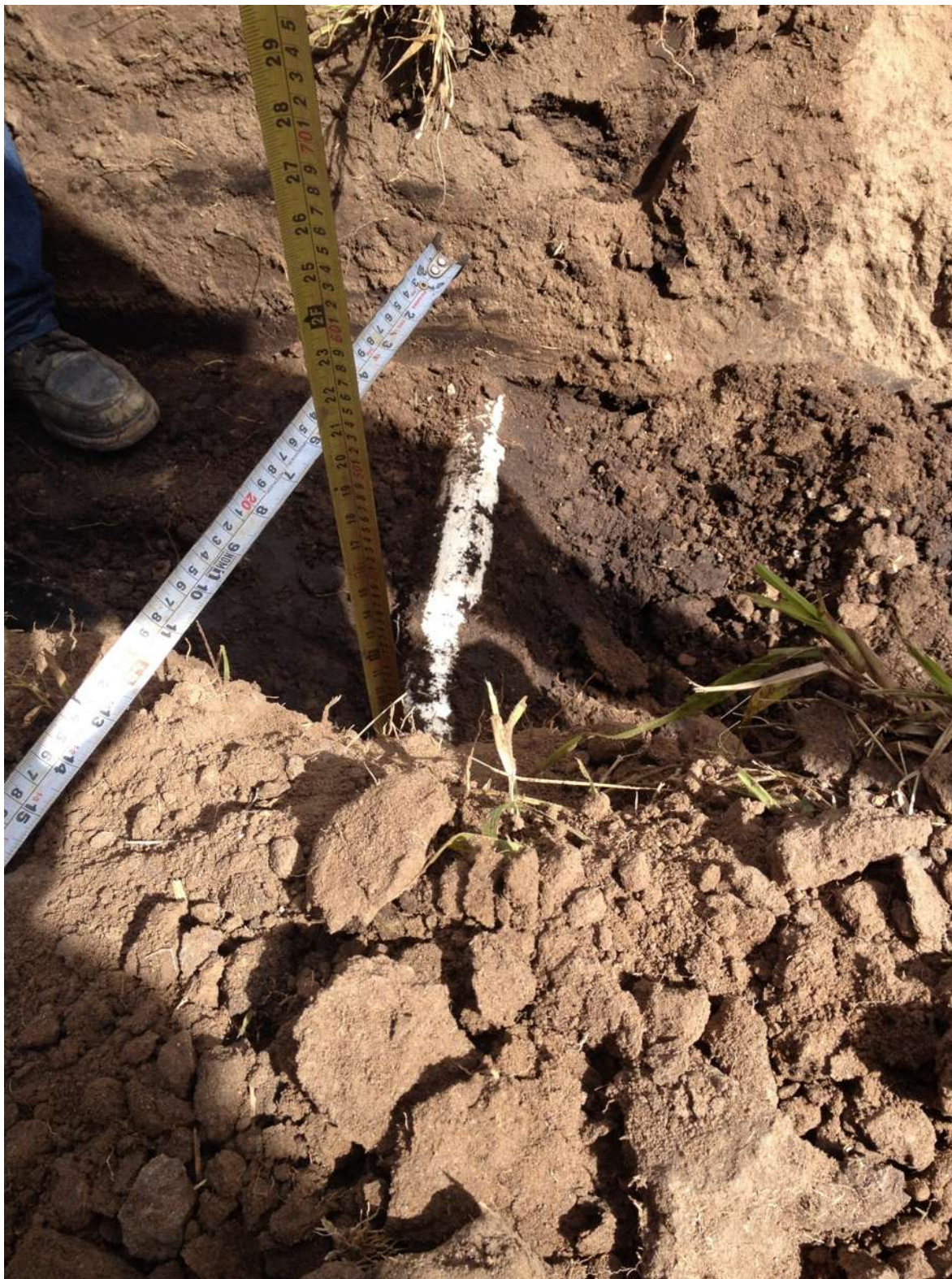
Sondeo de la tubería del agua potable.
