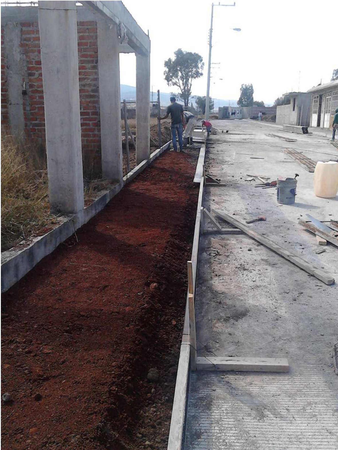
Terreno compactado y cimbrado para el colado de banquetas y guarniciones.
