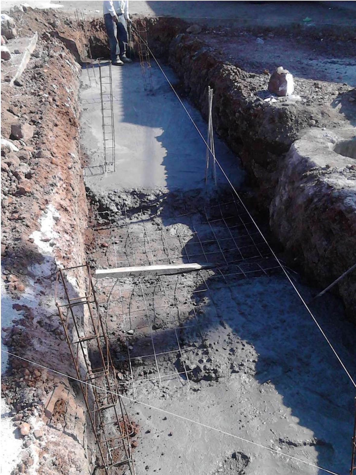
Armado de castillos y plantilla de la rejilla.
