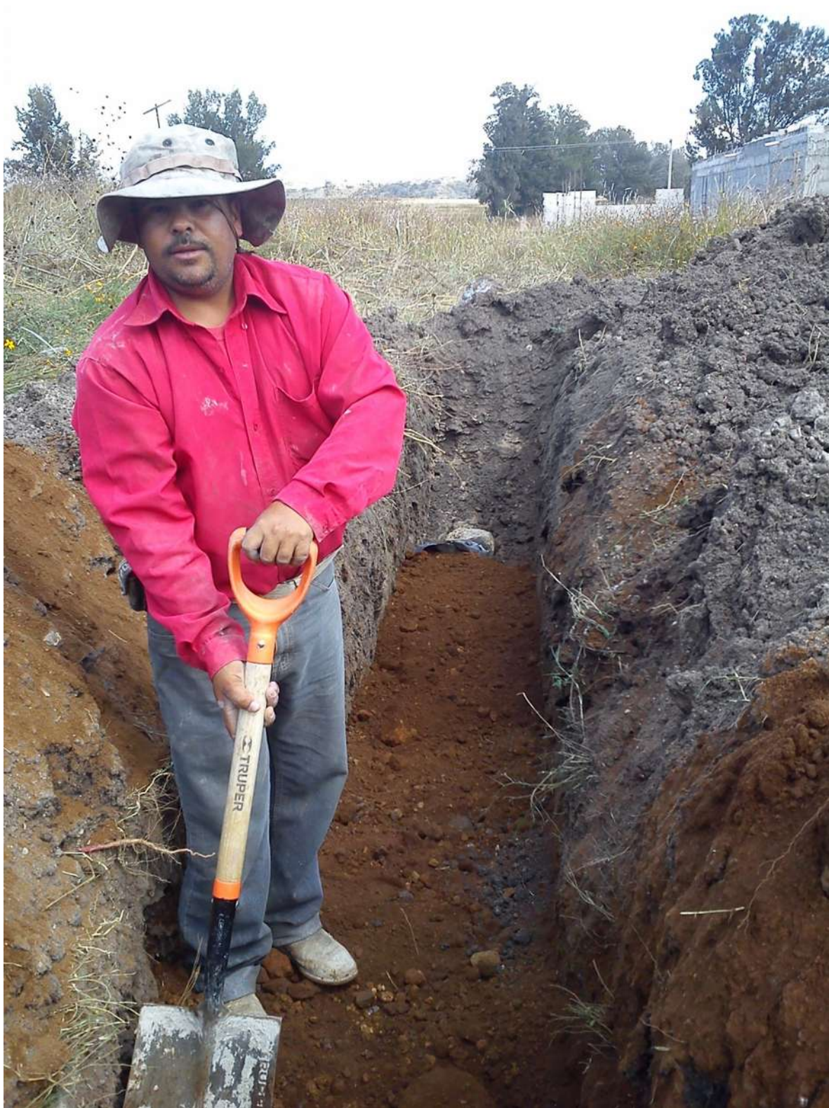
Encamado y encostillado de la tubería de las descargas domiciliarias.
