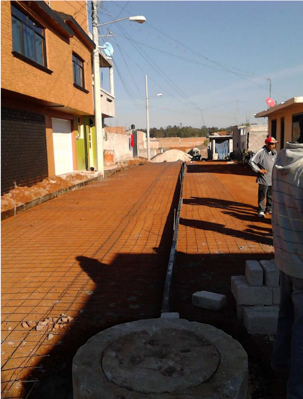
Cimbrado para comenzar con el tendido del concreto hidráulico hecho en sitio armado con malla electrosoldada.
