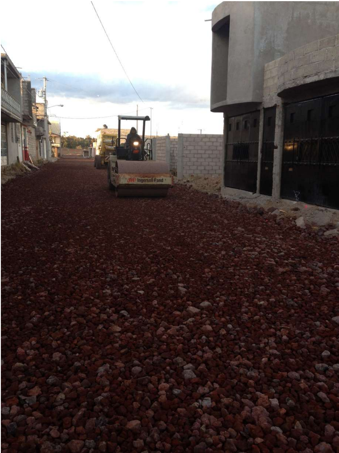
Acomodo de la capa de filtro con el vibrocompactador.
