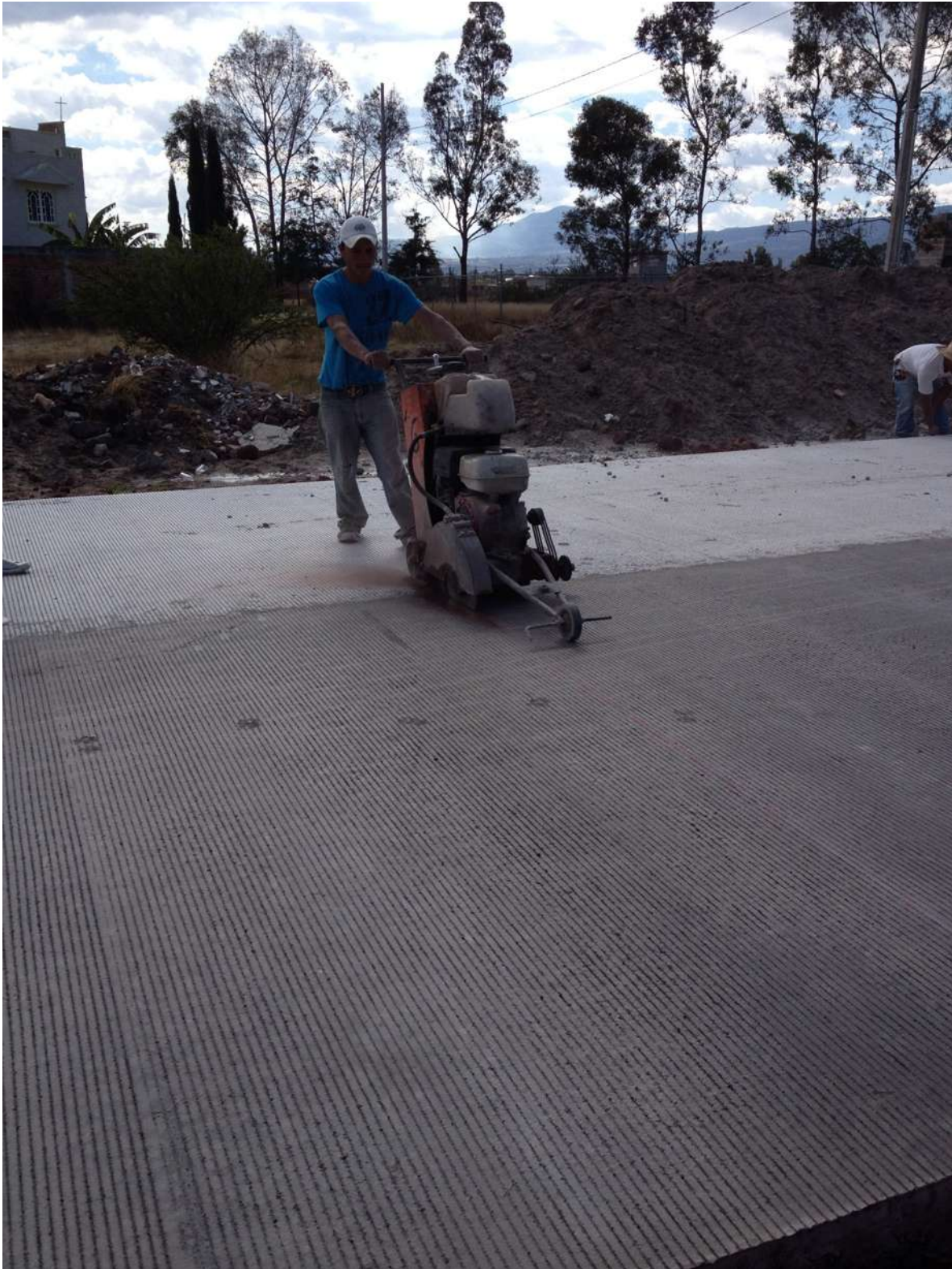
Corte de las piedras del concreto hidráulico.
