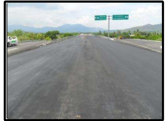
Fotografía 4.6. Determinación De Secciones Topográficas Después De Los Trabajos
