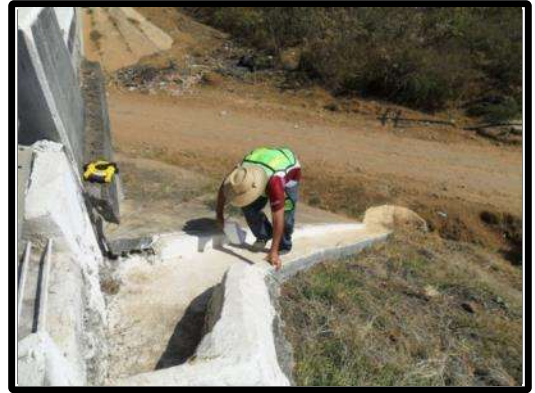
Fotografía 4.2. Medición con Cinta Para Determinar la Cantidad de Obra Ejecutada.
