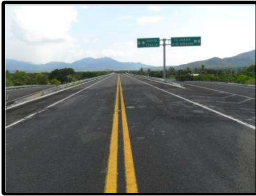
Fotografía 4.10. Antes de los Trabajos de Renivelación con Carpeta Asfáltica, PSV CAJONES Km 122+603.
