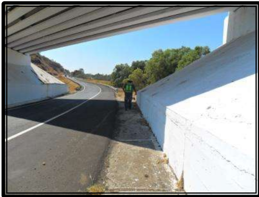
Fotografía 4.1. Medición con Odómetro Para Determinar la Cantidad de Obra Ejecutada.
