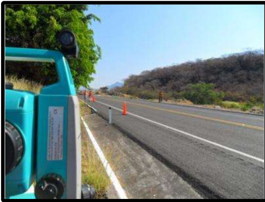
Fotografía 4.5. Determinación De Secciones Topográficas Antes De Los Trabajos
