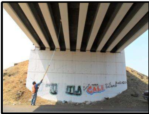
Fotografía 4.7. Antes de los Trabajos de Pintura Vinílica en Aleros, PSV CAJONES Km 122+603.
