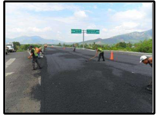
Fotografía 4.10. Durante los Trabajos de Renivelación con Carpeta Asfáltica, PSV CAJONES Km 122+603.
