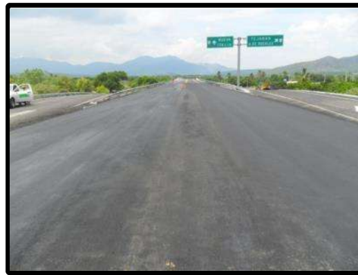
Fotografía 4.10. Después de los Trabajos de Renivelación con Carpeta Asfáltica, PSV CAJONES Km 122+603.
