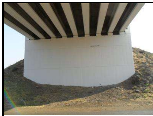
Fotografía 4.9. Después de los Trabajos de Pintura Vinílica en Aleros, PSV CAJONES Km 122+603.
