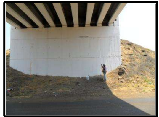
Fotografía 4.8. Durante los Trabajos de Pintura Vinílica en Aleros, PSV CAJONES Km 122+603.
