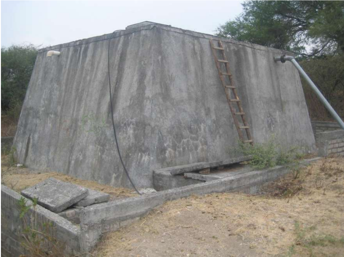
Figura 4.20. Tanque de concreto armado con capacidad de 224m 3
