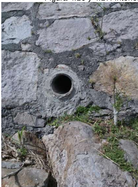
Figura 4.18 y 4.19. Tubo de excedencias y válvula de limpieza del tanque
