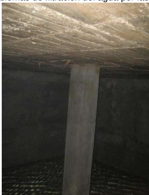
Figura 4.23. Interior del tanque de concreto armado
