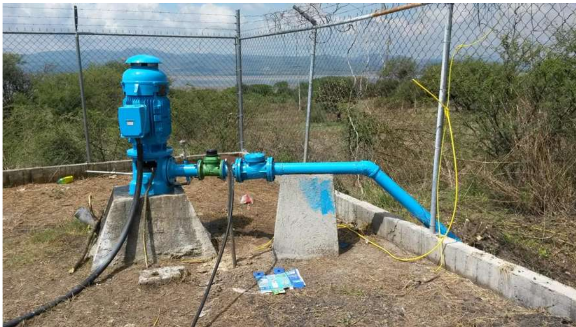
Figura 4.2. Instalaciones del pozo No. 2
