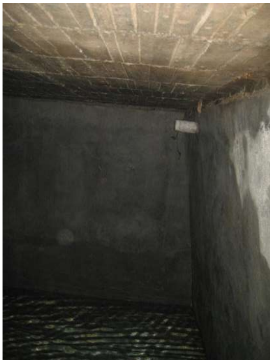
Figura 4.24 Tubería de descarga de la línea de conducción.
