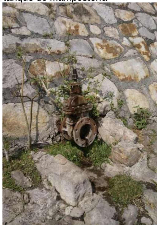
Figura 4.18 y 4.19. Tubo de excedencias y válvula de limpieza del tanque
