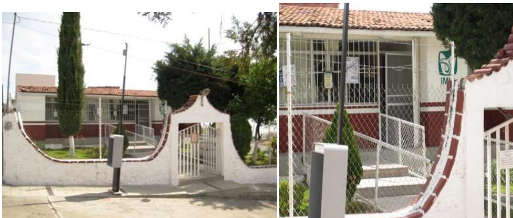
Figura 3.9 y 3.10. Instalaciones de la clínica del IMSS
