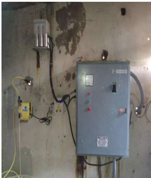
Figura 4.11 y 4.12. Tableros de control de los pozos No. 1 (izquierda) y No.2 (derecha)
