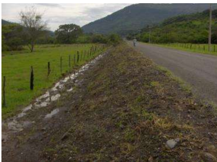
Vista de desmonte después de la ejecución mayor visibilidad en el camino.
