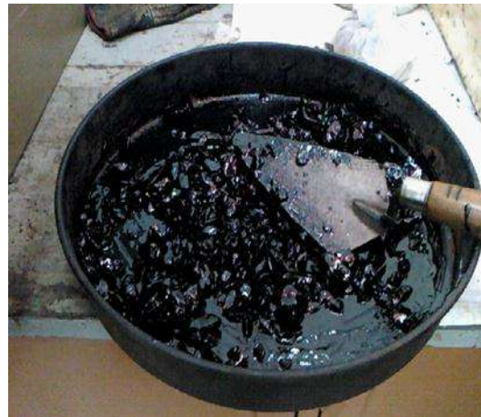
Fig. 4.10. Mezclado del material
