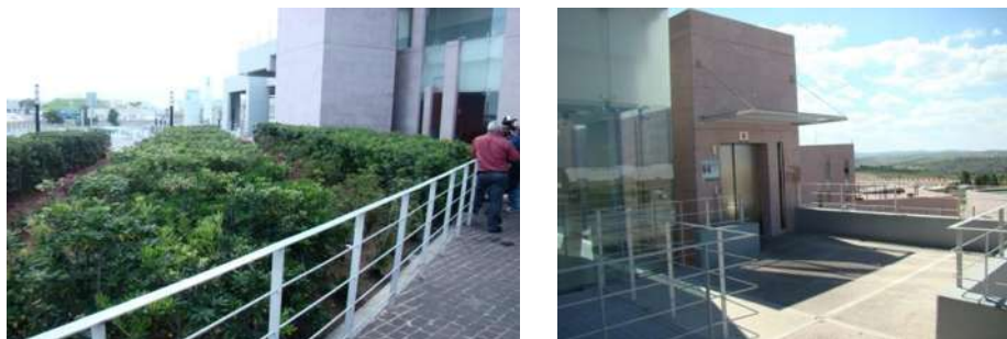
Figura 3.27 Acceso a gineco obstetricia planta baja del HGR N° 1
