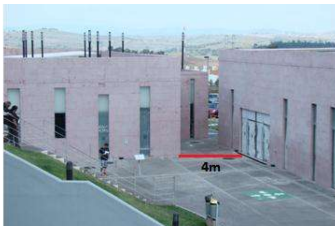
Figura 3.20 Separación de edificios del HGR N° 1
