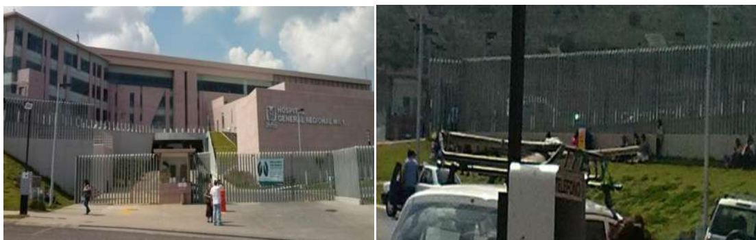
Figura 3.12 Barda Perimetral del HGR N° 1
