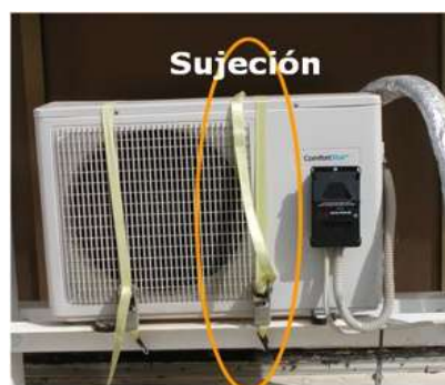
Figura 2.43 Seguridad a elementos no estructurales (Fuente: manual del evaluador).
