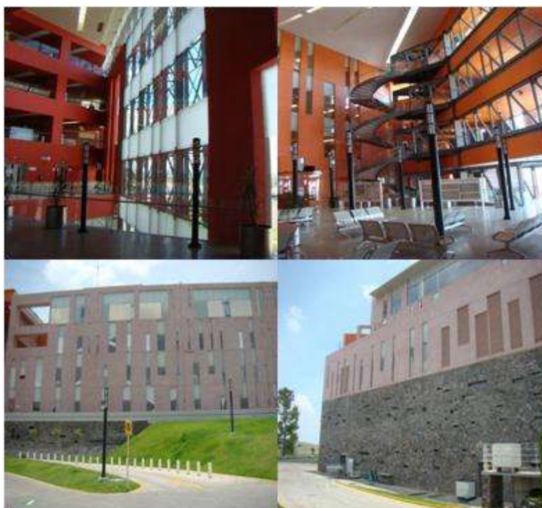
Figura 3.25 Estructura del HGR N° 1
