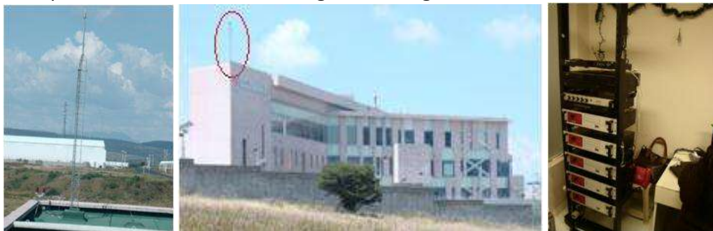
Figura 3.29 Sistema de telecomunicaciones del HGR N° 1
