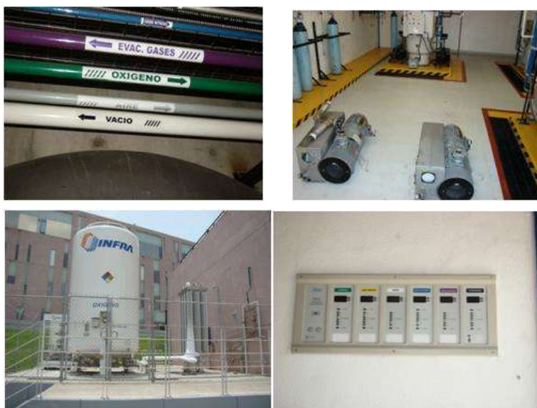
Figura 3.32 Gases medicinales del HGR N° 1
