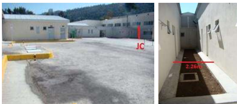
Figura 3.47 Proximidad de edificios del HGZ N° 83
