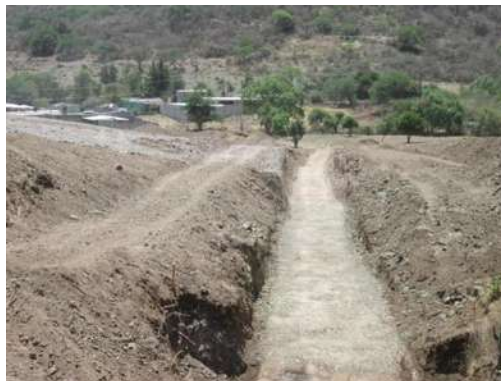
Figura 4.1.2.- Nivelación del terreno.
