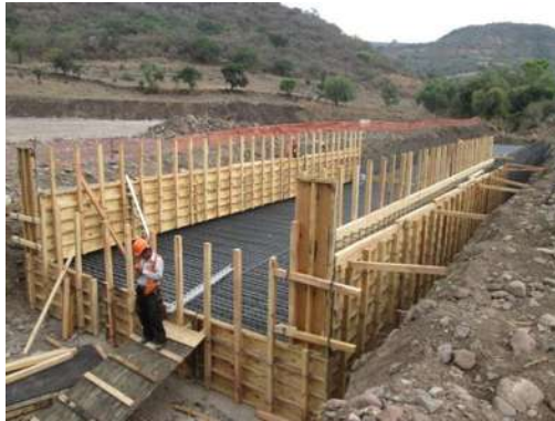
Figura 3.1.17.- Colocación de la cimbra.
