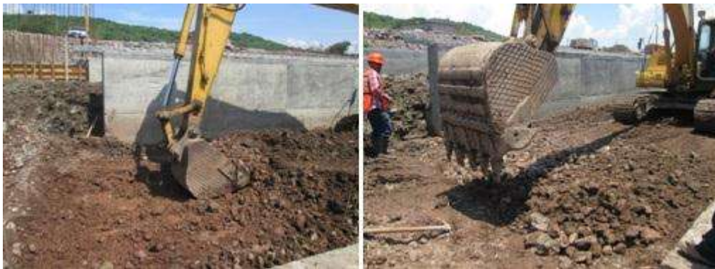
Figura 3.2.5.- Nivelación del terreno.
