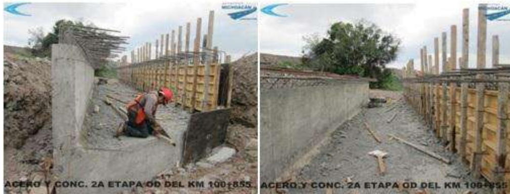
Figura 6.1.10.- Descimbrado.
