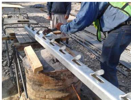
Figura 3.1.10.- Habilitado del canal.
