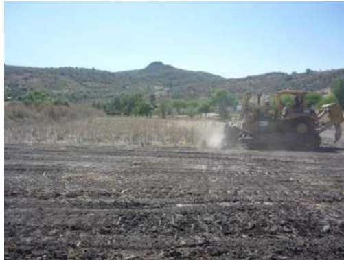
Figura 2.1.1.- Despalme en el eje de construcción.
