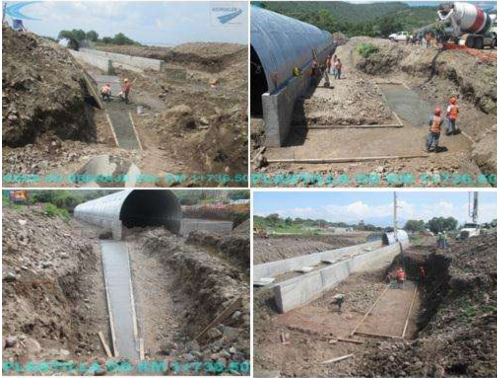
Figura 3.2.6.- Colocación de la plantilla.
