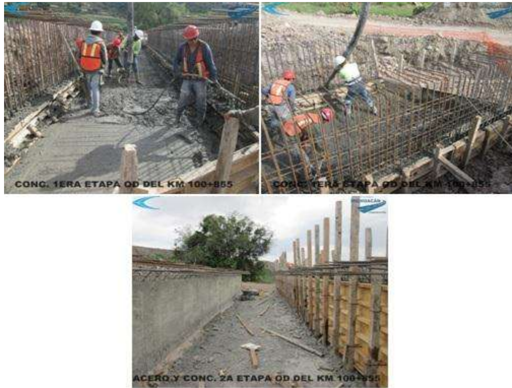
Figura 6.1.9. Colocación del concreto.
