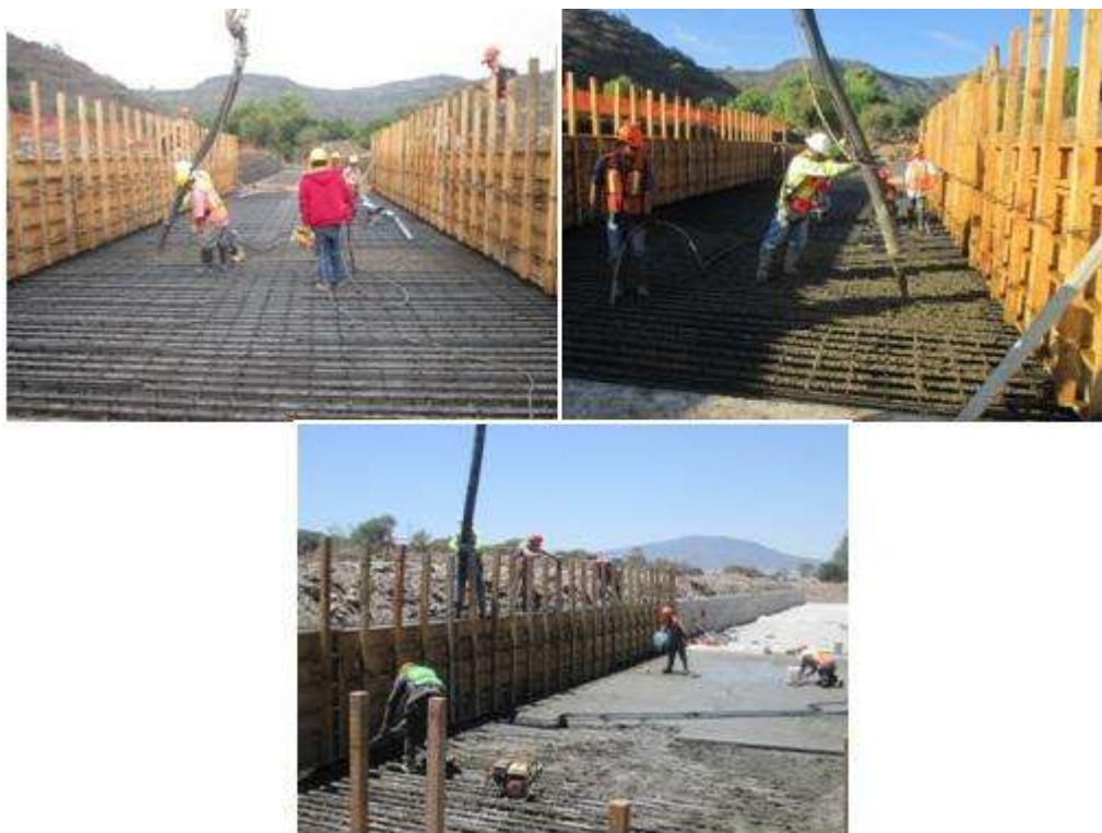
Figura 3.1.25.- Colocación y vibrado del concreto.
