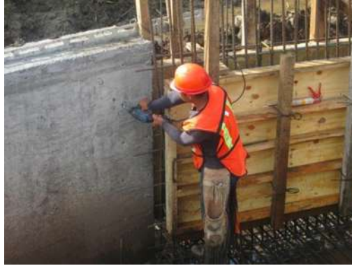
Figura 3.2.11.- Colocación de las barbas.
