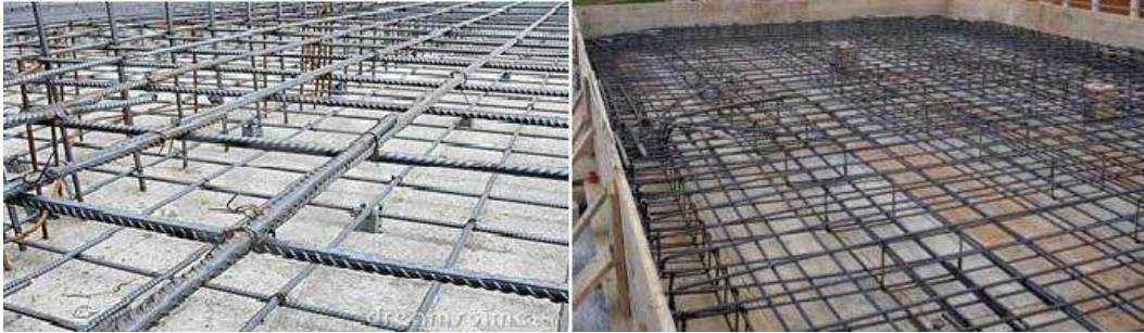
Figura 6.2.1.- Colocación del acero.
