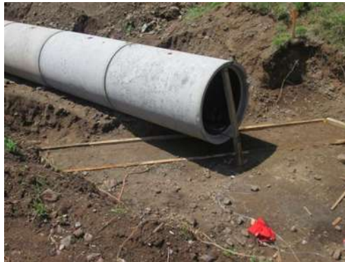
Figura 4.2.1.- Nivelación del terreno.
