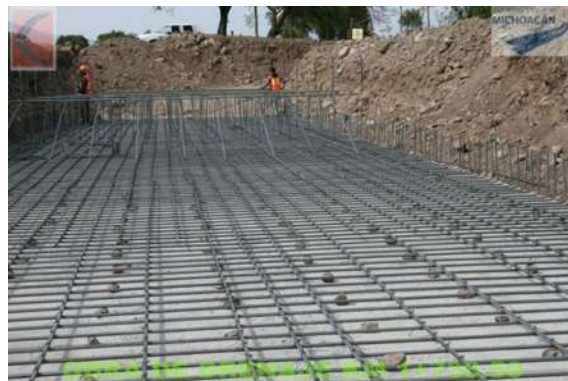
Figura 3.1.12.- Armado del acero.
