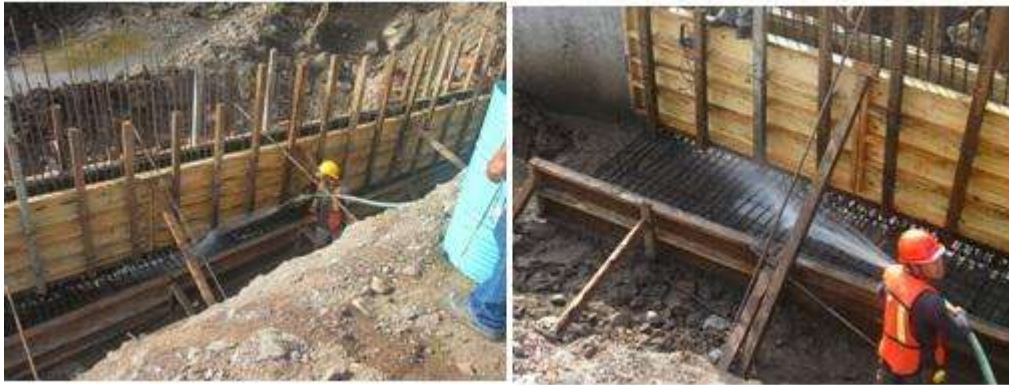
Figura 3.2.14.- Limpieza para la obra falsa.
