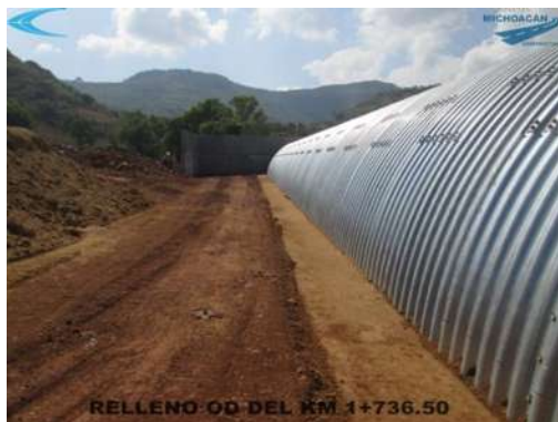
Figura 3.4.1.- Colocación del relleno de protección.
