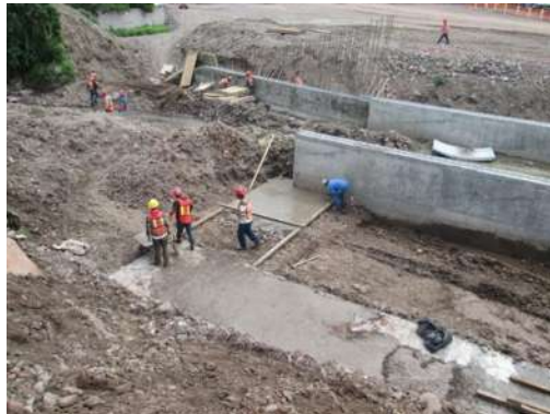
Figura 3.2.8.- Colocación de la plantilla.
