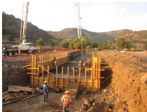
Figura 3.1.22.- Colocación y vibrado del concreto.
