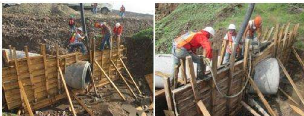
Figura 4.2.8.- Colocación del mortero.
