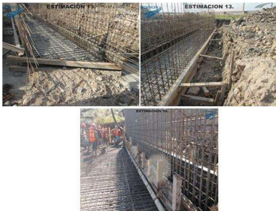
Figura 6.1.6.- Colocación del acero.
