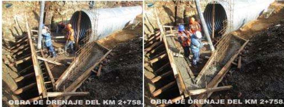
Figura 5.2.7.- Colocación del concreto.
