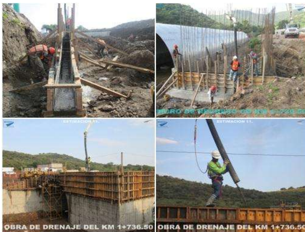
Figura 3.2.17.- Colocación del concreto.
