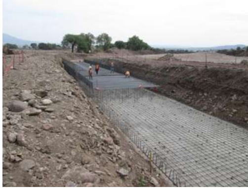
Figura 3.1.13.- Armado del acero.
