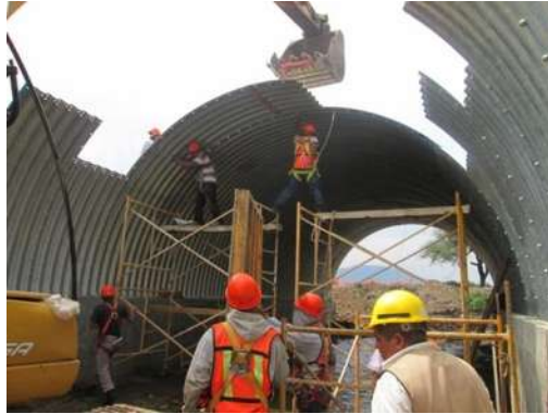
Figura 3.1.33.- Colocación de lámina.
