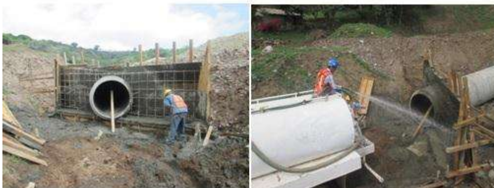
Figura 4.2.10.- Limpieza del acero.
