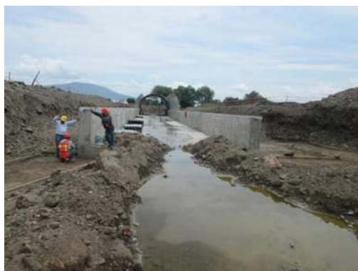
Figura 3.2.3.- Protección para la obra.
