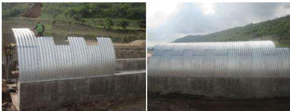
Figura 3.1.30.- Armado de lámina galvanizada
