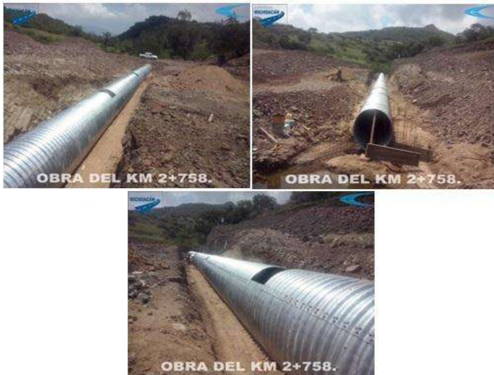
Figura 5.1.5.- Colocación de lámina.
