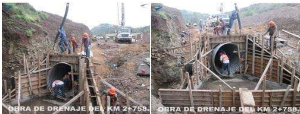
Figura 5.2.6.- Colocación de la cimbra.
