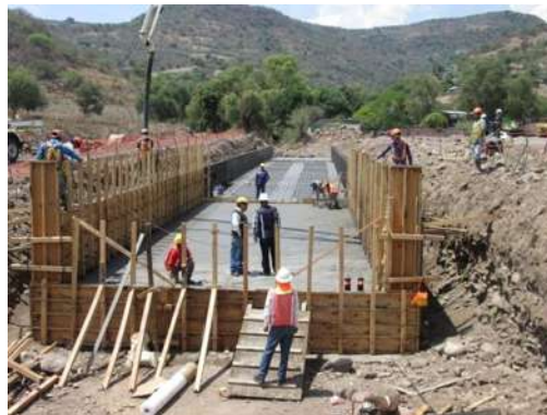
Figura 3.1.24.- Colocación y vibrado del concreto.
