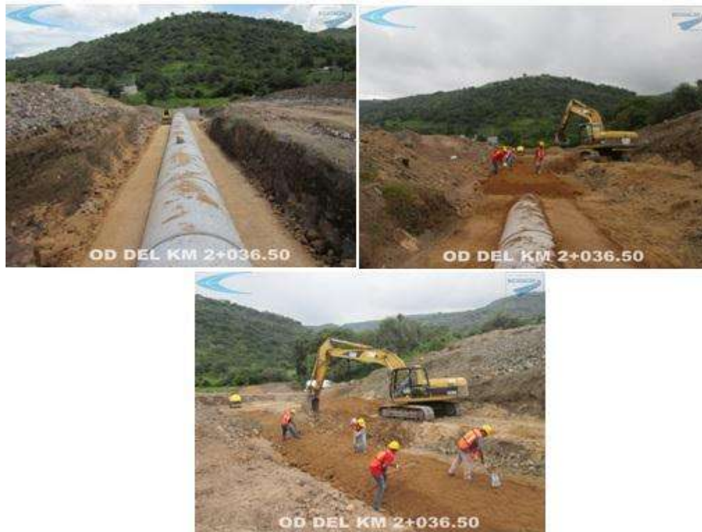
Figura 4.4.- Colocación del relleno de protección.
