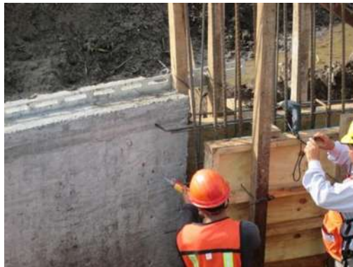
Figura 3.2.12.- Colocación de las barbas.
