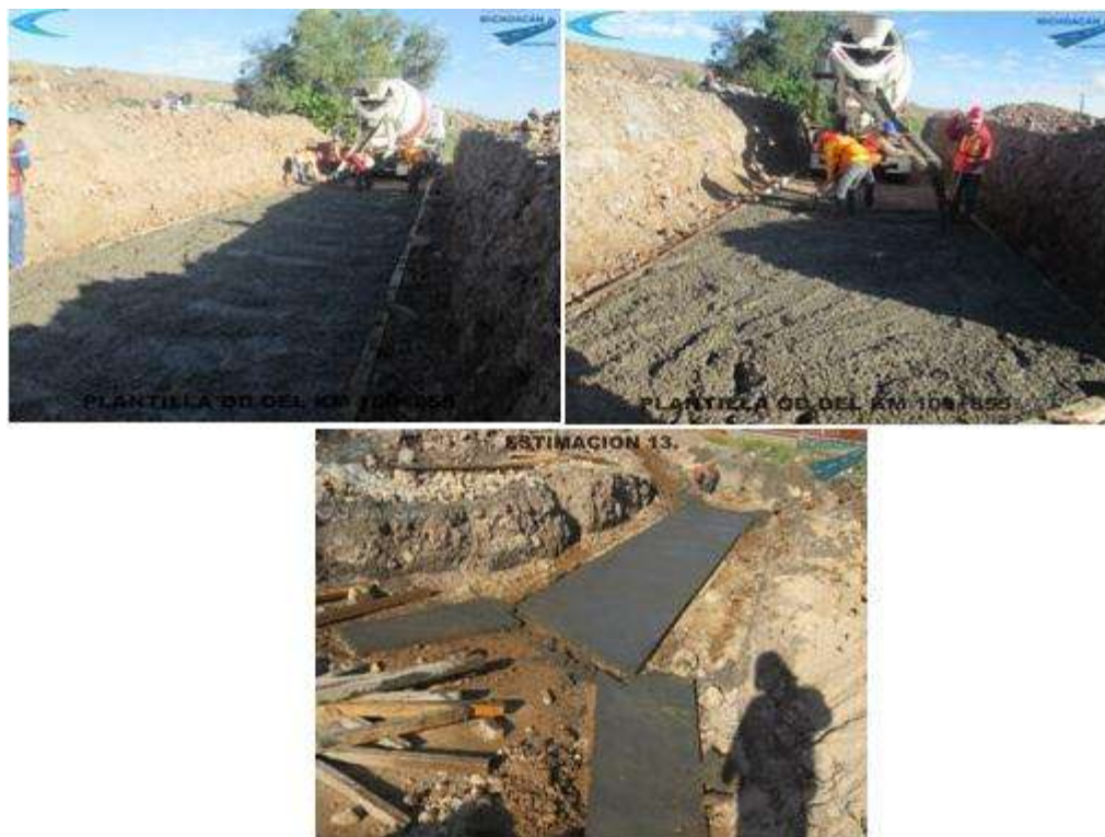
Figura 6.1.4.- Colocación de la plantilla.
