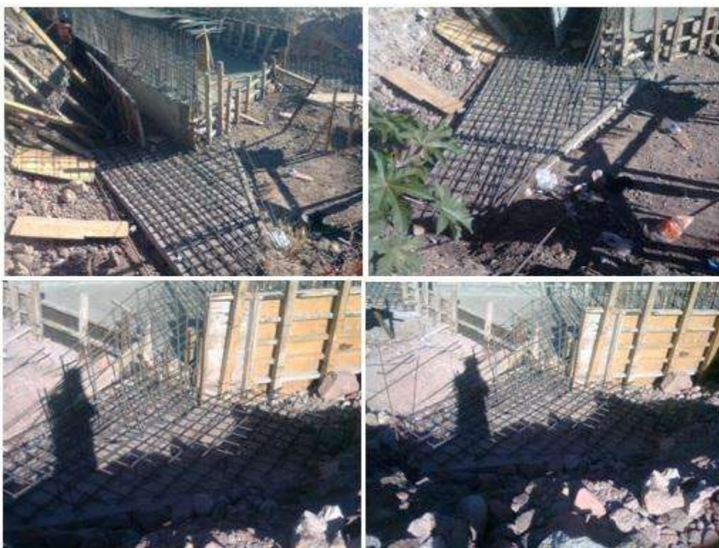
Figura 6.3.- Colocación del acero.
