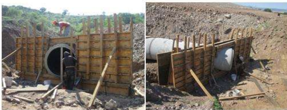
Figura 4.2.6.- Colocación de la cimbra.
