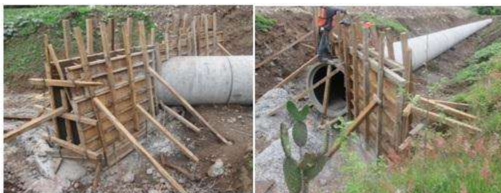
Figura 4.2.11.- Colocación de la cimbra.
