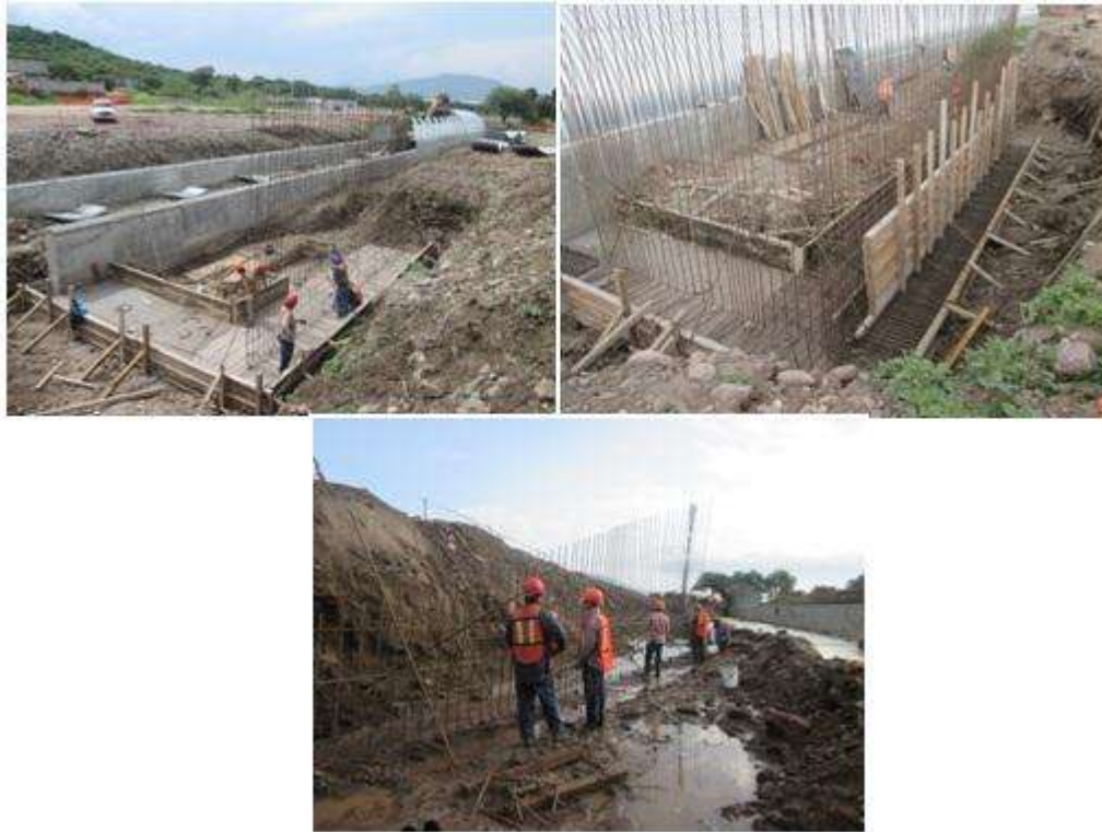
Figura 3.2.10.- Colocación del acero.
