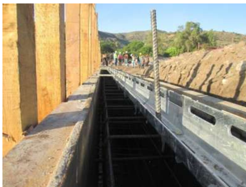
Figura 3.1.19.- Colocación de la cimbra.
