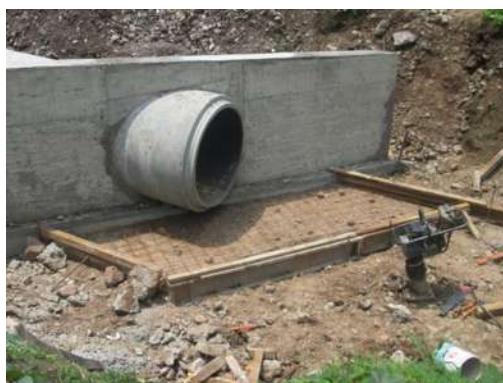
Figura 4.3.3.- Colocación de la cimbra.
