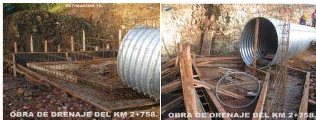
Figura 5.2.4.- Colocación del acero.
