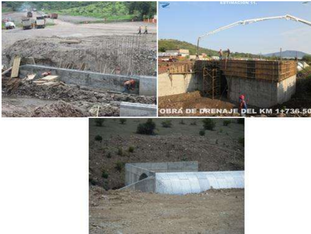
Figura 3.2.18.- Descimbrado de los muros de regreso, aleros, cabezales y dentellones.
