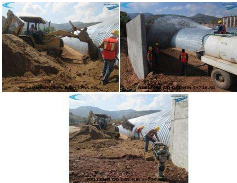
Figura 3.4.- Colocación del relleno de protección.
