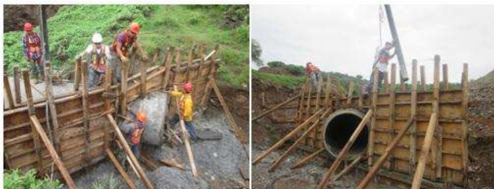
Figura 4.2.12.- Colocación del concreto.
