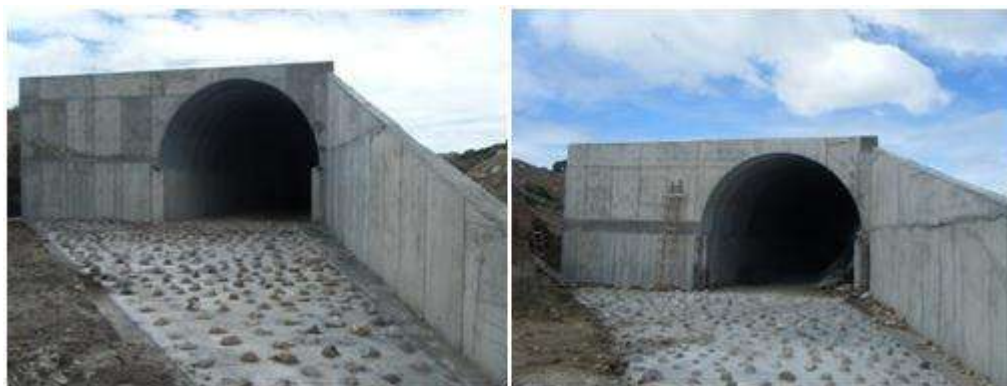
Figura 3.3.1.- Colocación del zampeado.
