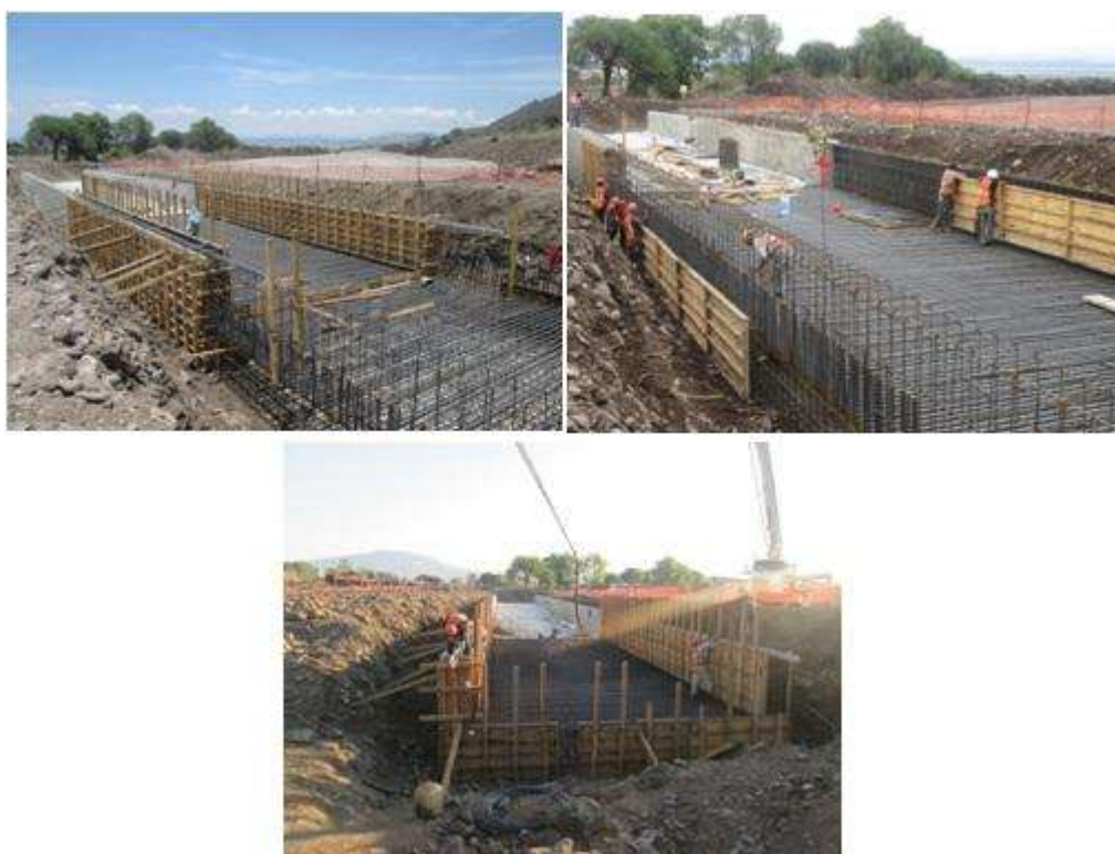
Figura 3.1.20.- Colocación de la cimbra.
