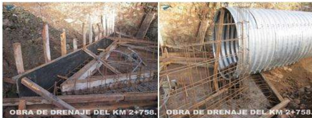
Figura 5.2.5.- Colocación de la cimbra.
