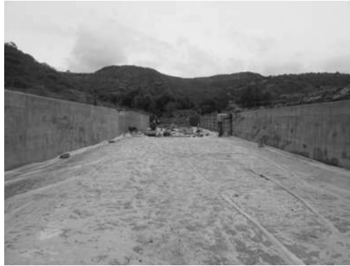
Figura 3.1.27.- Curado para el concreto.
