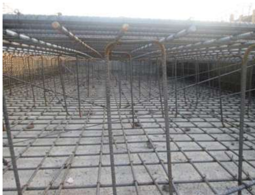
Figura 3.1.14.- Colocación del acero.
