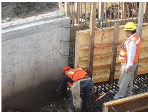
Figura 3.2.13.- Colocación de las barbas.
