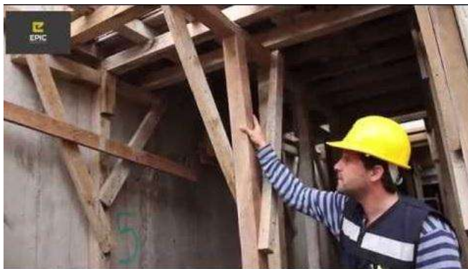
Figura 6.2.- colocación de la cimbra.
