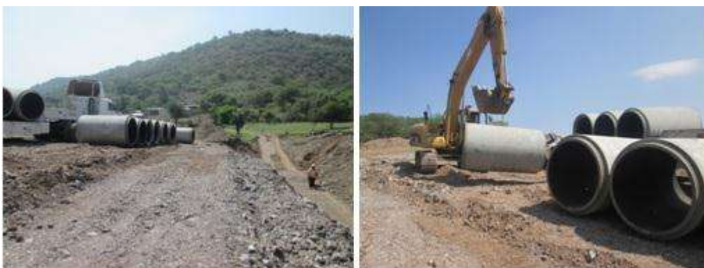
Figura 4.1.5.- Recibiendo la tubería.
