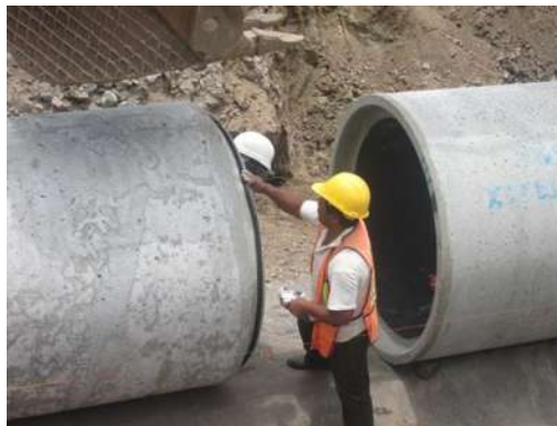
Figura 4.1.7.- Colocación de la tubería.
