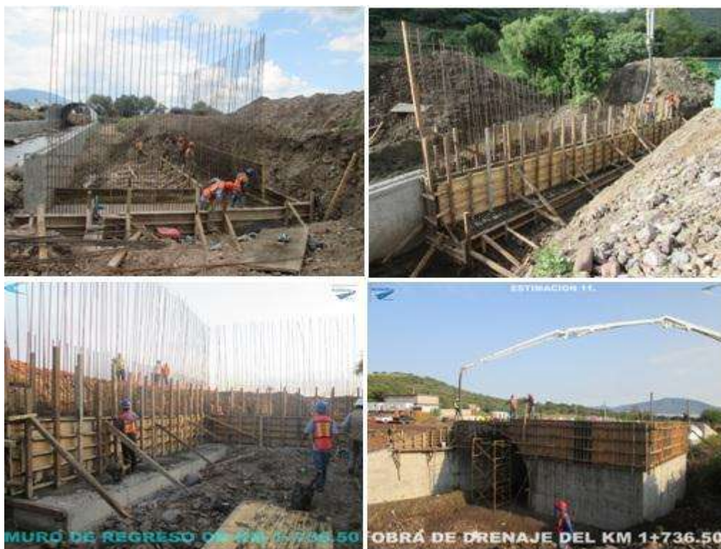
Figura 3.215.- Colocación de la cimbra.
