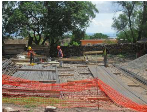
Figura 3.1.9.- Habilitado del acero.
