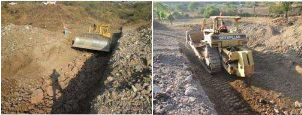
Figura 4.1.1.- Excavación del tubo de concreto.
