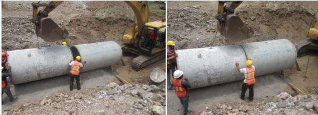
Figura 4.1.8.- Colocación de la tubería.
