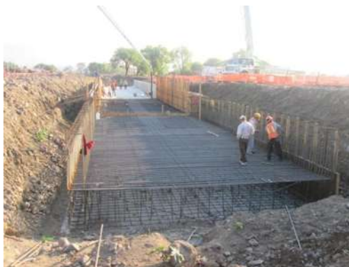
Figura 3.1.16.- Colocación del acero.
