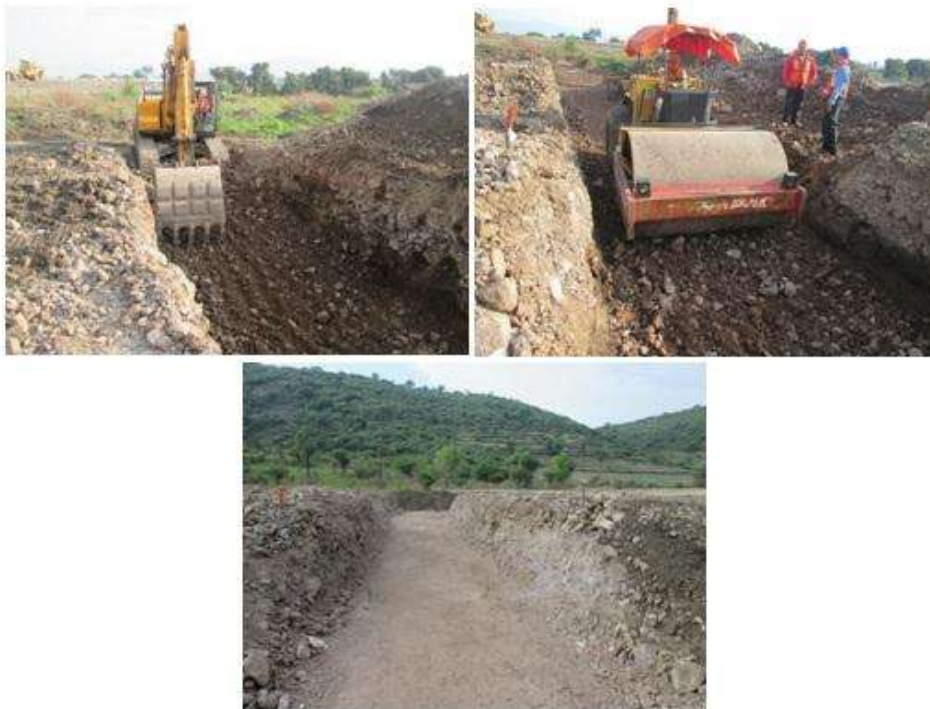
Figura 6.1.3.- Excavación y mejoramiento del terreno.
