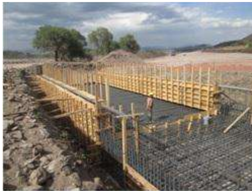
Figura 3.1.18.- Colocación de la cimbra.
