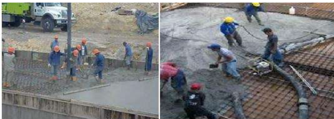
Figura 6.2.2.- Colocación del concreto.
