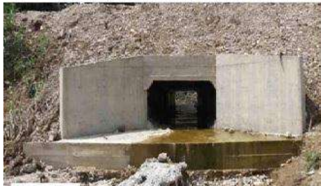
Figura 6.4.- Colocación del zampeado.
