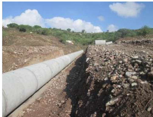
Figura 4.1.9.- Colocación de la tubería.
