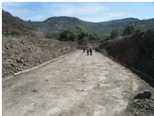
Figura 3.1.5.- Nivelación del terreno.
