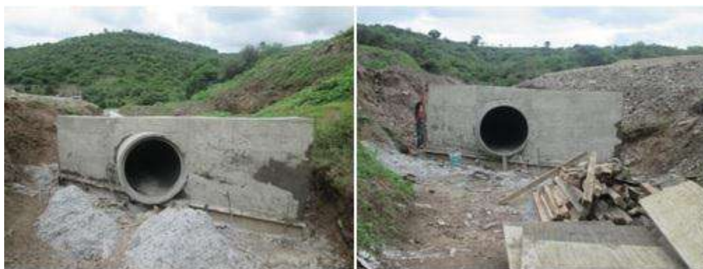
Figura 4.2.13.- Descimbrado.
