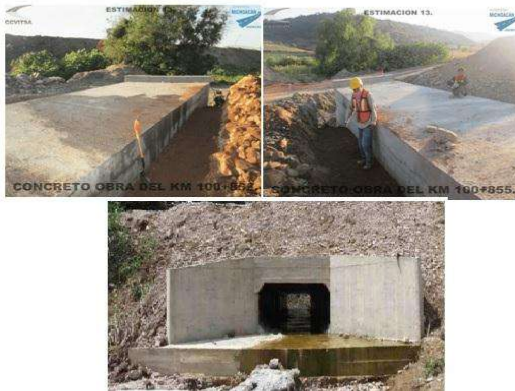
Figura 6.5.- Relleno de protección.
