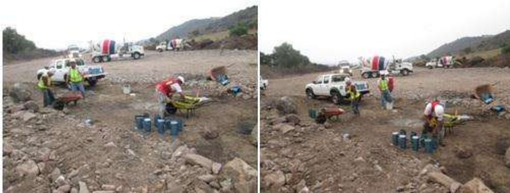
Figura 3.1.21.- Prueba de revenimiento para el concreto.
