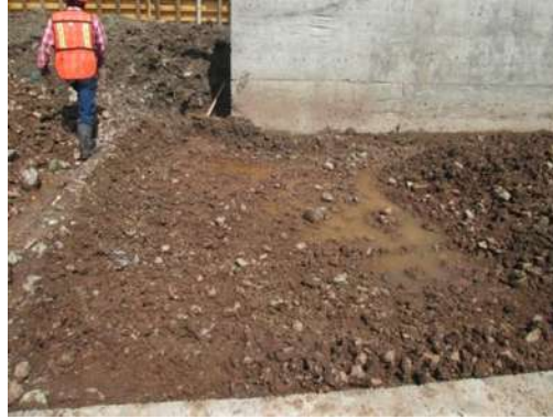
Figura 3.2.4.- Saturación del terreno.
