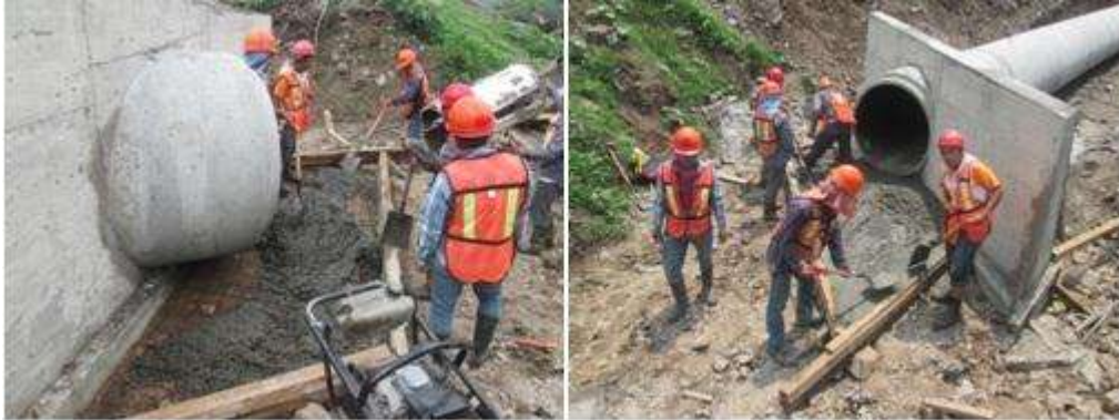
Figura 4.3.4.- Colocación del concreto.
