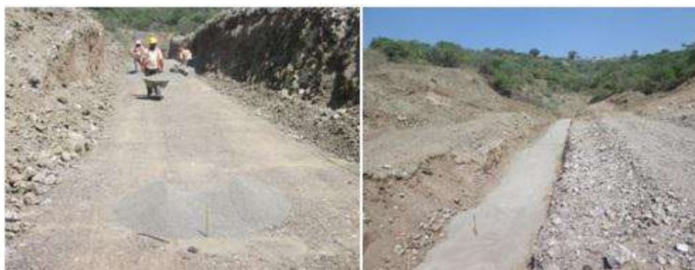
Figura 4.1.4.- Colocación de la cama de arena.
