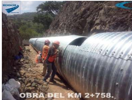
Figura 5.1.4.- Afine para la colocación de lámina.
