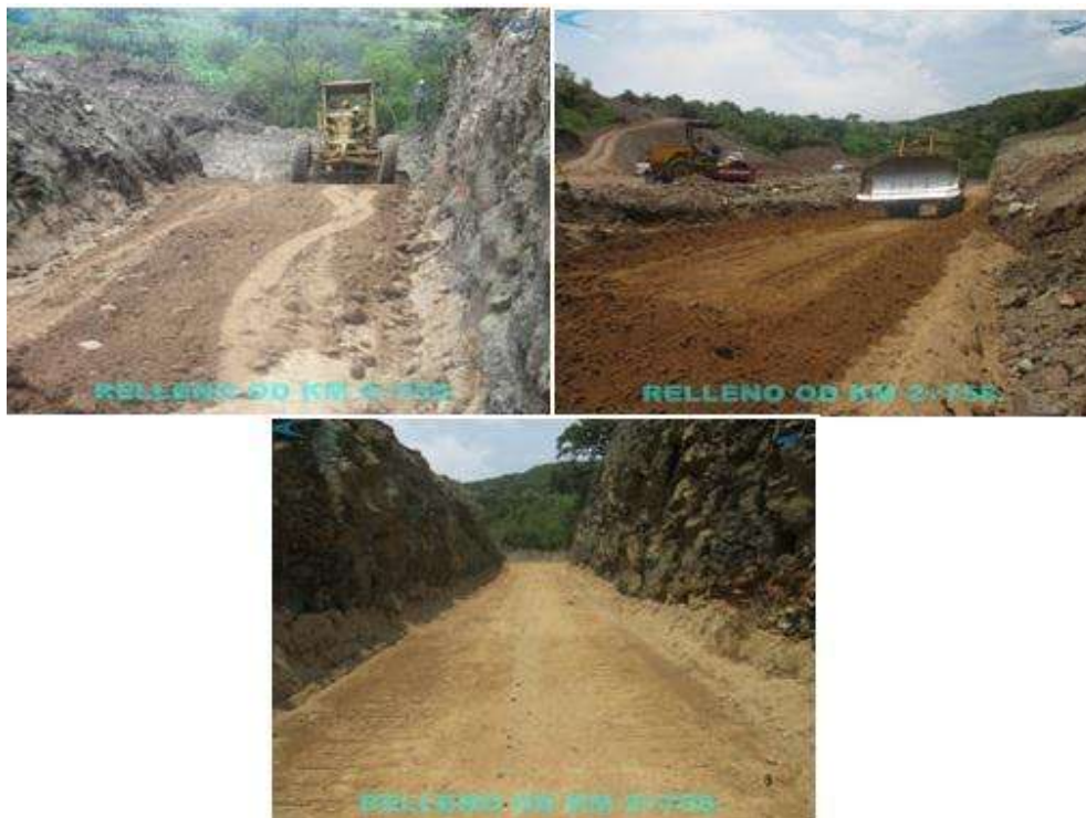
Figura 5.1.3.- Nivelación del terreno.
