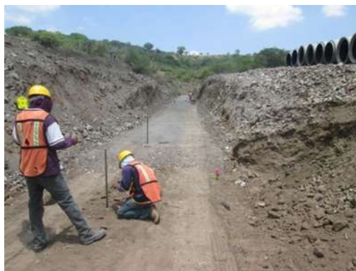
Figura 4.1.3.- Colocación de la tira-línea.
