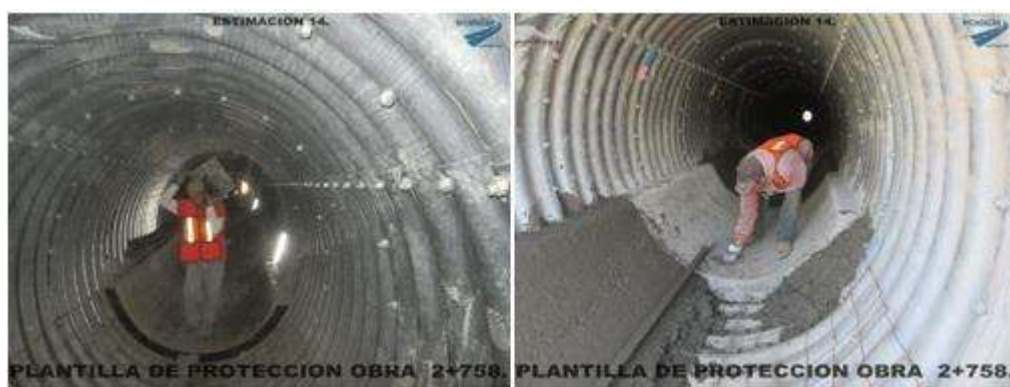
Figura 5.3.1.- Colocación de la plantilla de protección.
