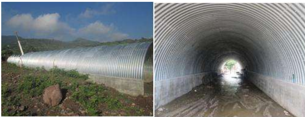
Figura 3.1.34.- Colocación de lámina.
