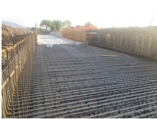
Figura 3.1.15.- Colocación del acero.
