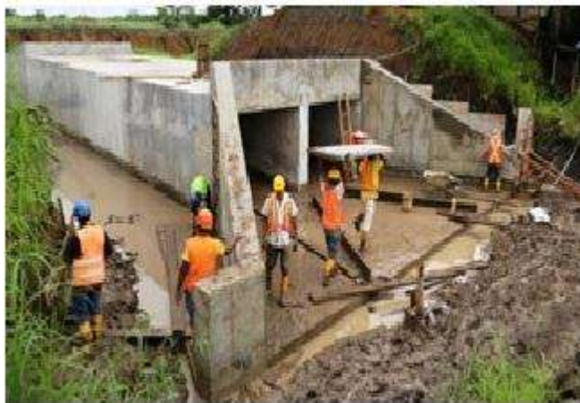
Figura 6.3.2.- Colocación del concreto.
