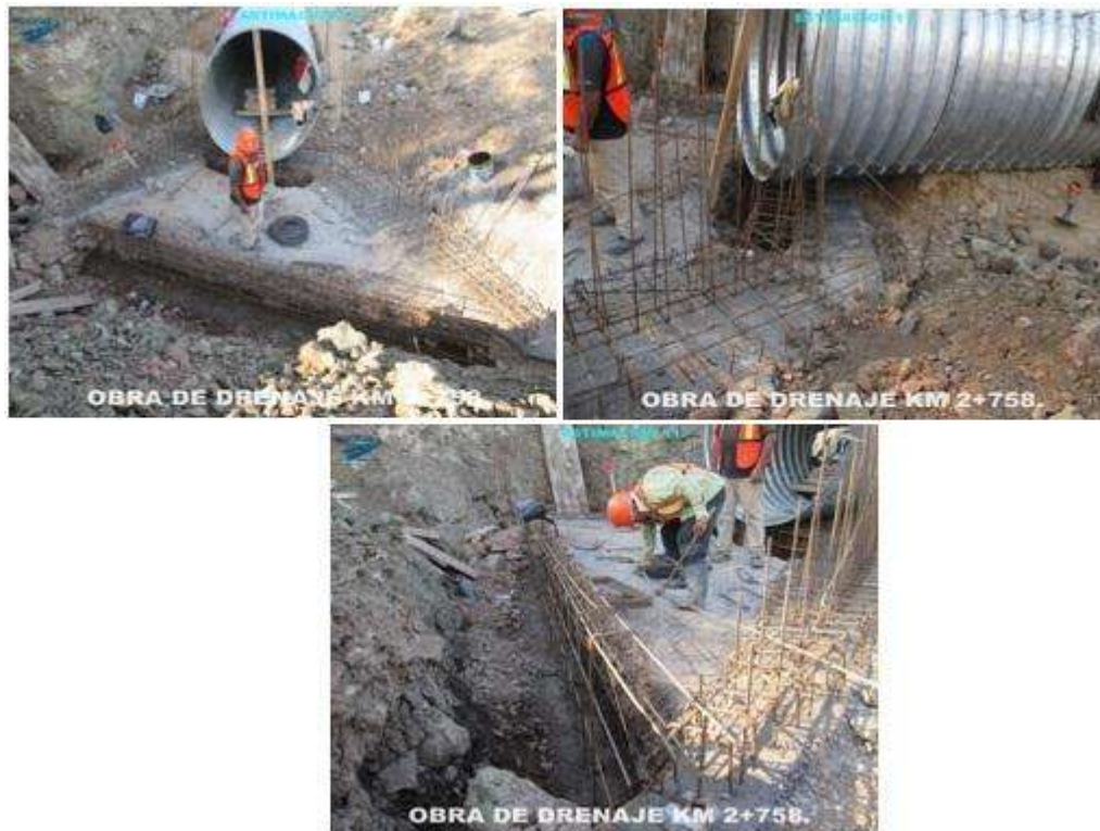
Figura 5.2.2.- Colocación de la plantilla.
