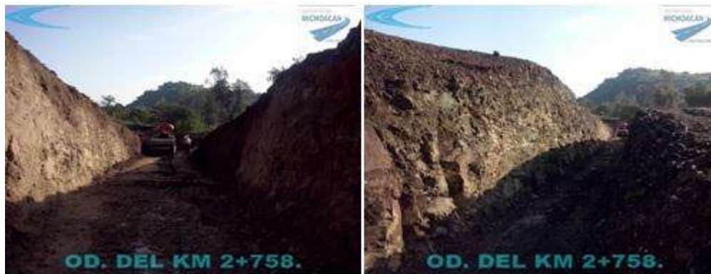
Figura 5.1.2.- Excavación para la lámina.
