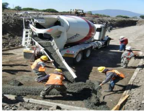
Figura 3.1.6.- Colocación de la plantilla.
