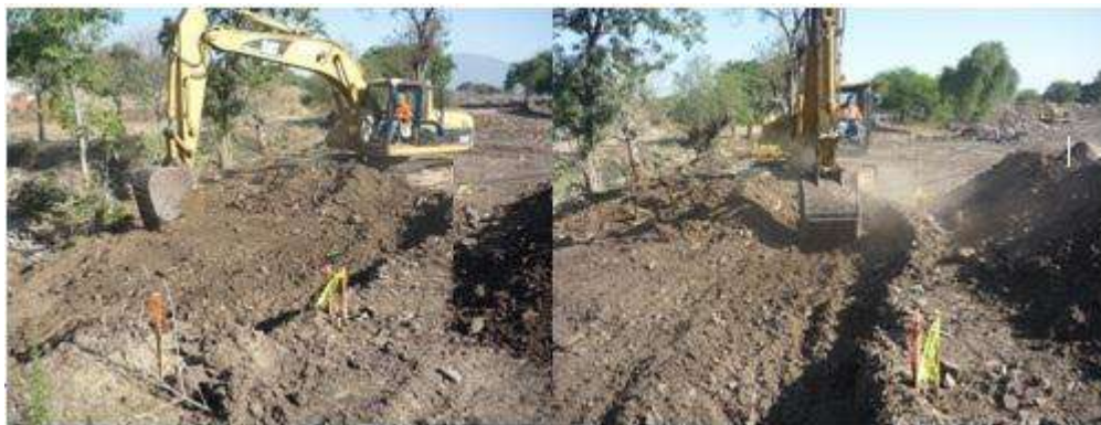
Figura 3.1.4.- Excavación para la losa de cimentación de la bóveda.
