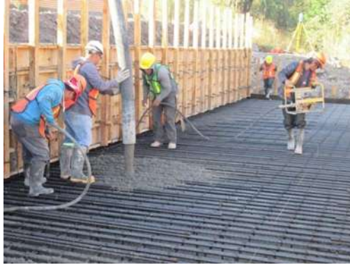
Figura 3.1.23.- Colocación y vibrado del concreto.
