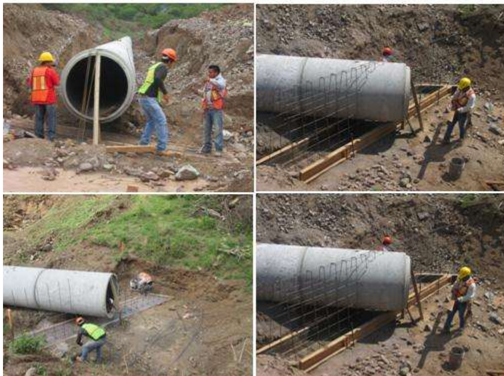
Figura 4.2.4.- Colocación del acero.
