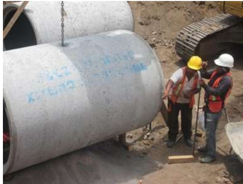
Figura 4.1.6.- Colocación de la tubería.
