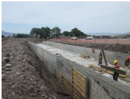
Figura 3.1.28.- Descimbrado.
