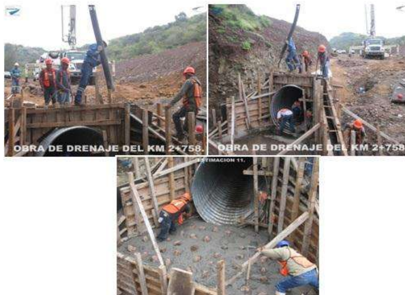
Figura 5.2.8.- Colocación del concreto.
