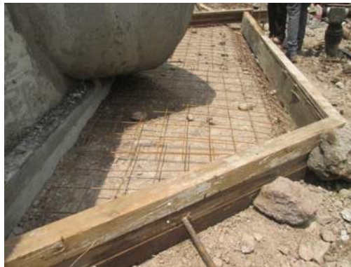
Figura 4.3.2.- Colocación de la malla electro soldada.
