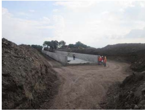
Figura 3.2.1.- Nivelación del terreno.
