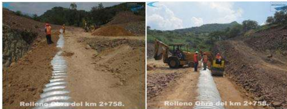
Figura 5.4.- Relleno de protección.
