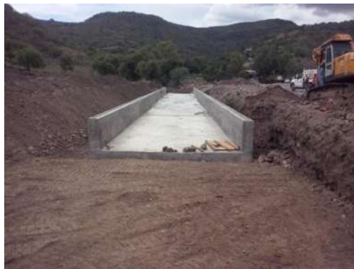
Figura 3.1.29.- Descimbrado.
