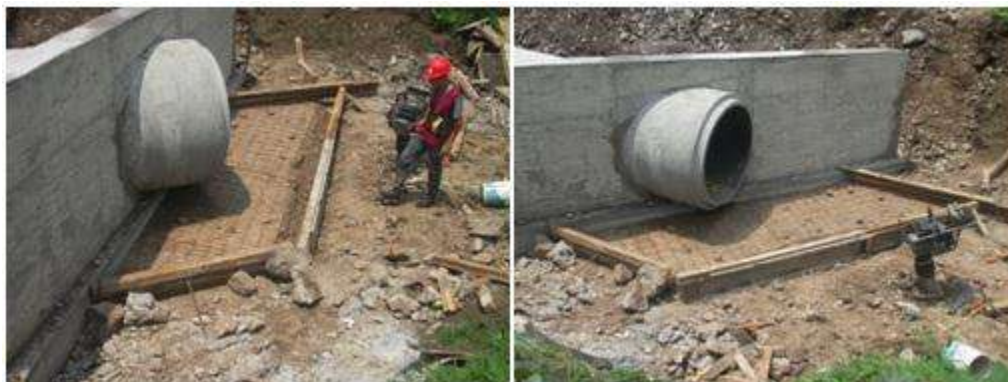
Figura 4.3.1.- Nivelación del terreno.
