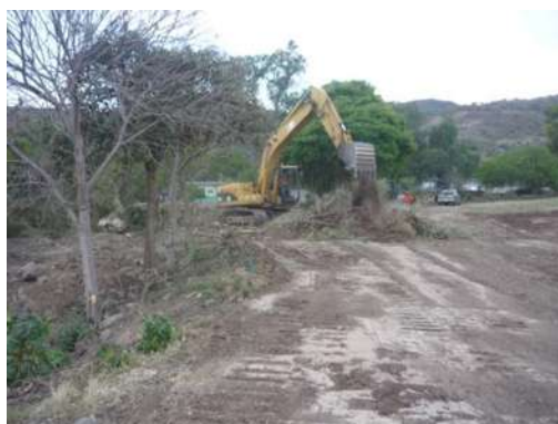
Figura 2.1.- Despalme en las obras de drenaje.
