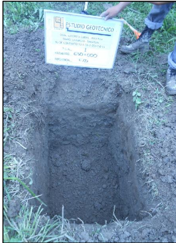
Fotografía No. 3.- P.C.A. No.1 ubicado en el km 630+000 de 1.50 m de profundidad. En donde se encontró arcilla inorgánica de alta plasticidad, de consistencia firme. De color café. CH1 (Zona de inundación),*Se recomienda colocar un pedraplen.
