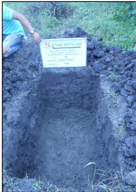
Fotografía No. 36.- PCA no.12 ubicado en el km 635+500 de 1.50 m de profundidad. En donde se encontró arcilla inorgánica de baja plasticidad, de consistencia media. De color café. CL
