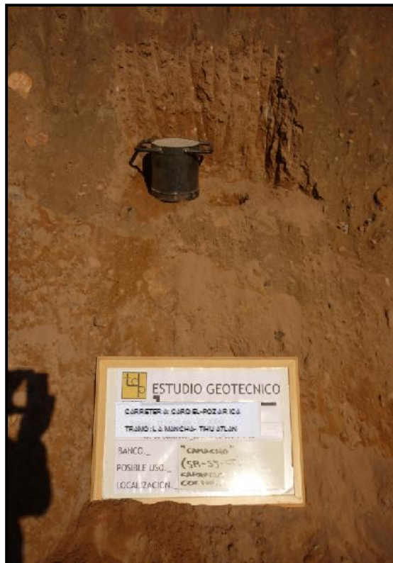
Fotografía 11.- Sondeo y % de compactación del banco Camacho.
