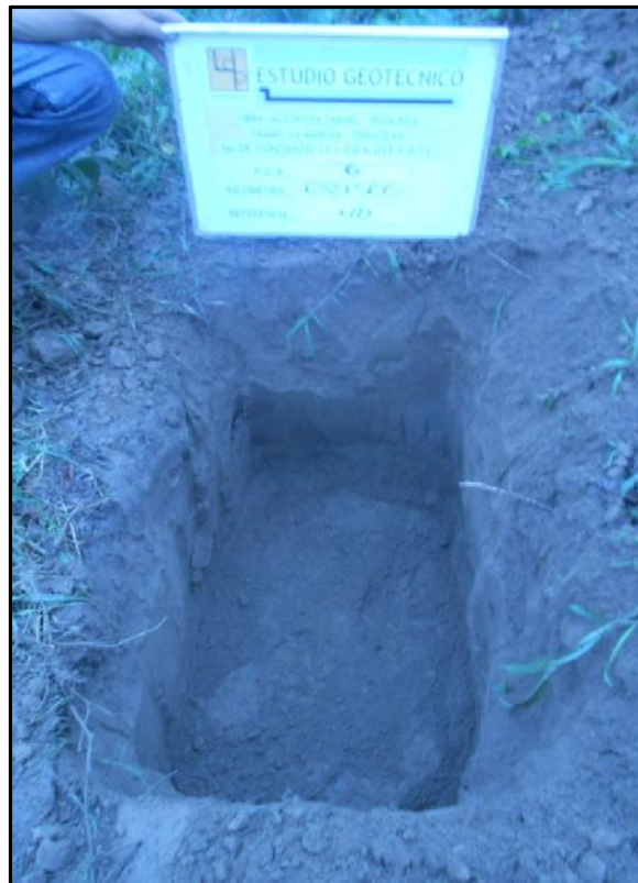
Fotografía No.18.- PCA no.6 ubicado en el km 632+500 de 1.20 m de profundidad. En donde se encontró arcilla inorgánica de baja plasticidad, de consistencia media. De color café. CL (Zona de inundación), Se recomienda colocar un pedraplen.
