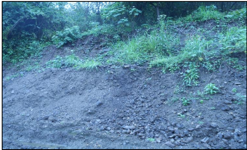
Fotografía No. 26.- Vistahacia adelante del km 634+020.
