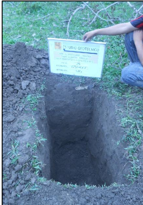
Fotografía No. 9.- P.C.A. No.3 ubicado en el km 631+000 de 1.50 m de profundidad. En donde se encontró arcilla inorgánica de alta plasticidad, de consistencia firme. De color café. CH1 (Zona de inundación), Se recomienda colocar un pedraplen.
