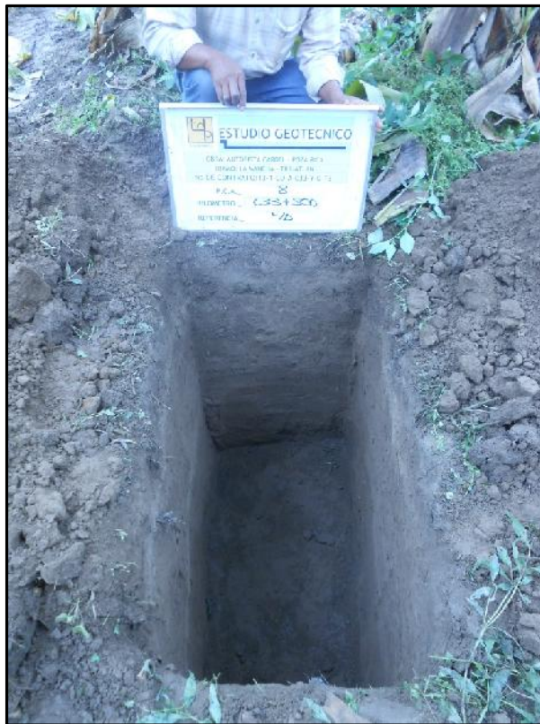
Fotografía No. 24.- PCA no.8 ubicado en el km 633+500 de 1.60 m de profundidad. En donde se encontró arcilla inorgánica de alta plasticidad, de consistencia firme. De color café. CH1 (Zona de inundación), Se recomienda colocar un pedraplen.
