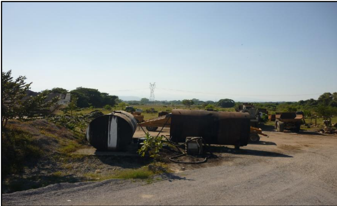
Fotografía 7.- Equipo para mezcla asfáltica en el lugar del banco El Cañizo.
