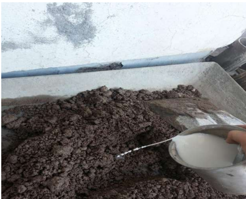
FIGURA 91. Agregando el aditivo MAXE-H.
