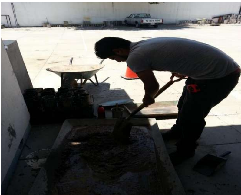
FIGURA 93. Mezclando con el agua el proporción.
