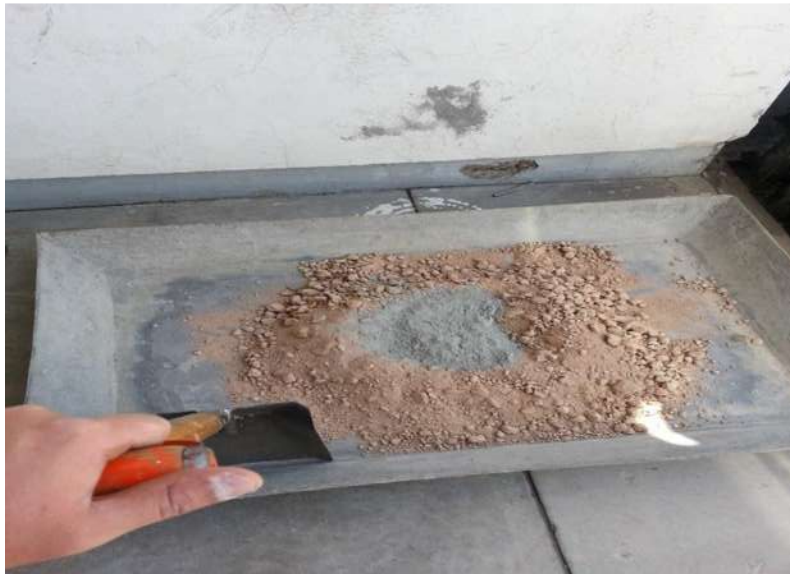
FIGURA 89. Preparación del tepetate con el cemento.
