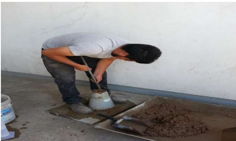
FIGURAS 99, 100, 101. Varillado en forma de espiral (25 golpes por cada capa).
