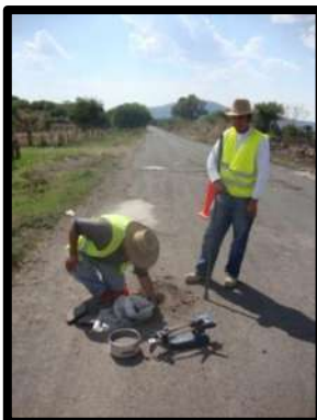
Foto 1. Determinación del grado de compactación para la capa de base Km 2+250.
