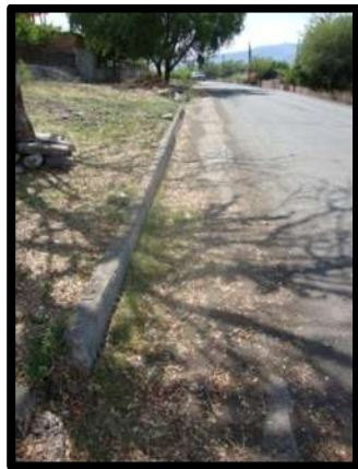
Foto 4 – 5. En estas fotos se muestra al km 1+700 una cuneta únicamente de lado derecho azolvado con material orgánico, con un ancho de 1.0 mts. Y una guarnición de 0.30 mts.
