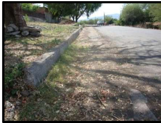
Foto 4 – 5. En estas fotos se muestra al km 1+700 una cuneta únicamente de lado derecho azolvado con material orgánico, con un ancho de 1.0 mts. Y una guarnición de 0.30 mts.
