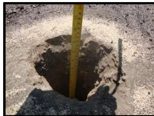
Foto 2. Se observa la toma de los espesores de las capas encontradas.
