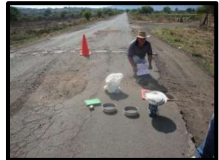
Foto 3. Identificación del sondeo realizado en el km 2+720.
