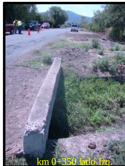
Foto 2 Se observa la condición actual de la obra de drenaje tipo alcantarilla ubicada en el km 0+350.
