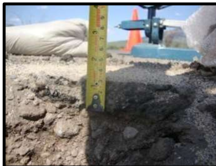
Foto 2. Se observa el espesor de la capa de carpeta asfáltica encontrada.
