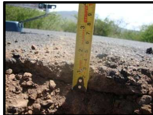
Foto 2. Toma de espesores en la capa de carpeta asfáltica.
