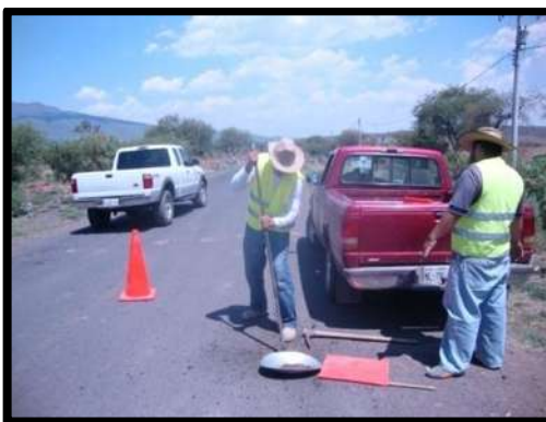
Foto 1. Elaboración del sondeo 2 ubicado en el km 0+500.
