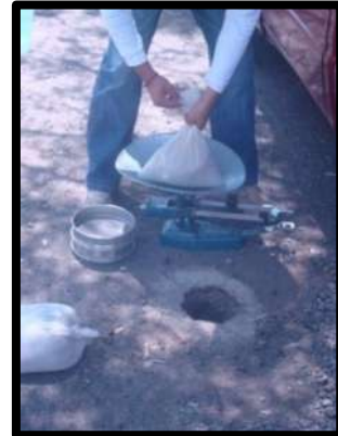
Foto 2. Determinación del grado de compactación para la capa de base, km 0+010
