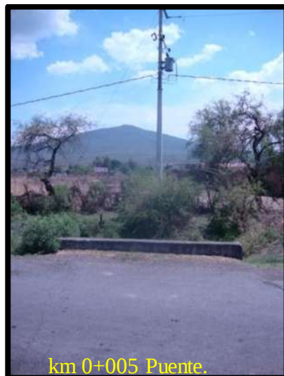
Foto 1 Se observa la condición actual de la obra de drenaje.
