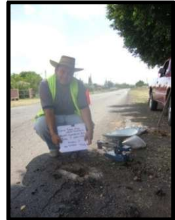
Foto 4. Identificación del sondeo realizado en el km 1+420.
