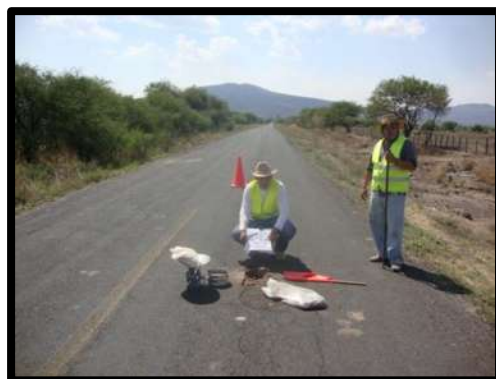
Foto 4. Identificación del sondeo realizado en el km 1+010
