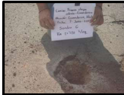
Foto 2. Identificación del sondeo realizado.
