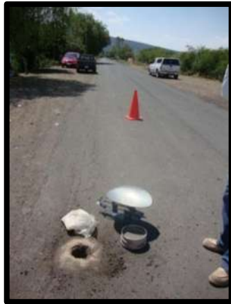
Foto 3. Se observa la ubicación donde se realizó el sondeo 2 en el km 0+500.
