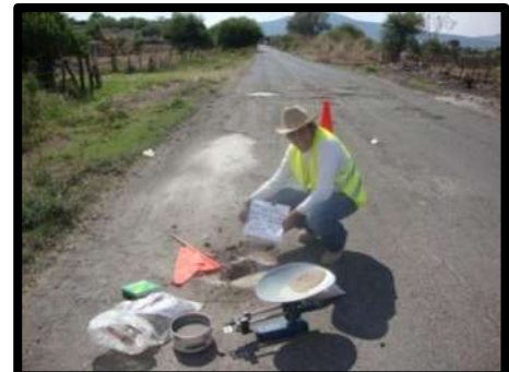
Foto 3. Identificación del sondeo realizado.
