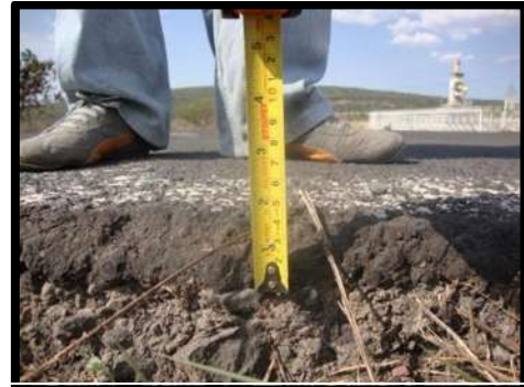
Foto 2. Se observa el espesor de la capa de carpeta asfáltica encontrada.
