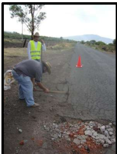
Foto 1. Se observa la ubicación donde se realizó el sondeo 7 en el km 3+480.
