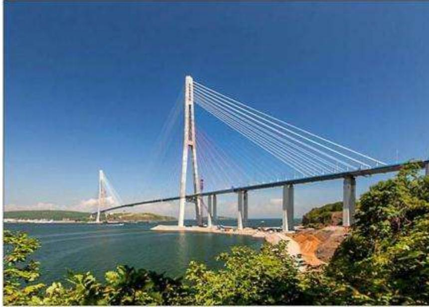
Figura 1.1 Puente atirantado de la isla Russki con un claro principal de 1.1 km
