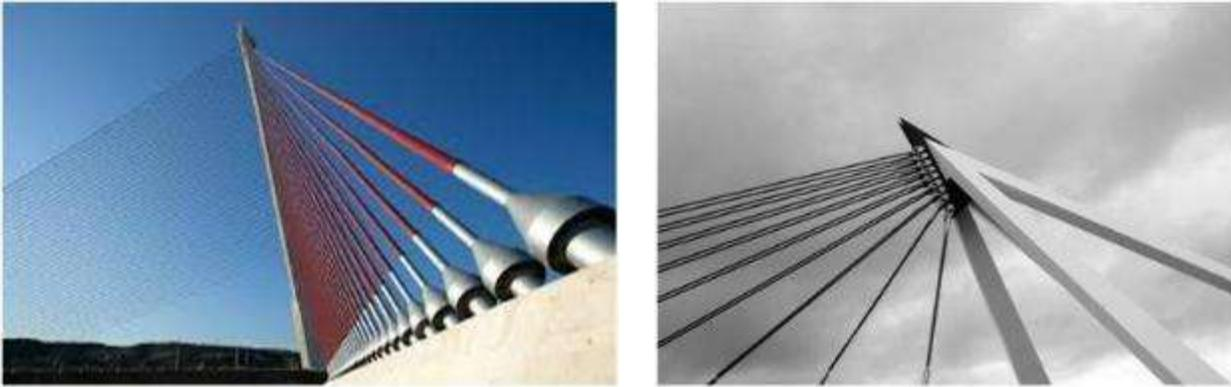
Figura 1.5 Atirantamiento de los puentes con cables de acero y su disposición en arpa y en abanico
