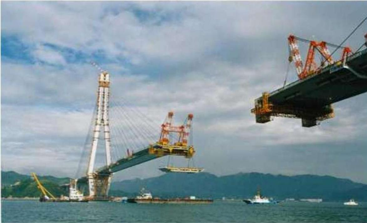
Figura 4.1 Muestra el avance de la construcción de un puente atirantado
