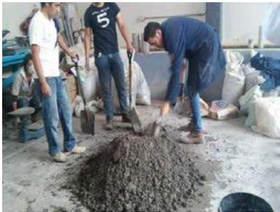
*Fig 14.-Revoltura de los materiales con el agua*
