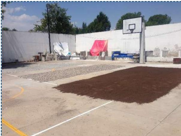
Figura 1.-Secado del material grueso y fino
