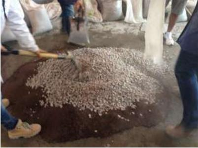
*Fig 11.- Revoltura del agregado pétreo*
