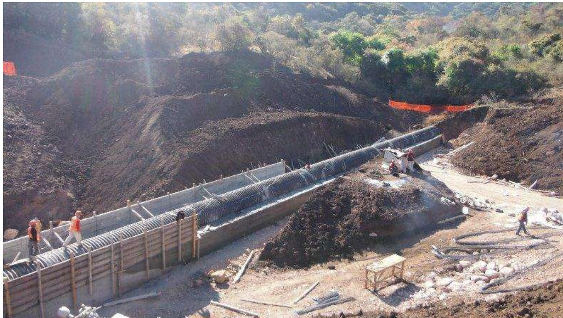
**Ilustración 50. Obra De Drenaje Del Km 7+699.00 (Troncal), Alcantarilla De Acero Corrugado, Elíptica, 1.98 Mts. Calibra No. 8. Con Una Longitud De 105.53 Mts. Una Pendiente De 10.50%, Un Esviaje De 37° (Constructora De Autopistas De Michoacan, S.A.P.I. De C.V., 2014)**
