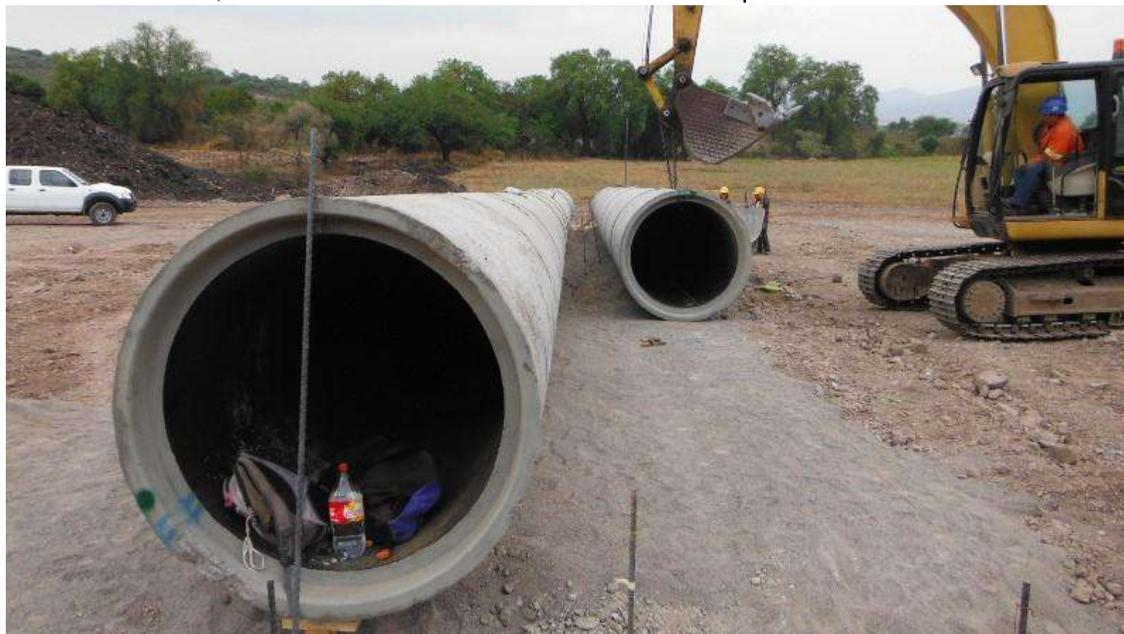
Ilustración 67. Colocación De La Tubería De La Obra De Drenaje Del Km 1+400.00 (Troncal), 2 Tubos De Concreto De 1.22 Mts. Con Una Longitud De 29.913 Mts. (15 Tubos En Cada Línea, Siendo Un Total De 30 Tubos En Esta Obra Ya Que Cada Tubo Mide 2.10 Mts. De Longitud) Una Pendiente De 7.75%, Un Esviaje De 0°. (Constructora De Autopistas De Michoacan, S.A.P.I. De C.V., 2014)
