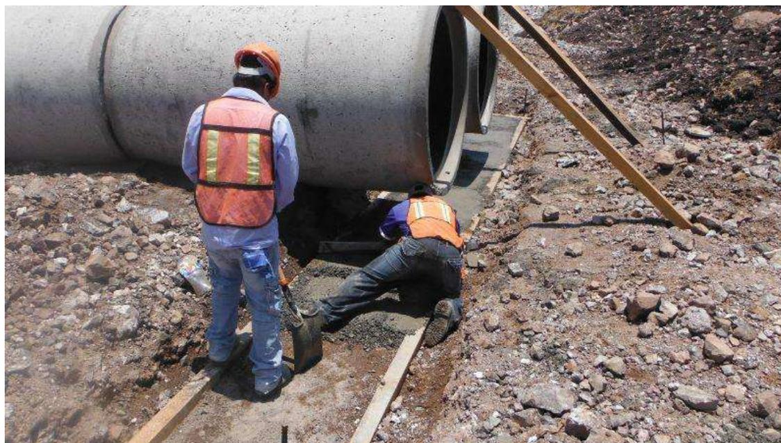
Ilustración 68. Colado De Plantilla Para Recibir Acero De La Zapata Del Cabezote De La Obra De Drenaje Del Km 1+400.00 (Troncal), 2 Tubos De Concreto De 1.22 Mts. Con Una Longitud De 29.913 Mts. (15 Tubos En Cada Línea, Siendo Un Total De 30 Tubos En Esta Obra Ya Que Cada Tubo Mide 2.10 Mts. De Longitud) Una Pendiente De 7.75%, Un Esviaje De 0°. (Constructora De Autopistas De Michoacan, S.A.P.I. De C.V., 2014)
