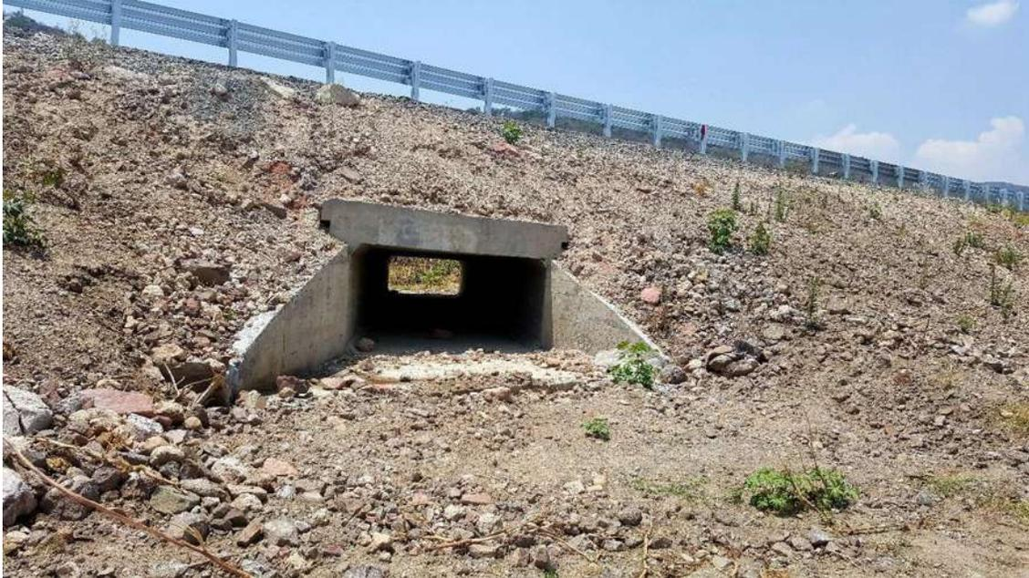
**Ilustración 19. Obra De Drenaje Del Km 100+855.00 (Gasa 100), Cajón De Concreto De 3.00 Mts. X 1.50 Mts. (Constructora De Autopistas De Michoacan, S.A.P.I. De C.V., 2014)**
