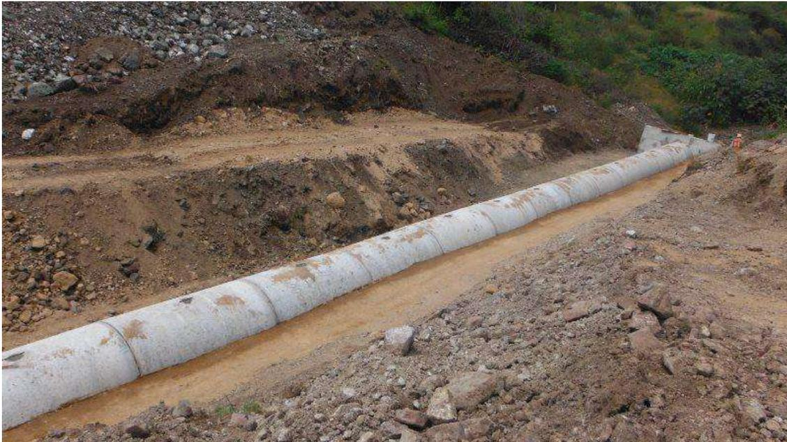
**Ilustración 40. Obra De Drenaje Del Km 2+036.00 (Troncal), Tubo De Concreto De 1.22 Mts. (Constructora De Autopistas De Michoacan, S.A.P.I. De C.V., 2014)**
