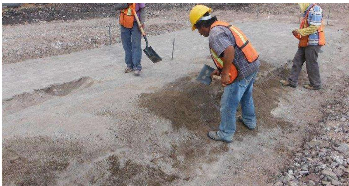
**Ilustración 66.** Cama De Arena Para Asentar La Tubería De La Obra De Drenaje Del Km 1+400.00 (Troncal), 2 Tubos De Concreto De 1.22 Mts. Con Una Longitud De 29.913 Mts. (15 Tubos En Cada Línea, Siendo Un Total De 30 Tubos En Esta Obra Ya Que Cada Tubo Mide 2.10 Mts. De Longitud) Una Pendiente De 7.75%, Un Esviaje De 0°. (Constructora De Autopistas De Michoacan, S.A.P.I. De C.V., 2014)
