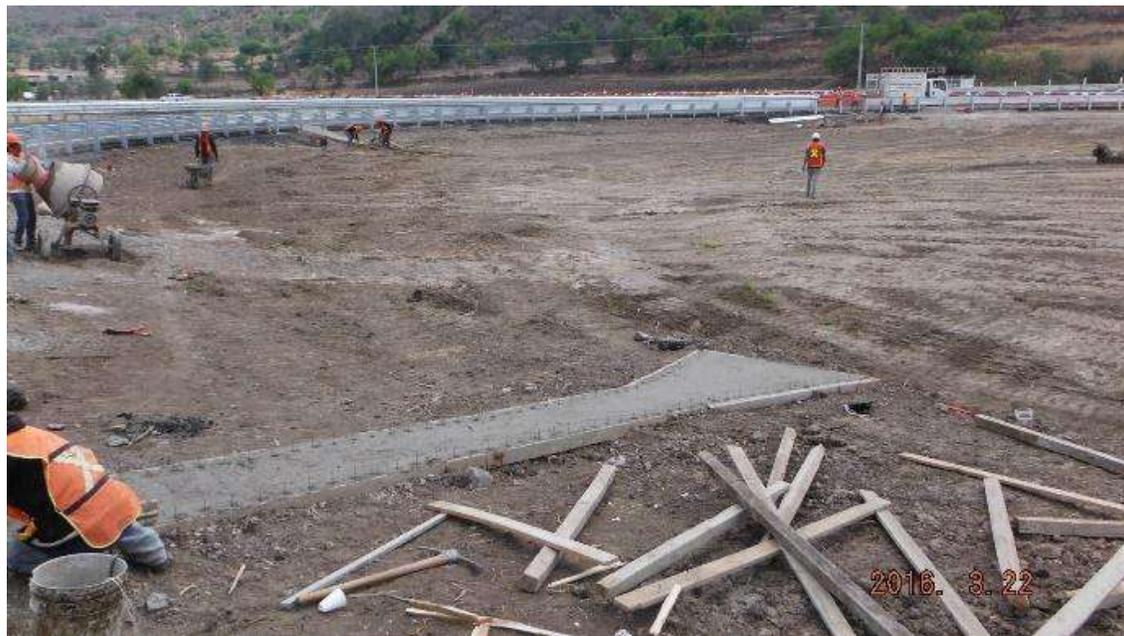
Ilustración 47. Lavaderos Gasa 40. (Constructora De Autopistas De Michoacan, S.A.P.I. De C.V., 2016)
