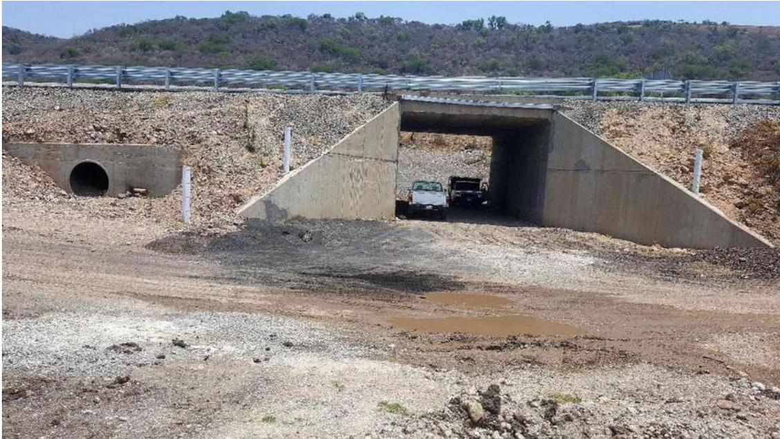
**Ilustración 13. Obra De Drenaje Del Km 11+300.00 (Gasa 10), Cajón De Concreto De 6.00 Mts. x 4.50 Mts. (Constructora De Autopistas De Michoacan, S.A.P.I. De C.V., 2014)**
