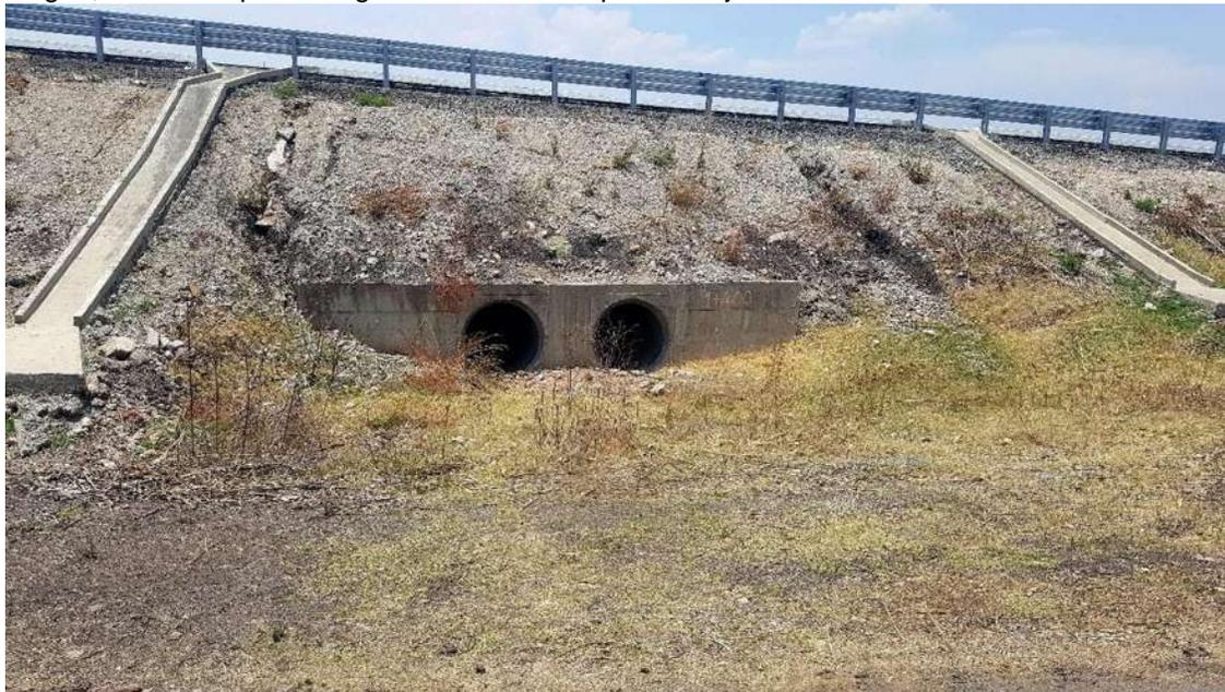
Ilustración 51. Obra De Drenaje Del Km 1+400.00 (Troncal), 2 Tubos De Concreto De 1.22 Mts. (Constructora De Autopistas De Michoacan, S.A.P.I. De C.V., 2014)
