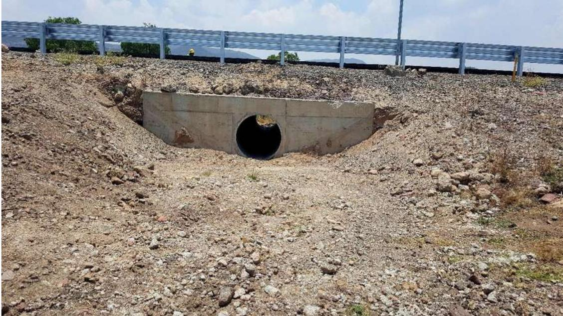
**Ilustración 15. Obra De Drenaje Del Km 30+160.00 (Gasa 30), Tubo De Concreto De 1.22 Mts. (Constructora De Autopistas De Michoacan, S.A.P.I. De C.V., 2014)**
