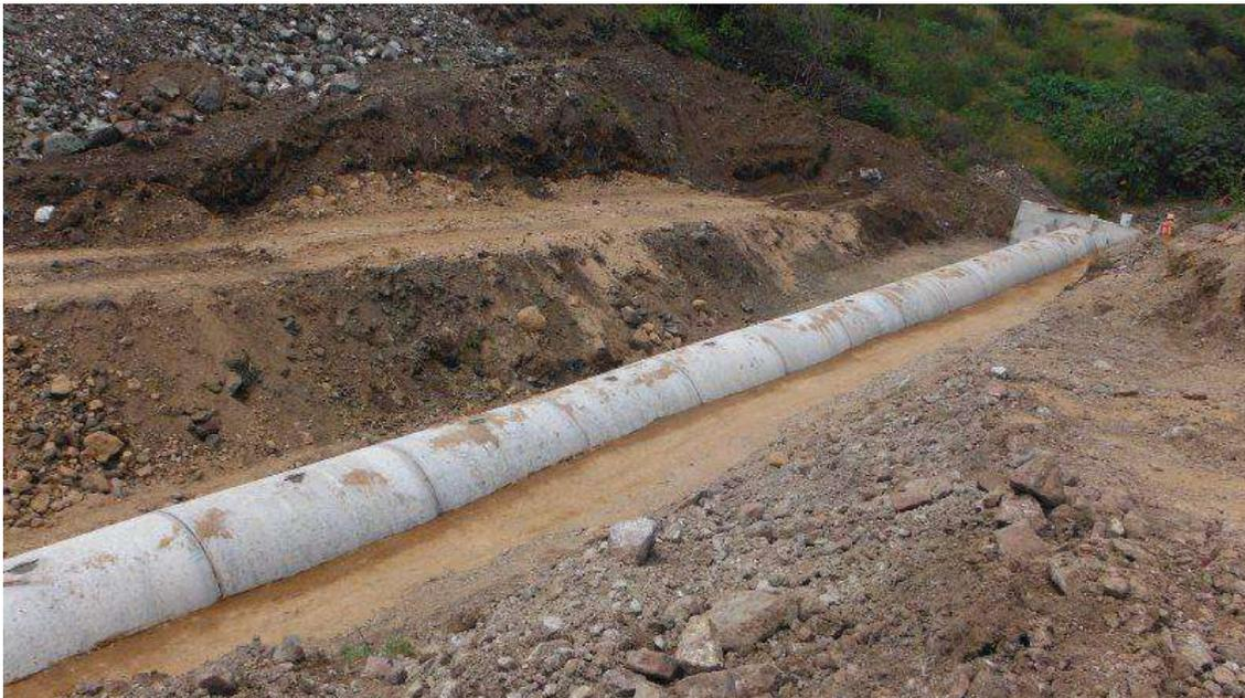
**Ilustración 22. Obra De Drenaje Del Km 2+036.00 (Troncal), Tubo De Concreto De 1.22 Mts. (Constructora De Autopistas De Michoacan, S.A.P.I. De C.V., 2014)**
