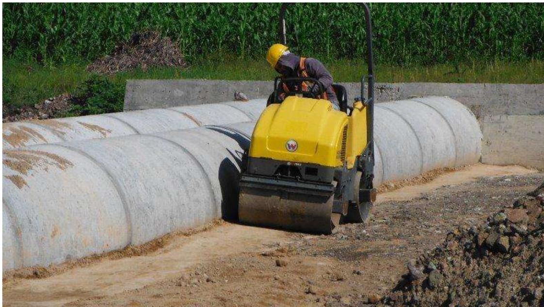
Ilustración 71. Compactación De La Obra De Drenaje Del Km 1+400.00 (Troncal), 2 Tubos De Concreto De 1.22 Mts. Con Una Longitud De 29.913 Mts. (15 Tubos En Cada Línea, Siendo Un Total De 30 Tubos En Esta Obra Ya Que Cada Tubo Mide 2.10 Mts. De Longitud) Una Pendiente De 7.75%, Un Esviaje De 0°. (Constructora De Autopistas De Michoacan, S.A.P.I. De C.V., 2014)
