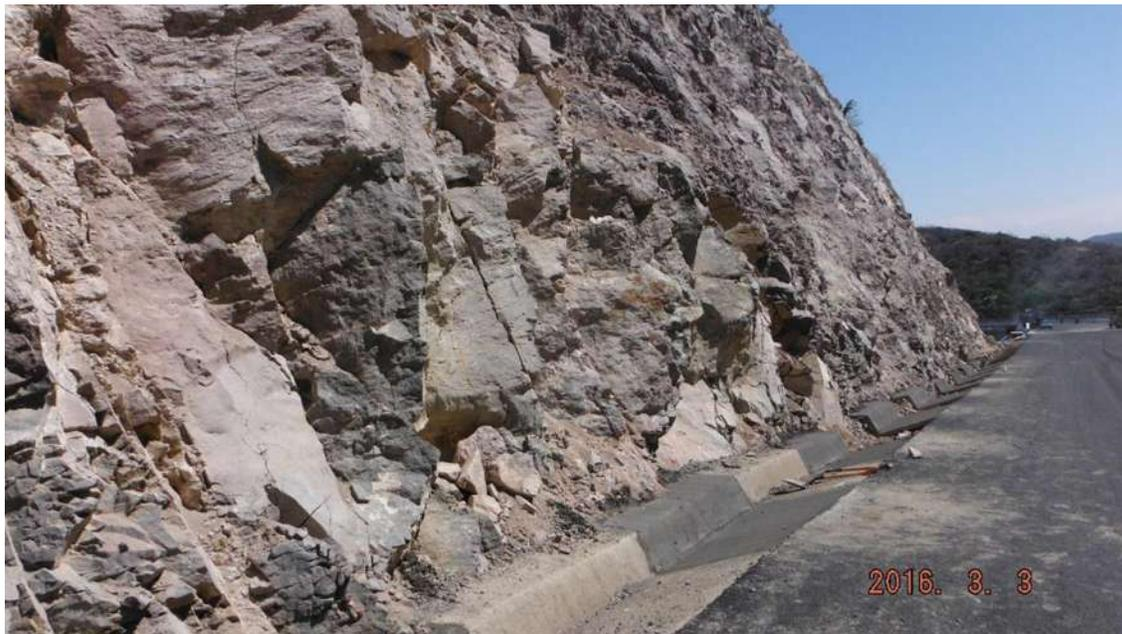
Ilustración 45. Cunetas L/D Km 4. (Constructora De Autopistas De Michoacan, S.A.P.I. De C.V., 2016)
