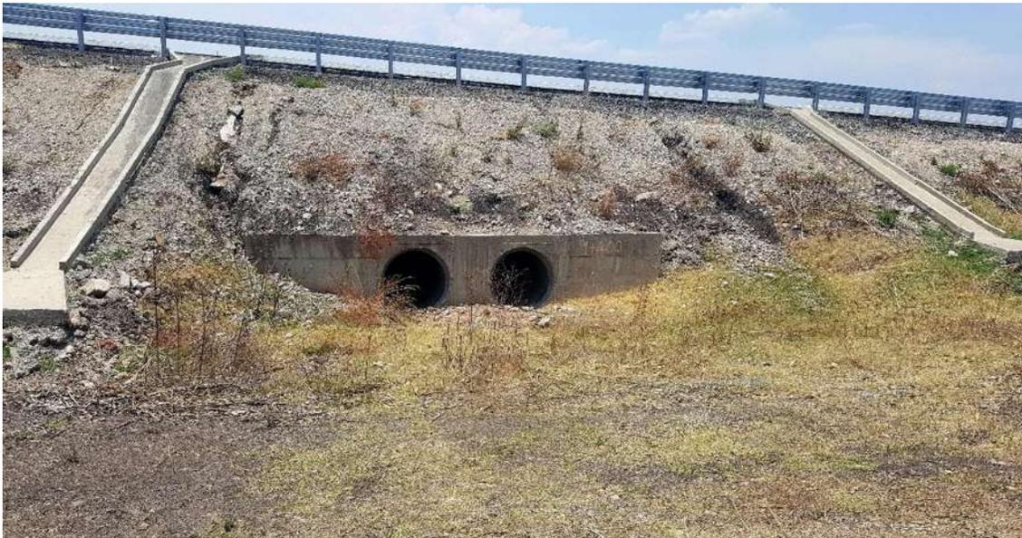
Ilustración 62. Obra De Drenaje Del Km 1+400.00 (Troncal), 2 Tubos De Concreto De 1.22 Mts. Con Una Longitud De 29.913 Mts. (15 Tubos En Cada Línea, Siendo Un Total De 30 Tubos En Esta Obra Ya Que Cada Tubo Mide 2.10 Mts. De Longitud) Una Pendiente De 7.75%, Un Esviaje De 0°. (Constructora De Autopistas De Michoacan, S.A.P.I. De C.V., 2014)
