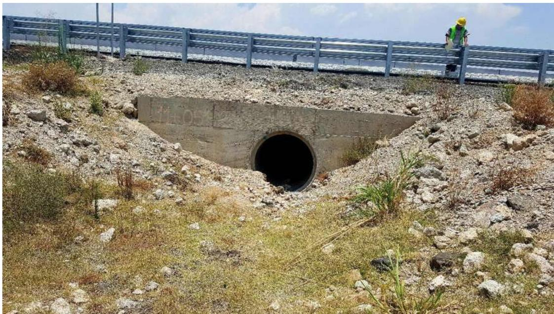
**Ilustración 10. Obra De Drenaje Del Km 11+051 (Gasa 10), Tubo De Concreto De 1.22 Mts. (Constructora De Autopistas De Michoacan, S.A.P.I. De C.V., 2014)**
