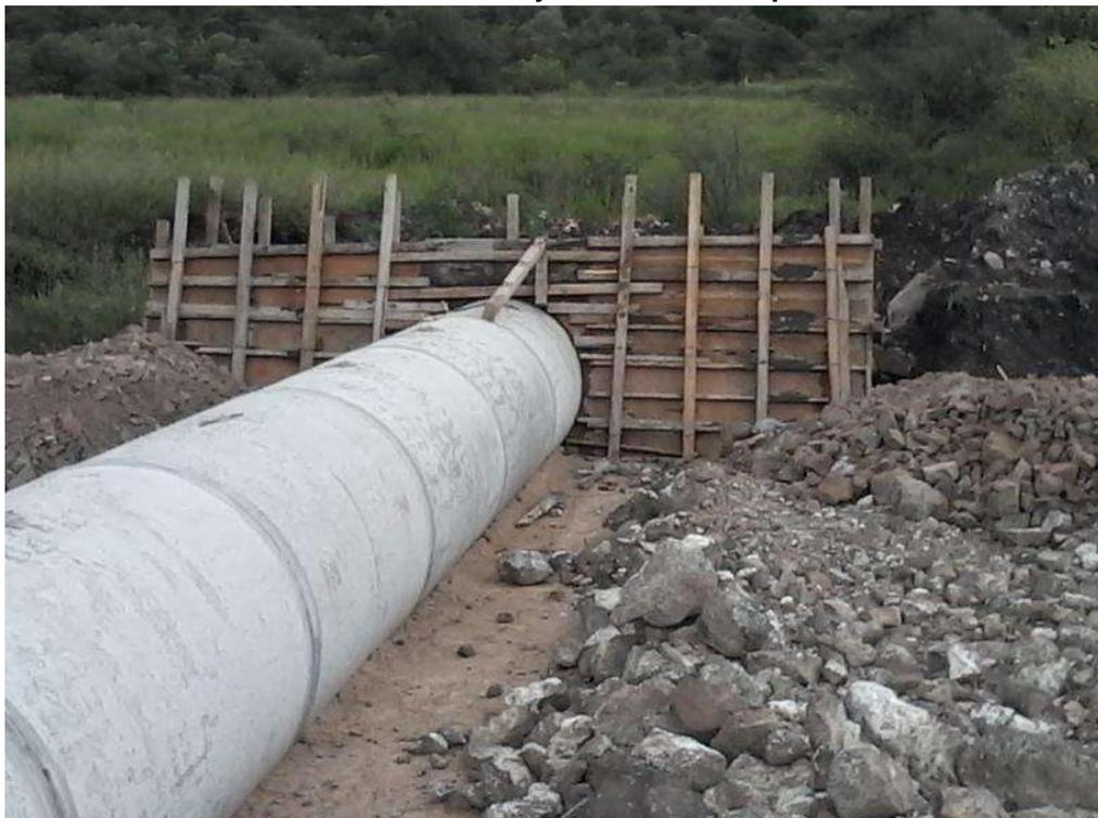
Ilustración 11. Obra De Drenaje Del Km 11+146.50 (Gasa 10), Tubo De Concreto De 1.22 Mts. (Constructora De Autopistas De Michoacan, S.A.P.I. De C.V., 2014)
