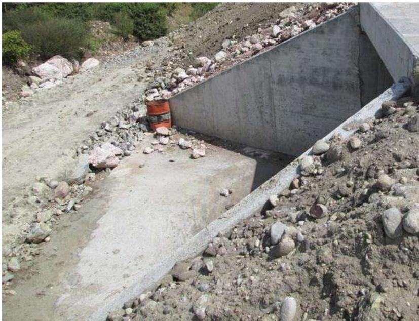
Ilustración 49. Obra De Drenaje Del Km 9+600.00 (Troncal), Cajón De Concreto De 5.00 Mts. x 3.50 Mts. Con Una Longitud De 13.99 Mts. Una Pendiente De 5.00%, Un Esviaje De 0° (Constructora De Autopistas De Michoacan, S.A.P.I. De C.V., 2014)
