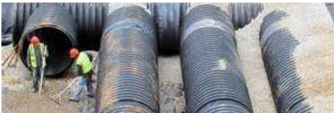
Ilustración 42. Tubería de polietileno corrugado. (alcantarillado/tuberia-moreno-polietileno-corrugado., 2016)
