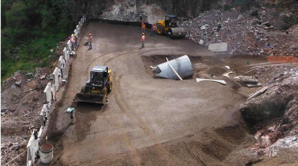
**Ilustración 28. Obra De Drenaje Del Km 4+295.00 (Troncal), Alcantarilla De Acero Corrugado Elíptica, 2.13 Mts. Calibra No. 12. (Constructora De Autopistas De Michoacan, S.A.P.I. De C.V., 2014)**
