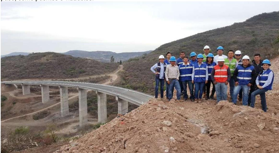
**Ilustración 54. Viaducto Nispo, Con Una Longitud De 400 Mts. Del Km. 3+600 Al Km. 4+000, Donde La Pila No. 5 Que Es La Mas Alta Con Una Altura De 55.756 Mts. (CONSTRUCTORA DE AUTOPISTAS DE MICHOACÁN, S.A.P.I. DE C.V., 2016)**
