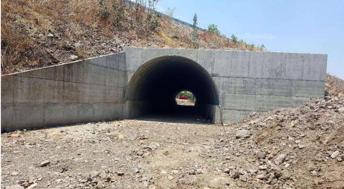
**Ilustración 21. Obra De Drenaje Del Km 1+736.50 (Troncal), Alcantarilla De Acero Corrugado, Arco De Luz, 7.01 Mts. Calibra No. 5. (Constructora De Autopistas De Michoacan, S.A.P.I. De C.V., 2014)**
