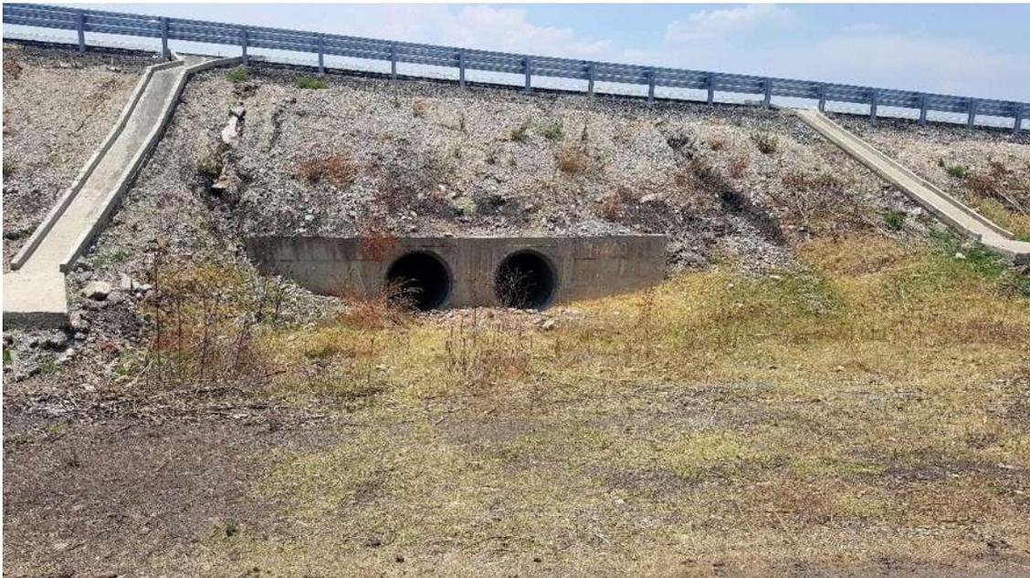
**Ilustración 20. Obra De Drenaje Del Km 1+400.00 (Troncal), 2 Tubos De Concreto De 1.22 Mts. (Constructora De Autopistas De Michoacan, S.A.P.I. De C.V., 2014)**
