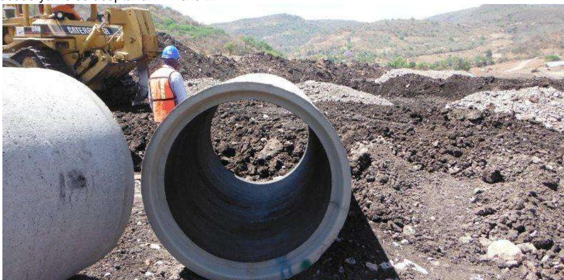
Ilustración 64. Recepción De La Tubería De La Obra De Drenaje Del Km 1+400.00 (Troncal), 2 Tubos De Concreto De 1.22 Mts. Con Una Longitud De 29.913 Mts. (15 Tubos En Cada Línea, Siendo Un Total De 30 Tubos En Esta Obra Ya Que Cada Tubo Mide 2.10 Mts. De Longitud) Una Pendiente De 7.75%, Un Esviaje De 0°. (Constructora De Autopistas De Michoacan, S.A.P.I. De C.V., 2014)
