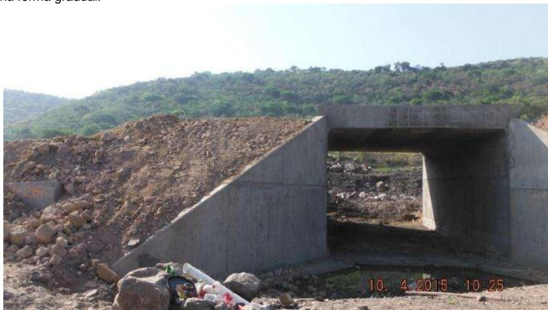
Ilustración 48. Obra De Drenaje Del Km 11+300.00 (Gasa 10), Cajón De Concreto De 6.00 Mts. x 4.50 Mts. (Constructora De Autopistas De Michoacan, S.A.P.I. De C.V., 2014)
