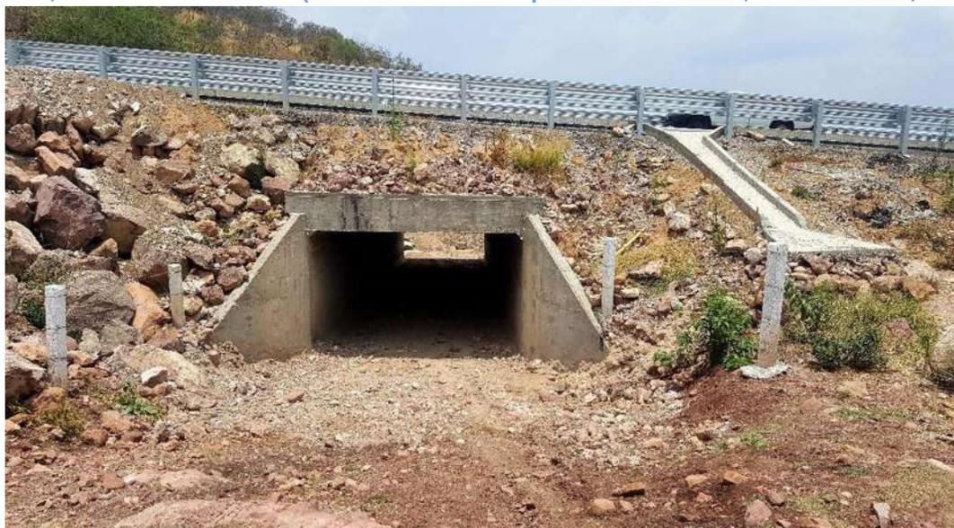
**Ilustración 44. Obra de Drenaje Del Km. 6+715.00 (Troncal), Cajón De Concreto De 4.00 Mts. x 2.50 Mts. (Constructora De Autopistas De Michoacan, S.A.P.I. De C.V., 2014)**
