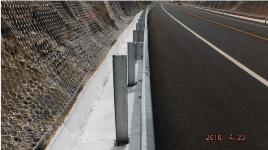
Ilustración 53. cunetas L/D. (Constructora De Autopistas De Michoacan, S.A.P.I. De C.V., 2016)
