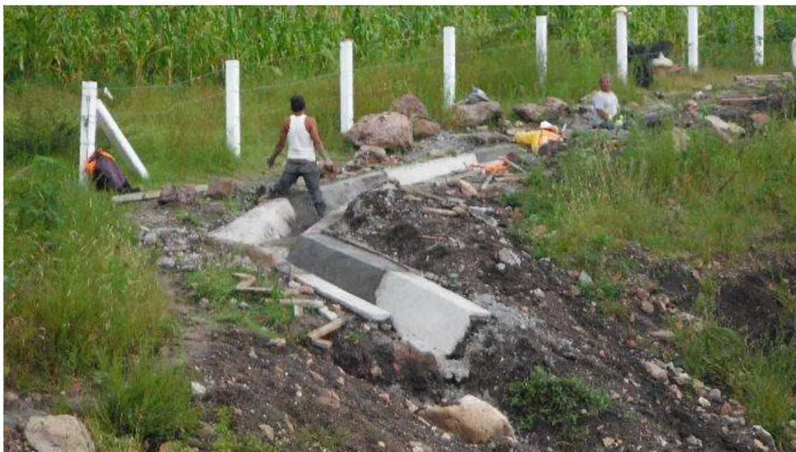
Ilustración 46. Contra cunetas L/I Km. 1. (Constructora De Autopistas De Michoacan, S.A.P.I. De C.V., 2016)
