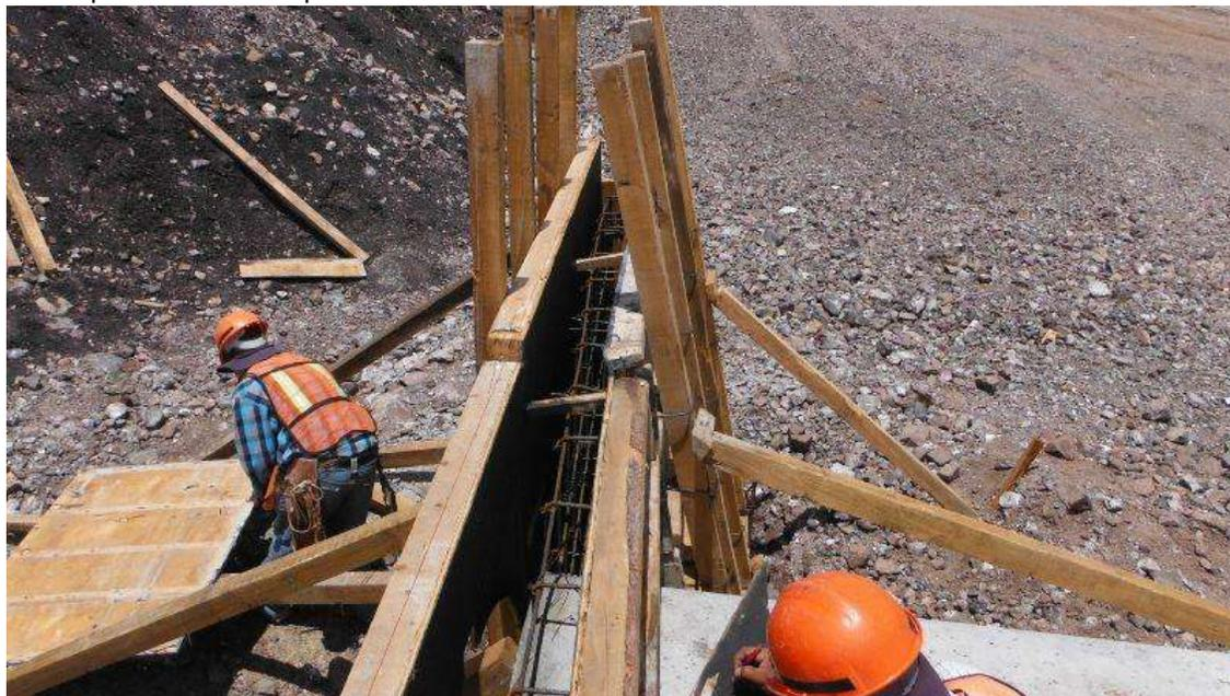
**Ilustración 69.** Cimbrado Y Armado Del Cabezote De La Obra De Drenaje Del Km 1+400.00 (Troncal), 2 Tubos De Concreto De 1.22 Mts. Con Una Longitud De 29.913 Mts. (15 Tubos En Cada Línea, Siendo Un Total De 30 Tubos En Esta Obra Ya Que Cada Tubo Mide 2.10 Mts. De Longitud) Una Pendiente De 7.75%, Un Esviaje De 0°. (Constructora De Autopistas De Michoacan, S.A.P.I. De C.V., 2014)
