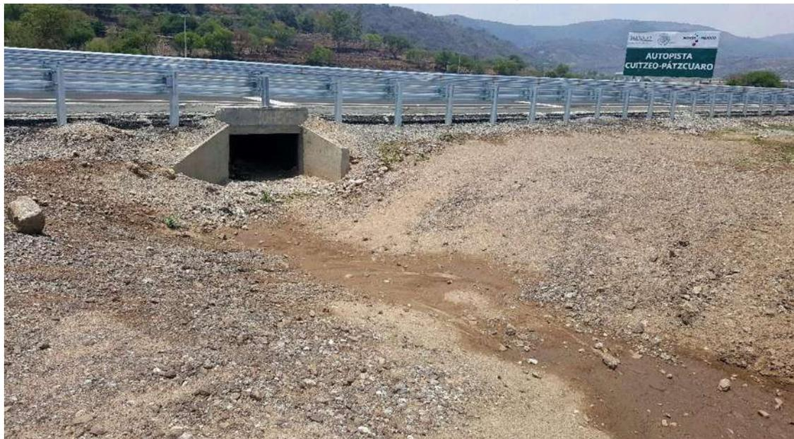
**Ilustración 7. Obra De Drenaje Del Km 10+156 (Gasa 10), Cajón De Concreto De 1.50 Mts. x 1.00 Mts. (Constructora De Autopistas De Michoacan, S.A.P.I. De C.V., 2014)**
