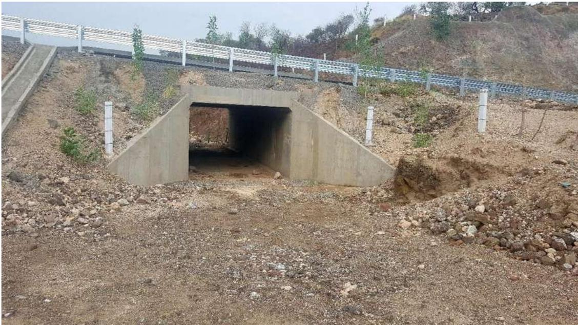
**Ilustración 24. Obra De Drenaje Del Km 2+675.00 (Troncal), Cajón De Concreto De 4.00 Mts. X 3.00 Mts. (Constructora De Autopistas De Michoacan, S.A.P.I. De C.V., 2014)**
