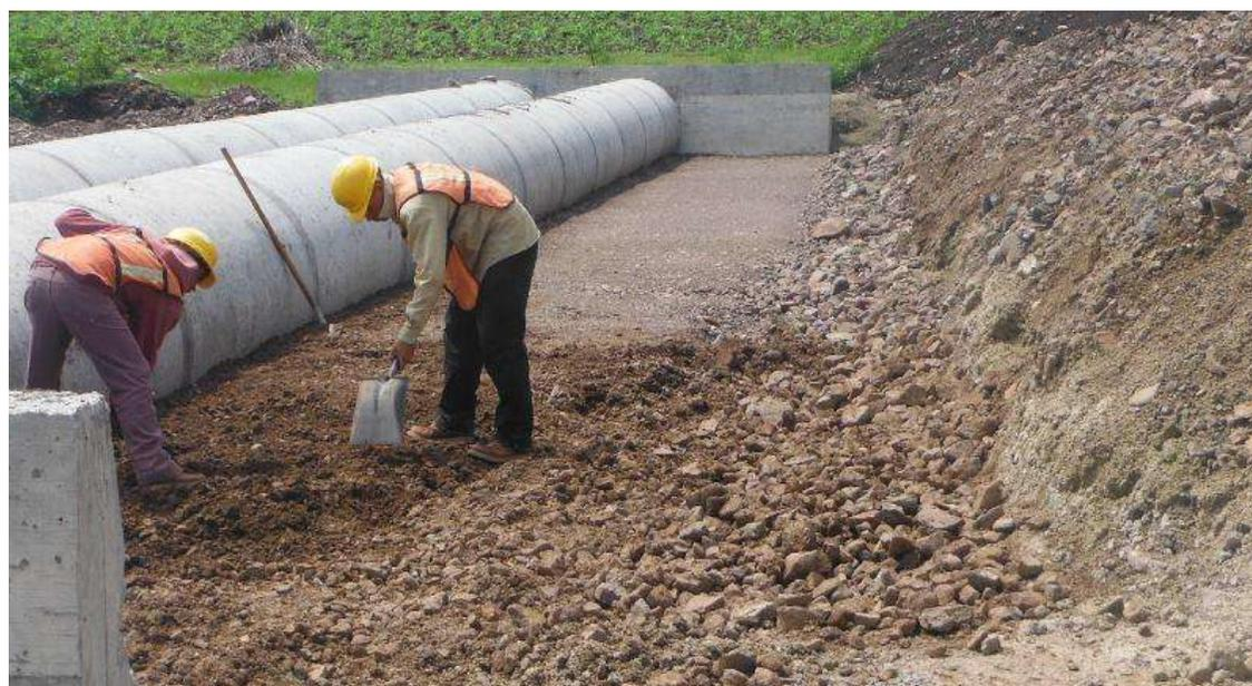
**Ilustración 70.** Preparación Para Recibir Aprovecho De La Obra De Drenaje Del Km 1+400.00 (Troncal), 2 Tubos De Concreto De 1.22 Mts. Con Una Longitud De 29.913 Mts. (15 Tubos En Cada Línea, Siendo Un Total De 30 Tubos En Esta Obra Ya Que Cada Tubo Mide 2.10 Mts. De Longitud) Una Pendiente De 7.75%, Un Esviaje De 0°. (Constructora De Autopistas De Michoacan, S.A.P.I. De C.V., 2014)
