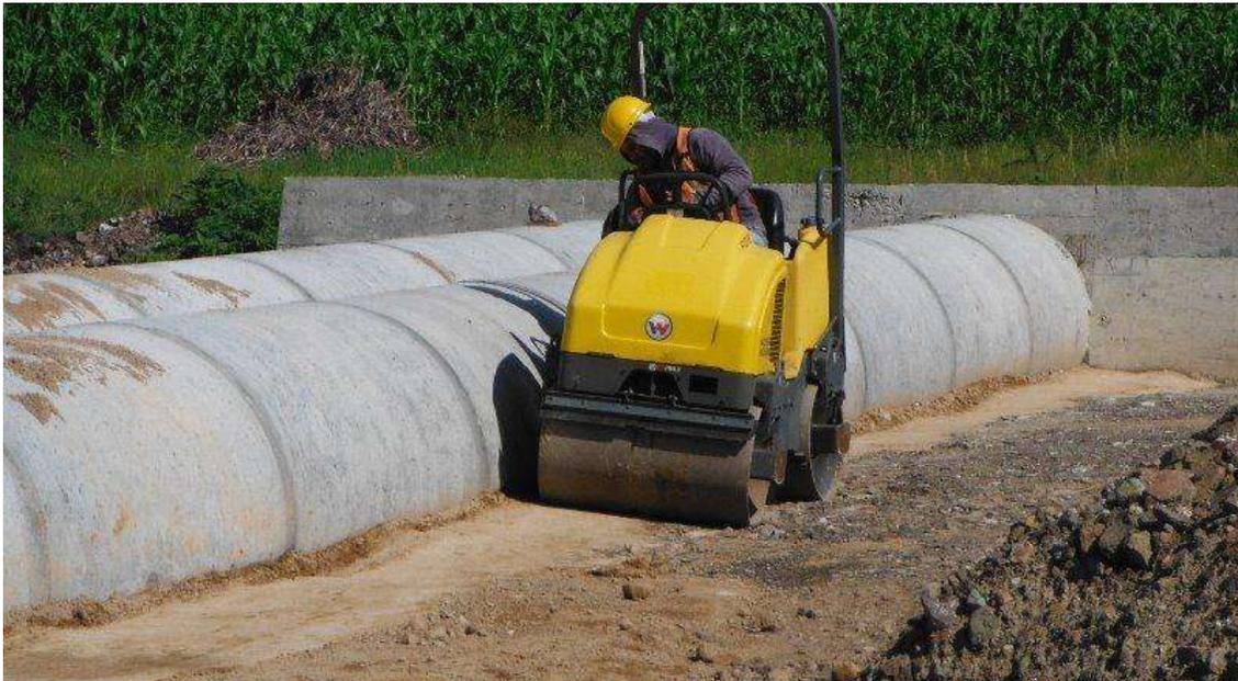
Ilustración 61. Obra De Drenaje Del Km 1+400.00 (Troncal), 2 Tubos De Concreto De 1.22 Mts. Con Una Longitud De 29.913 Mts. (15 Tubos En Cada Línea, Siendo Un Total De 30 Tubos En Esta Obra Ya Que Cada Tubo Mide 2.10 Mts. De Longitud) Una Pendiente De 7.75%, Un Esviaje De 0°. (Constructora De Autopistas De Michoacan, S.A.P.I. De C.V., 2014)
