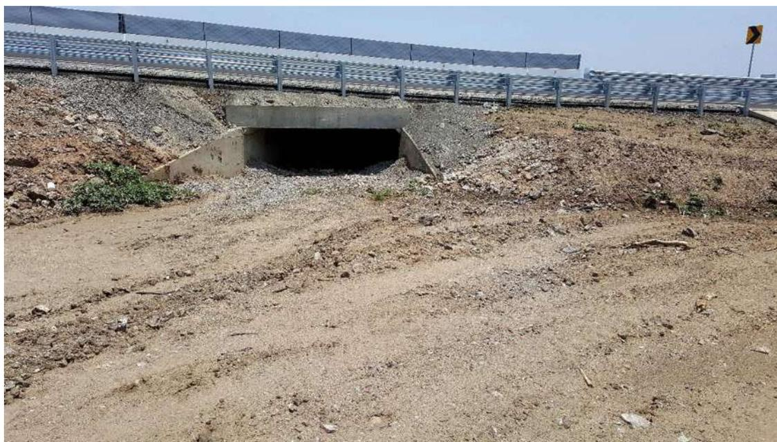
**Ilustración 8. Obra De Drenaje Del Km 10+410 (Gasa 10), Cajón De Concreto De 4.00 Mts. x 1.50 Mts. (Constructora De Autopistas De Michoacan, S.A.P.I. De C.V., 2014)**
