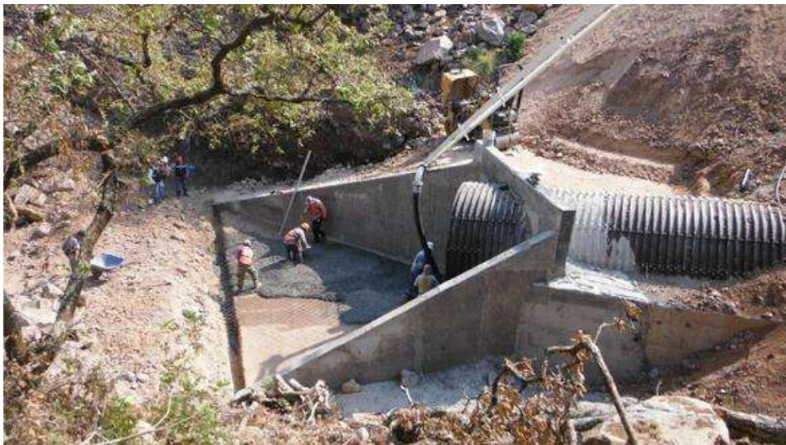
Ilustración 41. Obra De Drenaje Del Km 8+722.00 (Troncal), Alcantarilla De Acero Corrugado Elíptica De 3.05 Mts. Con Una Longitud De 95.77 Mts. Una Pendiente De 10.50%, Un Esviaje De 37° (Constructora De Autopistas De Michoacan, S.A.P.I. De C.V., 2014)
