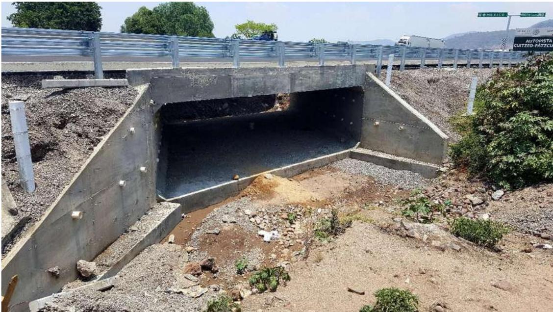
**Ilustración 14. Obra De Drenaje Del Km 29+982.805 (Gasa 30), Cajón De Concreto De 8.00 Mts. x 2.50 Mts. (Constructora De Autopistas De Michoacan, S.A.P.I. De C.V., 2014)**
