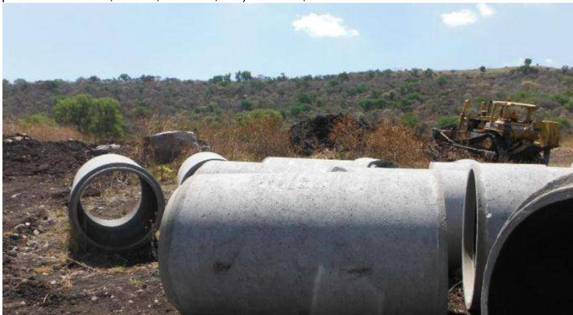
**Ilustración 58. Obra De Drenaje Del Km 1+400.00 (Troncal), 2 Tubos De Concreto De 1.22 Mts. Con Una Longitud De 29.913 Mts. (15 Tubos En Cada Línea, Siendo Un Total De 30 Tubos En Esta Obra Ya Que Cada Tubo Mide 2.10 Mts. De Longitud) Una Pendiente De 7.75%, Un Esviaje De 0°. (Constructora De Autopistas De Michoacan, S.A.P.I. De C.V., 2014)**
