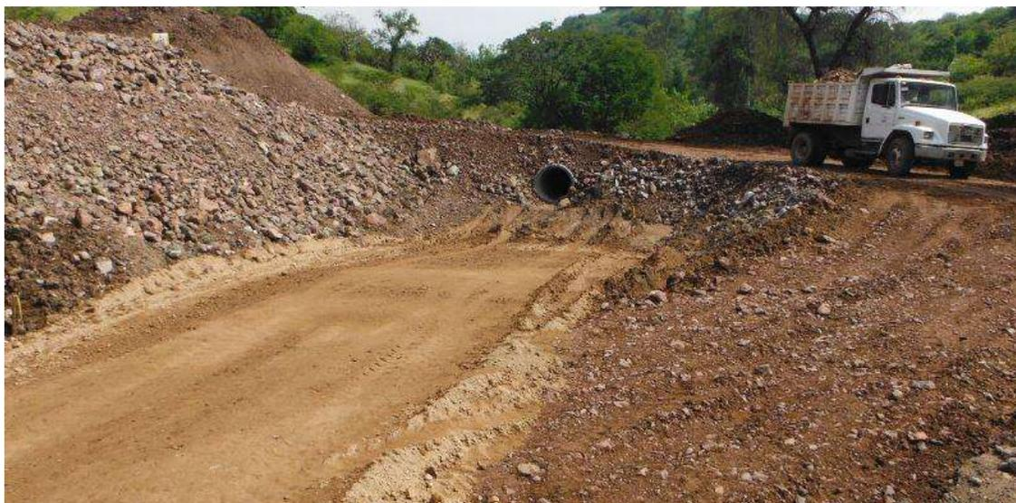
**Ilustración 56. Obra De Drenaje Del Km 2+758.00 (Troncal), Alcantarilla De Acero Corrugado, 1.98 Ms. Calibra No. 8. (Constructora De Autopistas De Michoacan, S.A.P.I. De C.V., 2014)**
