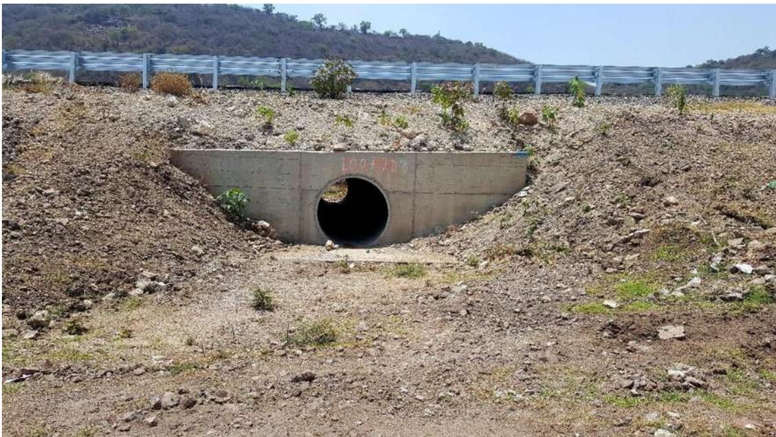
Ilustración 18. Obra De Drenaje Del Km 100+788.00 (Gasa 100), Tubo De Concreto De 1.52 Mts. (Constructora De Autopistas De Michoacan, S.A.P.I. De C.V., 2014)
