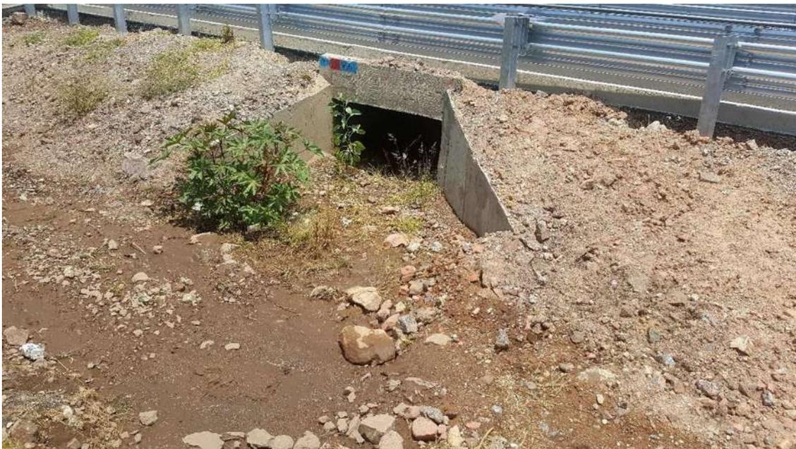
**Ilustración 16. Obra De Drenaje Del Km 100+490.00 (Gasa 100), Cajón De Concreto De 1.50 Mts. X 1.00 Mts. (Constructora De Autopistas De Michoacan, S.A.P.I. De C.V., 2014)**
