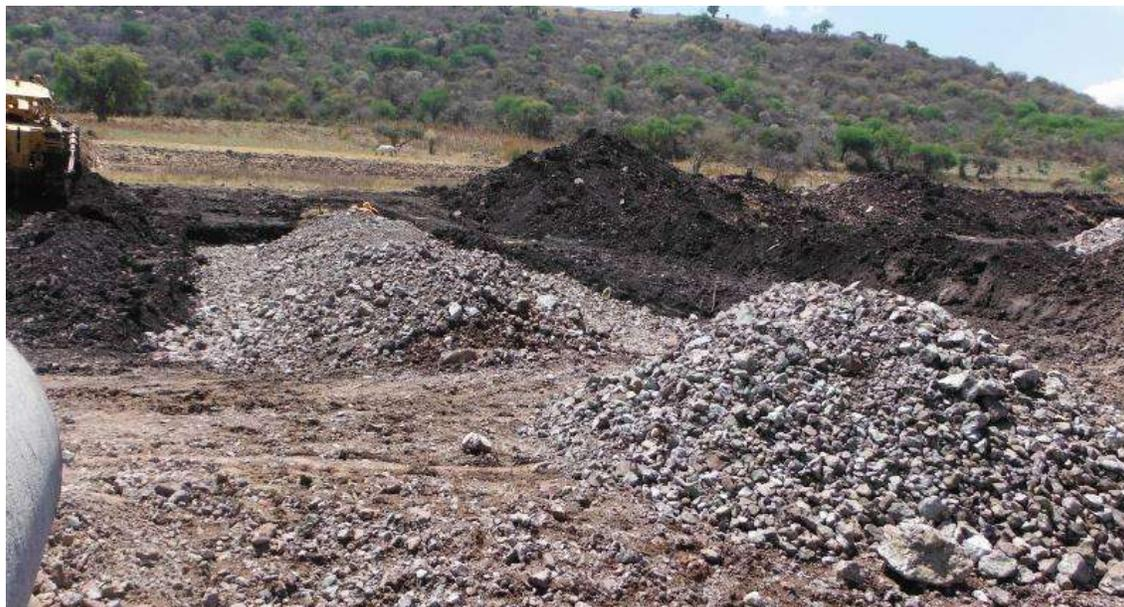
Ilustración 63. Excavación De La Obra De Drenaje Del Km 1+400.00 (Troncal), 2 Tubos De Concreto De 1.22 Mts. Con Una Longitud De 29.913 Mts. (15 Tubos En Cada Línea, Siendo Un Total De 30 Tubos En Esta Obra Ya Que Cada Tubo Mide 2.10 Mts. De Longitud) Una Pendiente De 7.75%, Un Esviaje De 0°. (Constructora De Autopistas De Michoacan, S.A.P.I. De C.V., 2014)
