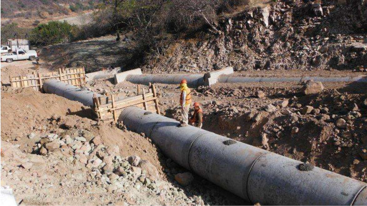
**Ilustración 27. Obra De Drenaje Del Km 3+322.50 (Troncal), Tubo De Concreto De 1.22 Mts. (Constructora De Autopistas De Michoacan, S.A.P.I. De C.V., 2014)**
