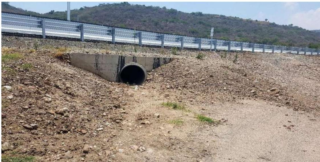
**Ilustración 9. Obra De Drenaje Del Km 10+983 (Gasa 10), Tubo De Concreto De 1.22 Mts. (Constructora De Autopistas De Michoacan, S.A.P.I. De C.V., 2014)**
