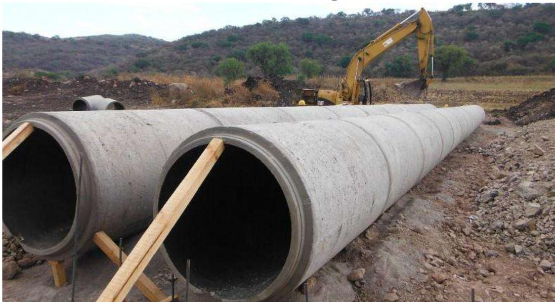
Ilustración 59. Obra De Drenaje Del Km 1+400.00 (Troncal), 2 Tubos De Concreto De 1.22 Mts. Con Una Longitud De 29.913 Mts. (15 Tubos En Cada Línea, Siendo Un Total De 30 Tubos En Esta Obra Ya Que Cada Tubo Mide 2.10 Mts. De Longitud) Una Pendiente De 7.75%, Un Esviaje De 0°. (Constructora De Autopistas De Michoacan, S.A.P.I. De C.V., 2014)
