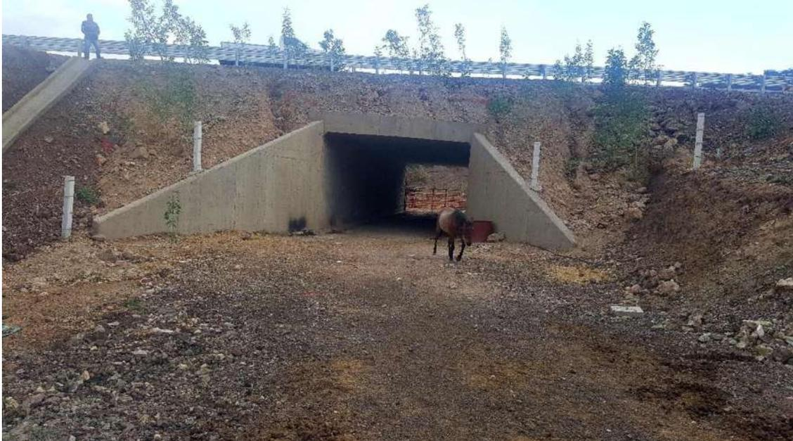
**Ilustración 23. Obra De Drenaje Del Km 2+096.00 (Troncal), Cajón De Concreto De 5.00 Mts. X 1.50 Mts. (Constructora De Autopistas De Michoacan, S.A.P.I. De C.V., 2014)**
