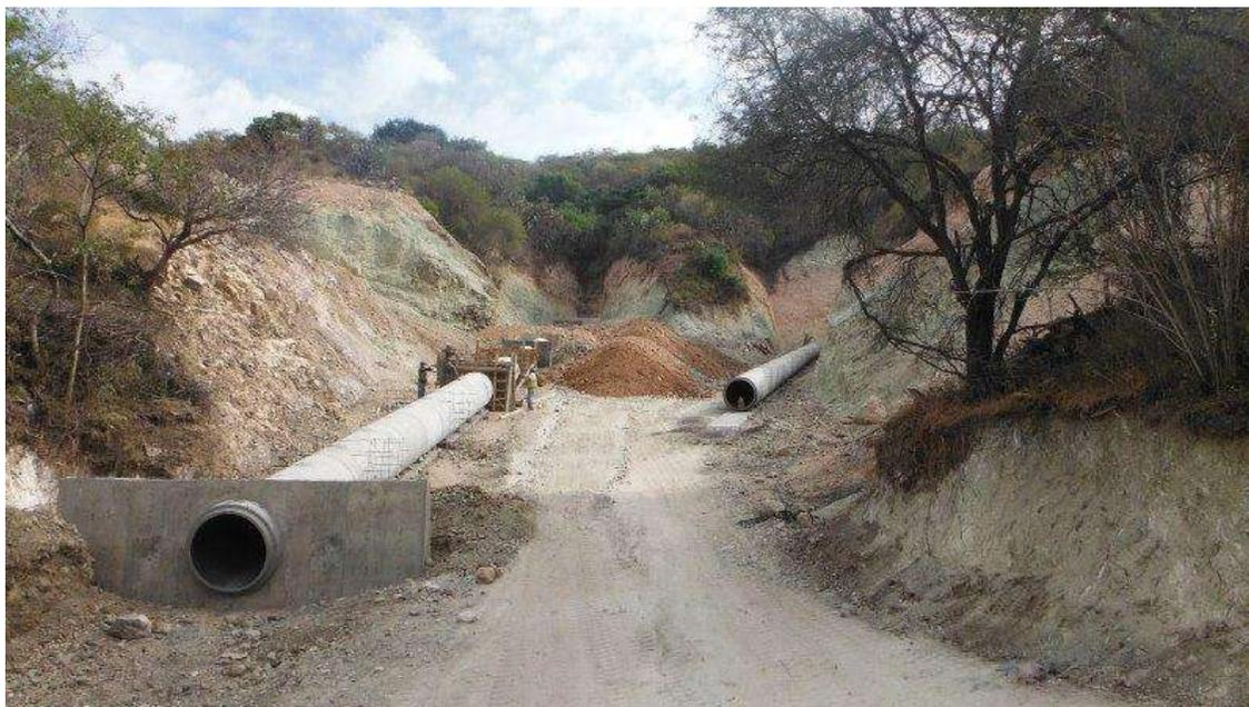
Ilustración 26. Obra De Drenaje Del Km 3+302.75 (Troncal), Tubo De Concreto De 1.22 Mts. (Constructora De Autopistas De Michoacan, S.A.P.I. De C.V., 2014)
