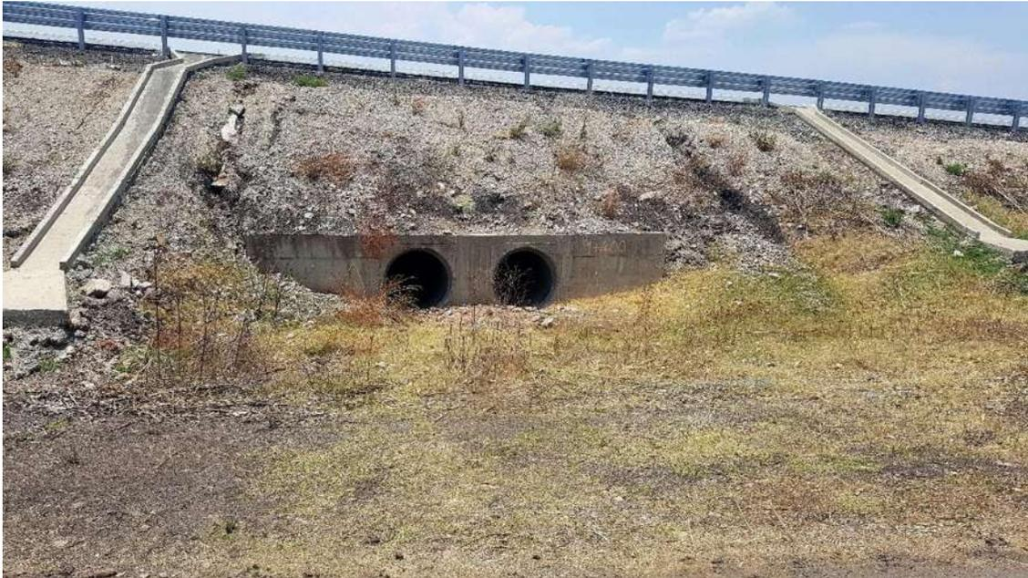
Ilustración 73. Obra De Drenaje Del Km 1+400.00 En Operación Lado Izquierdo. (Troncal), 2 Tubos De Concreto De 1.22 Mts. Con Una Longitud De 29.913 Mts. (15 Tubos En Cada Línea, Siendo Un Total De 30 Tubos En Esta Obra Ya Que Cada Tubo Mide 2.10 Mts. De Longitud) Una Pendiente De 7.75%, Un Esviaje De 0°. (Constructora De Autopistas De Michoacan, S.A.P.I. De C.V., 2014)
