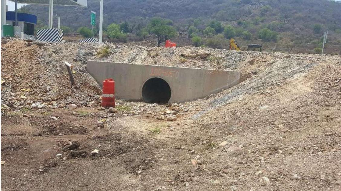
Ilustración 17. Obra De Drenaje Del Km 100+650.00 (Gasa 100), Tubo De Concreto De 1.22 Mts. (Constructora De Autopistas De Michoacan, S.A.P.I. De C.V., 2014)
