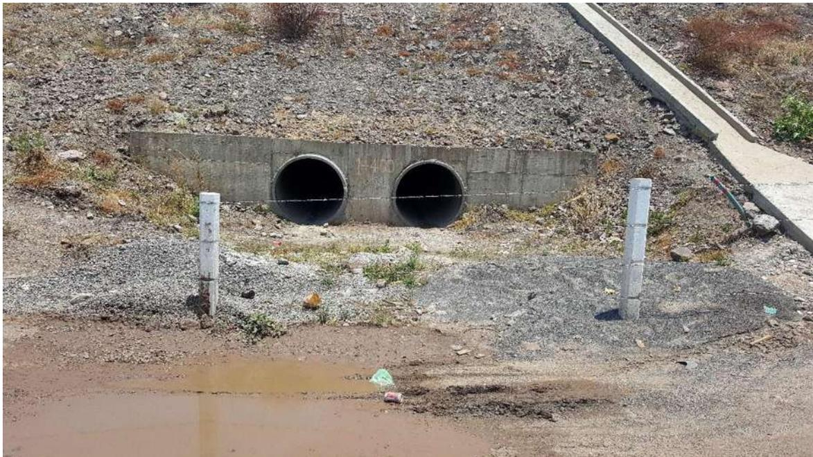
Ilustración 74. Obra De Drenaje Del Km 1+400.00 En Operación Lado Derecho (Troncal), 2 Tubos De Concreto De 1.22 Mts. Con Una Longitud De 29.913 Mts. (15 Tubos En Cada Línea, Siendo Un Total De 30 Tubos En Esta Obra Ya Que Cada Tubo Mide 2.10 Mts. De Longitud) Una Pendiente De 7.75%, Un Esviaje De 0°. (Constructora De Autopistas De Michoacan, S.A.P.I. De C.V., 2014)
