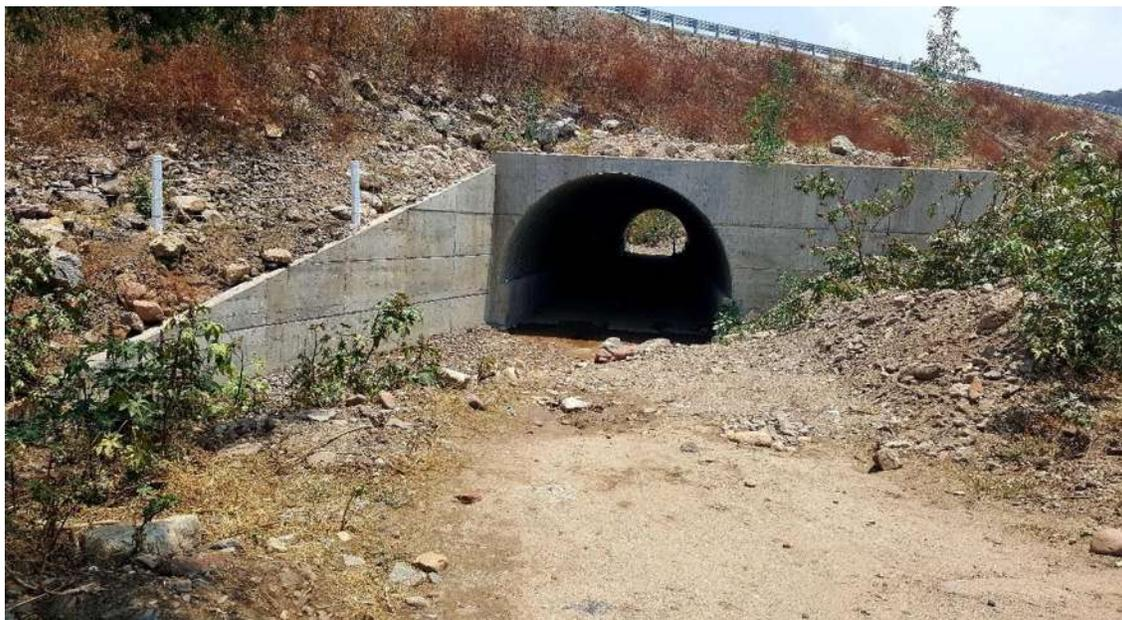
Ilustración 52. Obra De Drenaje Del Km 1+736.50 (Troncal), Alcantarilla De Acero Corrugado, Arco De Luz, 7.01 Mts. Calibra No. 5. (Constructora De Autopistas De Michoacan, S.A.P.I. De C.V., 2014)
