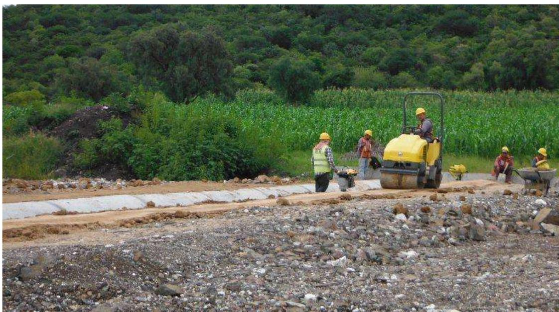
Ilustración 72. Compactación Obra De Drenaje Del Km 1+400.00 (Troncal), 2 Tubos De Concreto De 1.22 Mts. Con Una Longitud De 29.913 Mts. (15 Tubos En Cada Línea, Siendo Un Total De 30 Tubos En Esta Obra Ya Que Cada Tubo Mide 2.10 Mts. De Longitud) Una Pendiente De 7.75%, Un Esviaje De 0°. (Constructora De Autopistas De Michoacan, S.A.P.I. De C.V., 2014)
