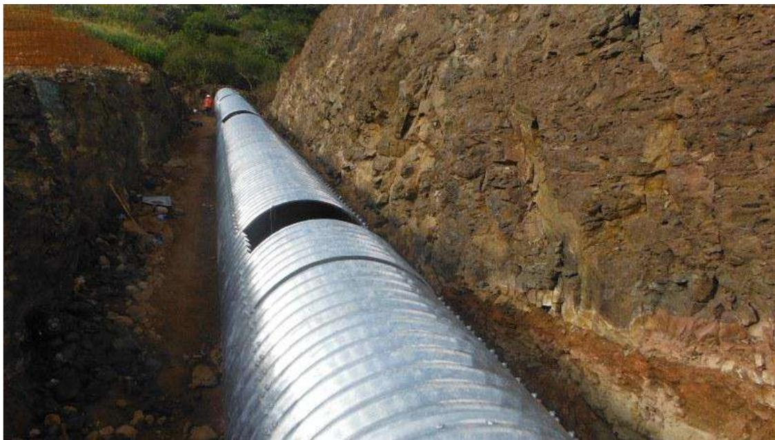
Ilustración 25. Obra De Drenaje Del Km 2+758.00 (Troncal), Alcantarilla De Acero Corrugado, 1.98 Mts. Calibra No. 8. (Constructora De Autopistas De Michoacan, S.A.P.I. De C.V., 2014)
