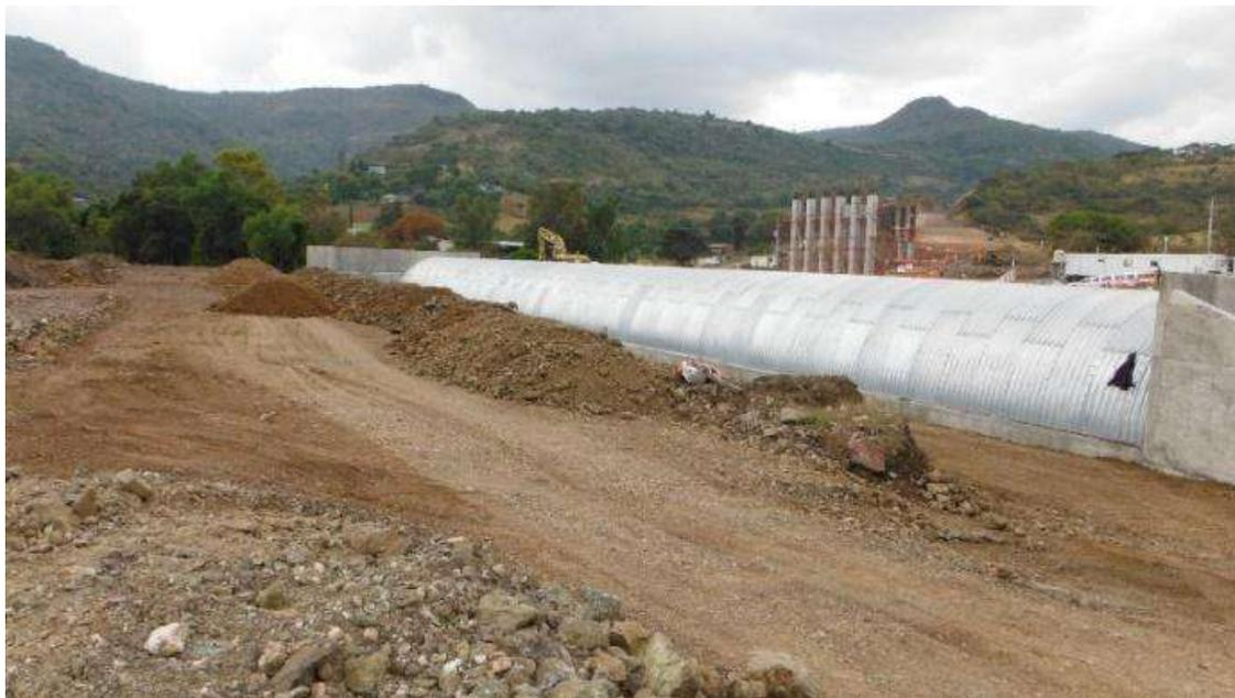
**Ilustración 43. Obra De Drenaje Del Km 1+736.50 (Troncal), Alcantarilla De Acero Corrugado, Arco De Luz, 7.01 Mts. Calibra No. 5. (Constructora De Autopistas De Michoacan, S.A.P.I. De C.V., 2014)**
