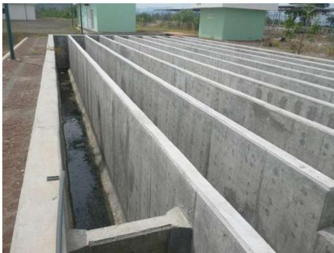
Figura 6.6 Tanque de contacto de cloro.
