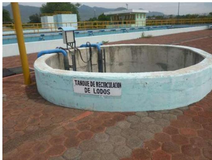
Figura 6.7 Tanque de recirculación de lodos.
