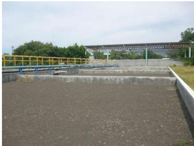
Figura 6.9 Lechos de secado de lodos.
