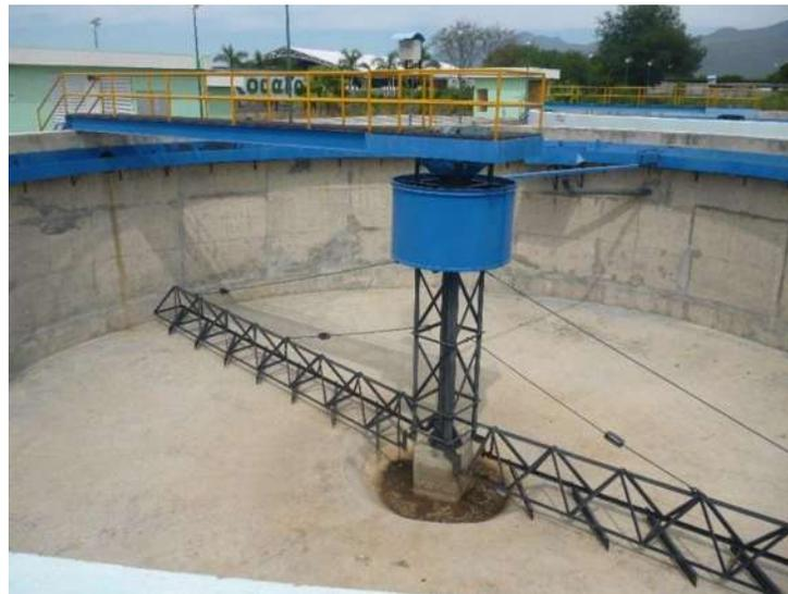
Figura 6.5 Sedimentador primario.
