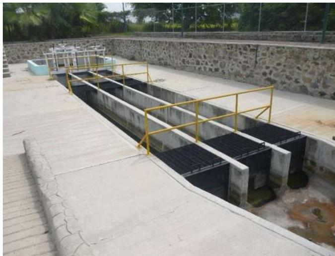
Figura 6.2 Canal desarenador.
